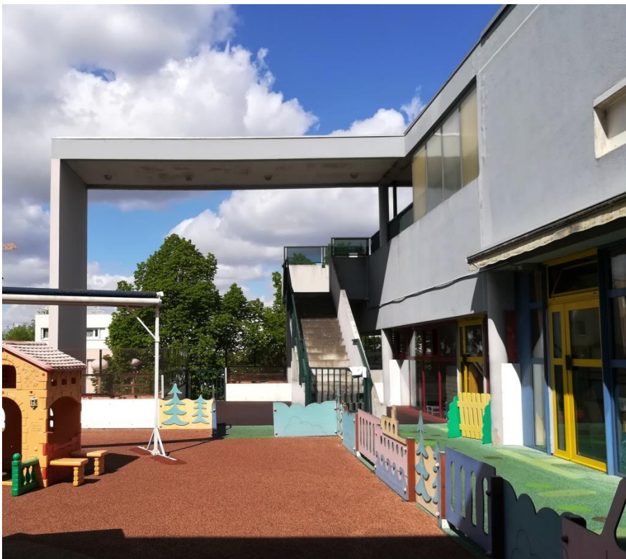
Vue extérieur de la terrasse, photographie, 1986-1989.
