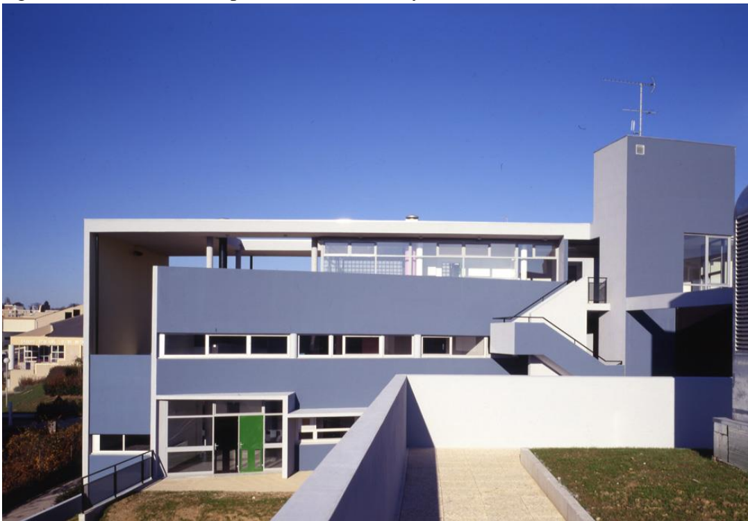
Façade nord sur cour, photographie, 1986-1989.
