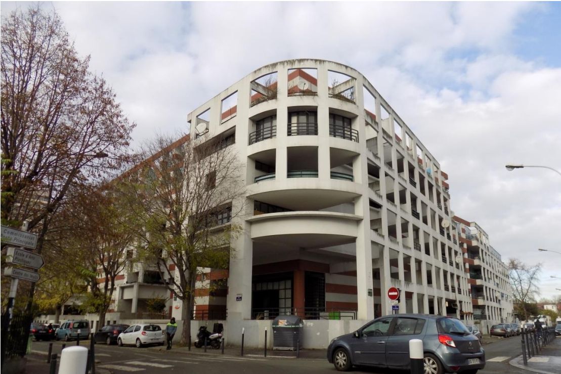
Vue de la façade sur rue, photographie, 1978-1982. Cliché Alice Agostini, septembre 2018.
