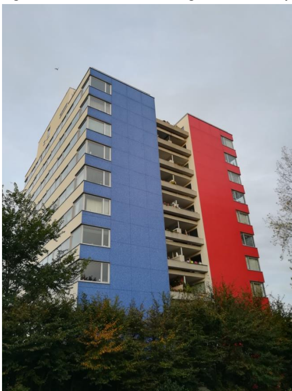
Façade, photographie, 1989-1995. Cliché Alice Agostini, novembre 2019.
