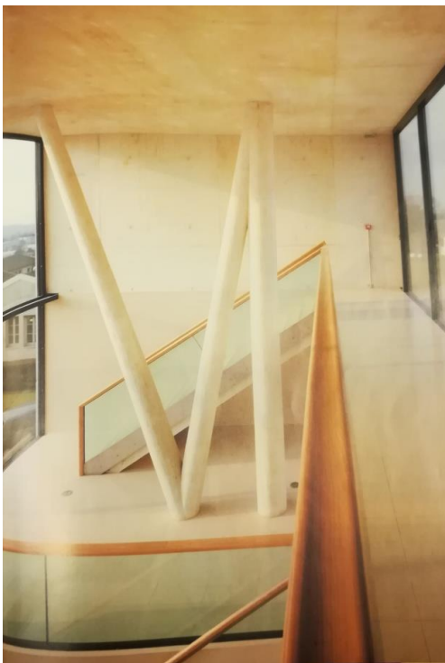
Figure 299 : Institut de Recherche en Informatique et en Automatique (INRIA), et le pôle Innovation et Communication, Rocquencourt
