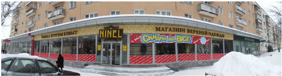
Photo 49. Ûmbal vurgem kevyt / Magazin verkhnej odeždy («Magasin de vêtements »)
