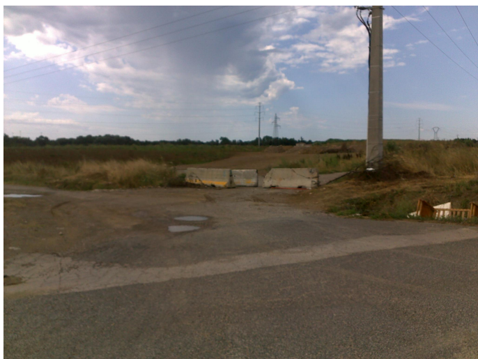
Photo 21 : Blocs en béton (13 juillet 2011)
