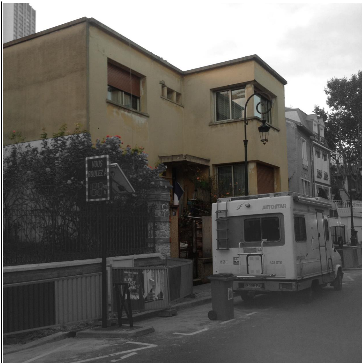
Figure 170 : Hôtel particulier de Mme Georges Barthélémy, 11 rue Montaigne, Puteaux (92), Jean et Édouard Niermans architectes, 1932. Photographie de l'auteur, prise de vue 16 juillet 2015.
