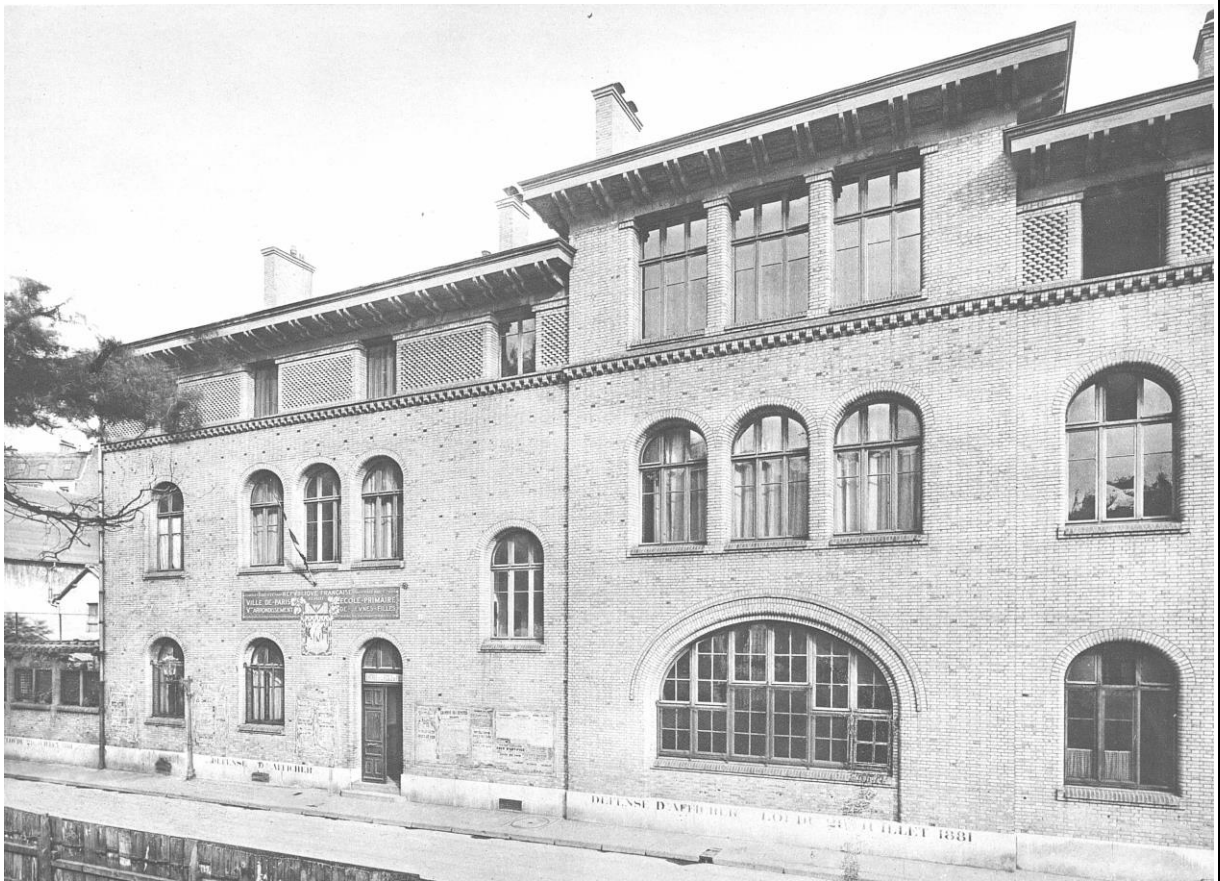
Figure 41 : École de la rue Pontoise, Paris, 1910-1911. Jacques-Marcel Auburtin architecte. L'architecte , octobre 1924, 1 ère année, n°10, pl. LXIII.
