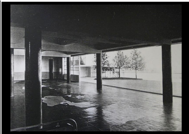
Figure 204 : Groupe scolaire Marius Jacotot, Putaux (92), Jean et Édouard Niermans architectes, 1938. In BARTHÉLÉMY, Georges. Groupe scolaire Marius Jacotot. Puteaux (Seine) . Paris : Éditions des Documents modernes, s.d., s.p. Les dalles de linoléum du préau de l'école maternelle sont également un support pour l'ornement, la faune et la flore y sont représentés.
