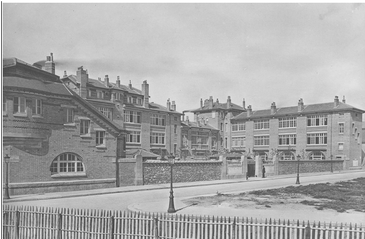
Figure 43 : Groupe scolaire de la rue Rouelle. Vue d'ensemble côté cour. Louis Bonnier architecte. In L'architecte , décembre 1912, n°12, pl. LXVIII.
