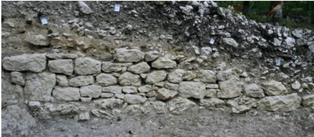
Fig. 127 : vue du mur M-18
