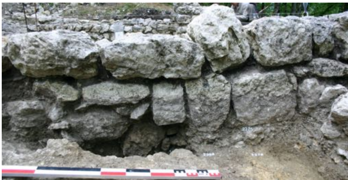
Fig. 132 : Vue du mur M-13
