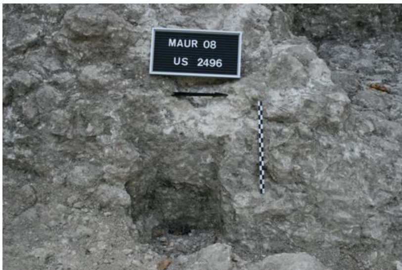
Fig. 136 : vue du trou de poteau 2496, dans l'épaisseur du mur M-28
