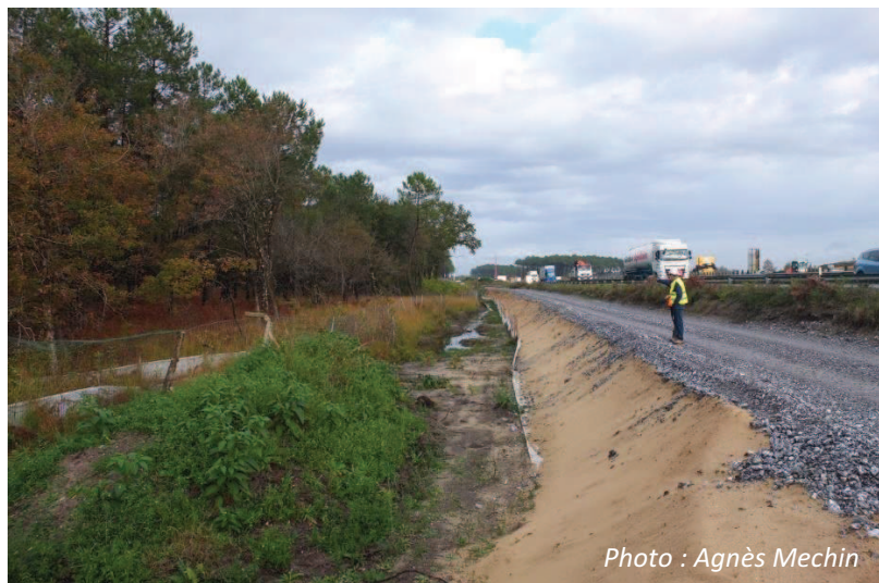
Figure 24 : Projet d'Elargissement d'autoroute. L'emprise du chantier est délimitée par les barrières métalliques.
