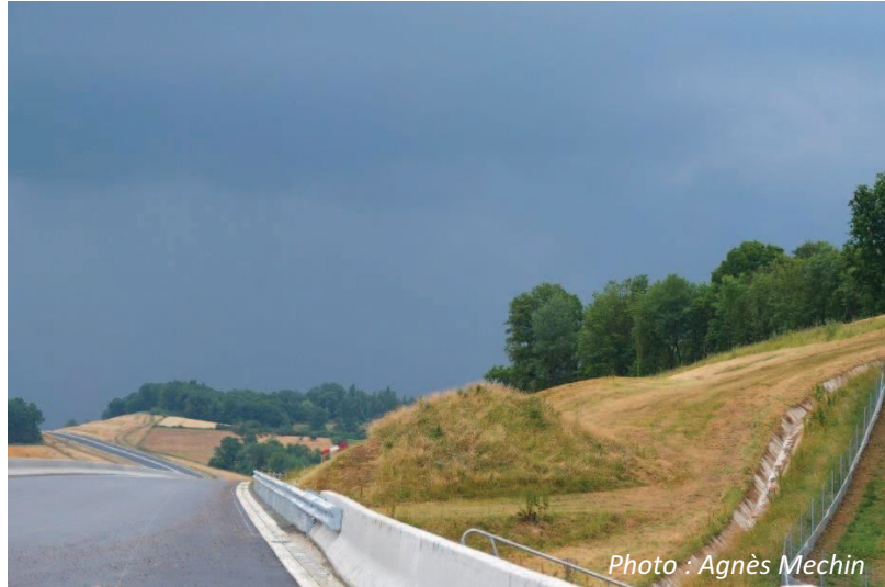
Figure 22 : Projet construction d'autoroute
