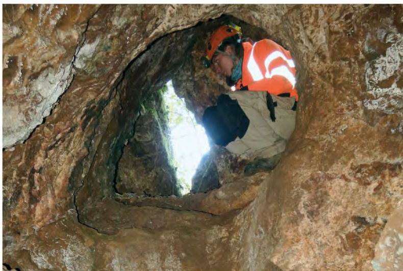
c. Accès au chantier CA1, qui permet à un adulte d'y passer, sans se tenir debout.
