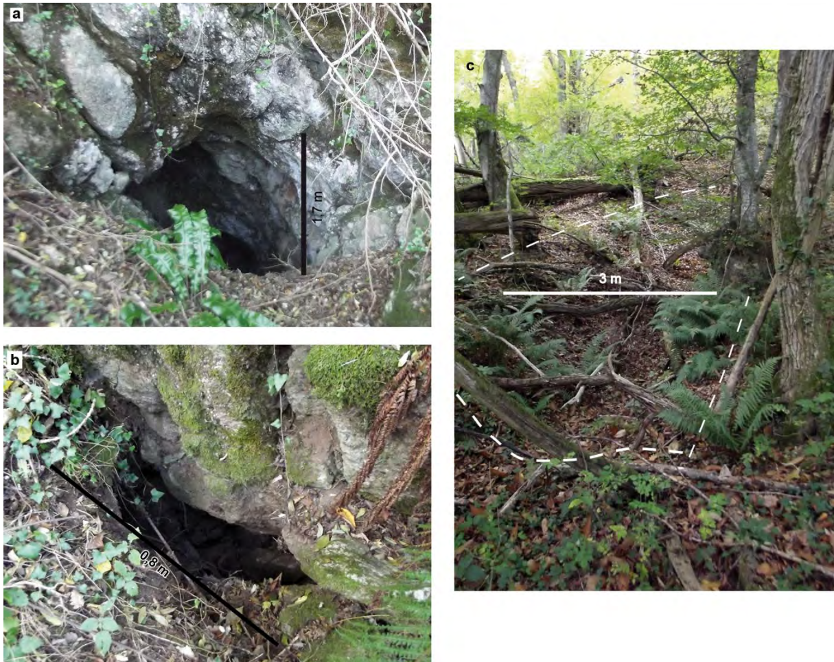
Fig. 40 : Vue des ouvrages DCH2 (a) DCH3 (b) et DCH6 (c).
