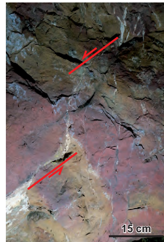
d. Fentes en échelon formant des losanges. La dolomie est rougie par le feu.
