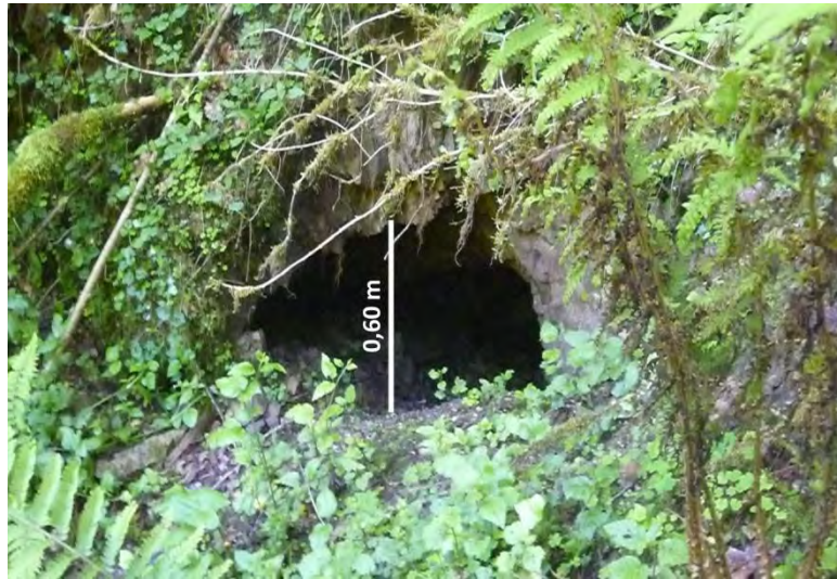
Fig. 9 : Galerie d'accès à la mine des Atiels (Ariège) partiellement comblée en pied de versant.
