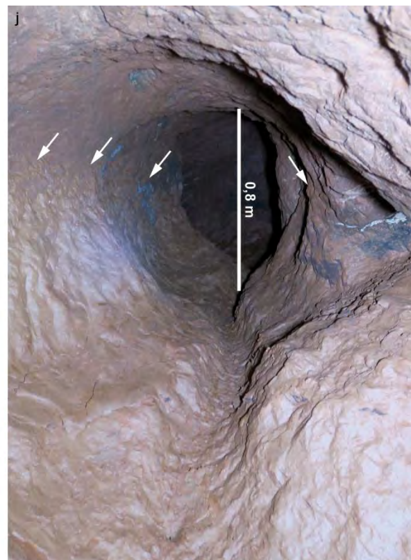
Fig. 121 : Le Goutil Ouest : encoches de boisage et canal d'exhaire.
