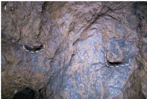
i. Encoches de boisage quadrangulaires. Une autre paire d'encoche leur fait face sur la paroi opposée. Largeur à la base: 10 cm
