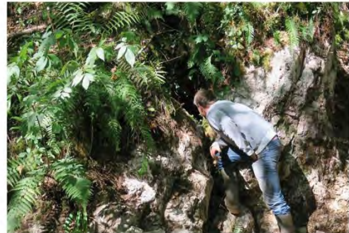
a. Accès à CA1 derrière les blocs éboulés
