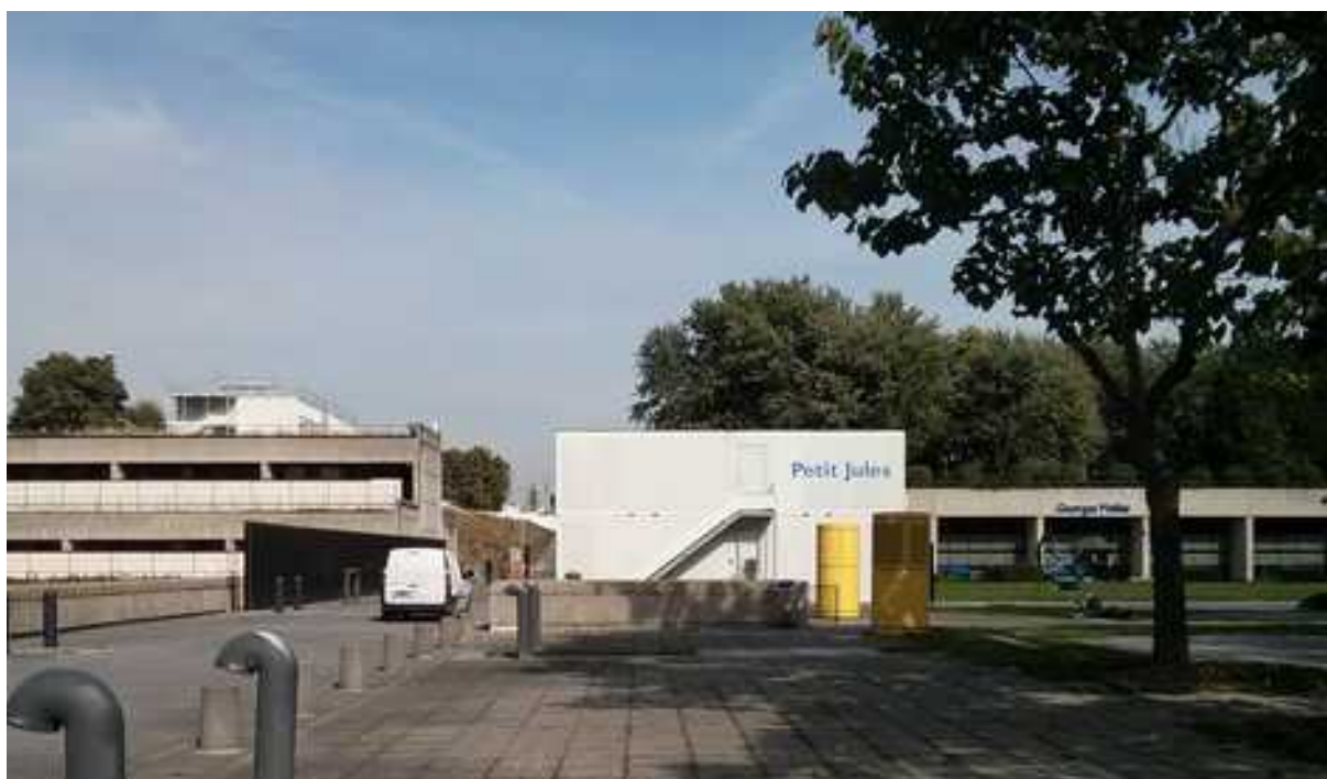
Illustration 10: le préfabriqué « Petit Jules », qui abrite le personnel de la DE.
