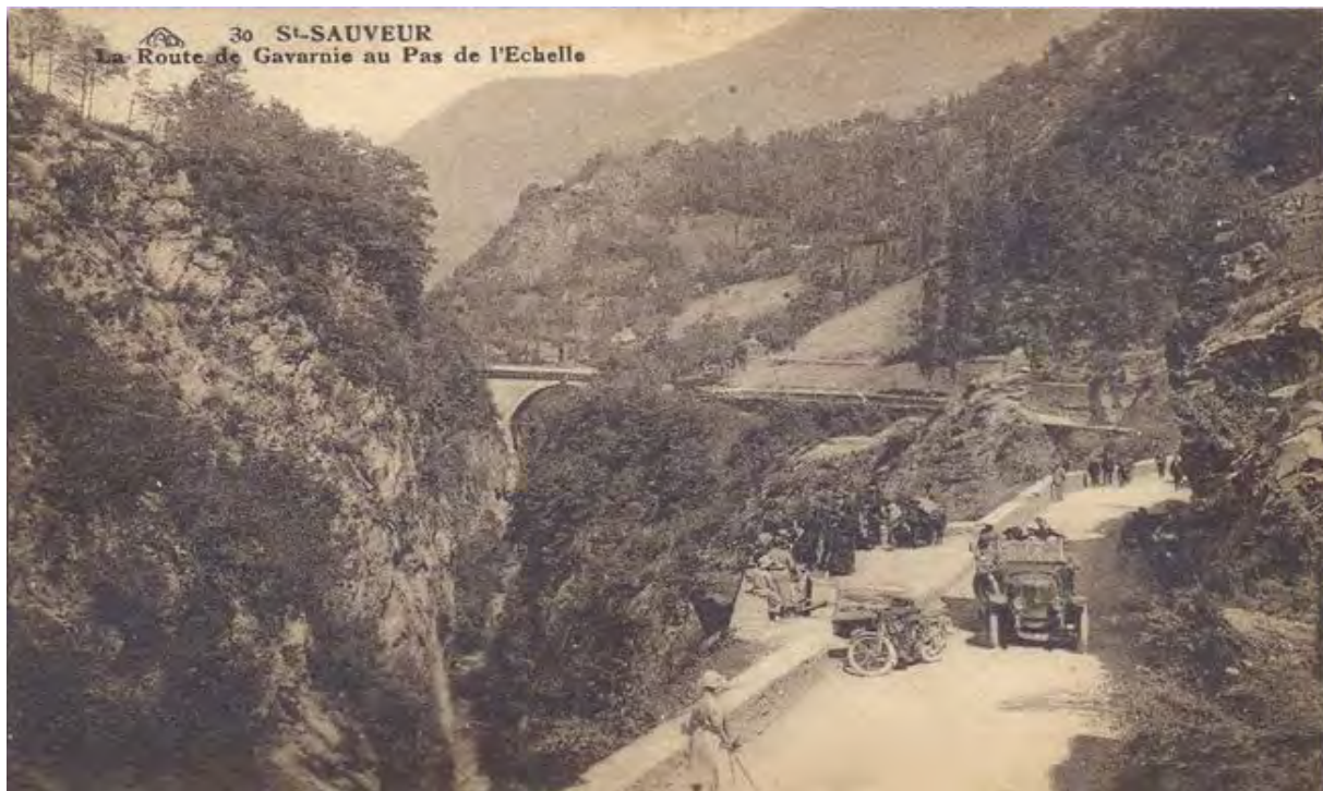
Figure 26. Carte postale montrant le Pont Napoléon à Saint Sauveur et du début de la route nationale 21 qui conduit à Gèdre et à Gavarnie, début du XX e siècle. Source : loucrup65.fr, 2012.
