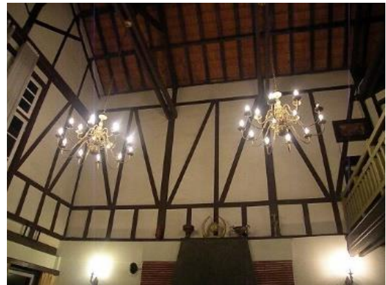
Photo 2.40-2.41 : Villa coloniale de style Normand à colombage à Dalat avec façade à l'extérieur et l'intérieur. L'ensemble des poutres formant la charpente du mur, cette ossature de bois a pour rôle de soutenir la maison (Valentin, 2014)
