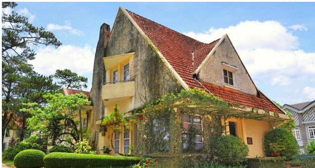
Photo 2.42: Villa coloniale de style Breton à Dalat, avec les pignons et les lucarnes triangulaires, le sommet du toit est très aigu et relié à la cheminée
