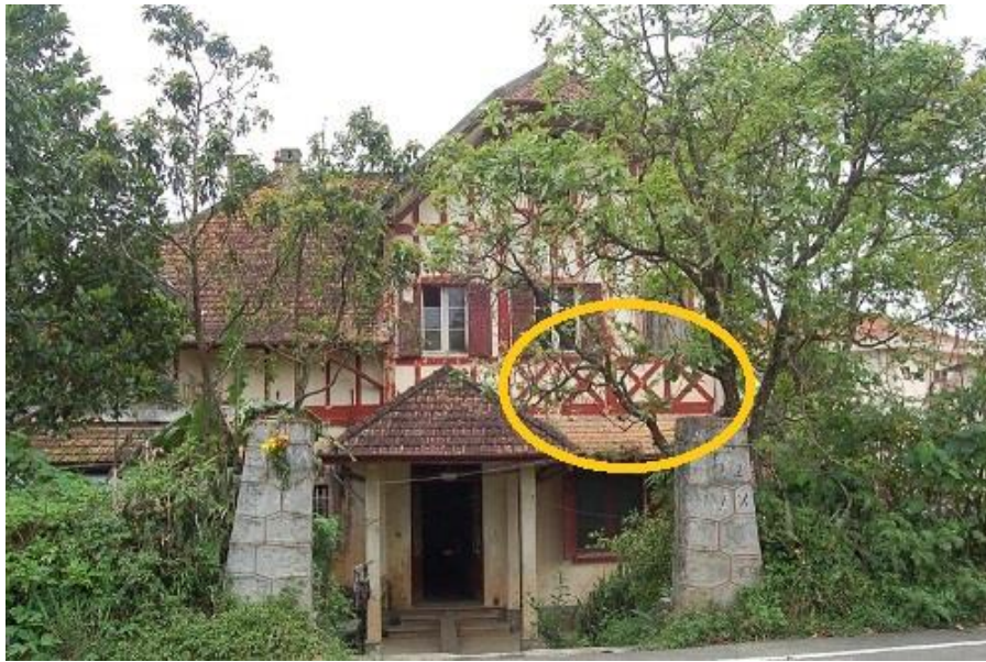
Photo 2.43: Villa coloniale à colombage de style Alsacien qui est différencié du style Normand par l'enchevêtrement de ses poutres.
