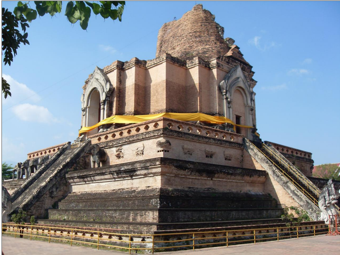
Figure 2. Le stupa Chedi Luang après la restauration du Département des Beaux-Arts en 1990 Source : Photo de Pijika Pumjetkao, 2011.
