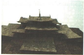
▲ วิหารวัดหนองไหล่งมุงหลังคาด้วยแผ่นเงิน
