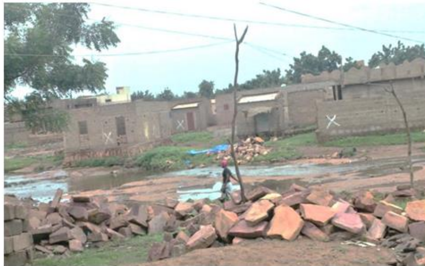
Figure 25. Exemple de construction illégale dans le quartier de Banconi
