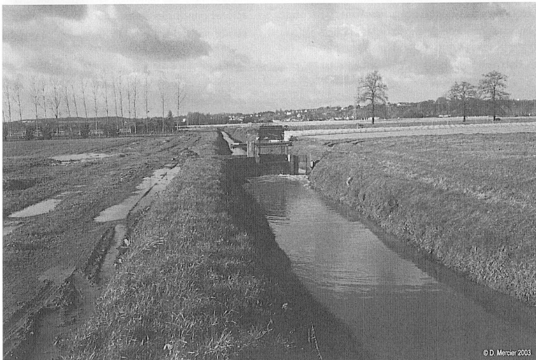
Foto 5. El drenaje del Val nantais mediante, canales, bombas y esclusas
