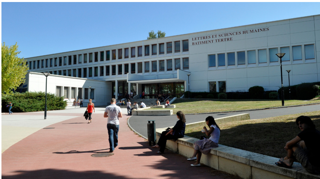
DOCUMENT 9. La faculté des Lettres et Sciences humaines et Sociales de l'Université de Nantes en 2009. Elle m'apparut ainsi lors de mon arrivée à l'université en septembre 1987. Des travaux récents entre 2016 et 2018 l'ont totalement transformée.
