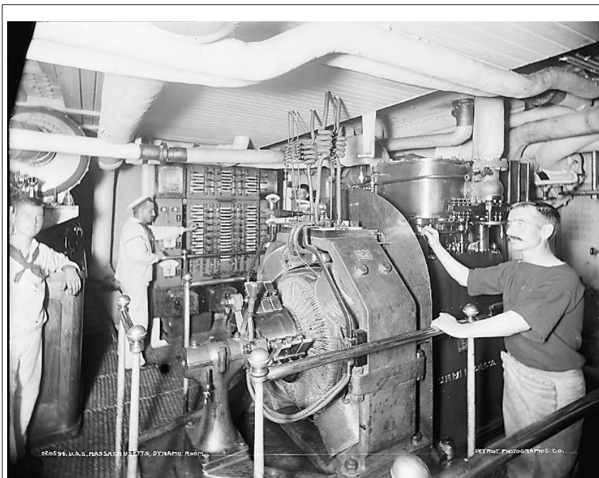
Illustration 98 : Électriciens travaillant sur un tableau et une dynamo
