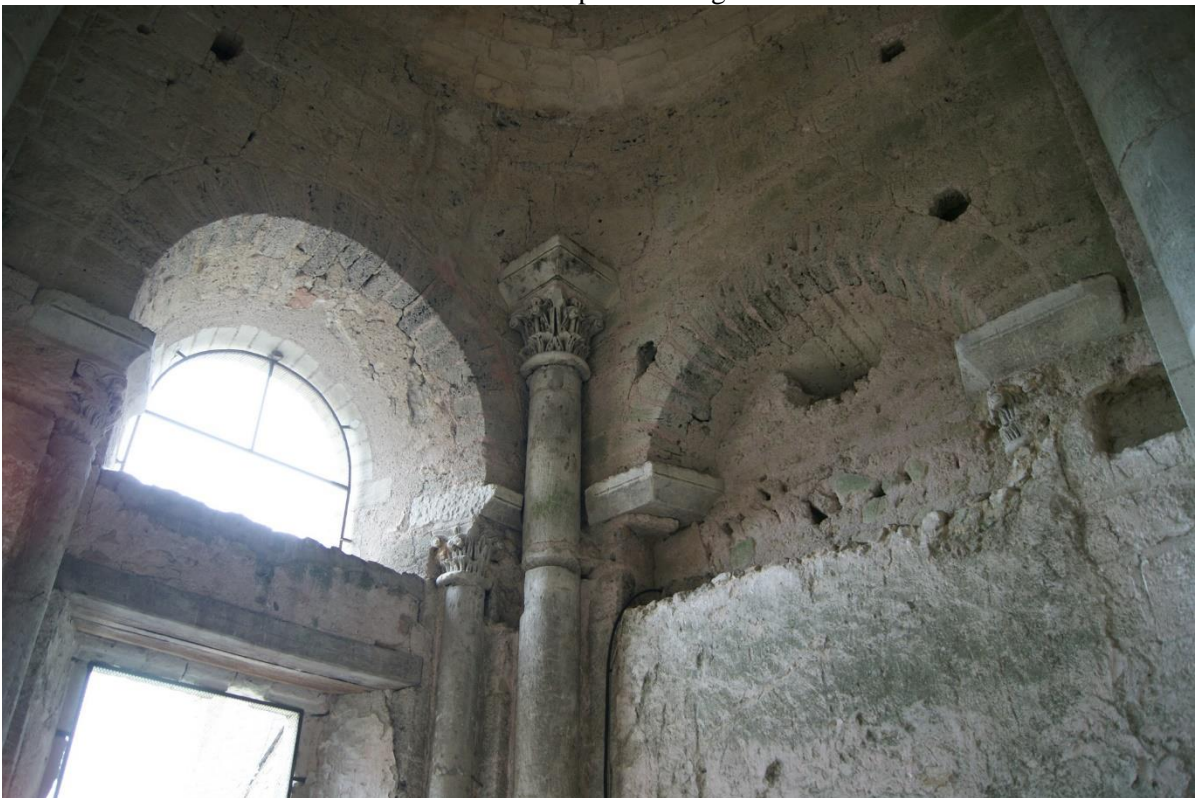
Illustration 5.23 – Angle intérieur nord-ouest de la tour, vue d’une colonnette d’angle au premier étage.
