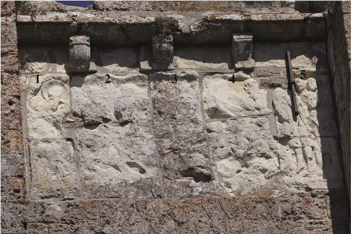
a. Plaques sculptées de la façade occidentale de la tour Saint-Paul. Côté droit. Les femmes au tombeau ?
