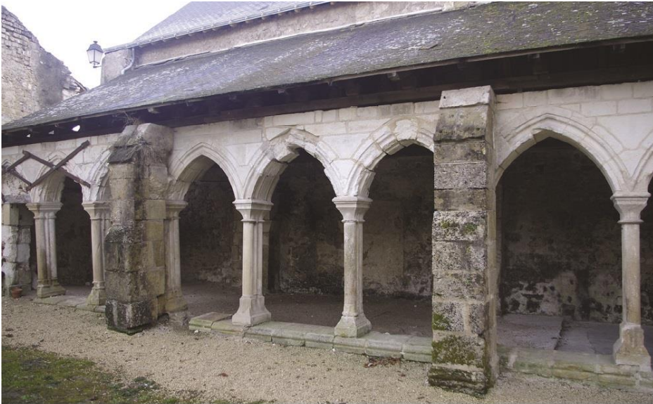
a. Galerie méridionale du cloître vue du préau
