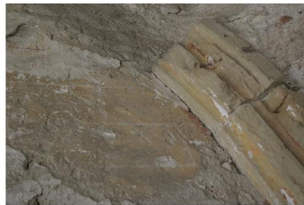
d. Vue détaillée de l'enduit peint du mur M 230 (UC 20076)
