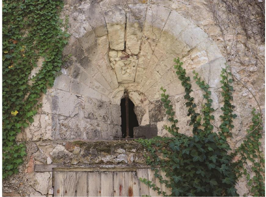
b. Baie. Mur nord des celliers
