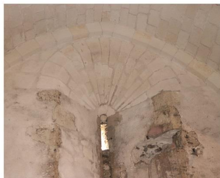
d. Baie. Mur sud des celliers. 1 er travée
