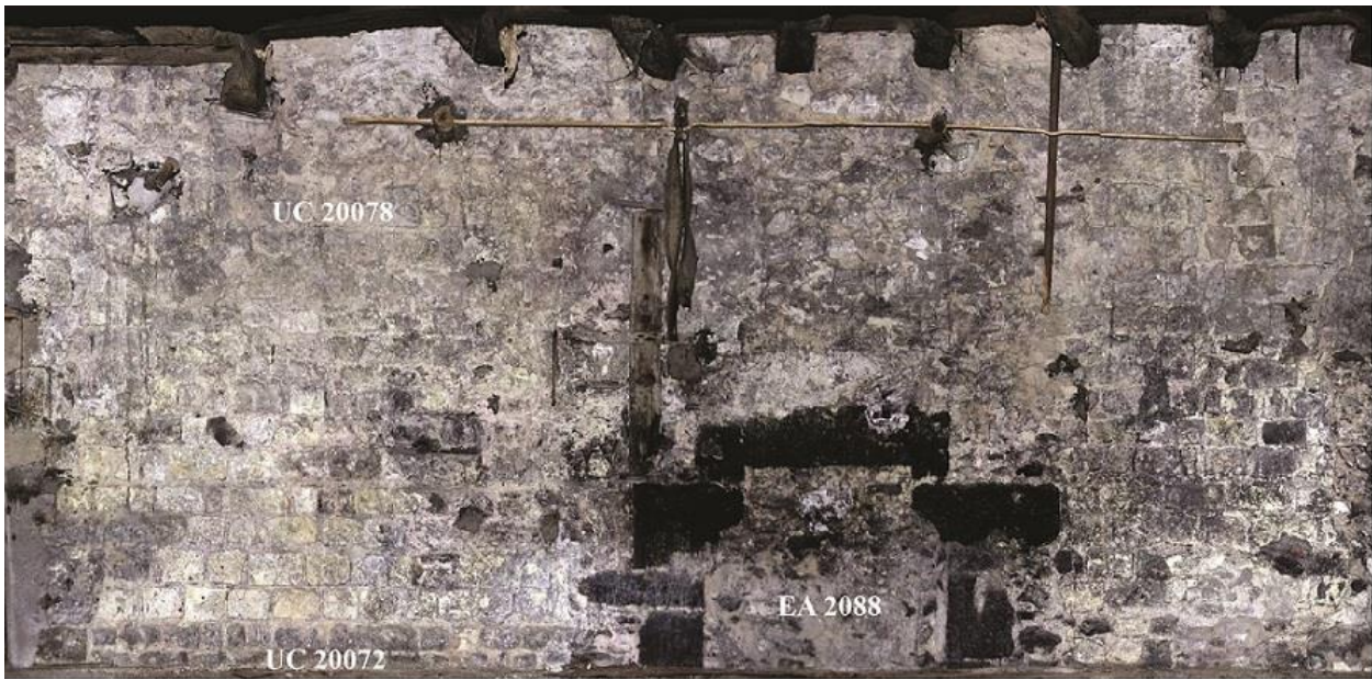
a. Bras droit du transept. Parement intérieur du mur méridional (M 232)
