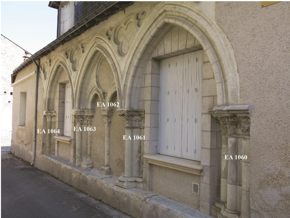
a. Mur occidental de la salle capitulaire (M 256) - enregistrement des colonnes
