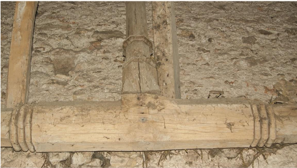
b. Décorations d'un poinçon et d'un entrait de la charpente du réfectoire de Cormery
