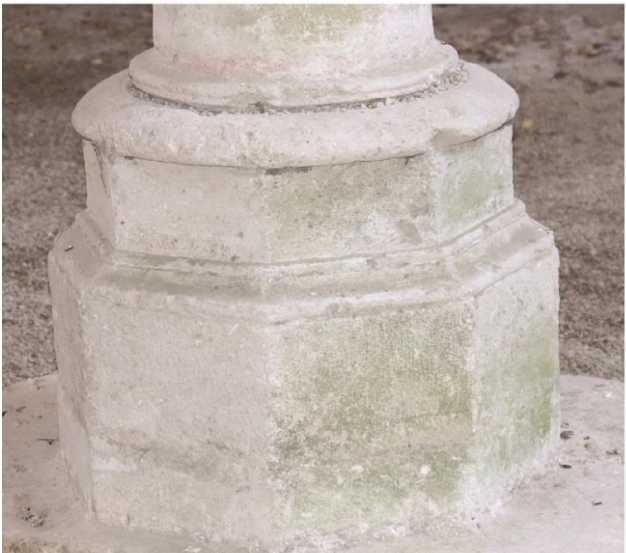
c. Base octogonale d'une colonne du réfectoire
