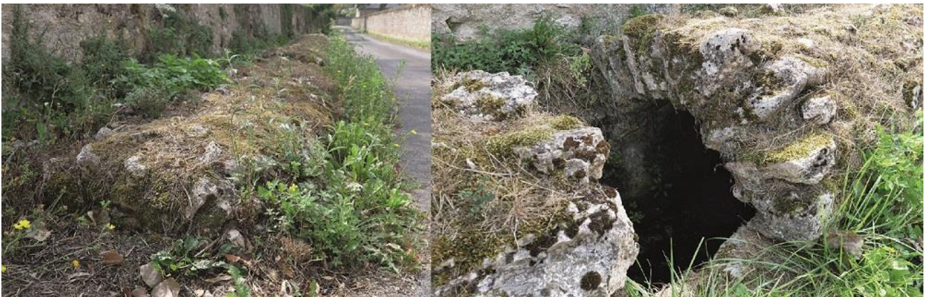
Illustration 1.8 - Vues de l'aqueduc de Truyes et de ses maçonneries.
