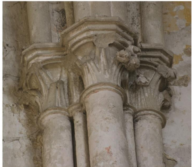
d. Chapiteaux des colonnes engagées fasciculées
