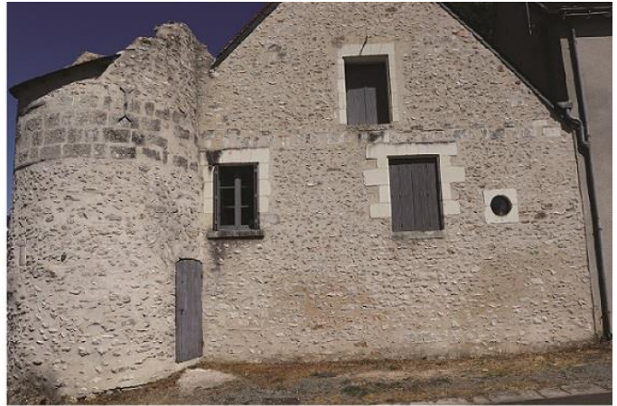
b. Tour nord-ouest de l'enceinte du bourg vue de l'ouest
