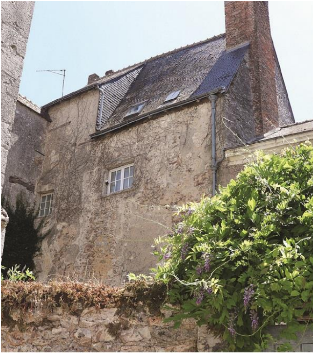
a. Logis du sacriste vue depuis le nord
