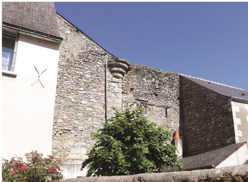
b. Encorbellement d'une ancienne échaugette dans l'angle sud-ouest de l'enceinte monastique (EA 3001)
