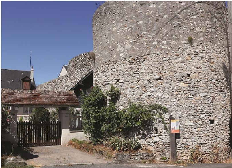
c. Tour de l'enceinte occidentale vue de l'ouest
