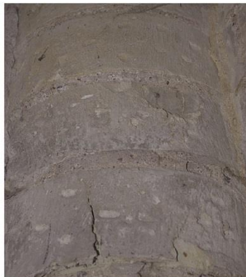
c. Détail du layage de la colonne (EA 2069)
