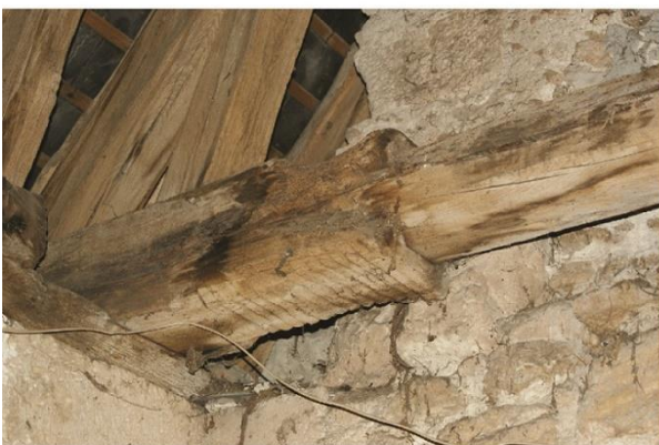
c. Engoulant à l'extrémité d'un entrait dans la charpente du réfectoire de Cormery
