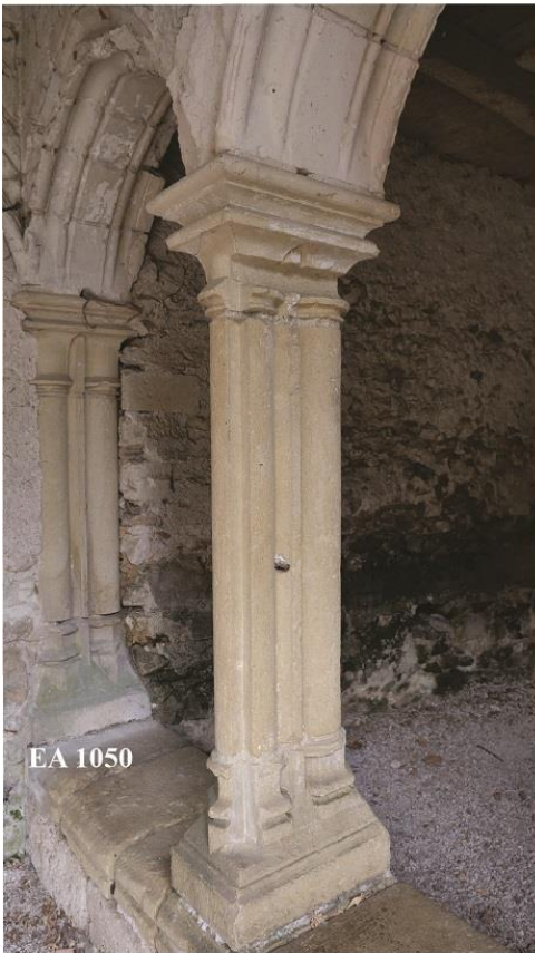
b. Mur-bahut est dans l'angle nord-est du cloître : colonnes à base prismatique
