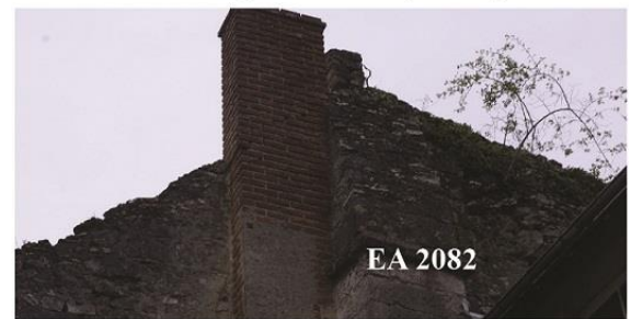
d. Contrefort dans l'angle sud-ouest (EA 2082)
