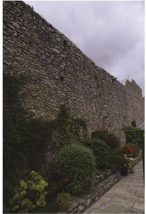
c. Enceinte monastique au sud-est (M 304)
