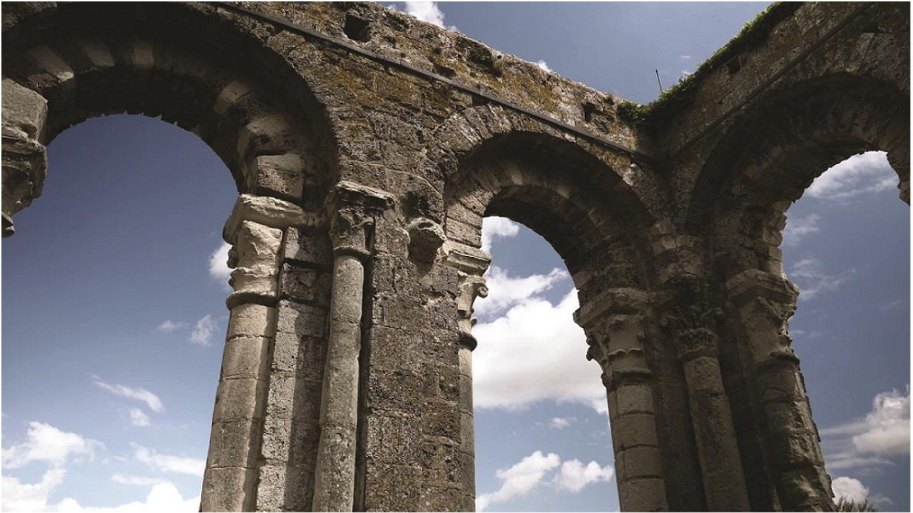
a. Façade intérieure du mur oriental de la tour Saint-Paul au troisième niveau. Vue de détail des arcs à double rouleaux
