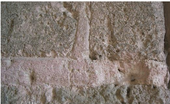
b. Maçonneries de la tour Saint-Paul. Pierre de taille en tuf karstique et joints rubanés rosâtres
