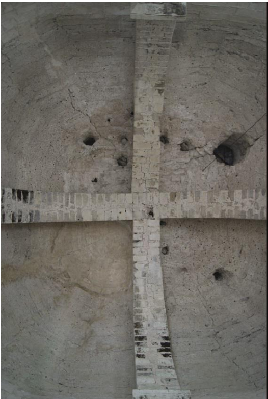
a. Vue de la coupole au premier étage
