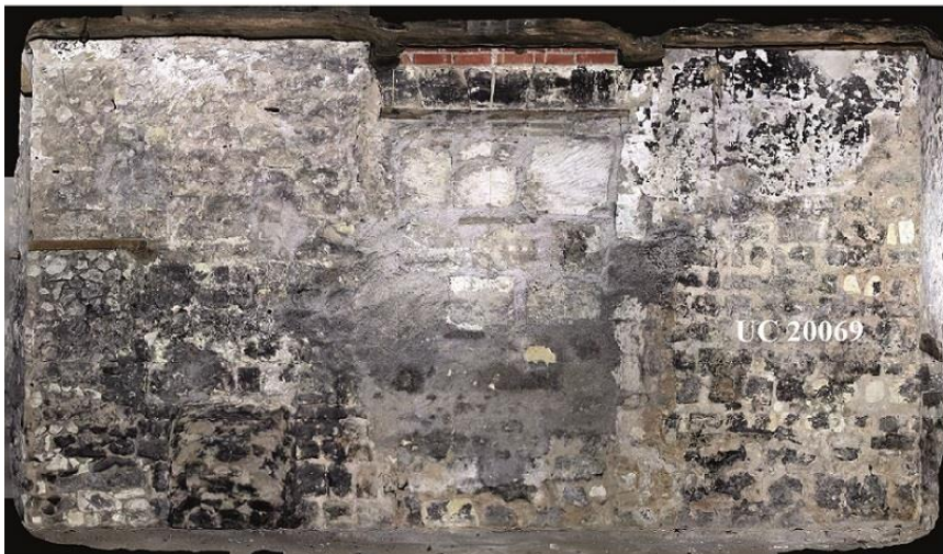
b. Vestiges romans du parement intérieur au rez-de-chaussée (M 231)
