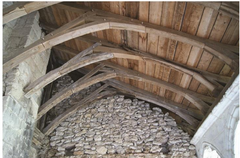
c. Charpente restaurée dans la galerie sud du cloître
