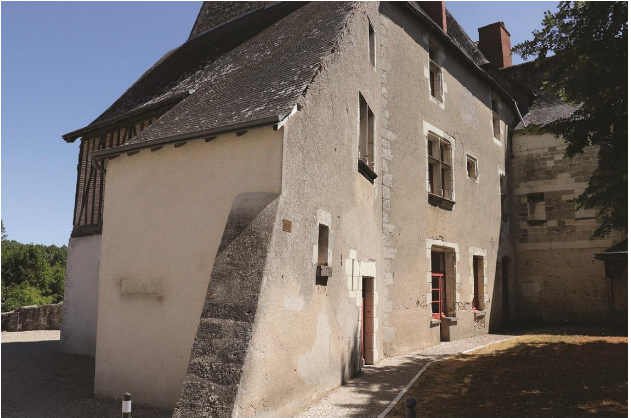
a. Logis abbatial vue depuis l'ouest
