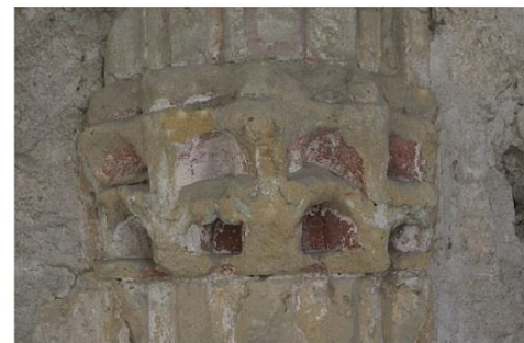
d. Vue détaillée des peintures sur le pilier 2002 (M 233)
