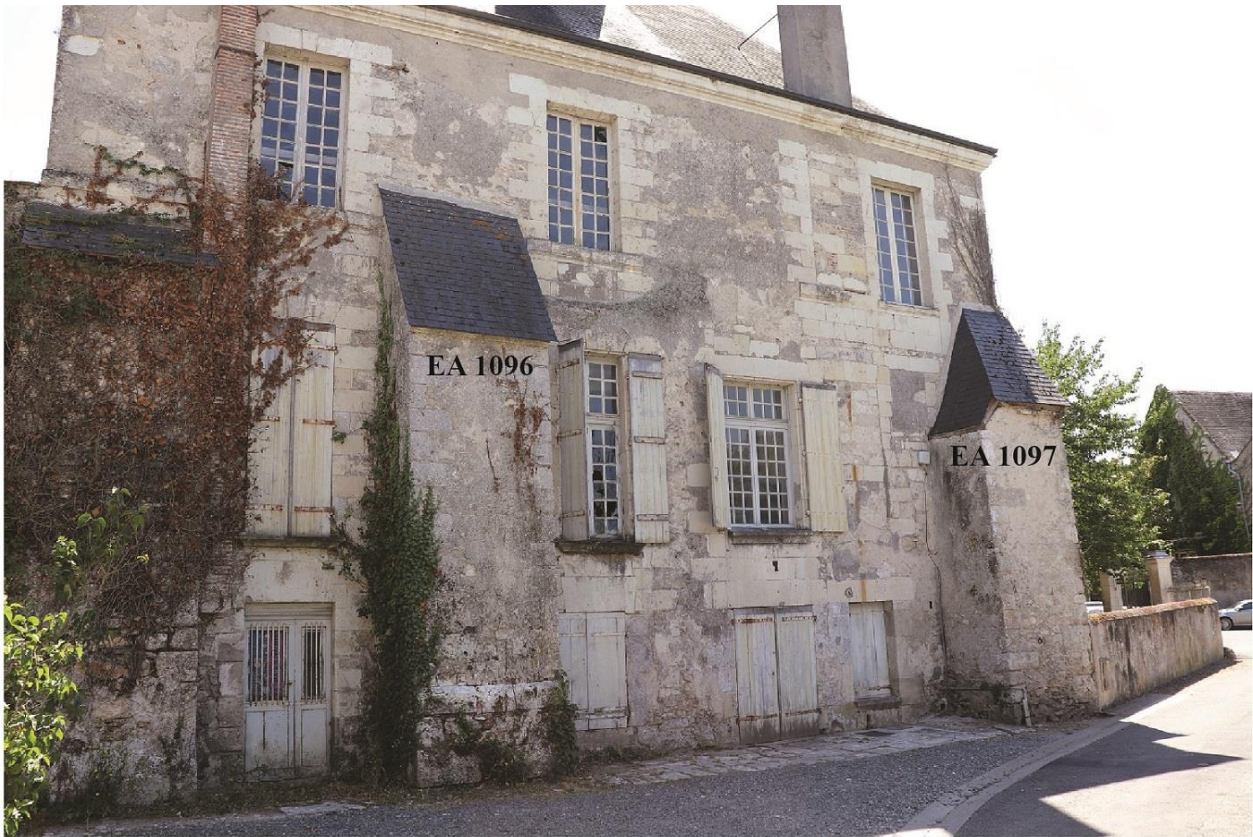
a. Logis Boyer et ses contreforts, vues depuis le nord
