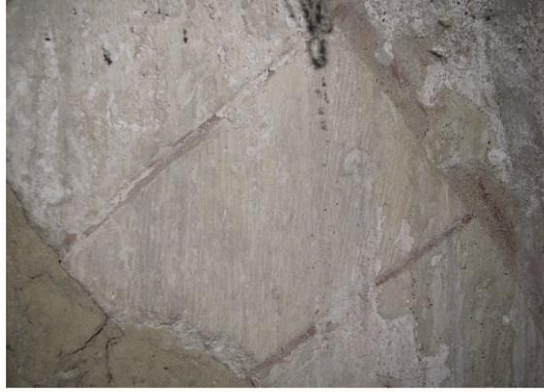
a. Revers du portail du collatéral sud de l'église (EA 2057) b. Vue détaillée du layage d'une pierre du portail
