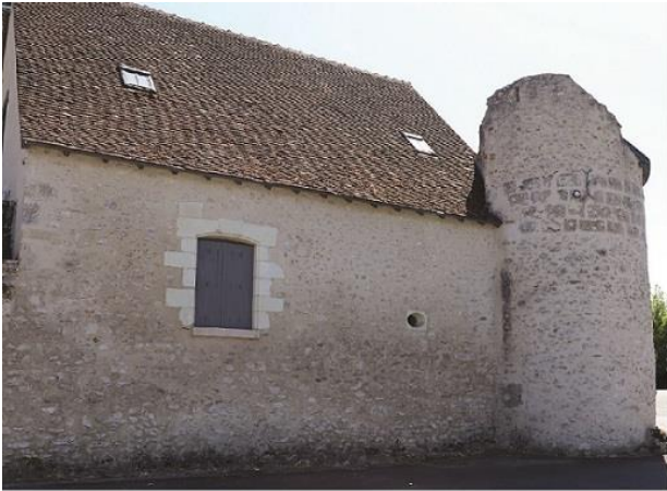
a. Tour nord-ouest de l'enceinte du bourg vue du nord
