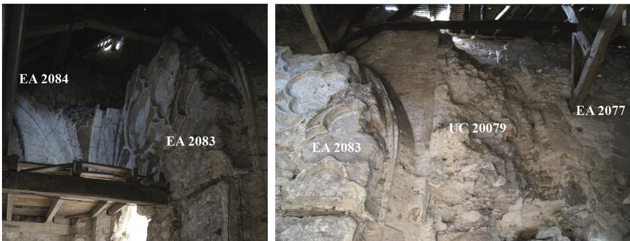
c. Vue détaillée des maçonneries arrachées (UC 20079)
