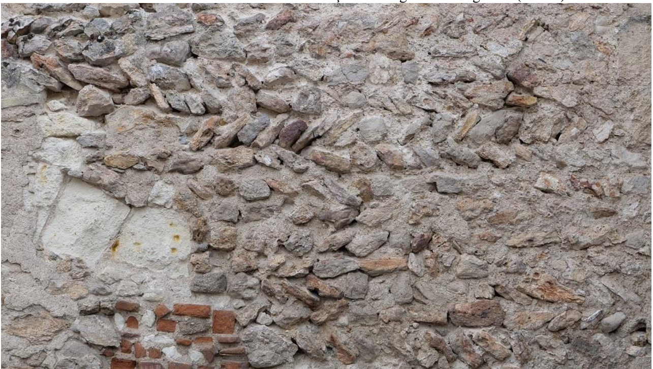
Illustration 4.13 – Mur occidental. Détails du parement en opus spicatum (M 201).
