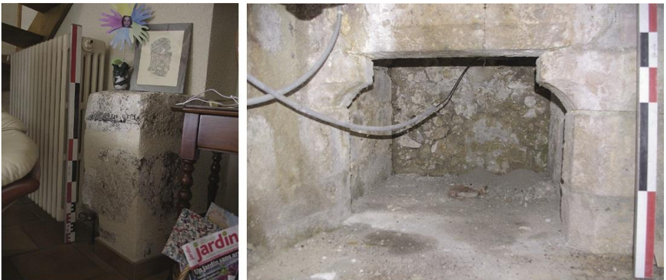
a. Contrefort dans le bâtiment des latrines b. Porte à linteau à chanfrein et lobes dans le bâtiment des latrines
