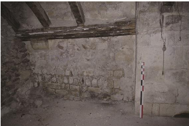
b. Vue de détail du parement du mur du collatéral nord de l'abbatiale depuis le sud (UC 20093)
