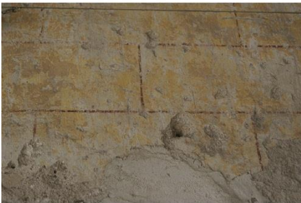
c. Vue détaillée de l'enduit peint du mur M 230 (UC 20075)
