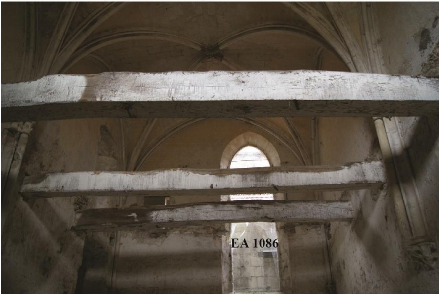
b. Vue de la porte d'accès au cloître depuis la porterie.
