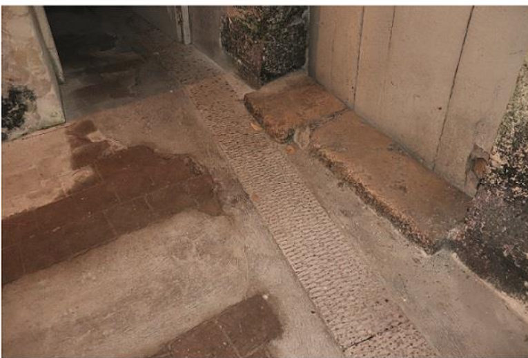
d. Canal d'évacuation devant les celliers dans le logis Boyer
