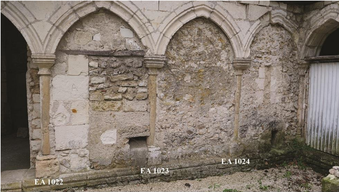
a. Mur-bahut sud dans l'angle sud-ouest du cloître : colonnes à base attique
