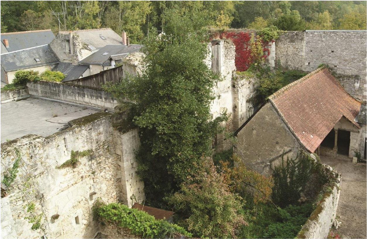
a. Bâtiment des celliers dans l'aile nord vue depuis l'ouest
