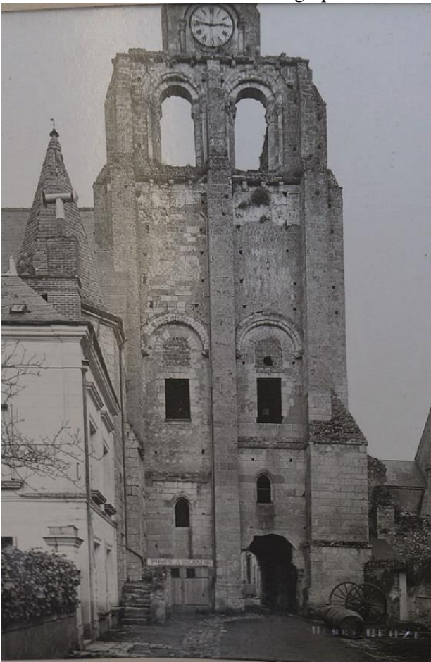
a. Photographie ancienne de la tour Saint-Paul vue de l'ouest (MAP, 81/37/242, cl. 24126)
