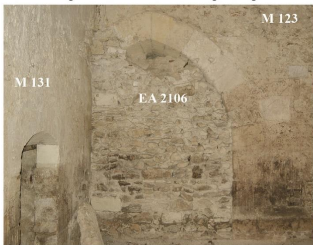
c. Vue de la porte d'accès au cloître depuis la porterie.
