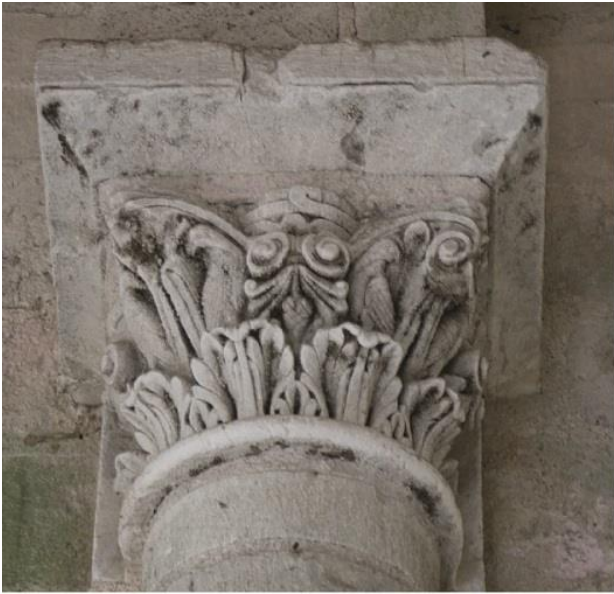
a. Chapiteau des colonnes engagées à dossieret
