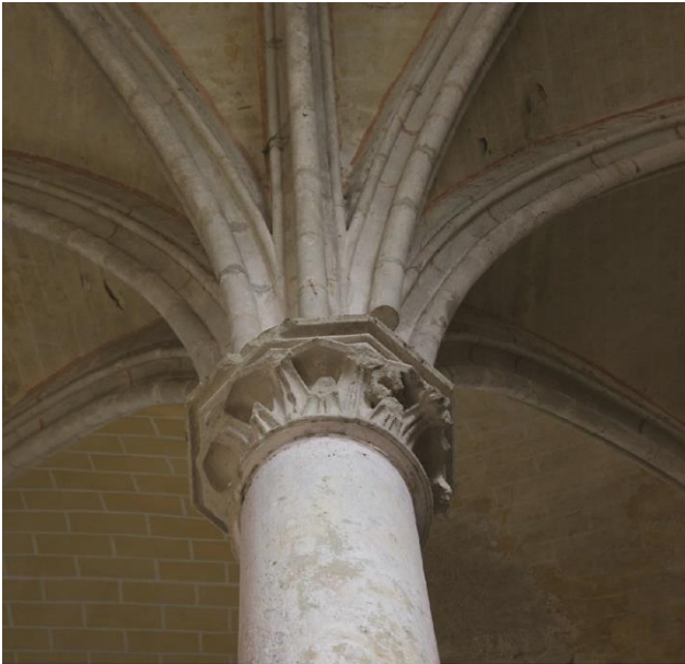
a. Supports et chapiteau à crochets du réfectoire
