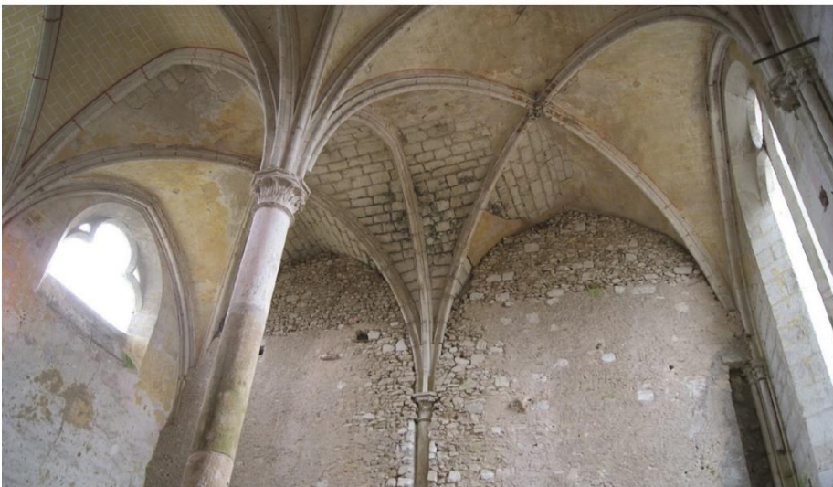
c. Vues des voûtes et colonnes dans les 4 e et 5 e travées du réfectoire
