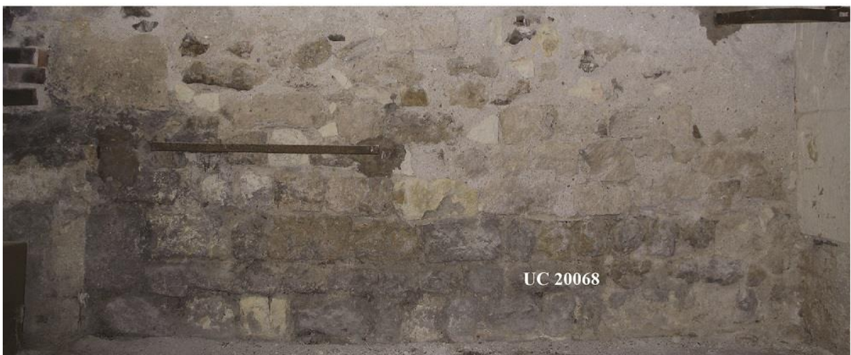
d. Ortho-image du parement extérieur du mur occidental du bras droit du transept en partie basse (M 231)
