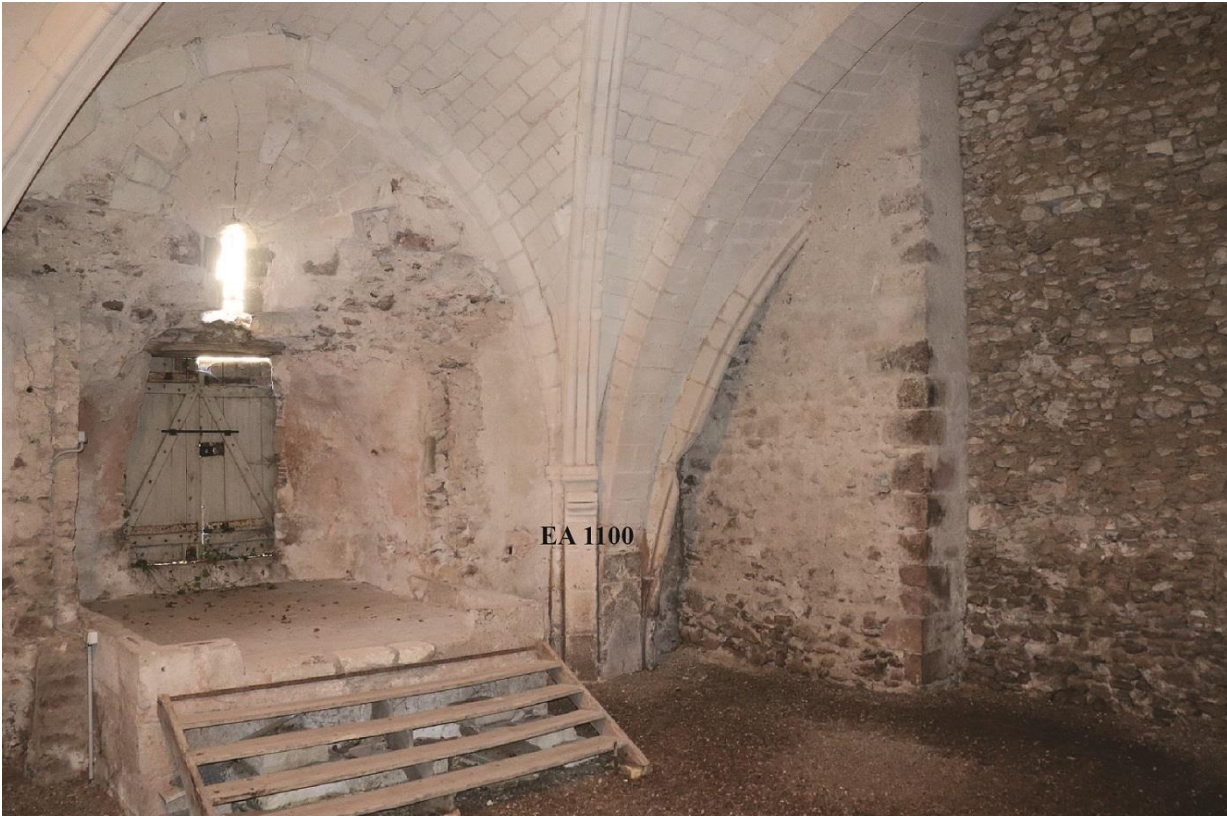
a. Bâtiment des celliers dans l'aile nord. Vue de l'intérieur de la première travée à l'ouest.
