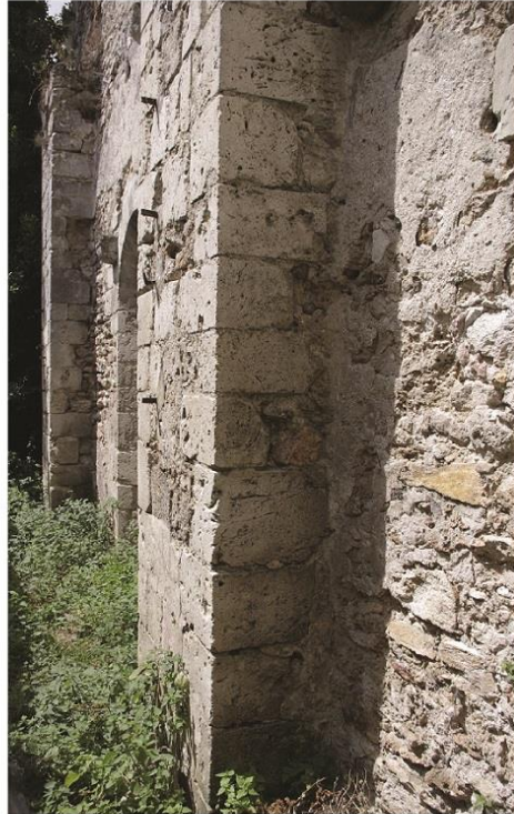
d. Contrefort. Mur sud des celliers
