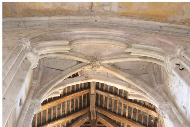
d. Vue détaillée des supports muraux de la chaire
