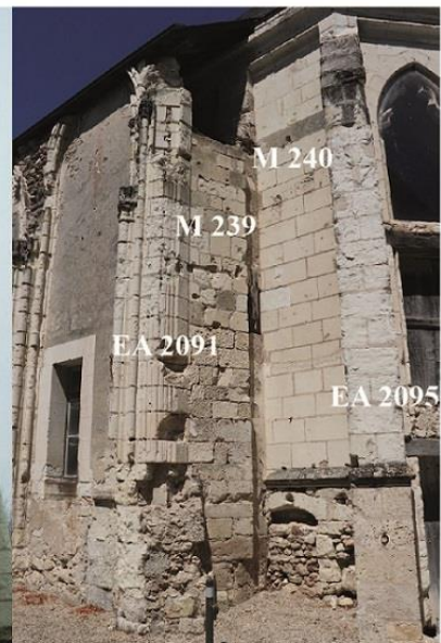
c. Angle sud-est de la chapelle.
