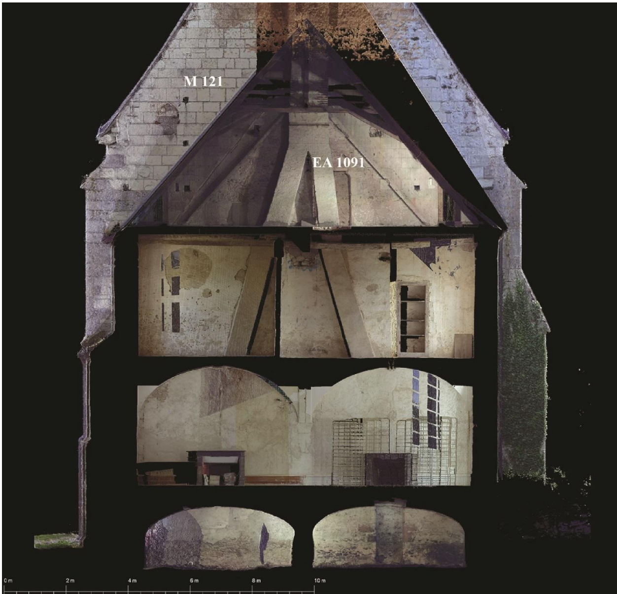
a. Face sud du bâtiment des anciennes cuisines vue de l'intérieur. Logis Boyer
