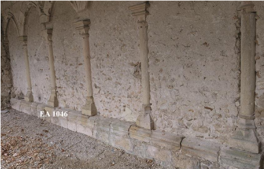
a. Mur-bahut nord dans l'angle nord-est du cloître : colonnes à base prismatique
