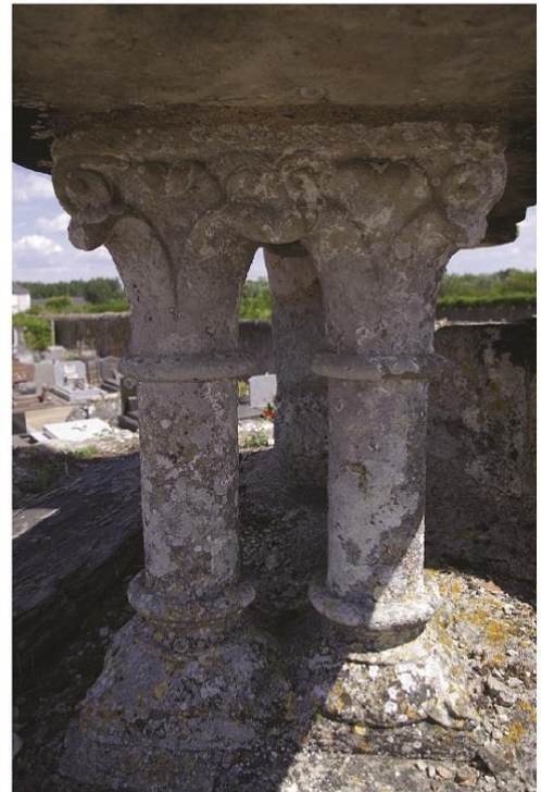
d. Colonnnettes supportant la dalle de pierre
