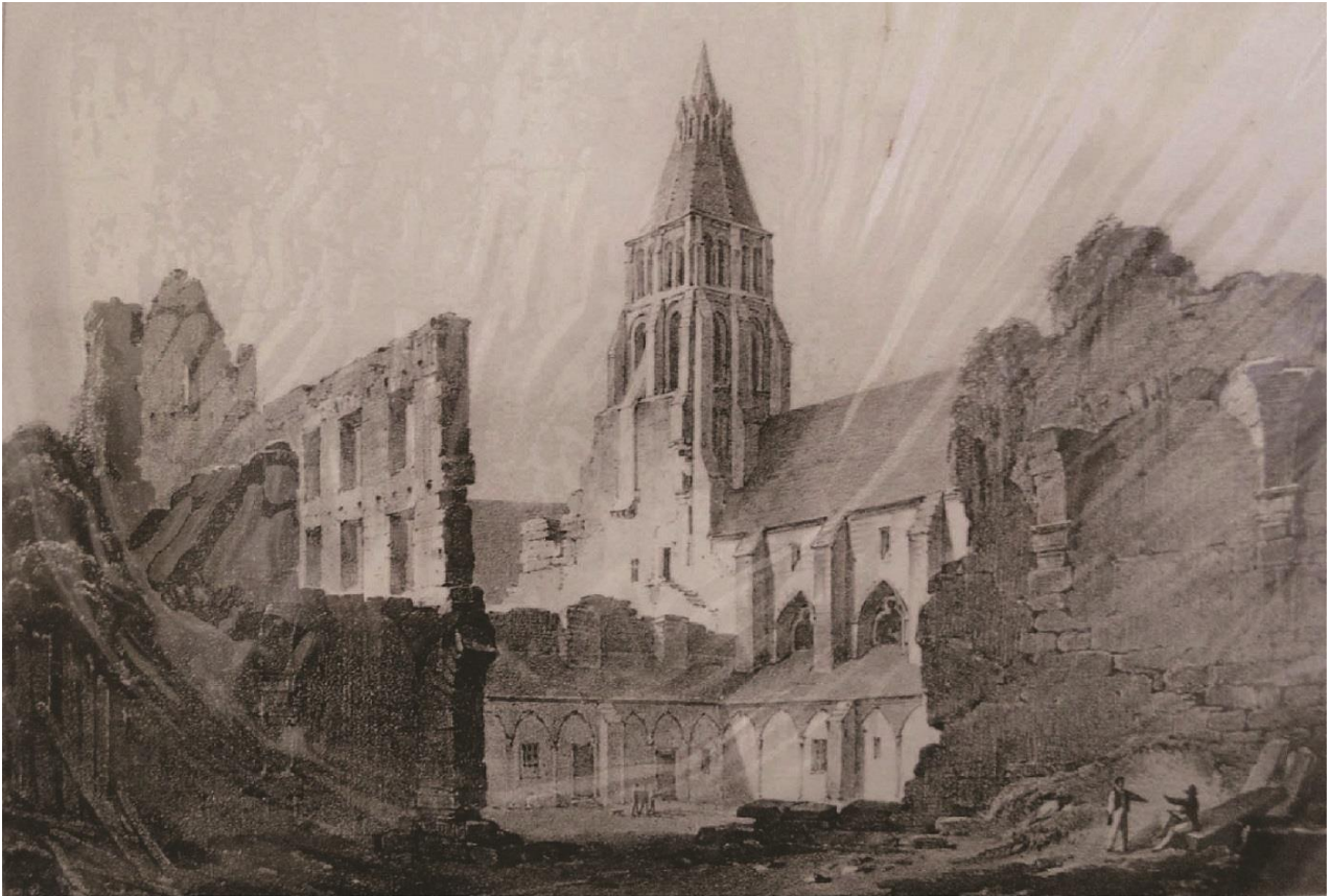
a. L'abbaye de Cormery en cours de démolition vers 1824. Lithographie de Langlumé (BnF)
