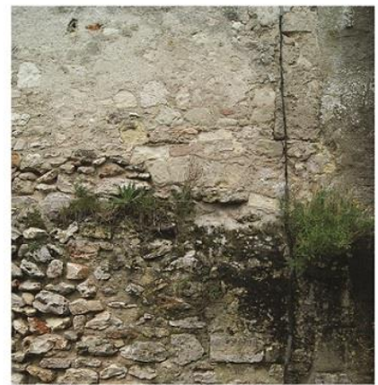
c. Vue de détail de la baie à claveaux (EA 2072)
