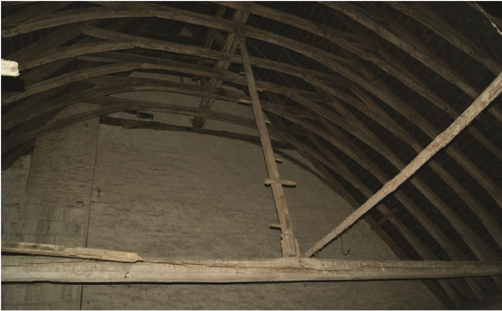
a. Vue des fermes de la charpente du réfectoire de Cormery
