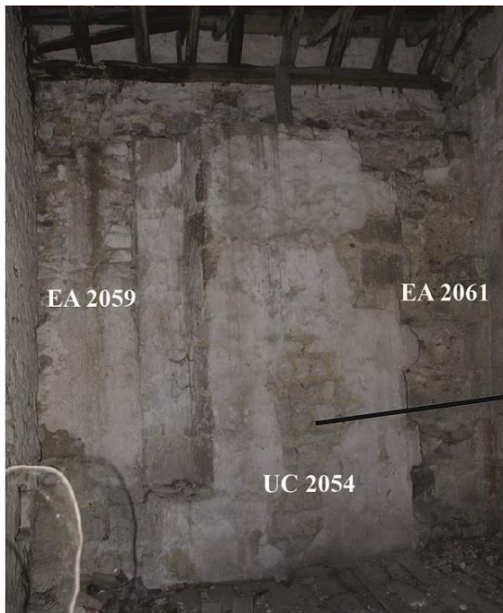
a. Mur gouttereau du collatéral sud.
