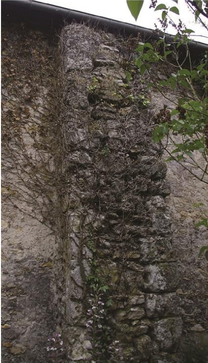
c. Contrefort. Mur nord des celliers
