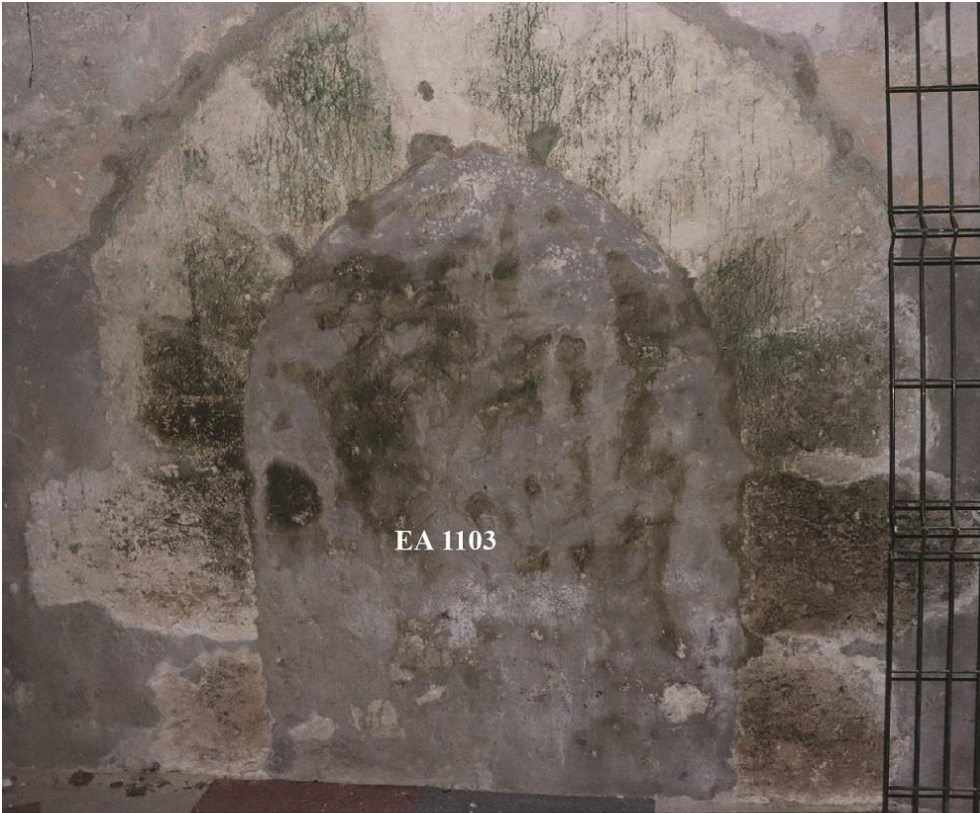
a. Porte septentrionale EA 1103. Mur ouest des celliers
