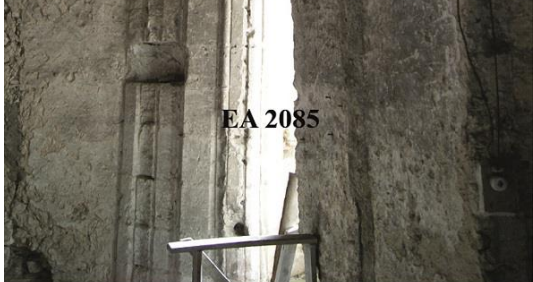
b. Réseau aveugle (EA 2083) et baies gothiques (EA 2085 et EA 2084). Mur 235 et 236
