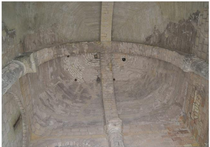
c. Coupole située au second niveau de la tour Charlemagne de Saint-Martin de Tours
