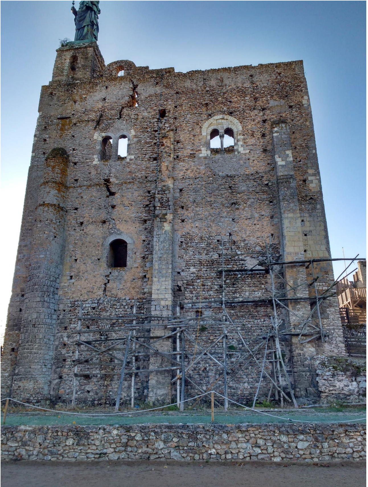
Illustration 4.18 - Tour maîtresse du château de Montbazou, vue du nord.
