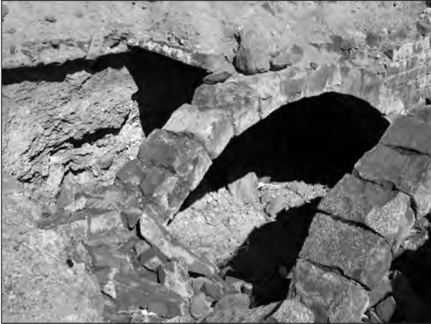
Figure 28 : Citerne collective de Karatin al-Kbir. Couverture de dalles de basalte sur arcs transversaux en enfilade.
