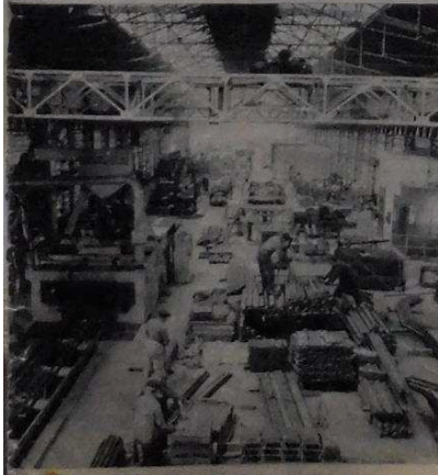
Le hall de montage de l'atelier wagons. A gauche, la grenailleuse, type « Sisson Lehmann », où toutes les pièces doivent passer obligatoirement.
