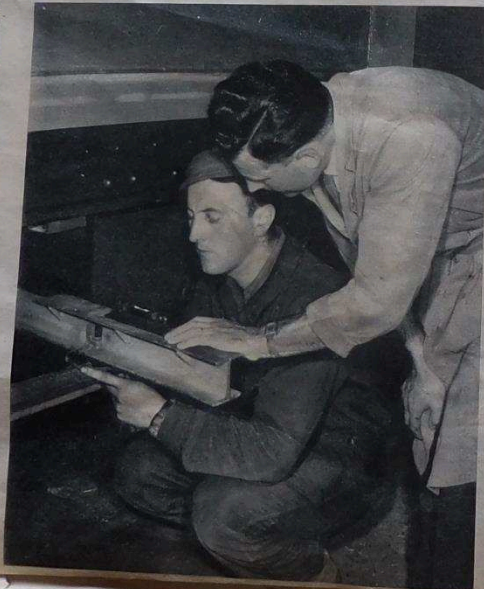
Vérification du gauche de l'ensemble du châssis avant soudure, afin de rétablir les « vrillages ». La tolérance est de 3 mm.
