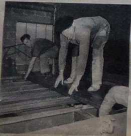
Mise en place du plancher.
