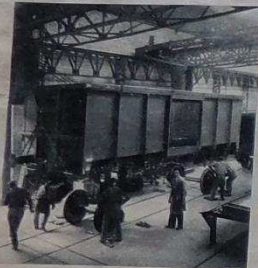
Mise sur roues de la caisse. Les 1 000 wagons de ce marché sont équipés par moitié, de boîtes SKF et Athermos.
