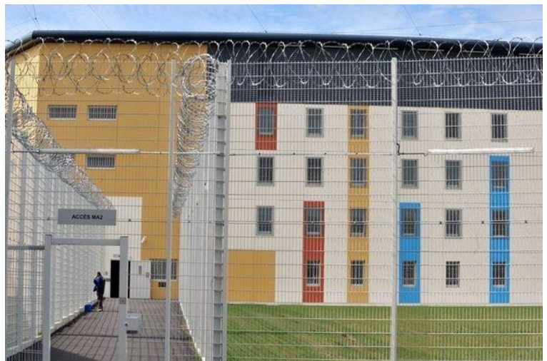
Figure 2 – Vue de la cour principale de la maison d'arrêt de Tormeilles (plaquette éditée lors de la livraison de l'établissement par Agence publique pour l'immobilier de la justice)
