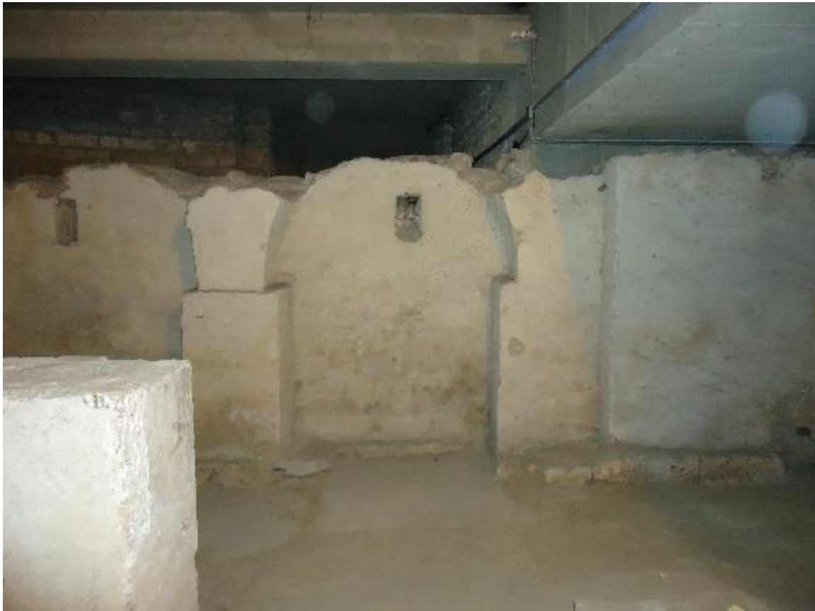
Figure 680 Première travée occidentale, côté sud
