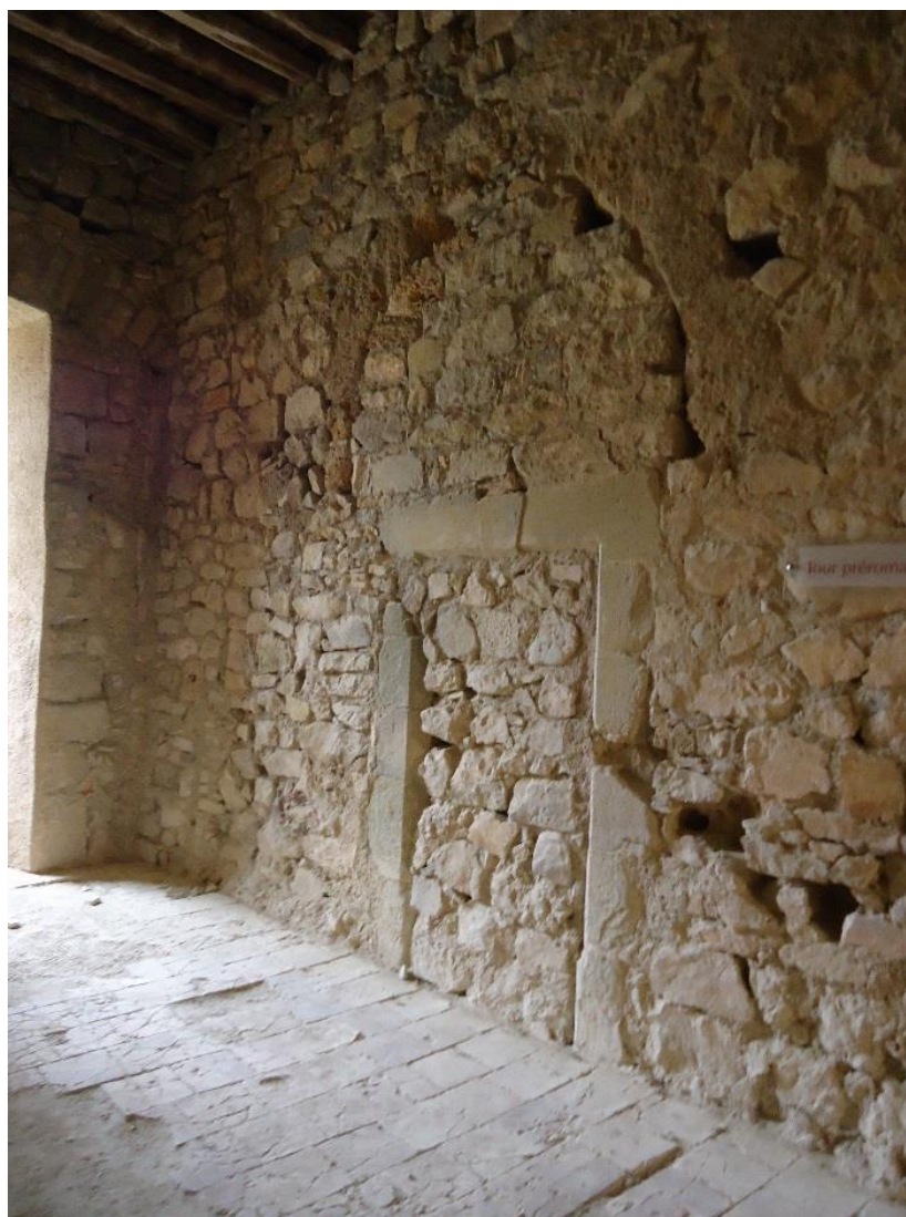
Figure 417 La porte bouchée au premier étage de la tour
