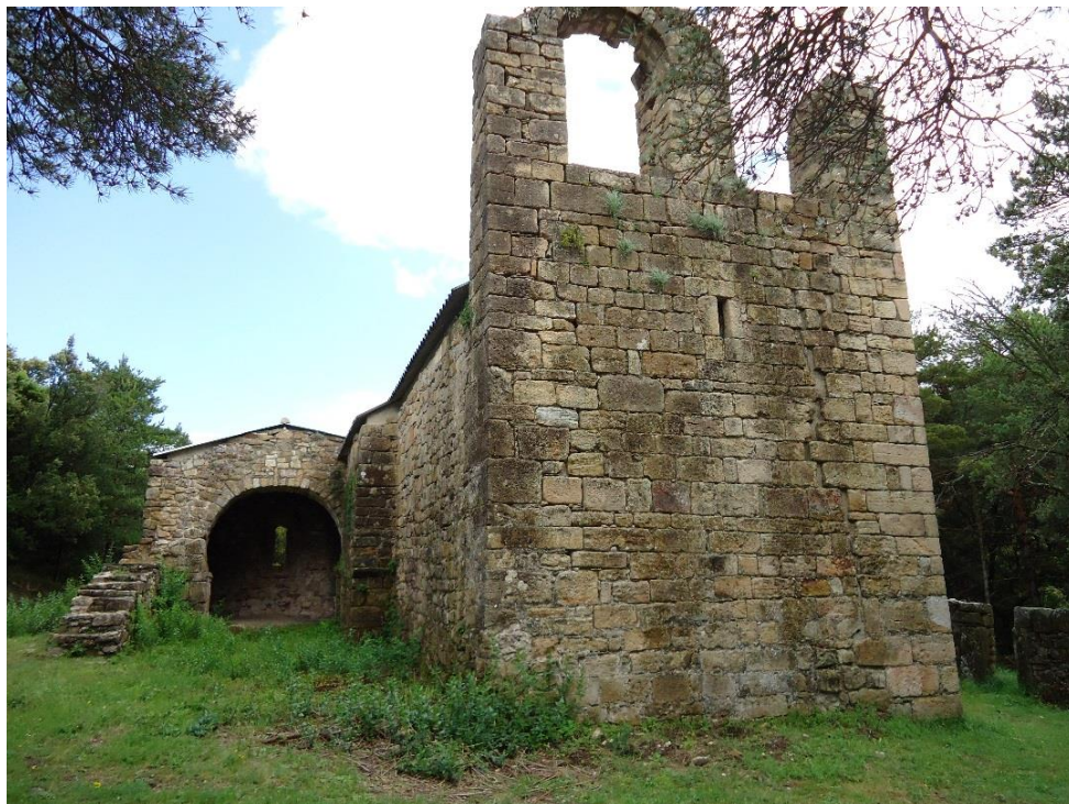
Figure 6 Vue de l'ensemble des deux églises
