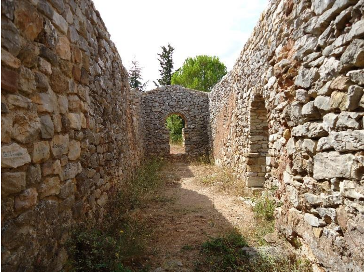
Figure 180 Vue de la nef depuis le chevet
