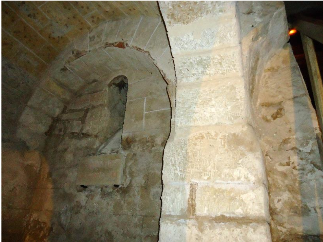
Figure 480 Bas-côté nord, première travée orientale
