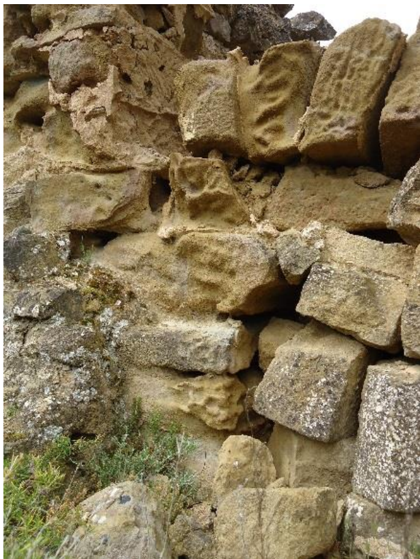
Figure 164 Arc triompal, piédroit sud avec imposte, sommier et claveaux tombés
