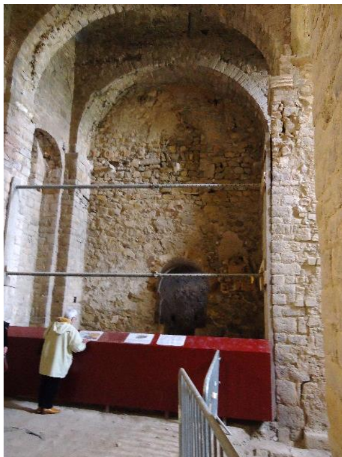
Figure 414 Le bras nord du transept roman de l'abbaye avec la porte en champignon de la tour dite préromane
