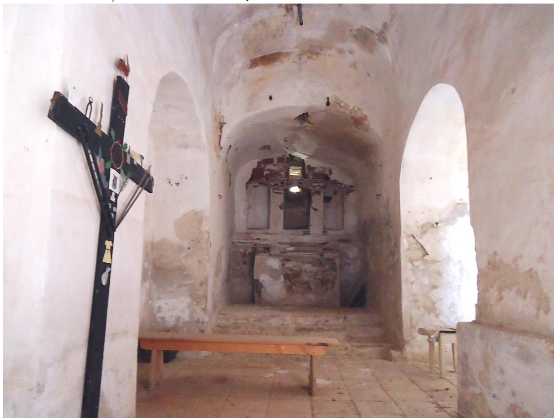
Figure 59 Vue de la nef d'ouest en est
