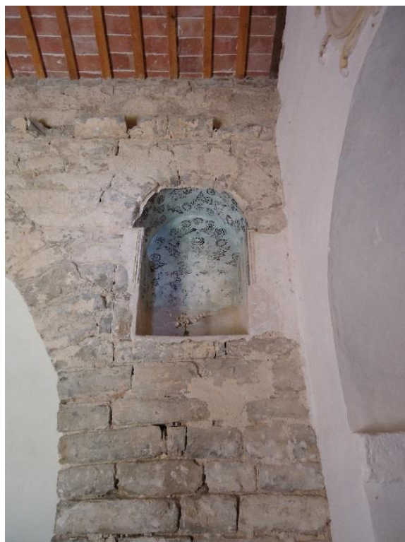
Figure 28 Vue d'une niche en arc en champignon
