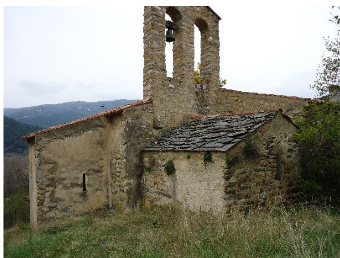
Figure 57 Vue extérieure sud-est
