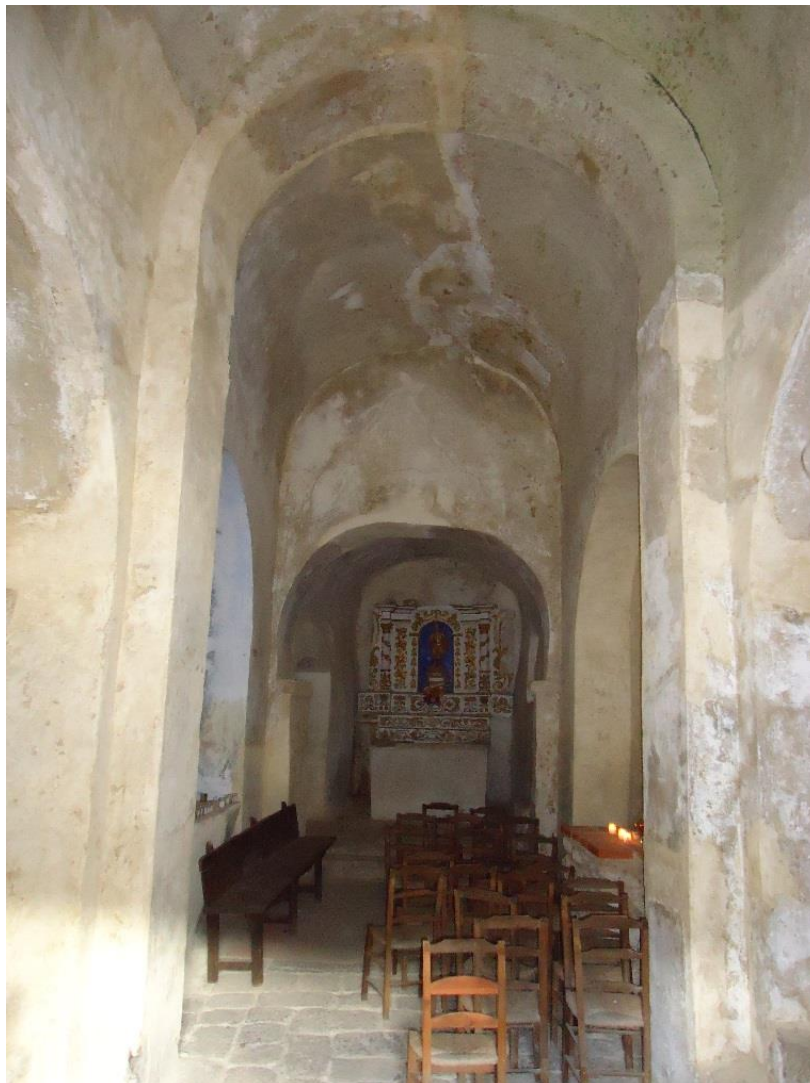
Figure 511 Vue de la nef d'ouest en est
