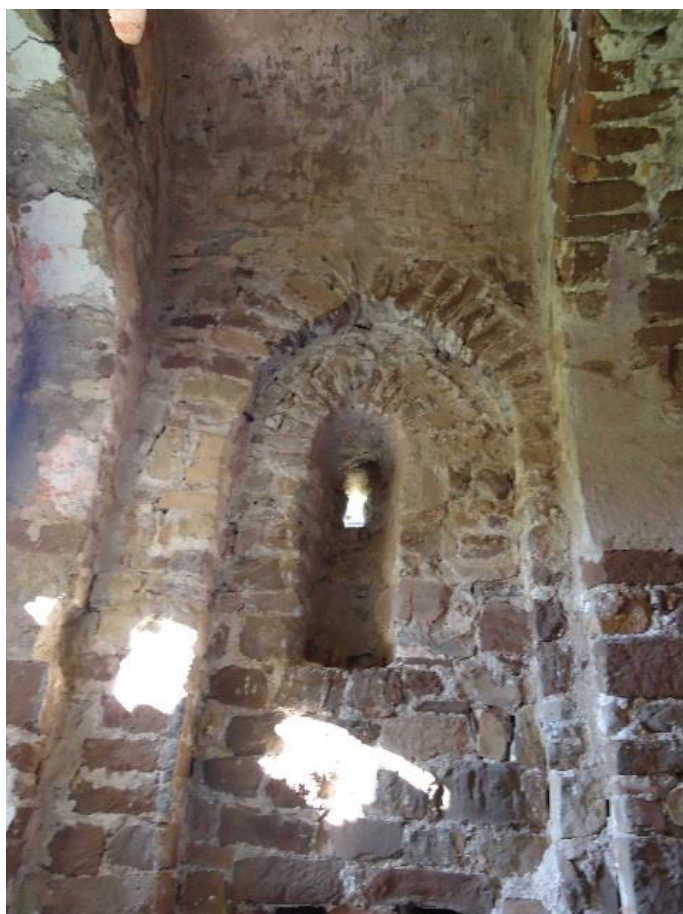
Figure 644 Transept surélevé sur les murs latéraux épaissis, au fond la fenêtre méridionale
