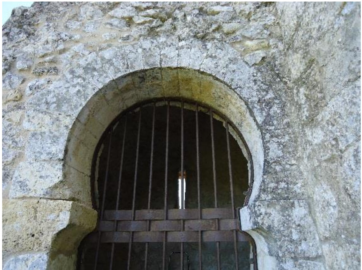
Figure 575 L'arc triomphal avec ses impostes saillantes
