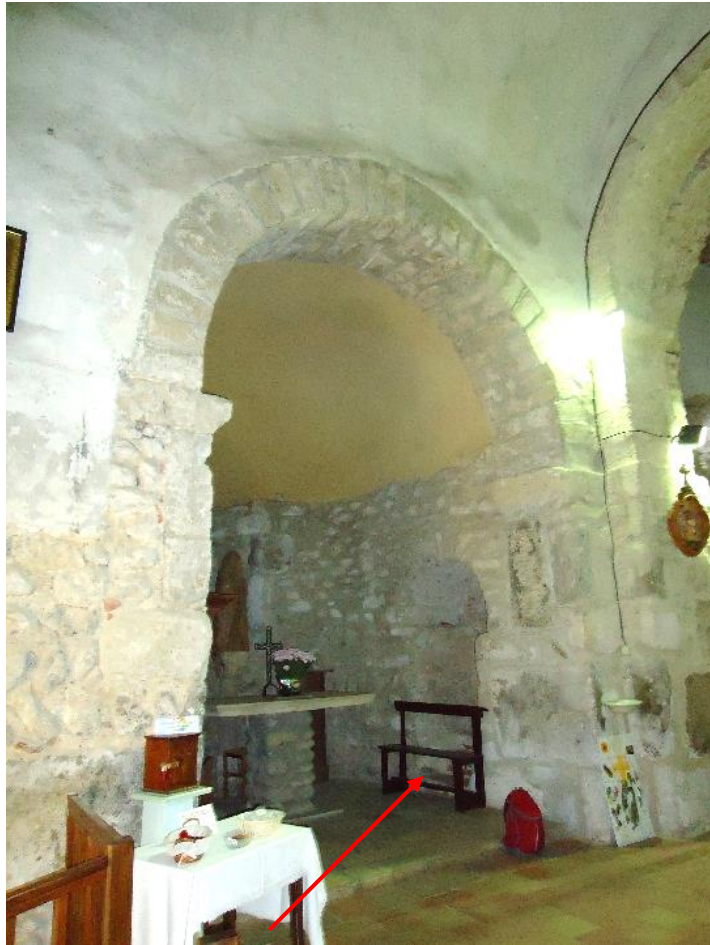
Figure 657 Vue de l'absidiole nord avec le passage vers l'abside principale
