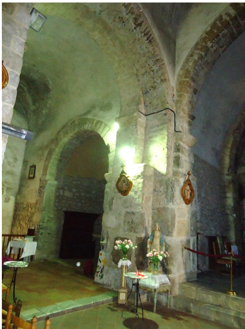
Figure 660 Piliers des arcs doubleaux et des arcs triomphaux, voûte du bras nord du transept
