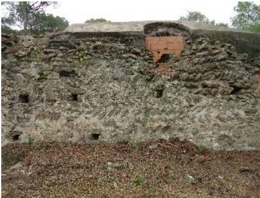
Figure 375 Mur nord de la nef
