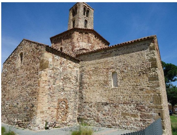
Figure 779 Chevet de Santa Maria, vue sud-est
