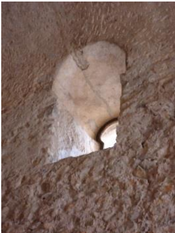
Figure 110 Fenêtre sud, nef centrale
