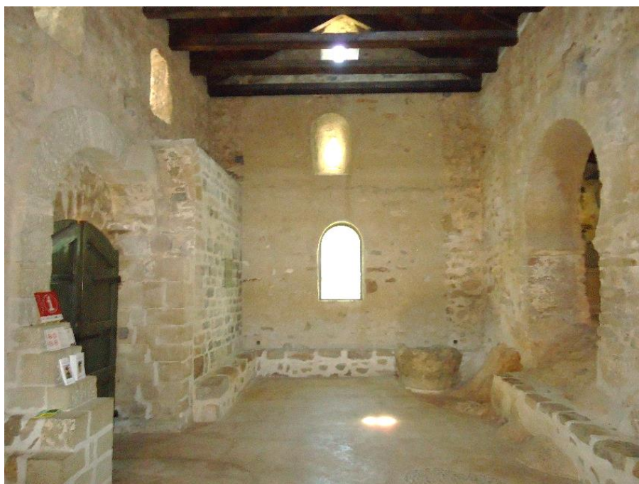
Figure 198 Vue de la nef depuis le chevet
