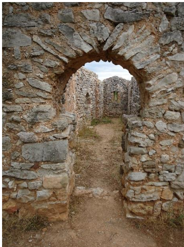
Figure 181 Porte occidentale, extérieur
