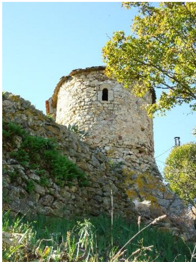
Figure 55 Vue extérieure de l'abside avec sa baie axiale
