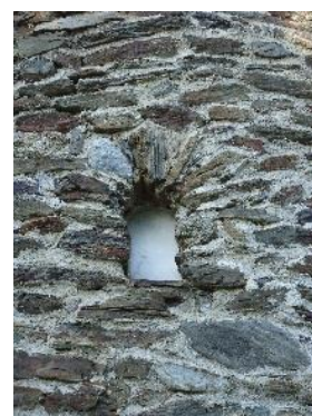
Figure 352 Baie, façade ouest
