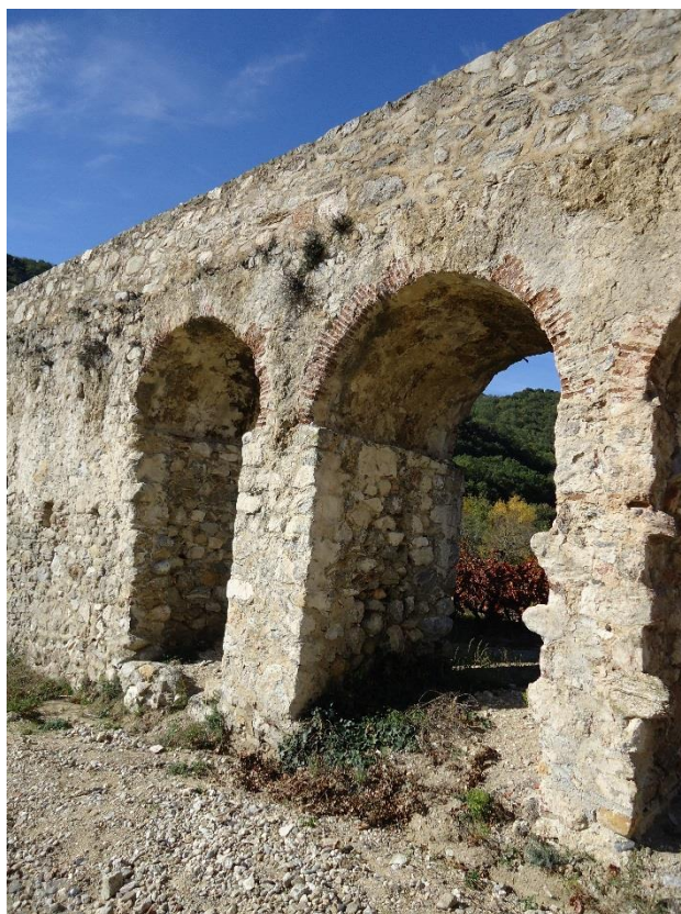
Figure 36 Détail de la section en arc en champignon de l'aqueduc d'Ansignan
