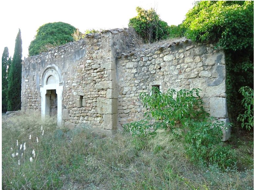
Figure 117 Vue extérieure sud-est
