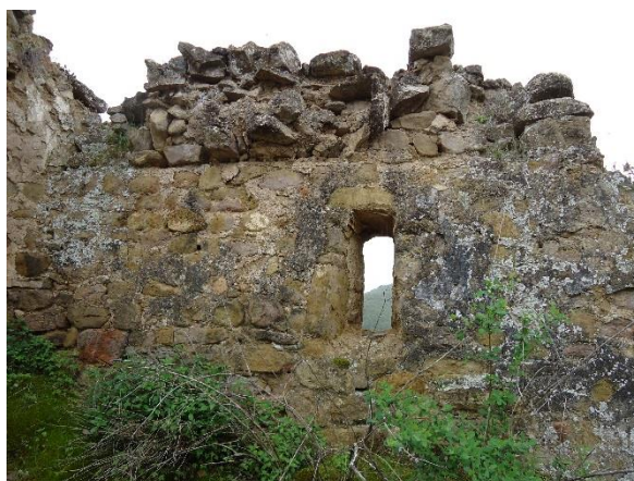
Figure 166 Mur sud avec sa fenêtre, côté intérieur
