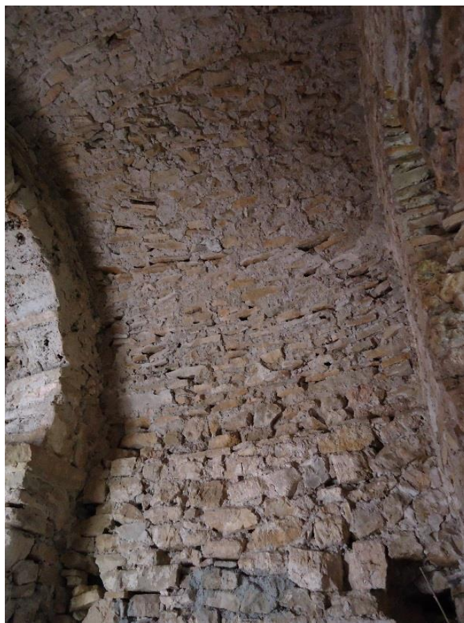
Figure 86 Voûte du chevet sur banquette
