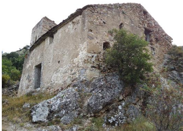
Figure 224 Vue extérieure nord-ouest
