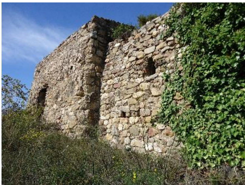
Figure 398 Vue extérieure sud-est
