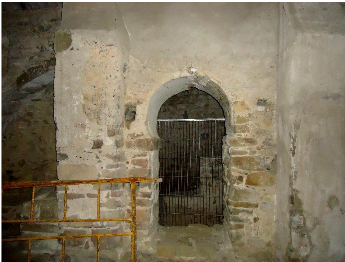
Figure 308 L'ouverture du bras nord du transept
