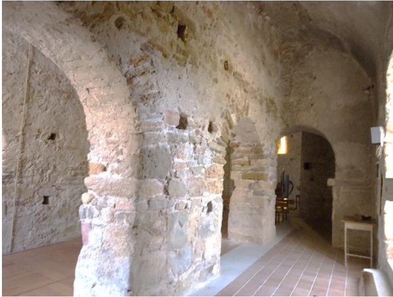
Figure 103 Vue du bas-côté sud
