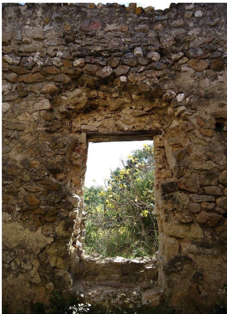
Figure 403 Porte méridionale, vue intérieure
