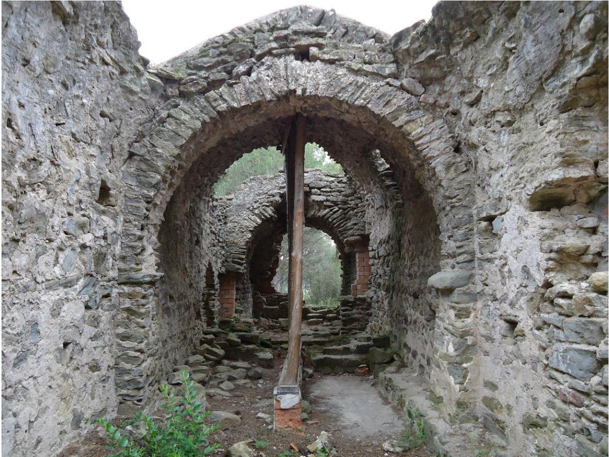
Figure 368 Vue de la nef depuis l'ouest
