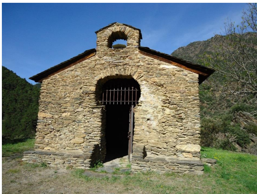
Figure 9 Vue extérieure après la reconstruction
