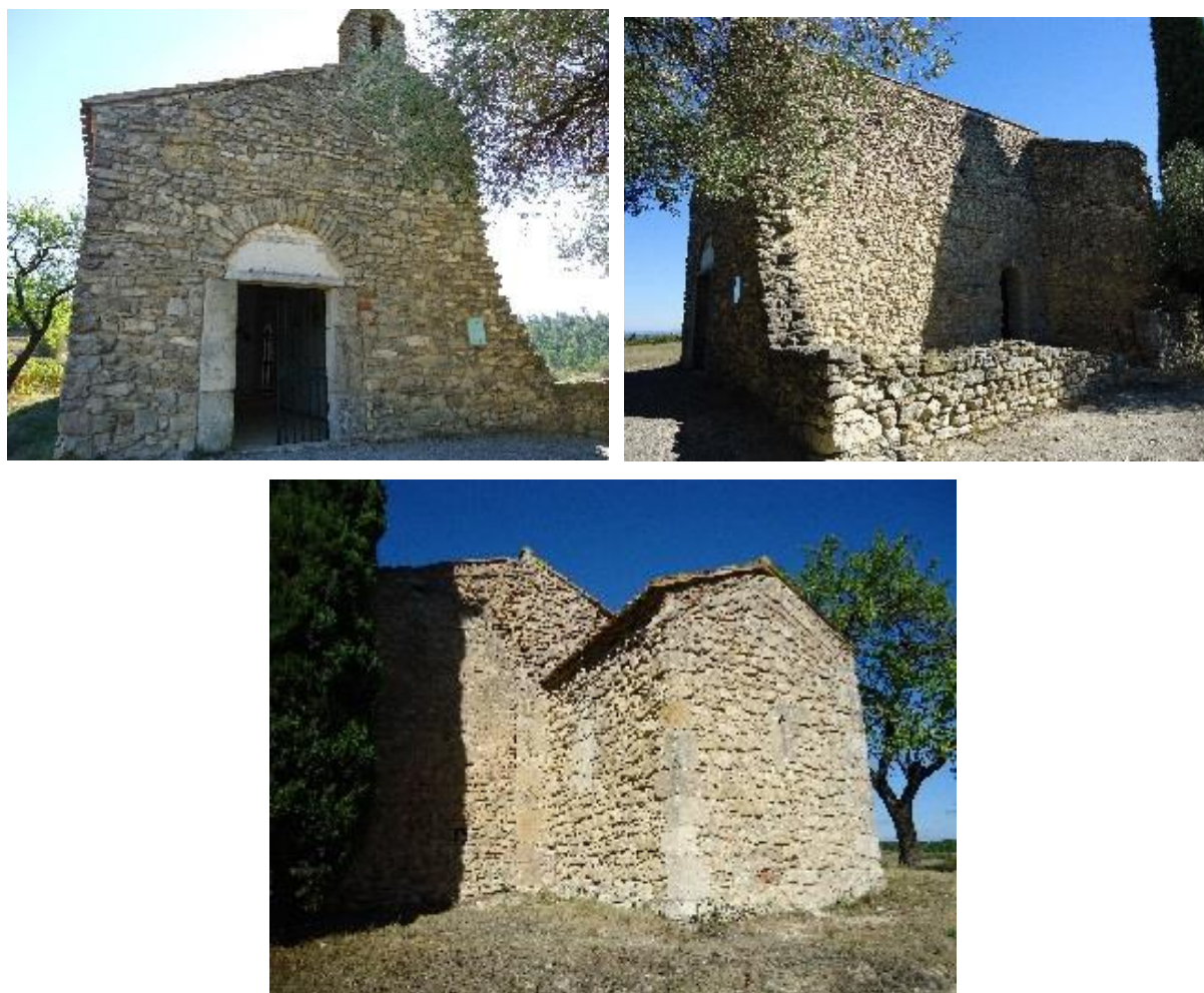
Figure 547- 548- 549 Vues ouest, sud et est
