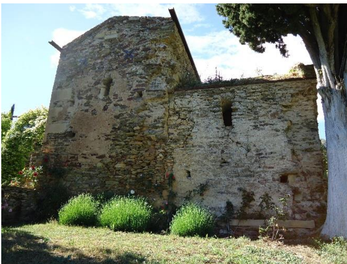
Figure 389 Vue sud: chevet et transept surélevé, nef disparue
