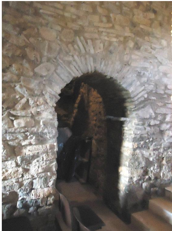
Figure 273 Porte du clocher-tour dans le mur nord de la nef
