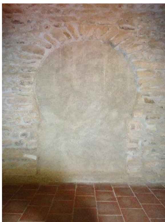
Figure 262 Porte murée du vaisseau nord, intérieur
