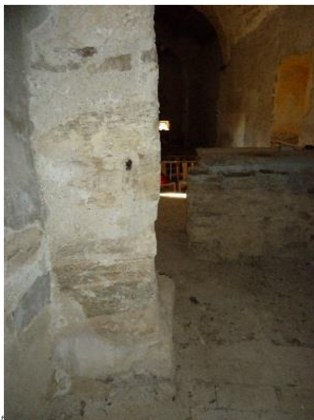
Figure 48 Piédroit méridional de l'arc triomphal
