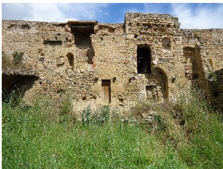
Figure 591 Façade méridionale de l'église, incorporée dans le château
