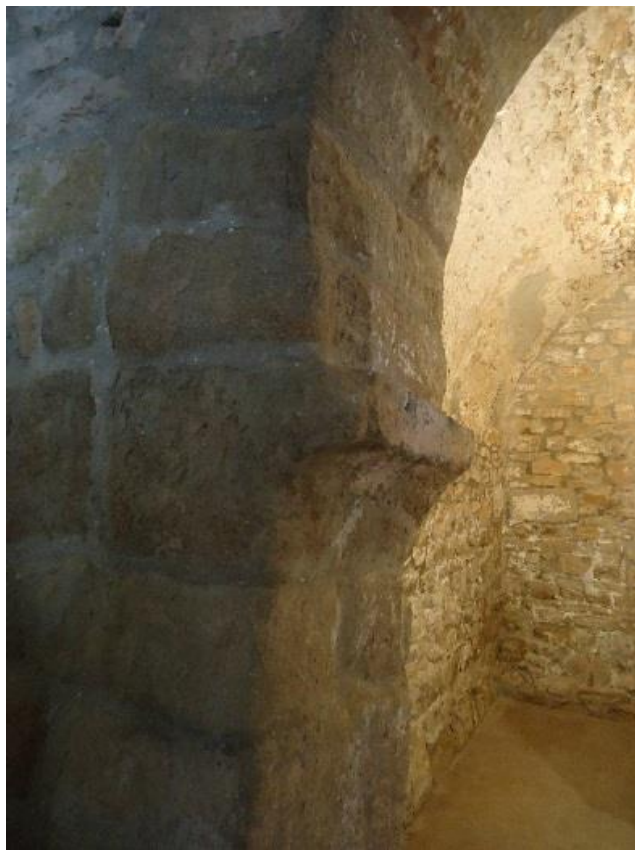
Figure 539 Piédroit nord de l'arc triomphal
