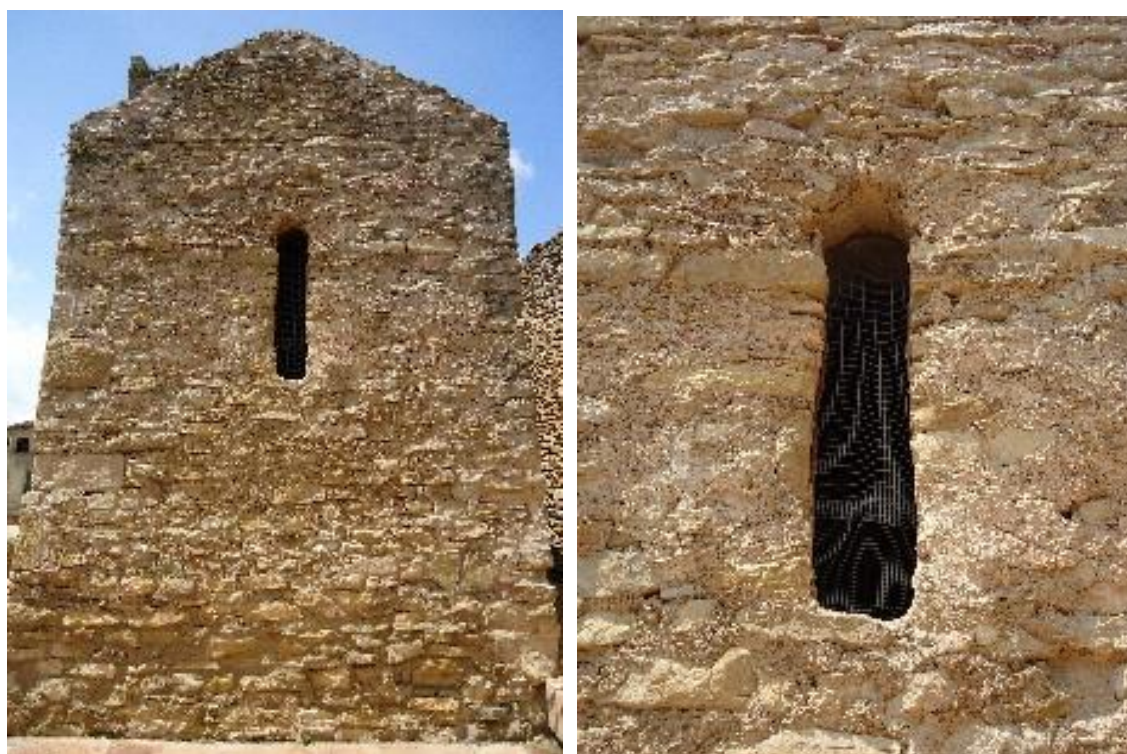
Figure 610 Façade orientale du chevet avec son baie
