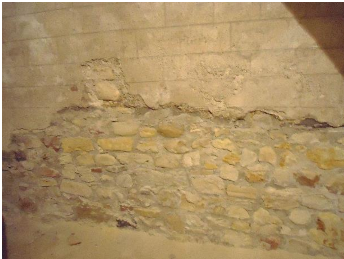
Figure 483 L'appareil primitif au-dessous de l'enduit moderne
