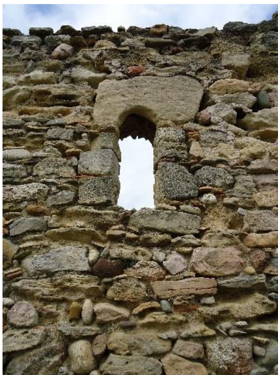
Figure 176 Fenêtre du mur sud de la nef, extérieur
