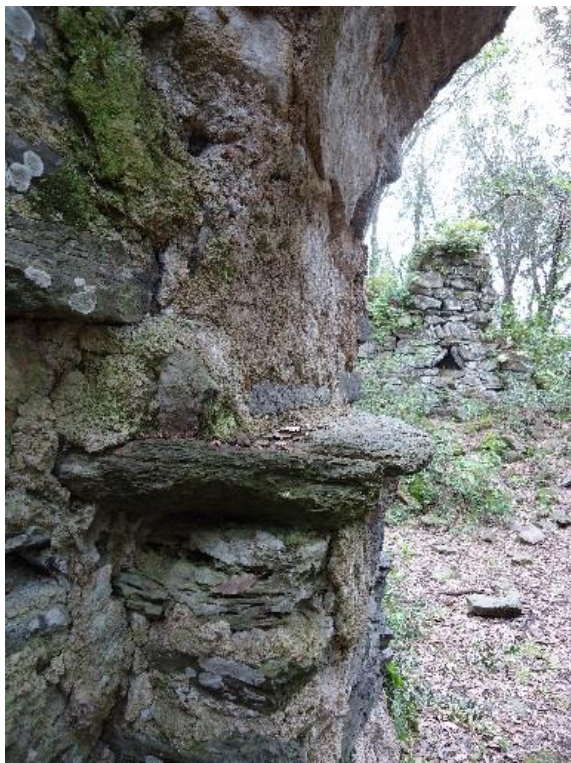
Figure 152 Détail du piédroit sud de l'arc triomphal
