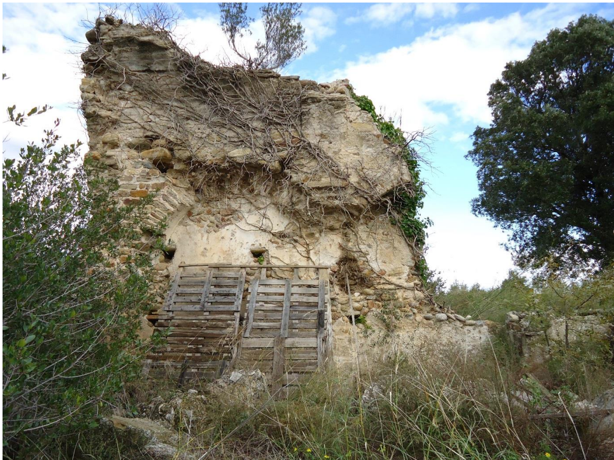
Figure 772 Vestiges, mur nord, intérieur
