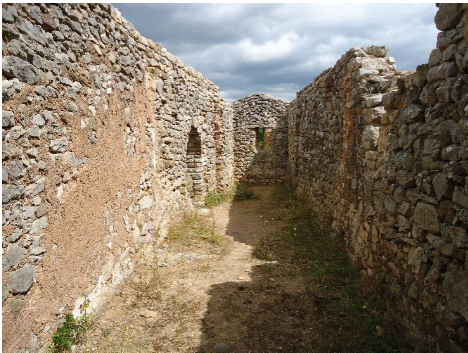
Figure 179 Vue de la nef depuis l'ouest
