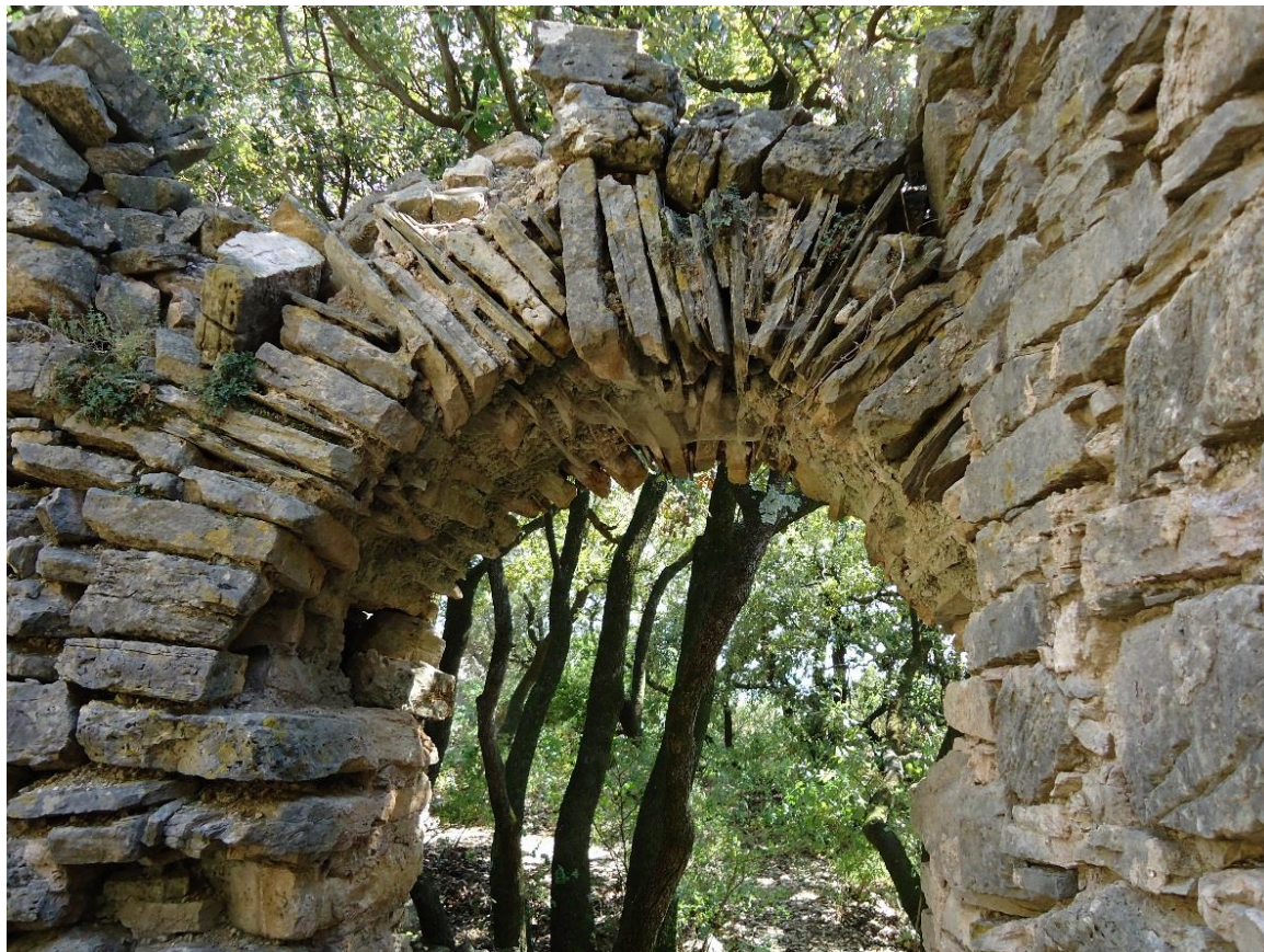
Figure 798 Claveaux en lamelles étroites
