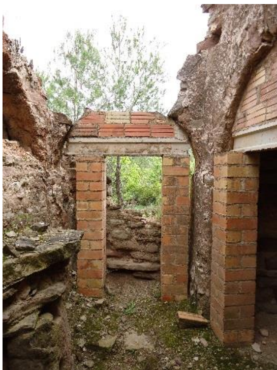
Figure 76 Vue de l'arc latéral est
