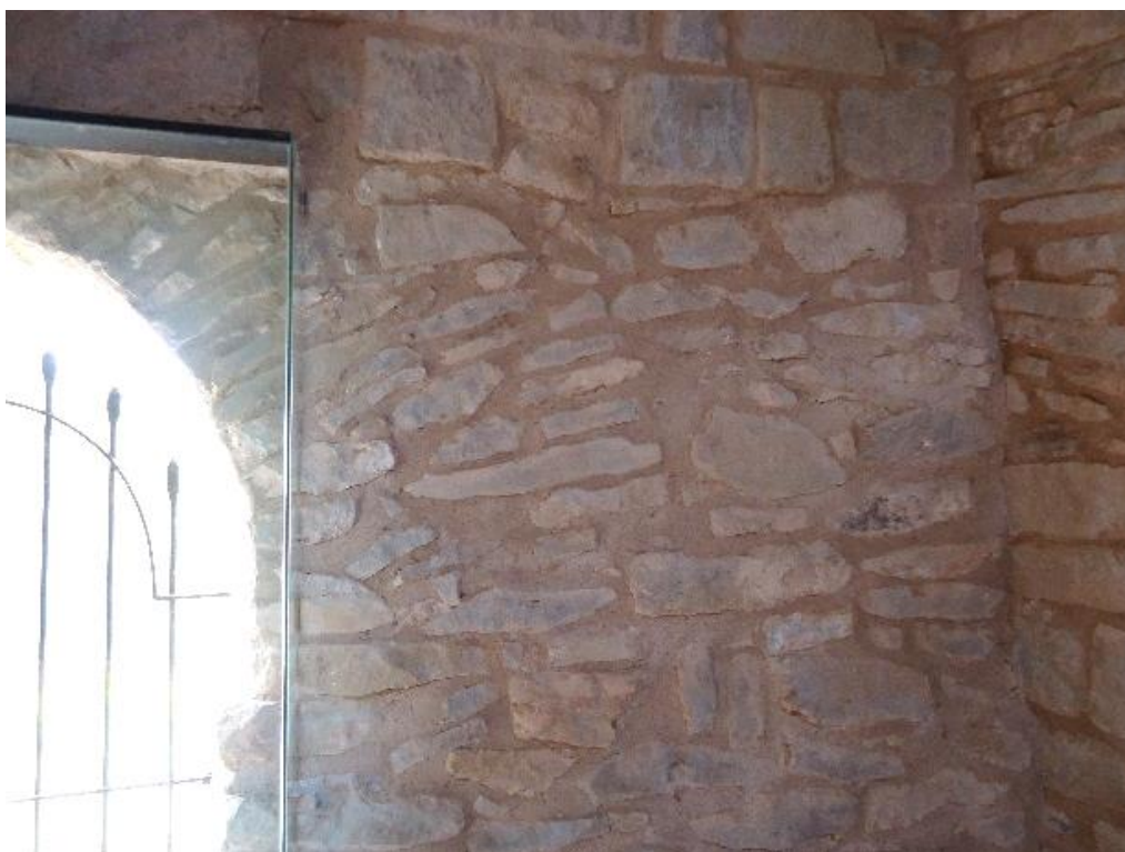
Figure 237 Porte nord, intérieur, détail de la maçonnerie
