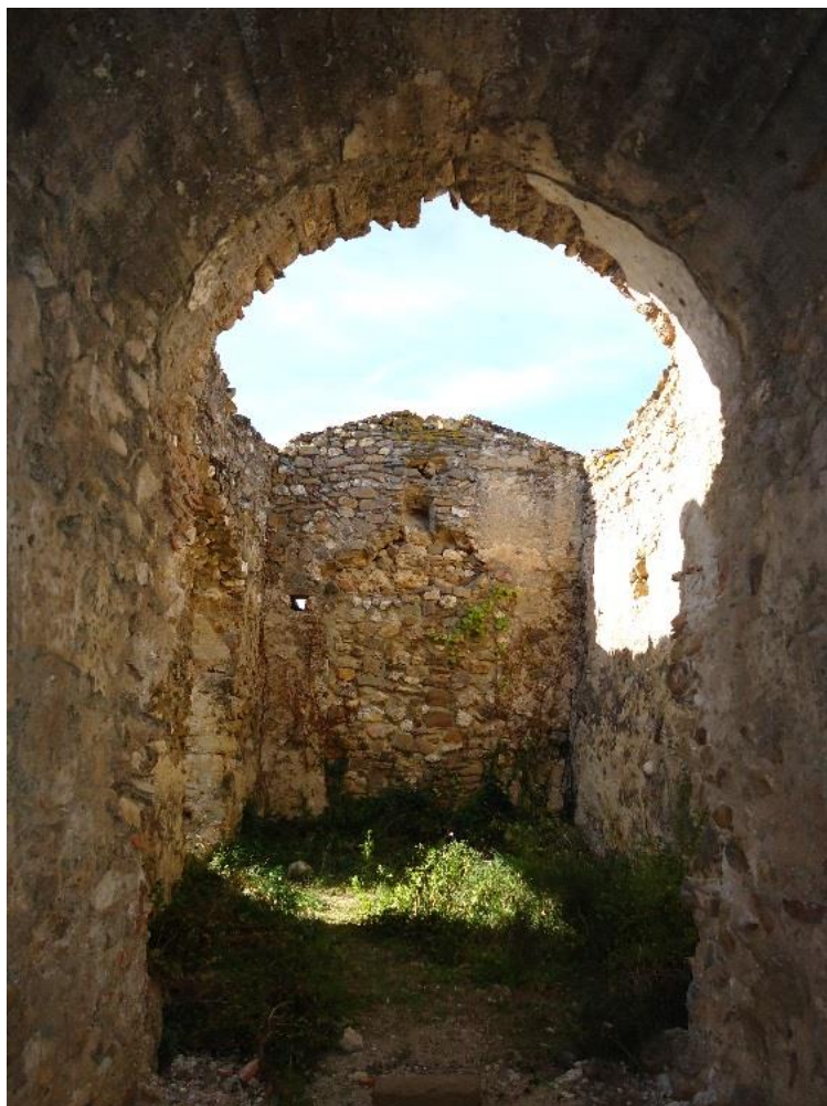
Figure 401 Vue de la nef depuis le chevet
