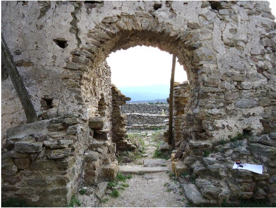
Figure 92 Vue de la porte méridionale depuis le nef
