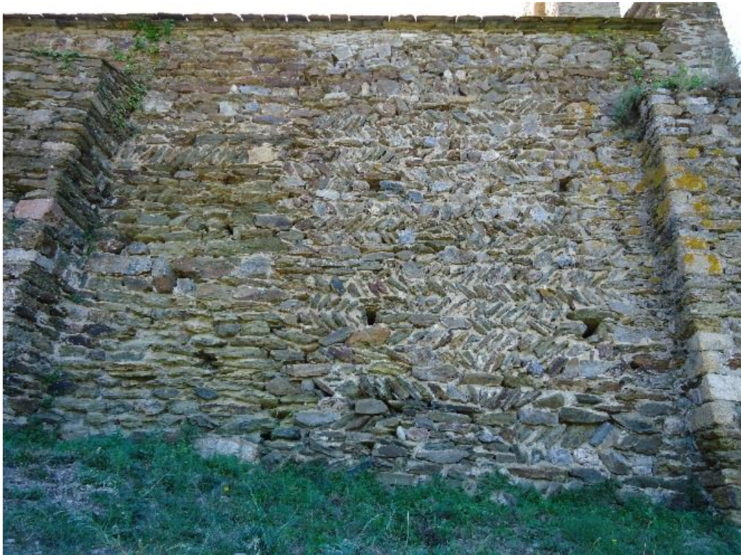
Figure 284 Détail de la façade nord
