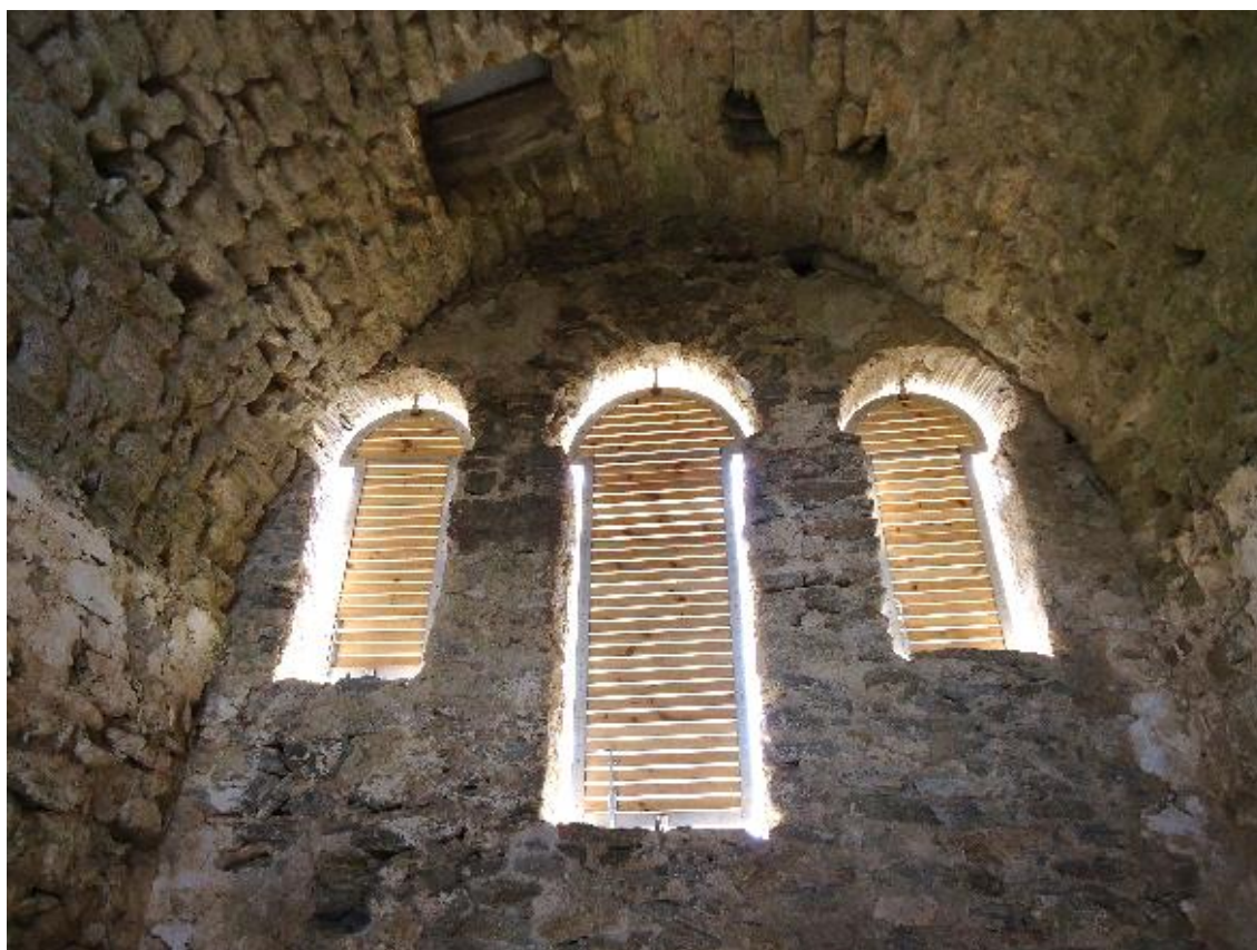
Figure 330 Le niveau supérieur de la tour avec ses ouvertures occidentales et sa voûte sur banquettes
