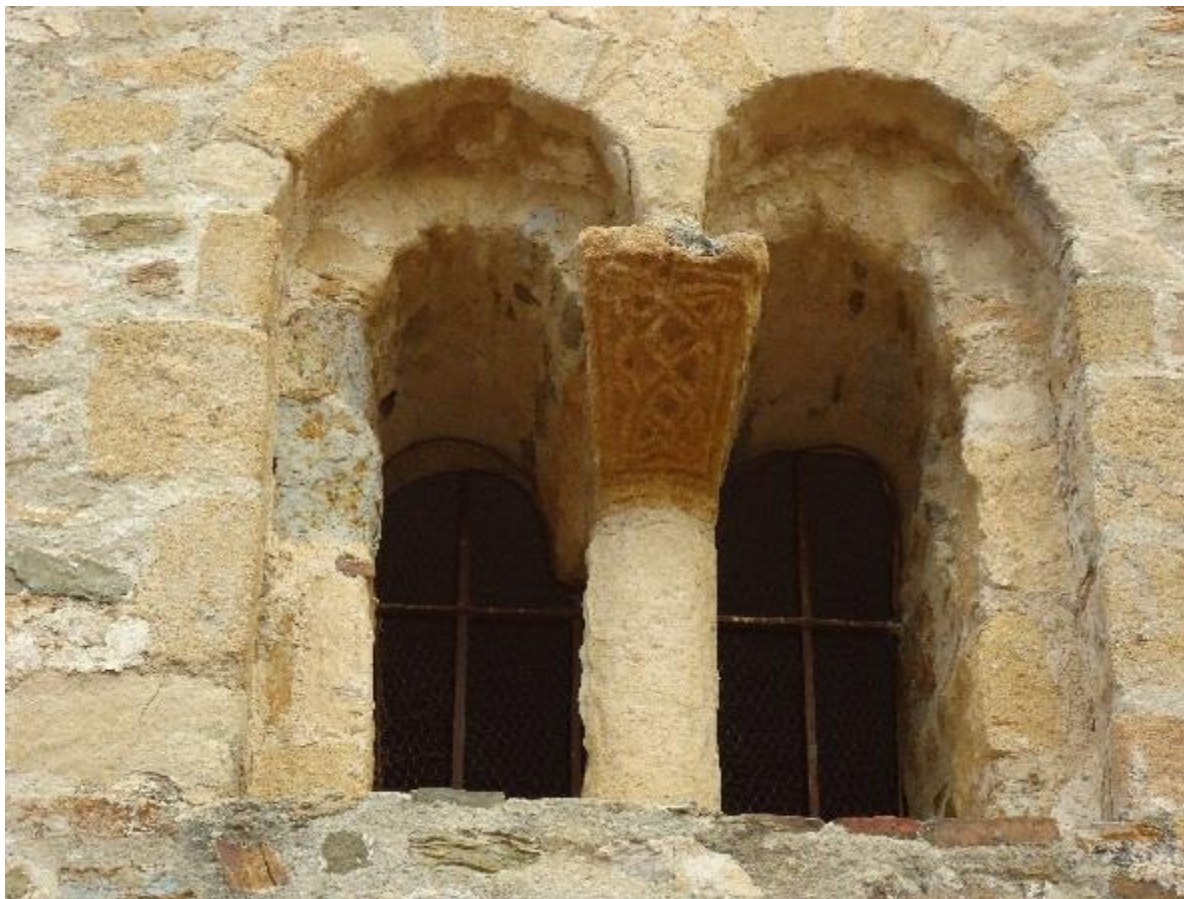
Figure 412 Baie jumelée dans la façade occidentale
