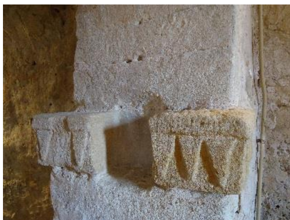
Figure 605- 606 Piédroit nord de l'arc triomphal avec son imposte
