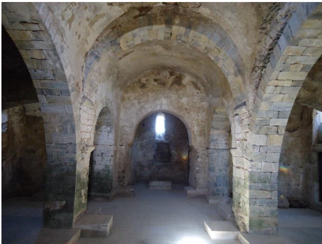
Figure 325 Vue de la nef d'ouest en est
