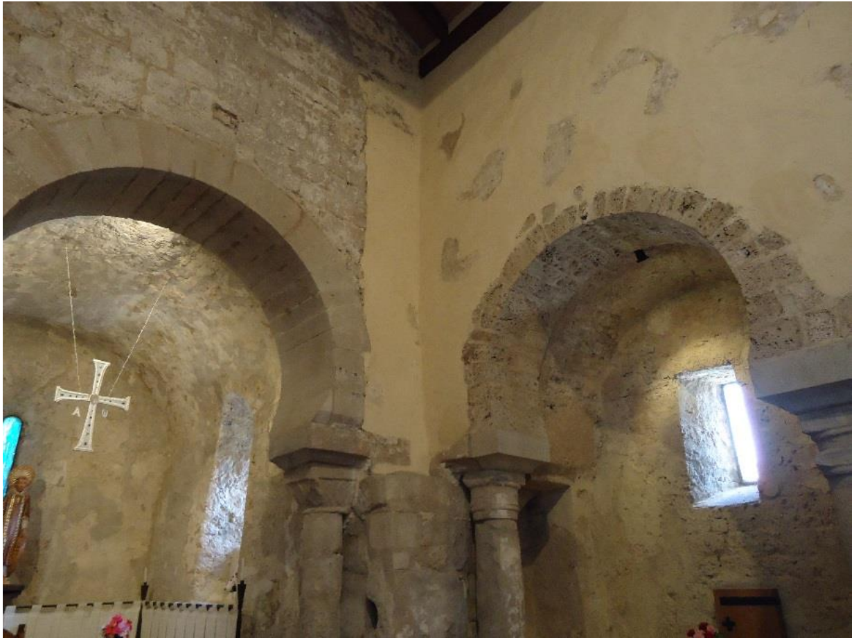
Figure 67 Vue du chevet avec son arc triomphal restauré et du bras sud du transept
