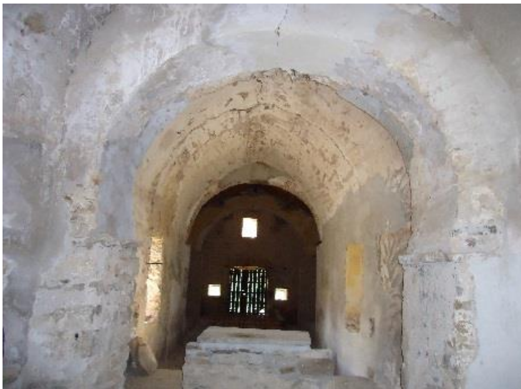
Figure 47 Vue de la nef depuis le chevet
