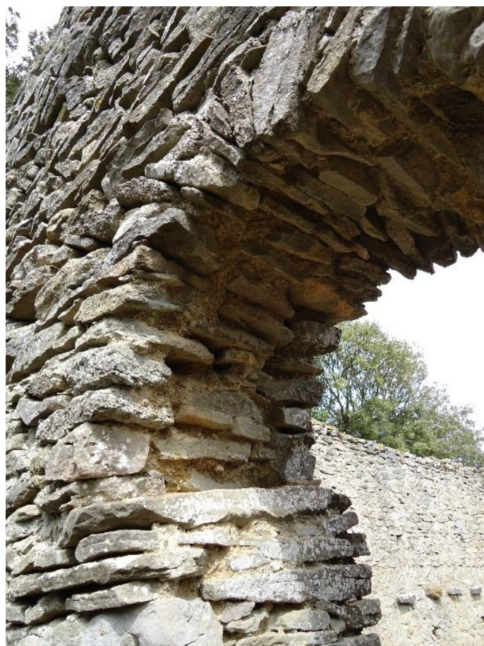
Figure 812 L'intrados de la porte occidentale
