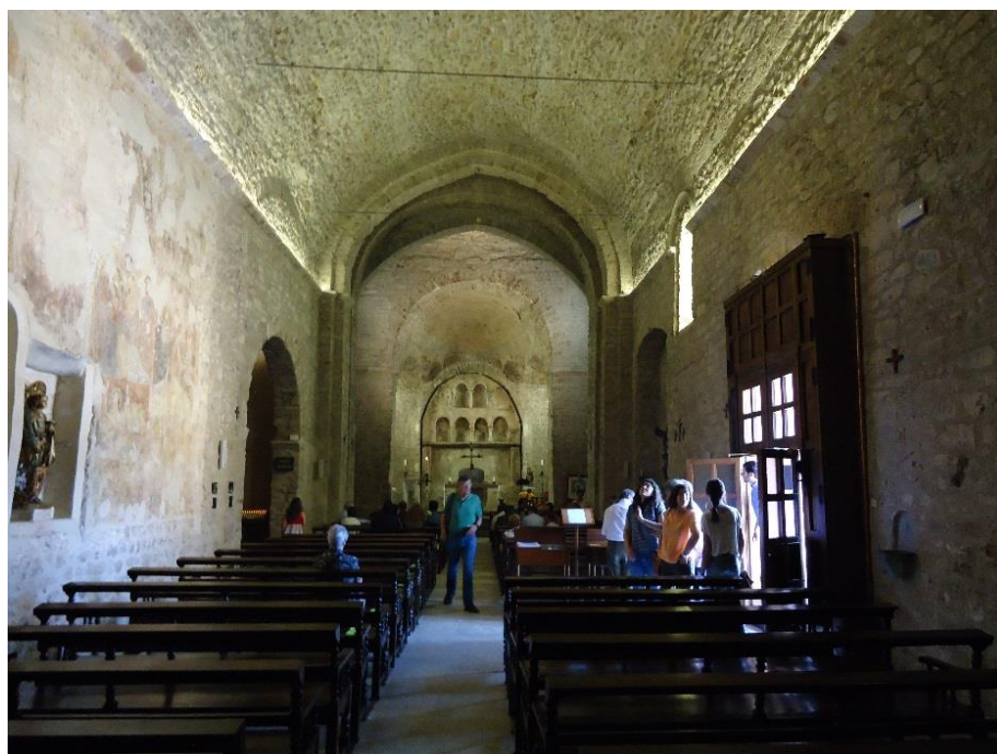
Figure 784 Arc brisé outrepassé de la nef de Sant Pèr
