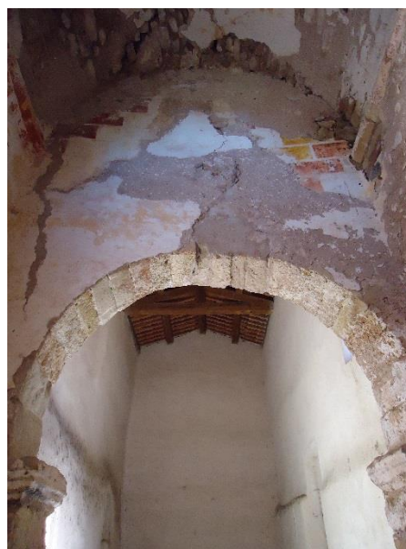
Figure 218 Mur diaphragme de l'arc triomphal
