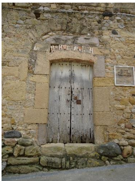
Figure 588 Porte nord, extérieur
