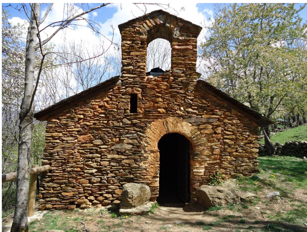
Figure 15 Vue de la façade occidentale après la reconstruction
