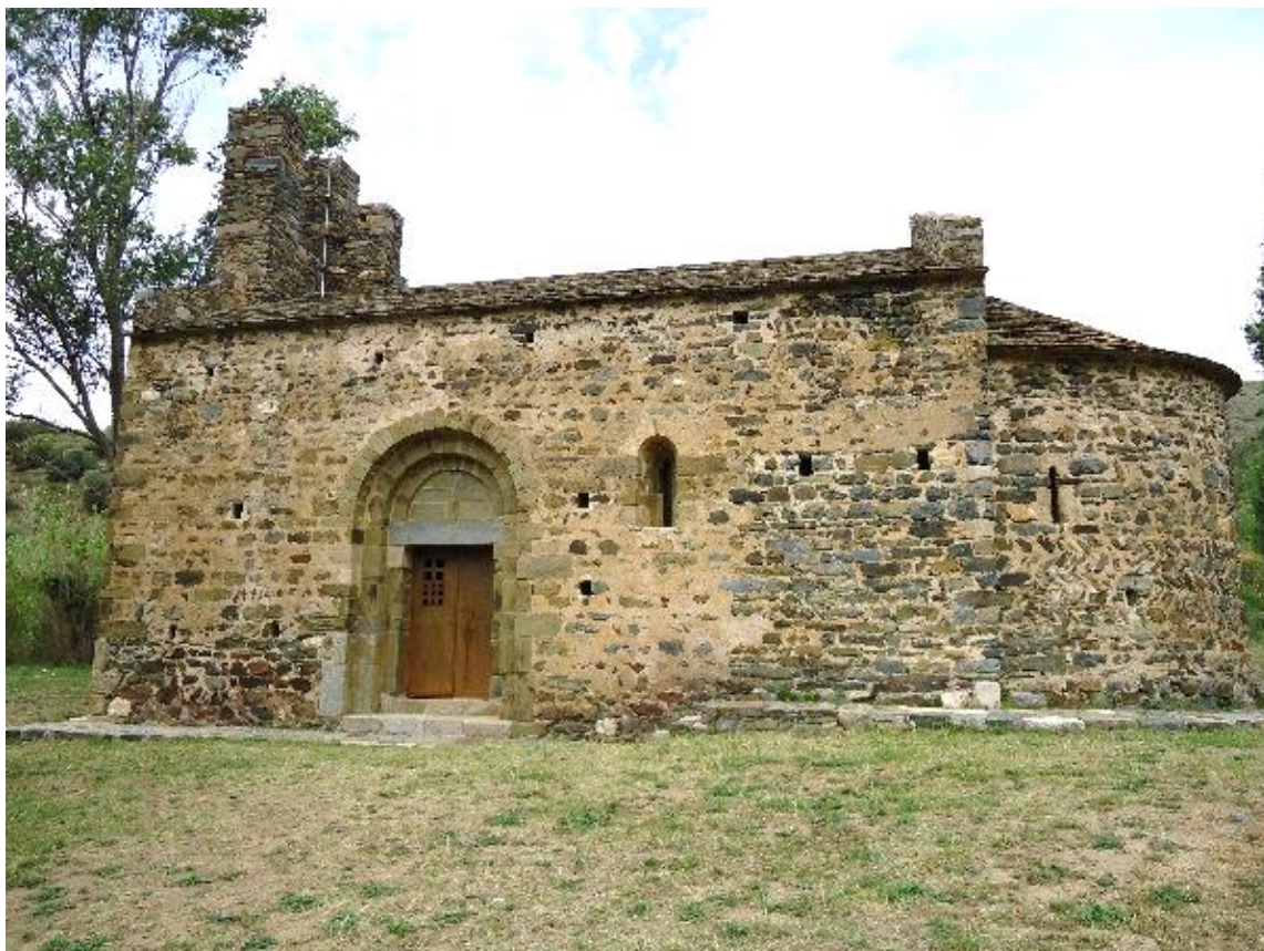
Figure 474 Vue de la façade méridionale
