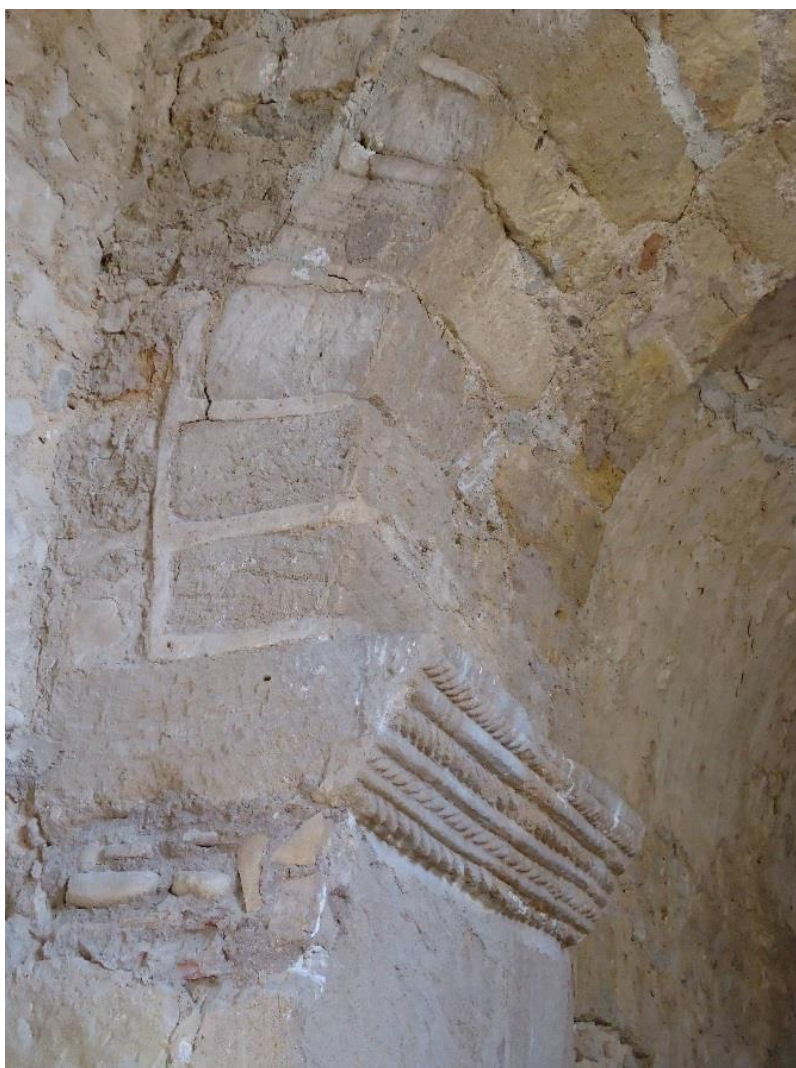
Figure 587 L'imposte du piédroit nord de l'arc triomphal
