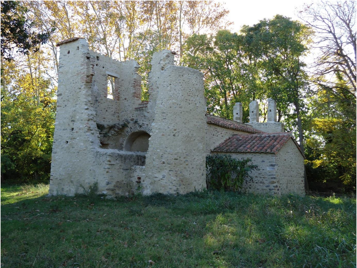
Figure 663 Vue extérieure nord-est avec l'ancien chevet tronqué et intégré dans des nouvelles constructions
