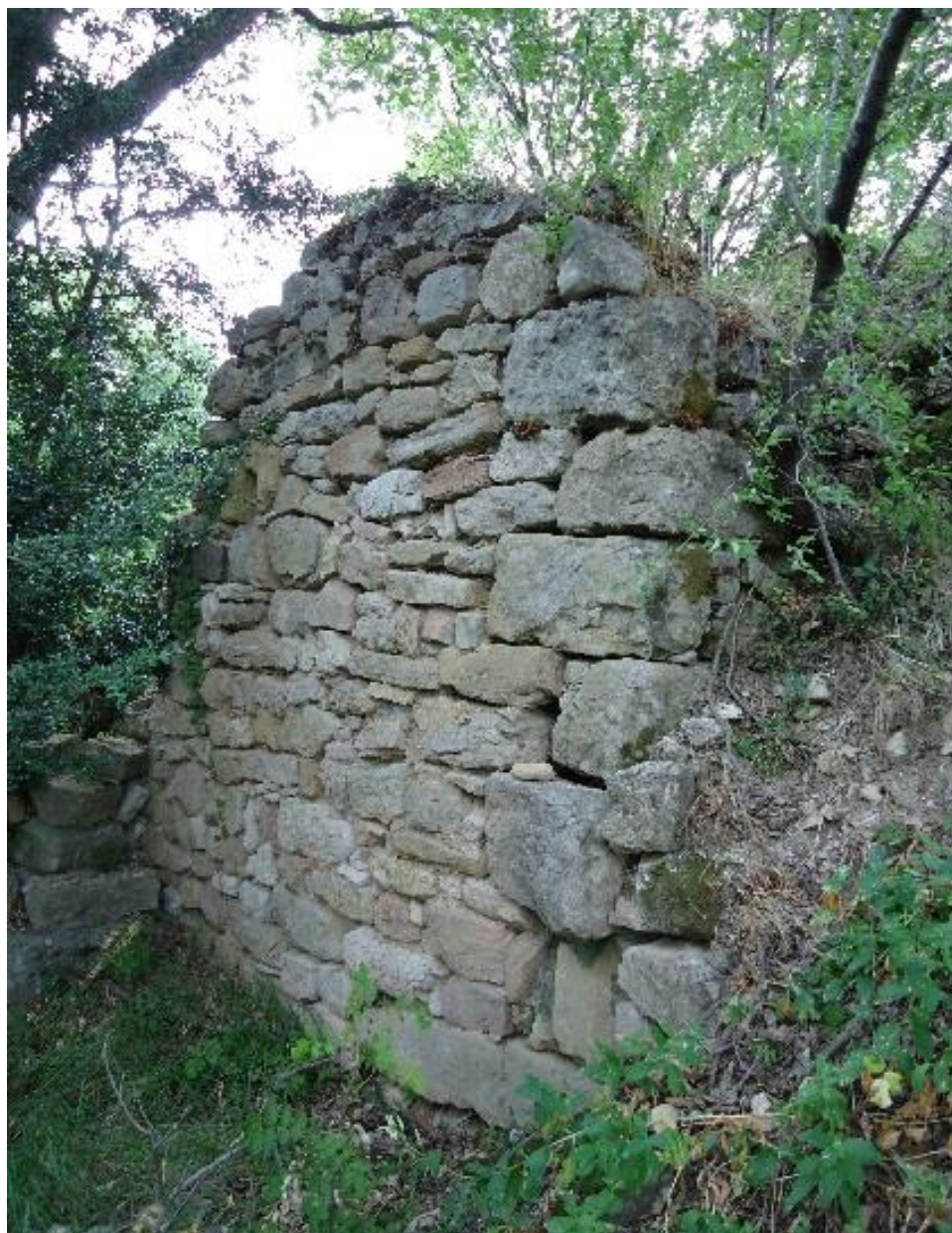
Figure 445 Vue extérieure de l'angle sud-est du chevet
