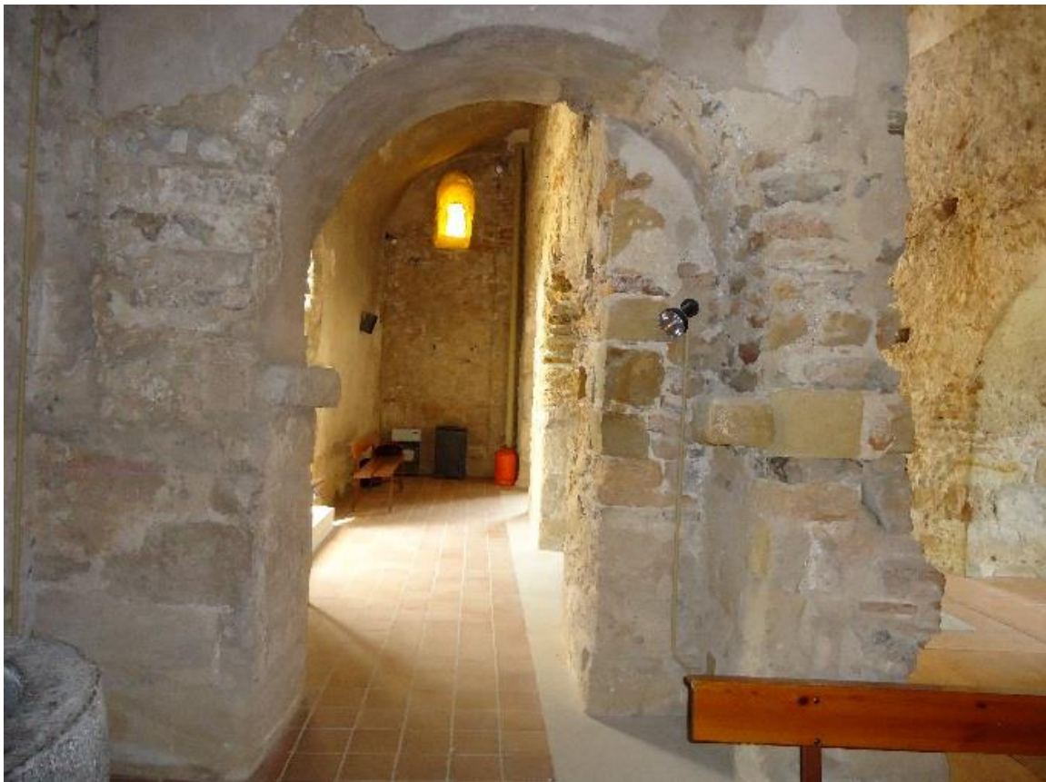
Figure 104 Arc doubleau du bas-côté méridional
