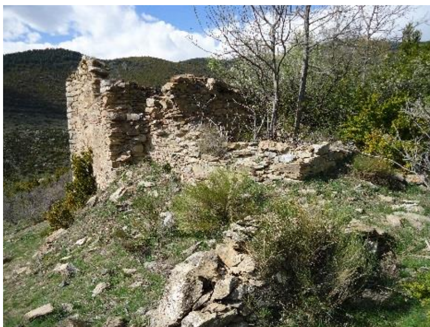
Figure 616 Vue sud-est des ruines
