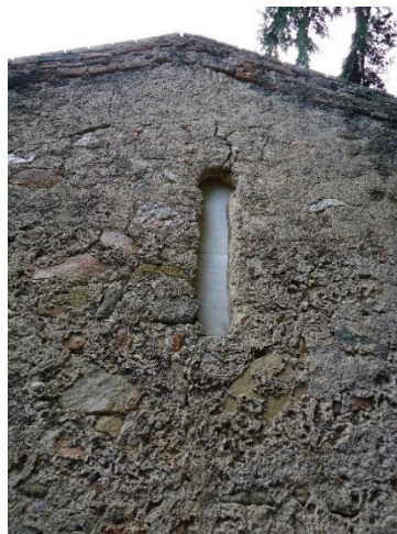
Figure 137 Fenêtre axiale, extérieure
