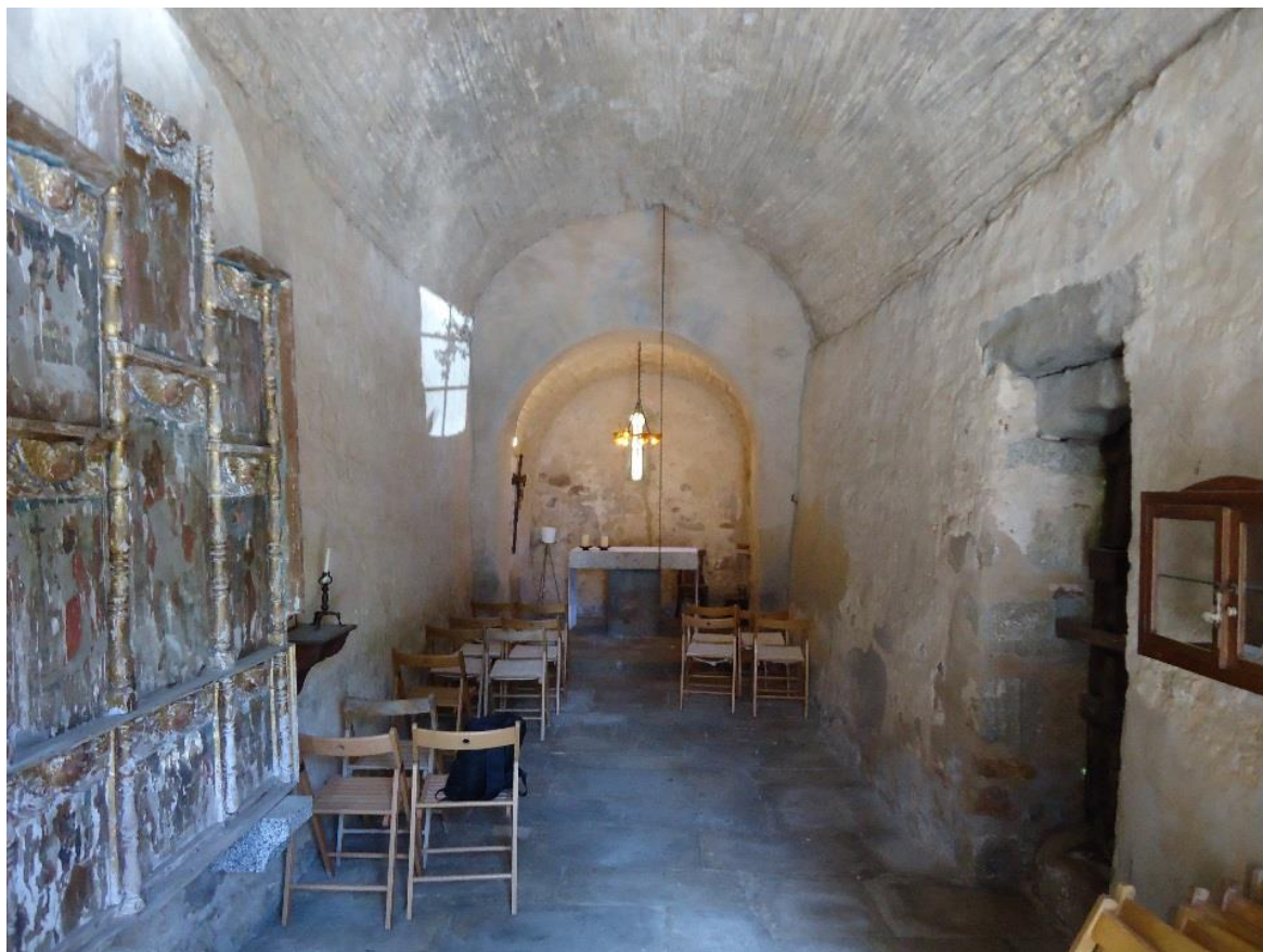
Figure 131 Vue de la nef d'ouest en est
