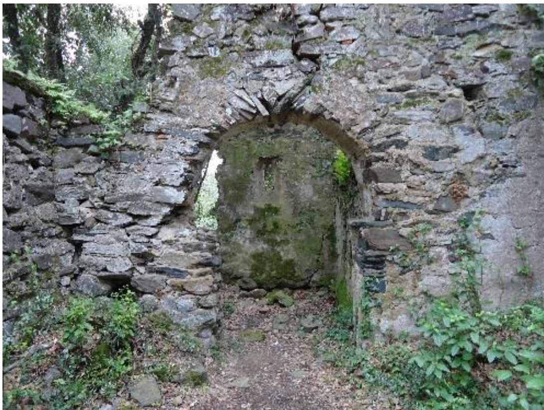
Figure 150 Vue de l'arc triomphal depuis la nef disparue
