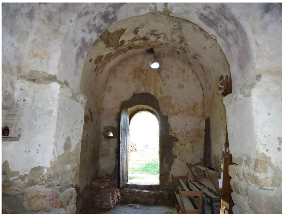
Figure 53 Vue de la nef depuis le chevet
