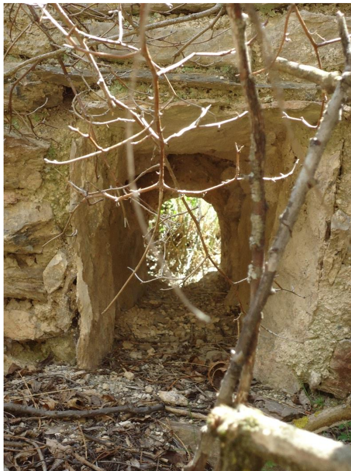
Figure 623 Baie dans le mur sud du chevet
