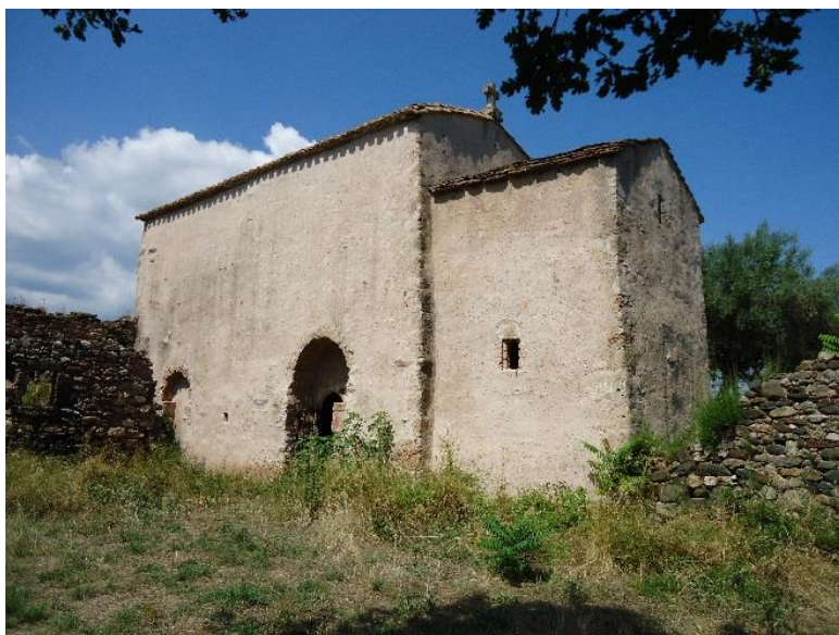
Figure 210 Vue extérieure sud-est
