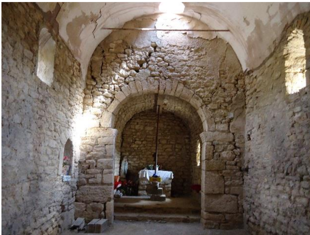
Figure 649 Vue de la nef d'ouest en est
