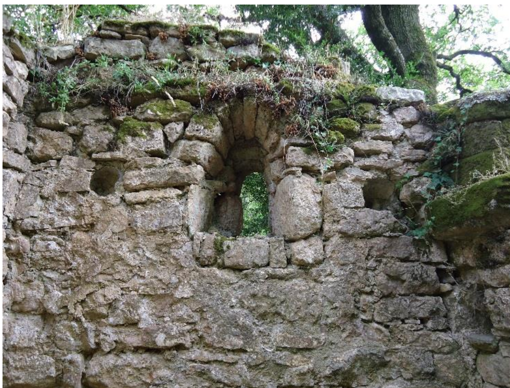
Figure 450 Intérieur, mur méridional du chevet avec sa fenêtre encadrée de deux pots acoustiques
