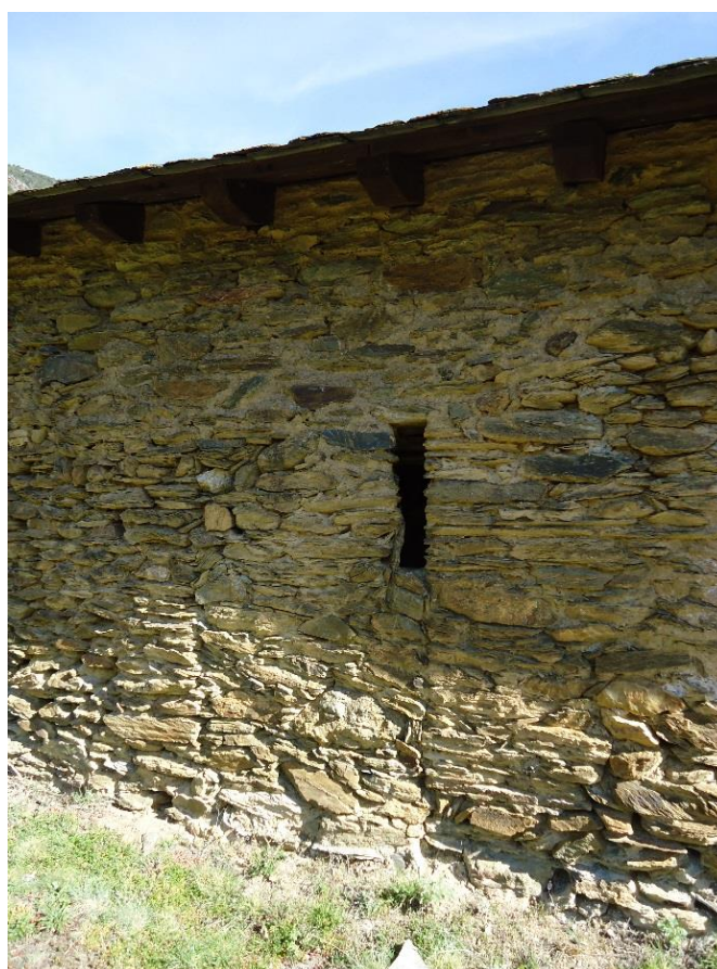
Figure 12 Porte bouchée dans la façade méridionale
