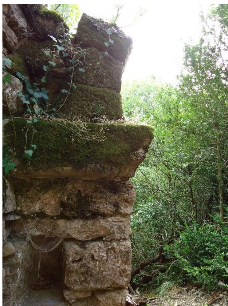
Figure 449 Revers de l'arc triomphal, côté sud : piédroit avec cavité, imposte, sommier, contre-sommier, premier claveau
