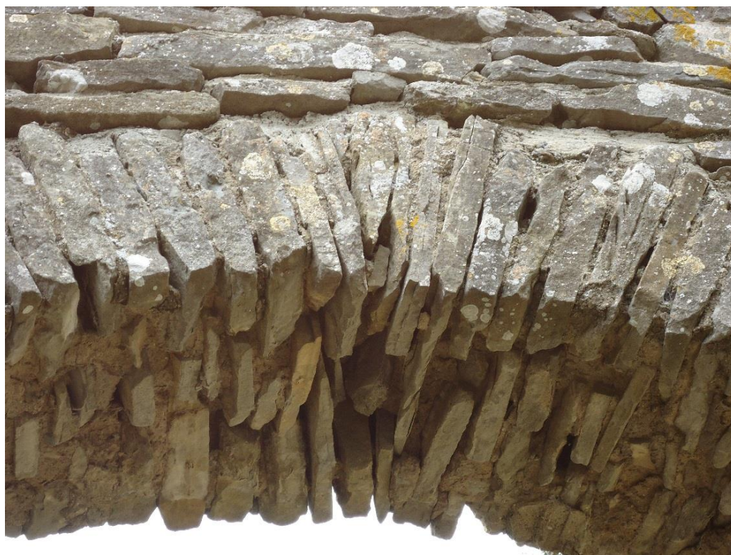
Figure 814 Clavage de l'arc triomphal, côté chevet
