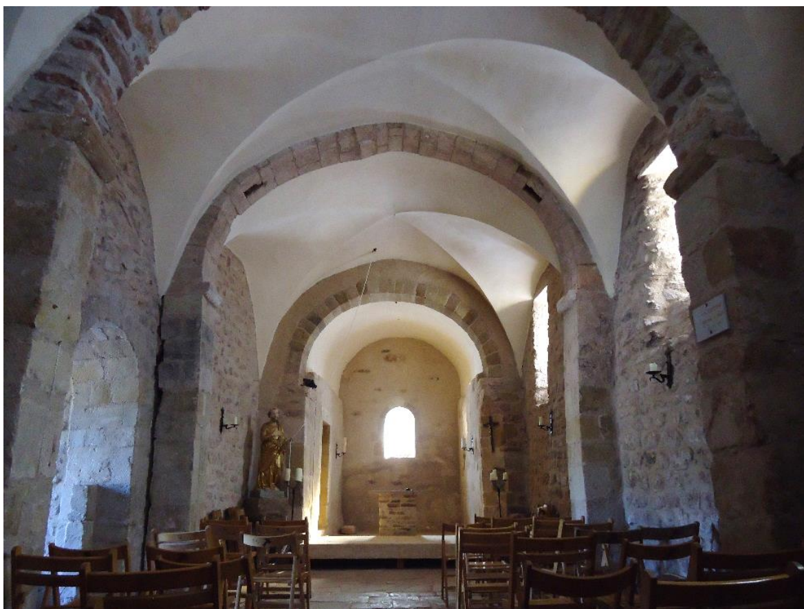
Figure 440 Vue de la nef d'ouest en est
