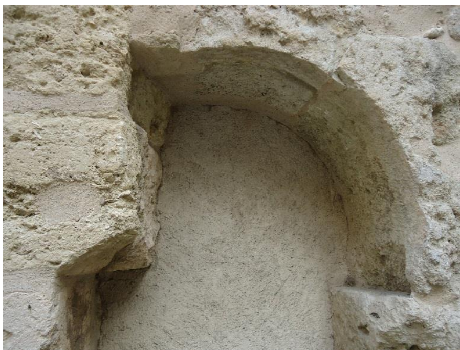
Figure 563 Détail de l'arc outrepassé
