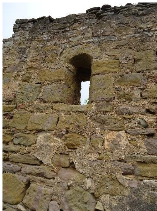
Figure 165 Fenêtre du mur sud, extérieur
