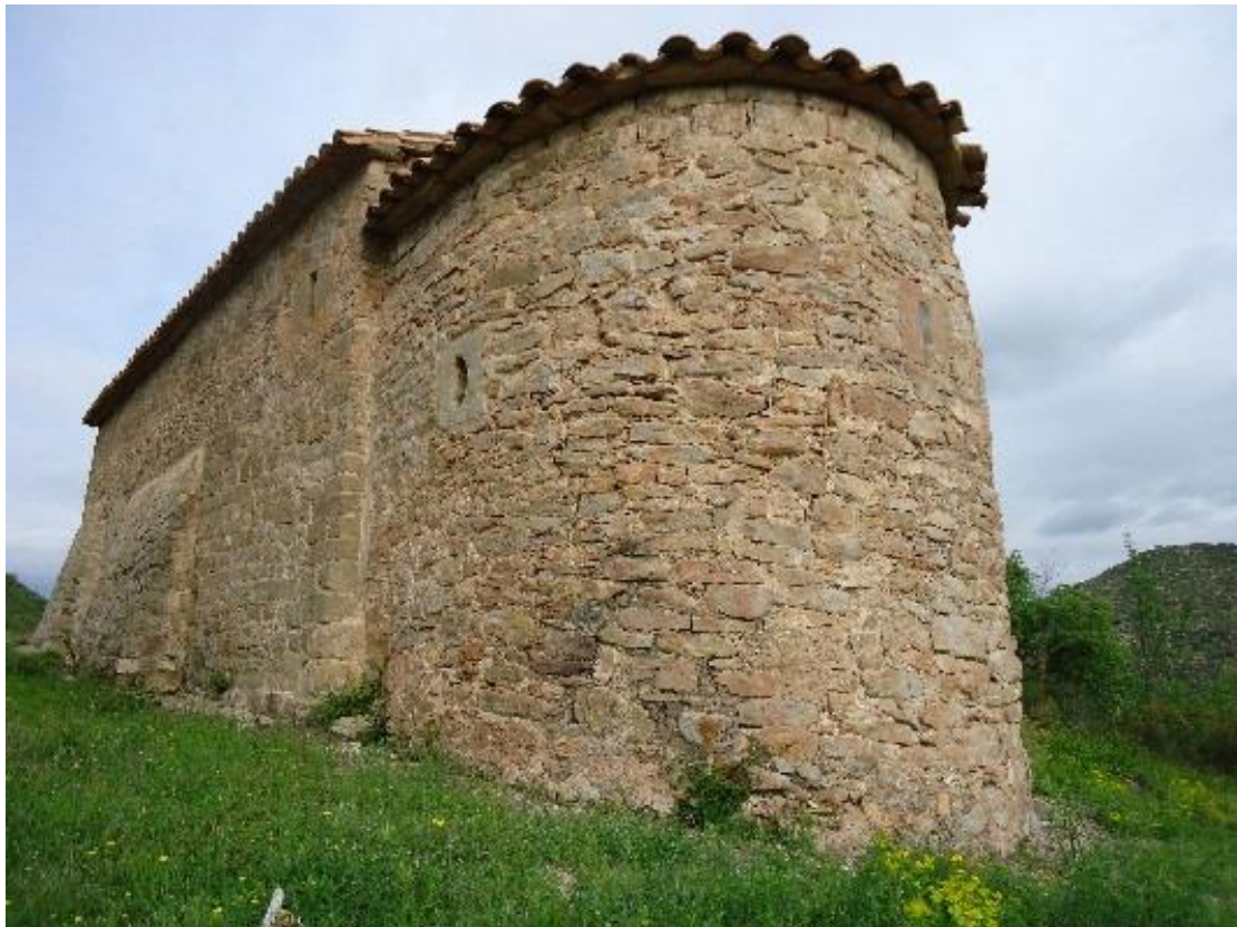
Figure 231 Vue extérieure sud-est
