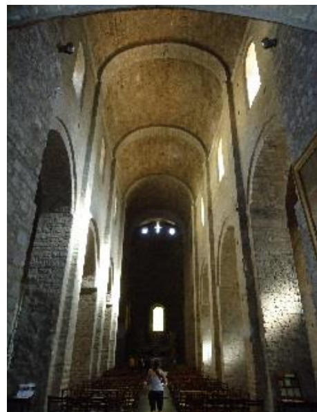
Figure 674 Vue de la nef d'ouest en est
