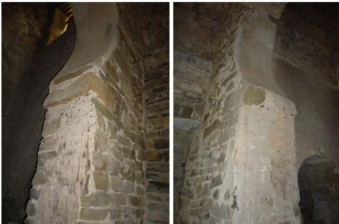
Figure 307 Piliers nord et sud de l'arc entre la nef et la croisée du transept
