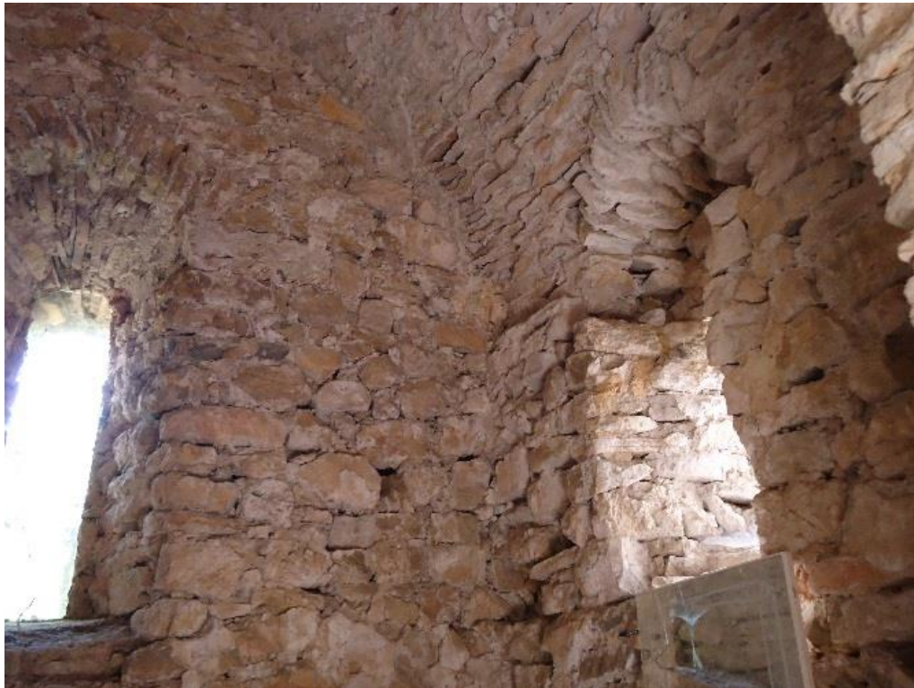
Figure 87 Fenêtres du chevet sur banquettes
