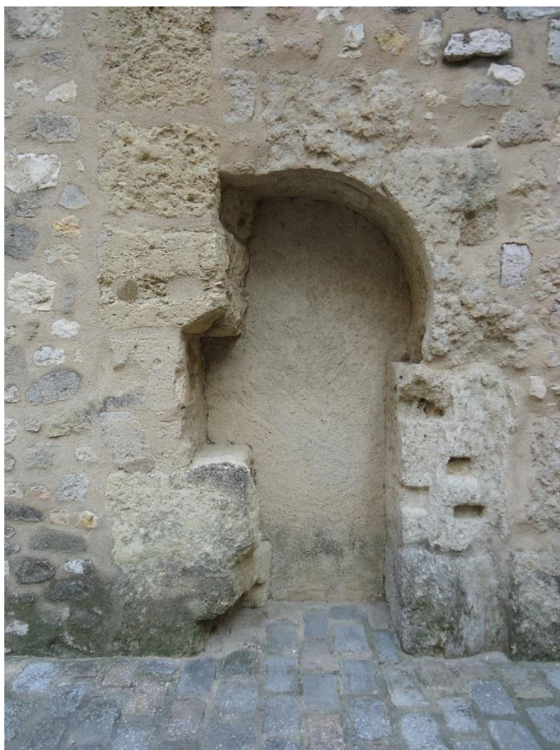
Figure 562 Porte à l'arc outrepassé
