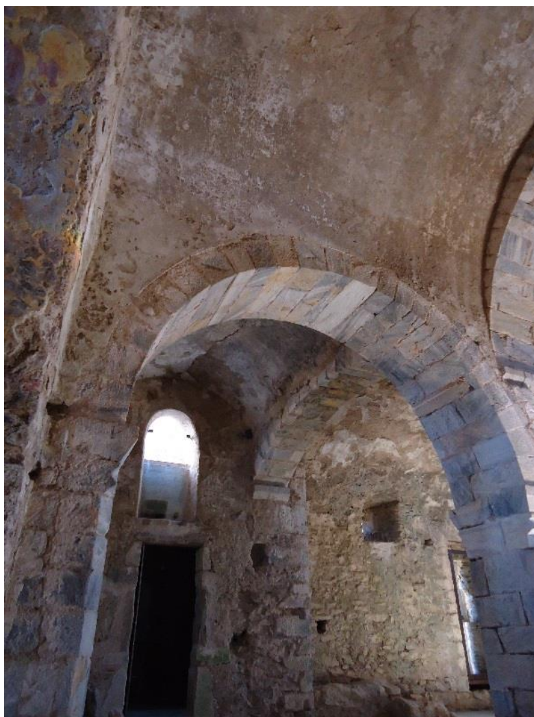
Figure 327 Les voûtes perpendiculaires de la croisée et du bras nord du transept
