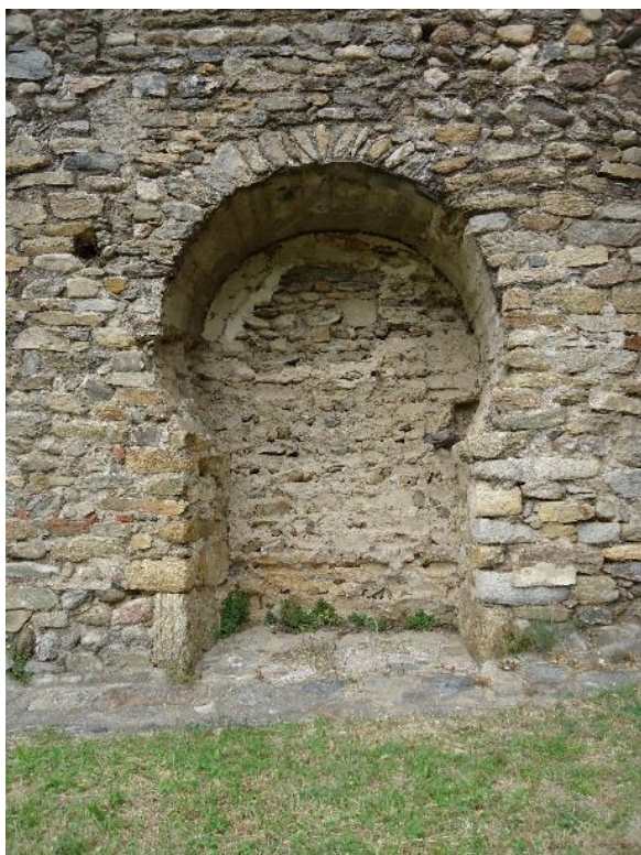
Figure 263 Porte bouchée du vaisseau sud, extérieur
