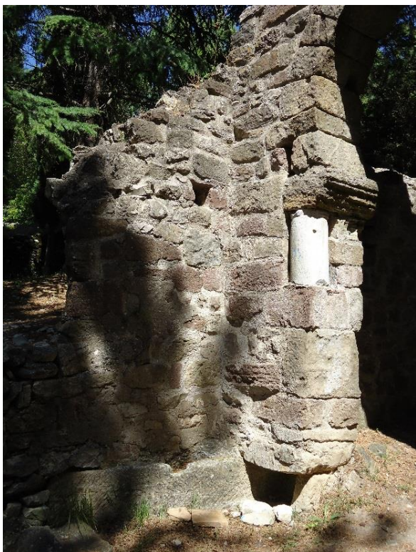
Figure 491 Angle N-E de la nef construit sur un sarcophage
