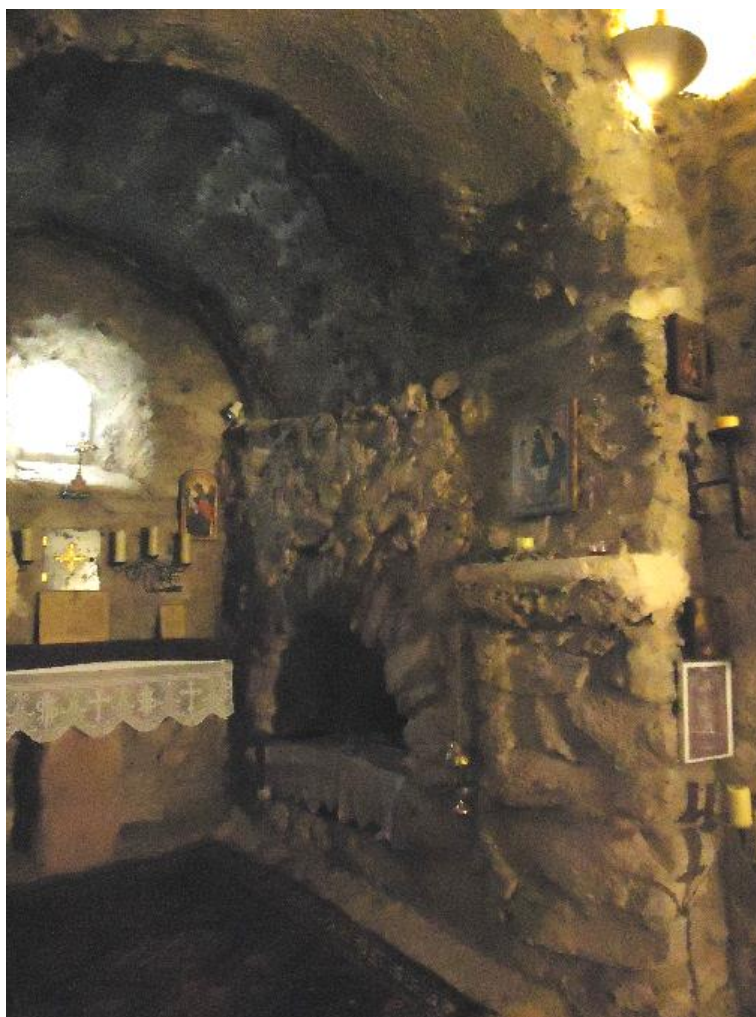
Figure 362 Niche intérieure et voûte sur banquette du chevet nord
