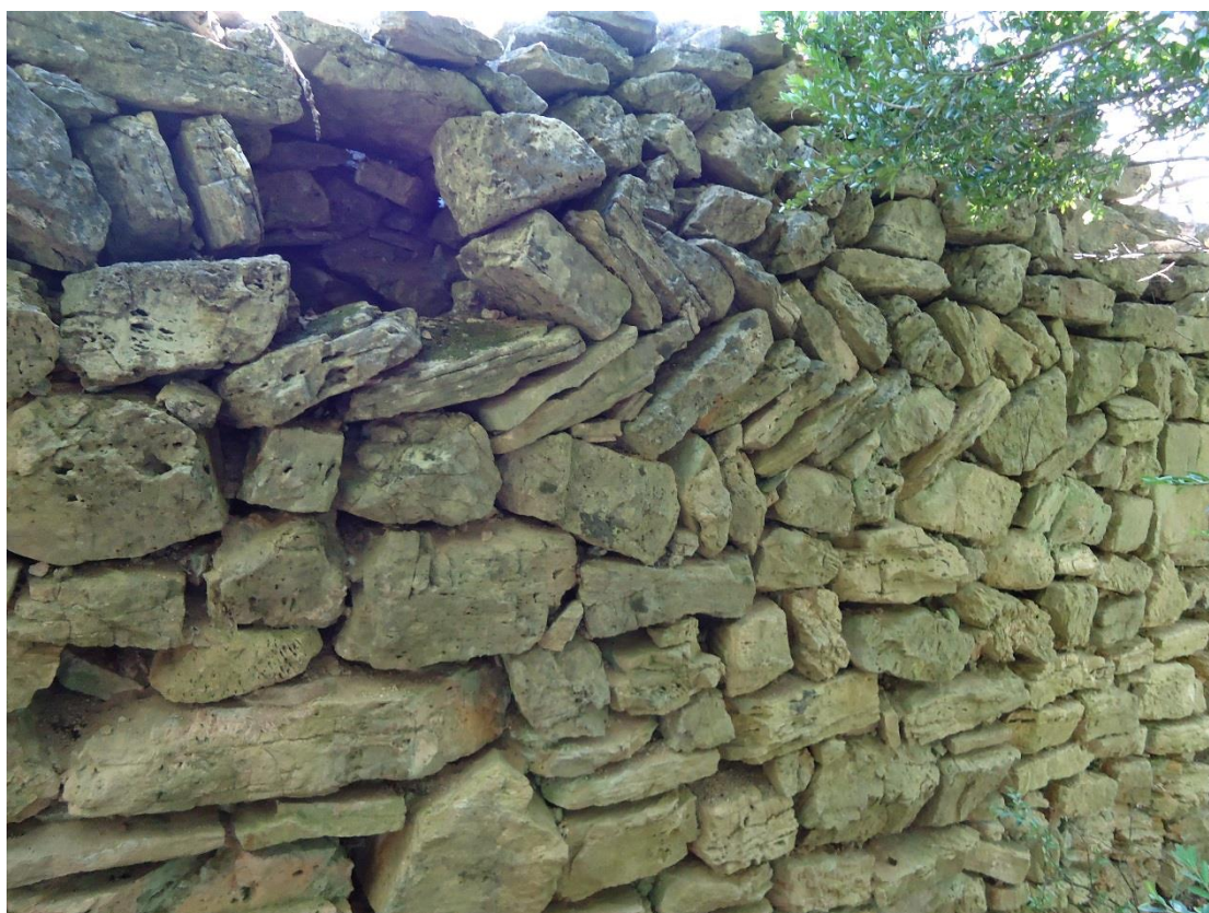
Figure 800 Détail de la maçonnerie
