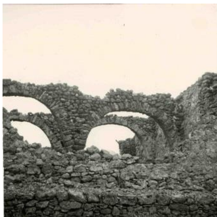
Figure 357 Photographie prise durant les reconstructions, DRAC de Montpellier
