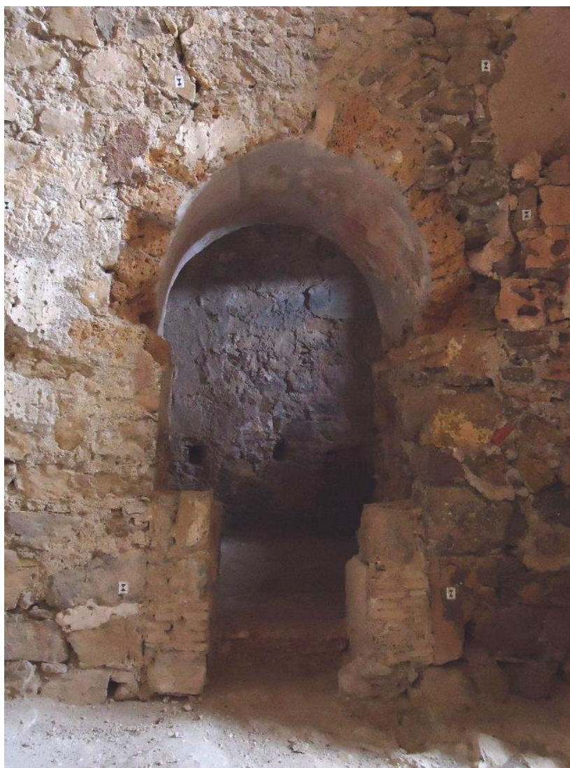
Figure 415 Porte au rez-de-chaussée de la tour
