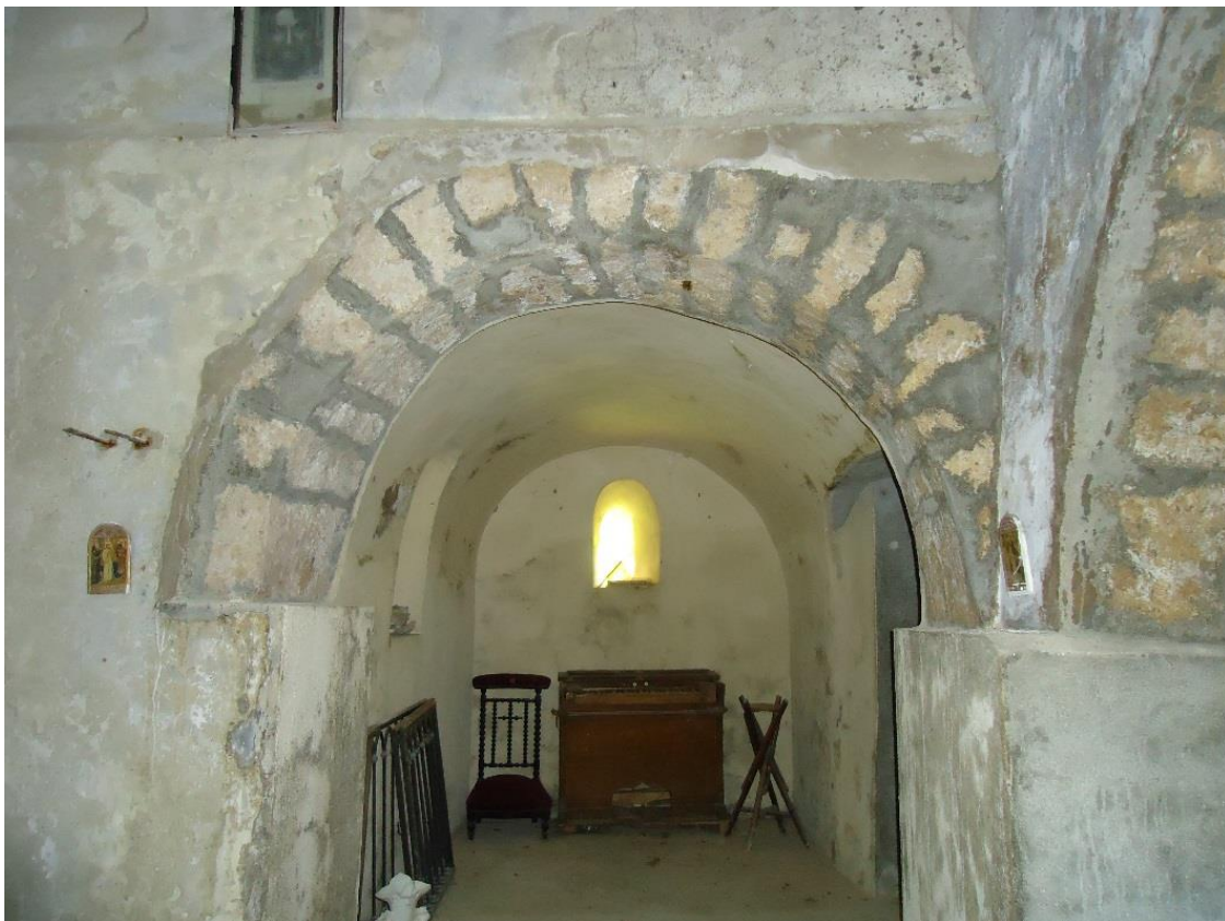
Figure 825 Vue de la chapelle nord depuis la salle nord-ouest
