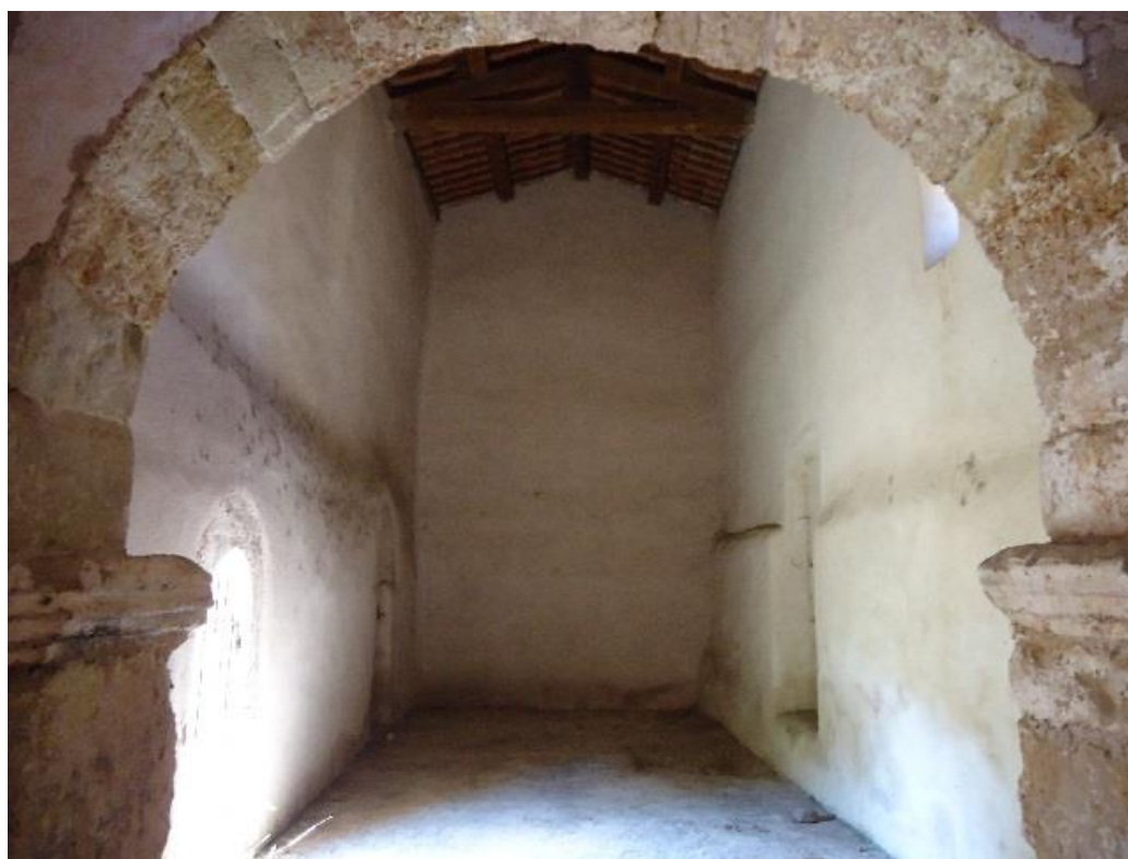
Figure 213 Vue de la nef depuis le chevet
