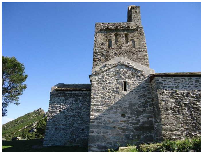
Figure 333 Façade nord de la tour avec ses niches semi-circulaires encadrant deux baies en fer à cheval
