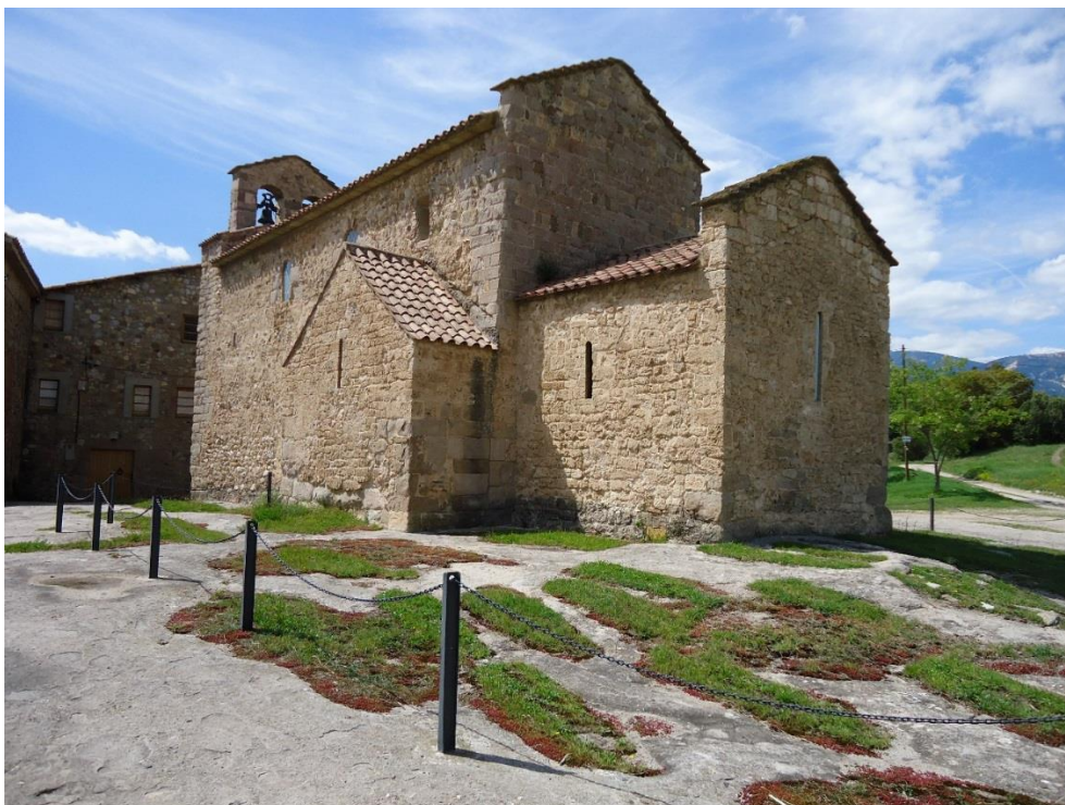
Figure 64 Vue extérieure sud-est
