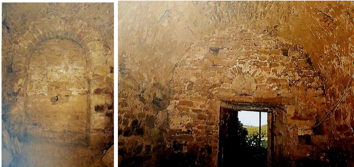
Figure 532- 533 État avant la restauration avec l'arc triomphal muré et porte ouverte dans le fond du chevet, ADELL, VIGUE, 1985, p. 338.
