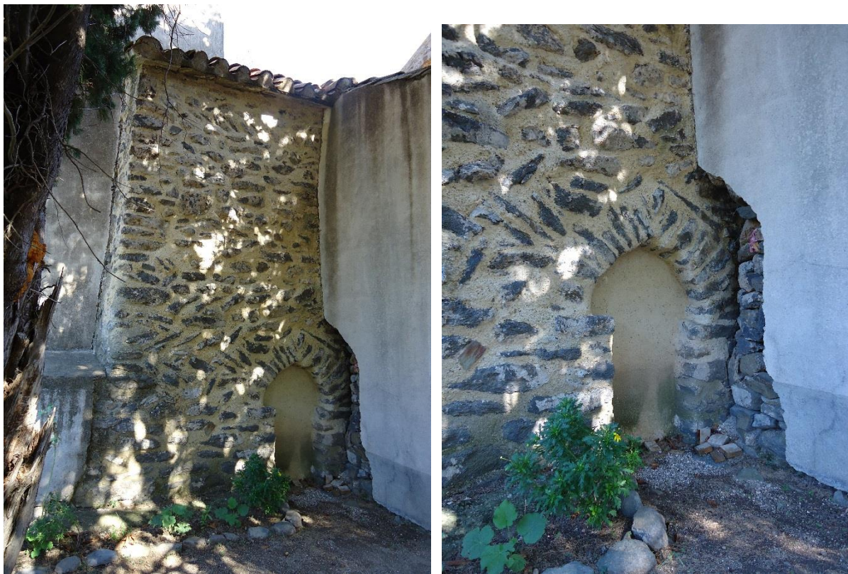
Figure 528- 529 Vues extérieures de la petite porte en champignon
