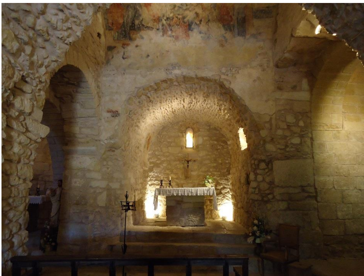
Figure 383 Vue du chevet avec sa voûte outrepassée
