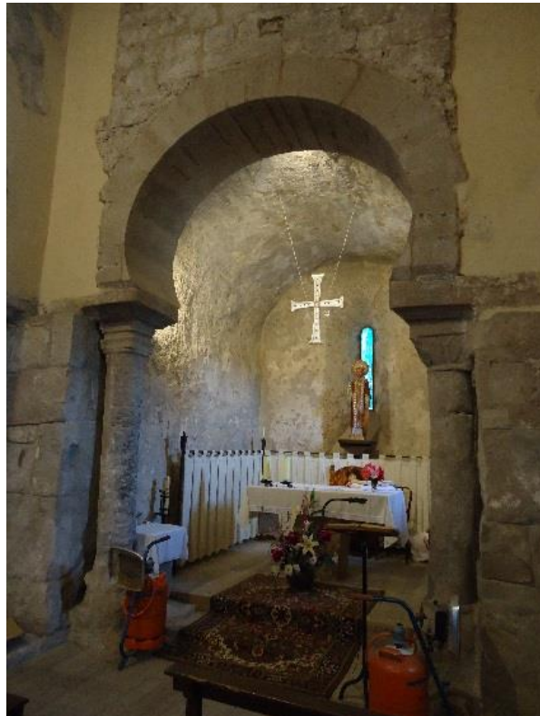
Figure 68 Vue du chevet avec sa voûte outrepassée
