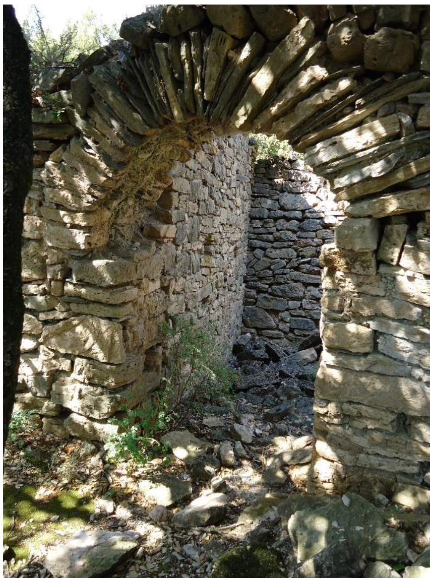
Figure 796 Vue extérieure de la porte méridionale
