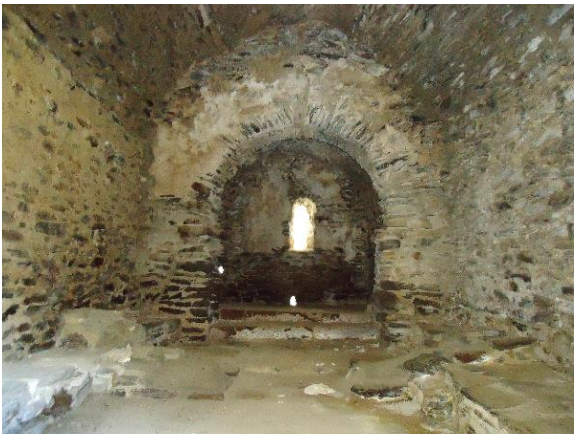
Figure 345 Vue de la nef d'ouest en est
