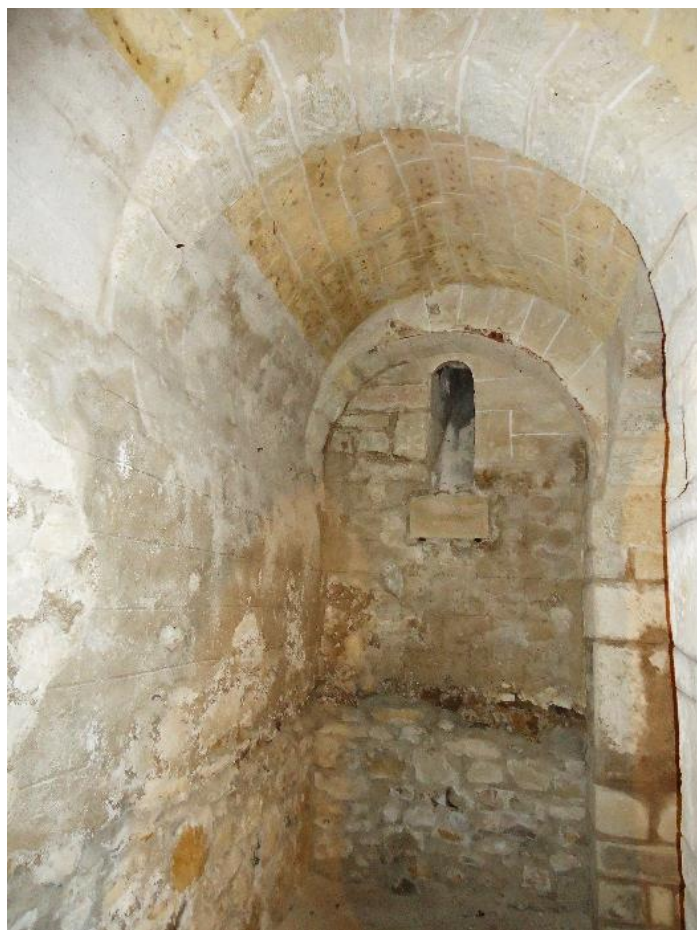
Figure 481 Voûte du bas-côté nord, première travée orientale
