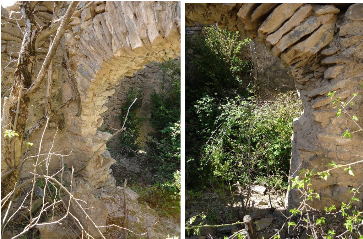
Figure 621 Arc triomphal, retombée sud : courbure sans mortier ; retombée nord : écoinçon formé du mortier
