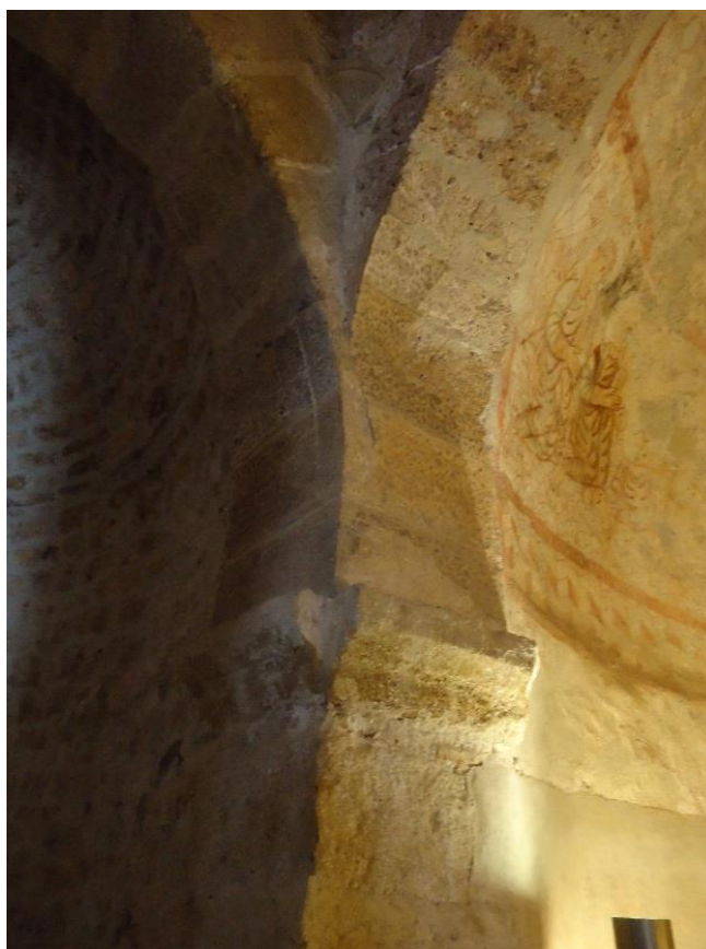
Figure 781 Retombée nord de l'arc triomphal et de l'arc doubleau est du couloir entourant la coupole
