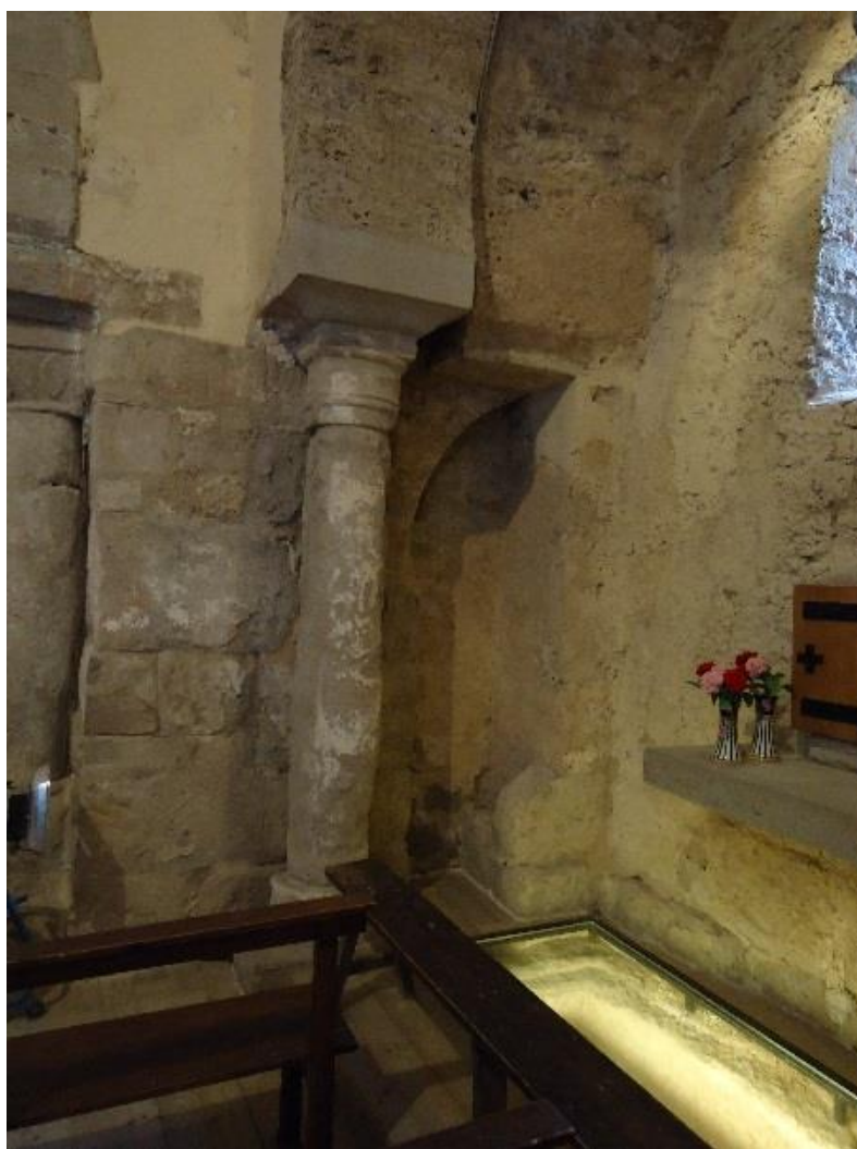
Figure 70 Vue du bras sud du transept
