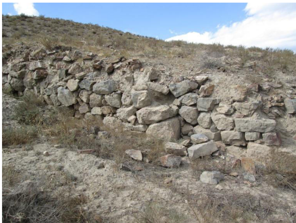
Fig. 2 : Rempart. Cliché : A. Parsamyan, 2013.
