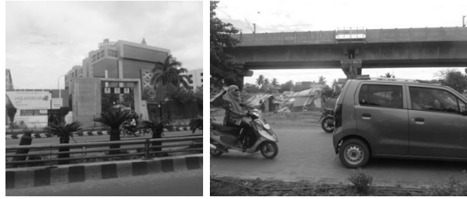
Le long de l'OMR en allant vers le sud.
