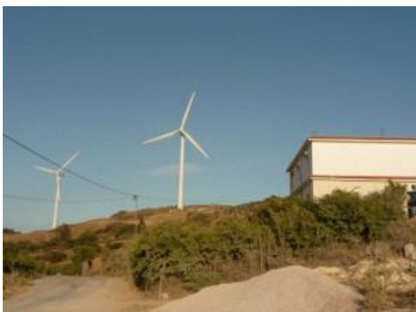
Une éolienne très proche des habitations à Sidi Abdel Aziz dans la localité de Metline. Cliché E. Verdeil, 2013.
