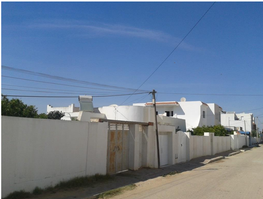
Figure 7-2 : chauffe-eau solaire sur une villa d'un lotissement en zone péricentrale (2014)
