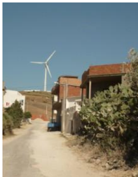
La route qui mène aux éoliennes dans le village de Sidi Ali Chebab n'a pas été entièrement refaite après qu'une tranchée destinée aux câbles a été creusée. Cliché E. Verdeil 2013
