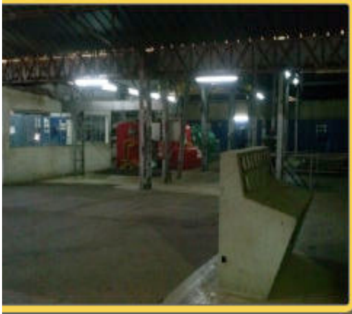
Emplacements des anciennes turbines SAUTTER
