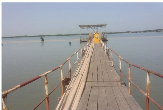
Pont conduisant aux pompes
