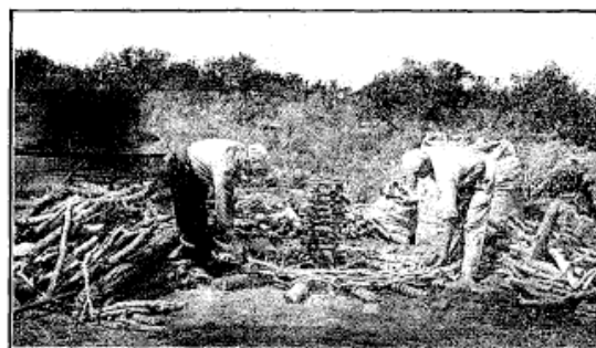
Fig. B. — Mise en place du bois (2 e phase).
