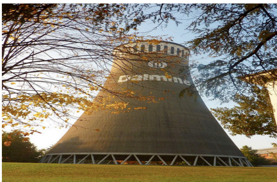
L'usine de Tenaris Dalmine
