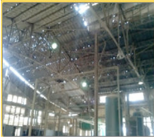
Charpente métallique atelier énergie
