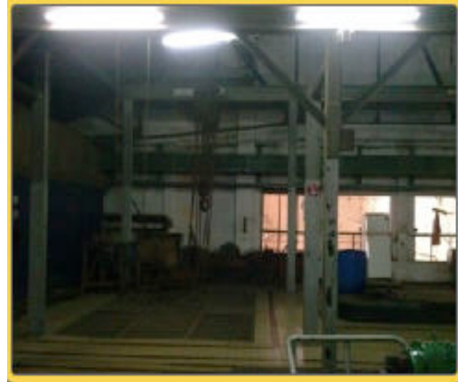
Palan 12 tonnes anciennes turbines BB
