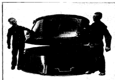
Fig. F. — Pose du 2 e élément.
