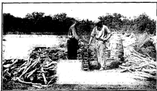
Fig. A. — Mise en place du bois (1 re phase).
