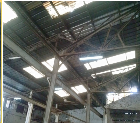
Charpente métallique atelier mécanique
