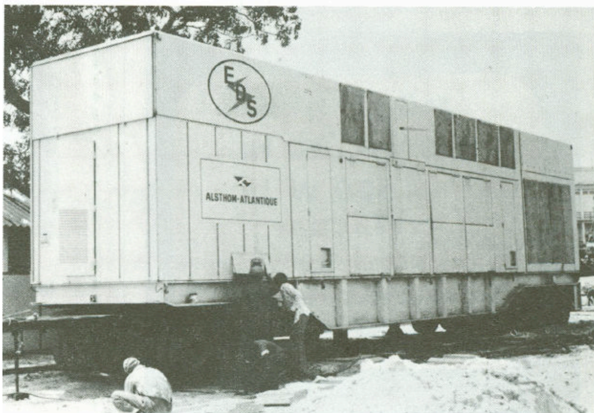
Groupe Mobile 2 mw en cours de montage à Kaolack
