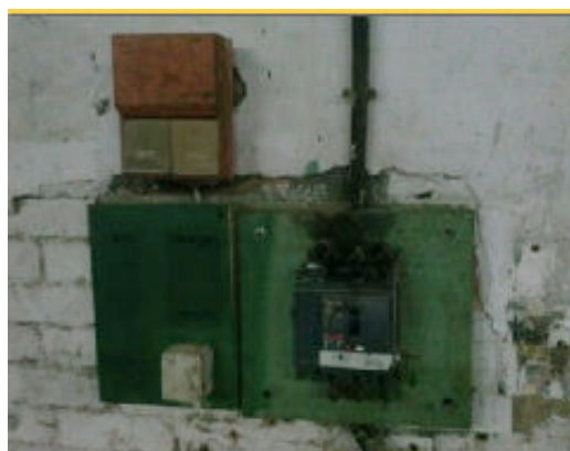
Disjoncteur palan électrique 16 tonnes
