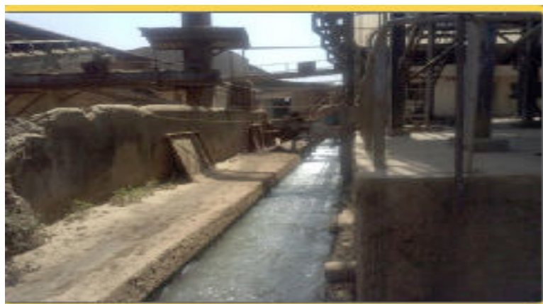
Canal retour eau du fleuve
