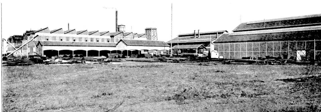
ATELIERS DE LA COURNEUVE Vue des Ateliers prise de la cour intérieure de l'Usine
