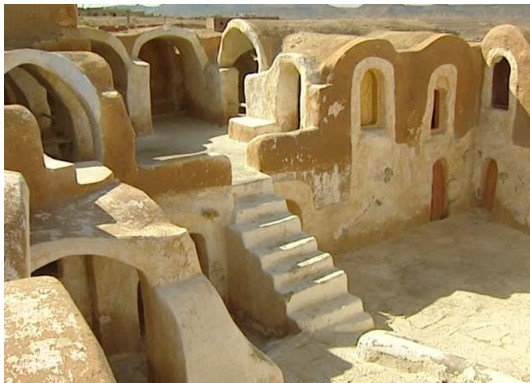
A : La partie reconstruite de ksar Haddada
