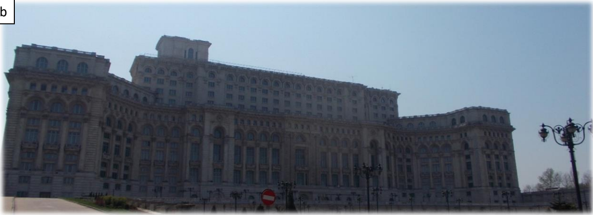
Figure 16 - Le Palais du Parlement (appelé la « maison du Peuple ») : la façade d'est (a) et la façade d'ouest (b) ;
