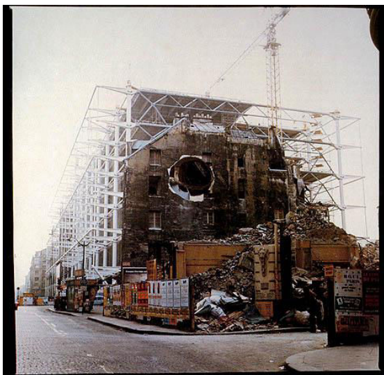
Beaubourg en construction, au moment de Conical Intersect de Gordon Matta-Clark, 1975
