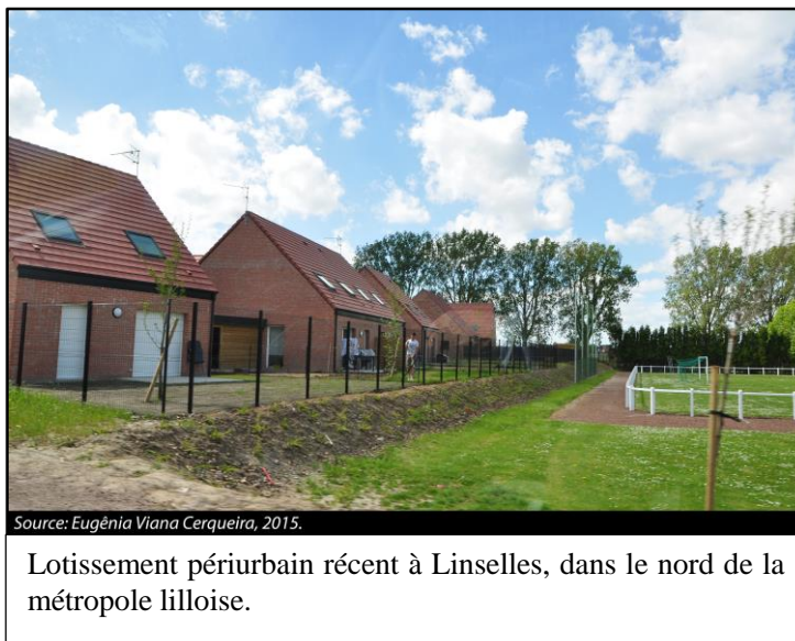
Figure 2.1- Lotissement dans le périurbain lillois
