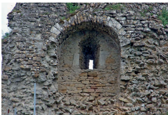
Fig. 7 – Fenêtre à niche et embrasure du second étage. Vue intérieure (cliché Cédric Moulis).
