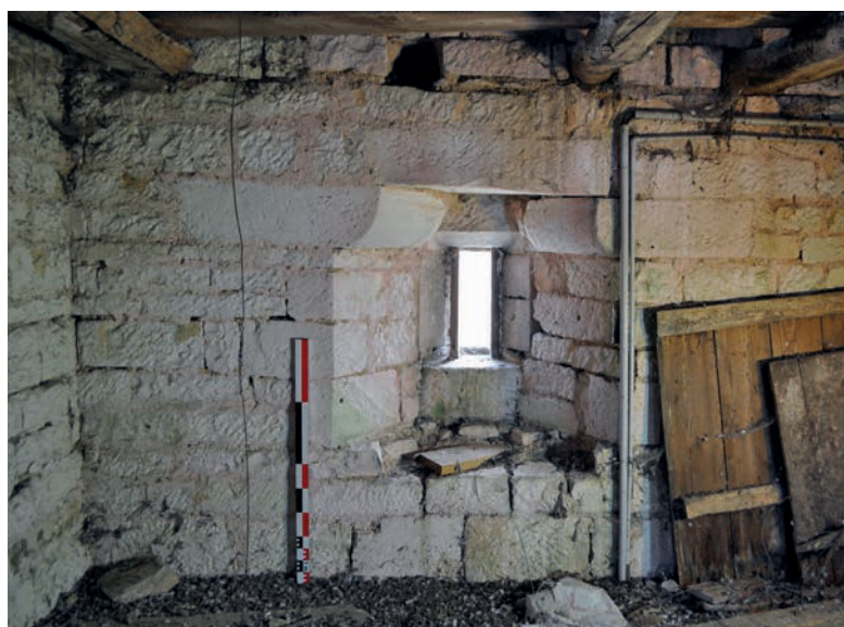
Fig. 20 – Fenêtre à cousinets du XIV e siècle au premier étage de l'élévation sud de la tour-chœur, constituée de pierres portant des traces de laie, de gradine (en haut à droite) et de bretture (en bas à droite) (clichés Cédric Moulis).
