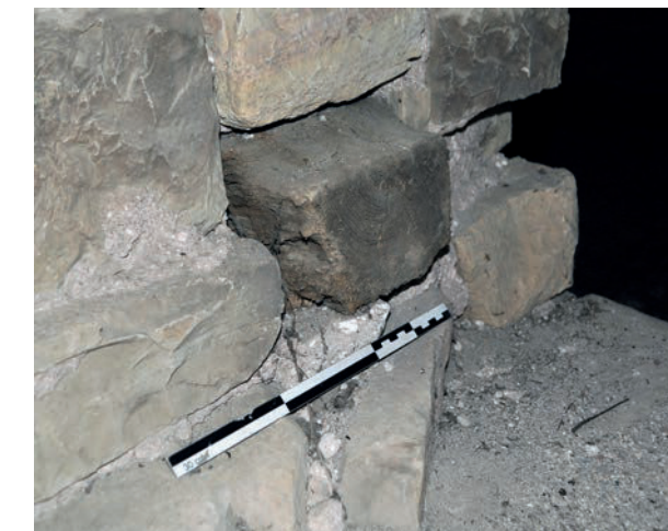
Fig. 37 – Détail de la poutre insérée dans la maçonnerie du clocher (cliché Cédric Moulis).
