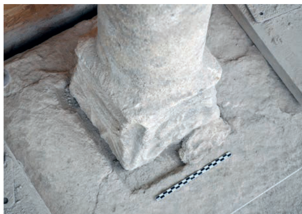
Fig. 21 – Baie sud, encoche de calage pour la base de la colonnette (cliché Cédric Moulis).
