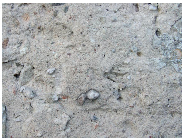
Fig. 33 – Enduit de l'élévation extérieure est (cliché Cédric Moulis).
