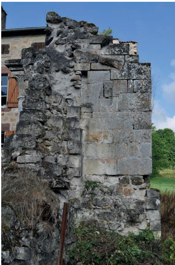
Fig. 16 – Contrefort séparant les travées n°4 et 5 (cliché Cédric Moulis).
