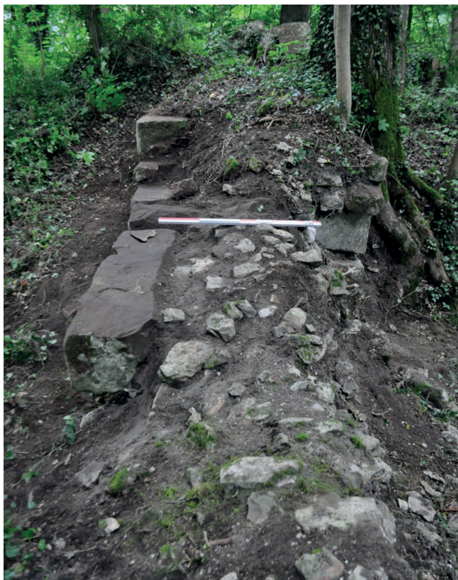
Fig. 15 – Mur 2.1 de l'aula. Coupe des deux parements et blocage (cliché Cédric Moulis).
