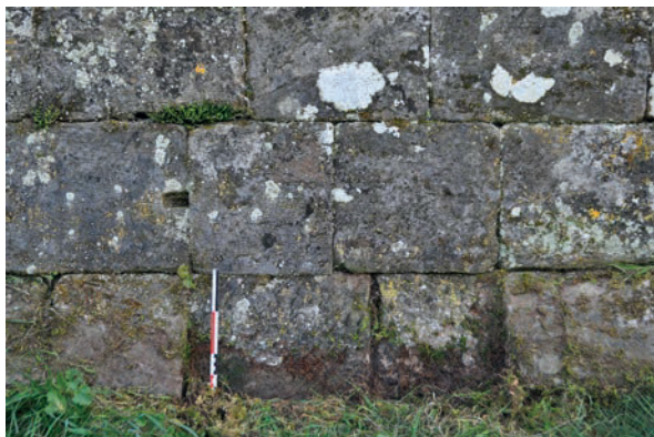
Fig. 15 – Entaille dans le larmier, sans doute destinée à appuyer un mur de refend du palais abbatial moderne (cliché Cédric Moulis).
