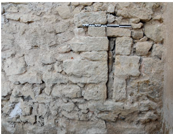
Fig. 7 – Fente rebouchée du mur sud (cliché Cédric Moulis).
