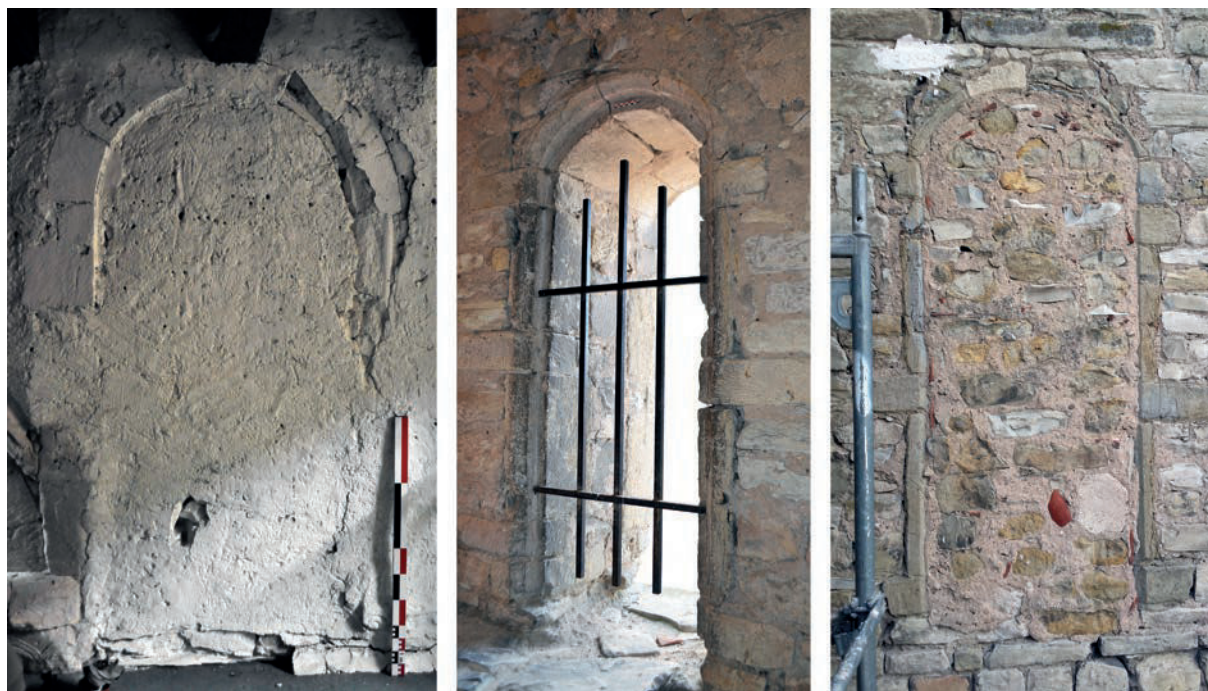
Fig. 83 – Portes percées dans le parement est, la tour d'escalier et le parement nord (clichés Cédric Moulis).
