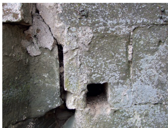
Fig. 25 – Trou de boulin façonné d'arête du chevet (cliché Cédric Moulis).
