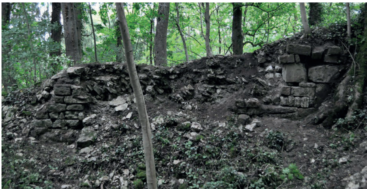
Fig. 8 – Parement intérieur du mur 2.1 de l'aula après nettoyage (cliché Cédric Moulis).
