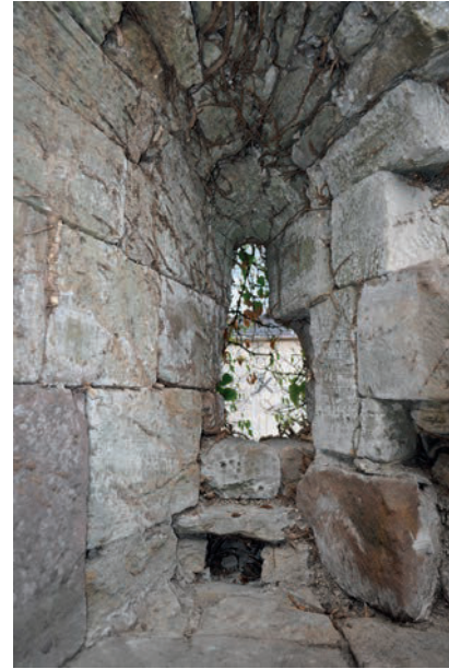
Fig. 16 – Trou de boulin dans l'embrasure d'une fenêtre de type 3 (cliché Cédric Moulis).
