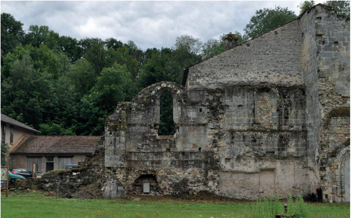
Fig. 5 – Élévation extérieure des vestiges du collatéral nord (cliché Cédric Moulis).
