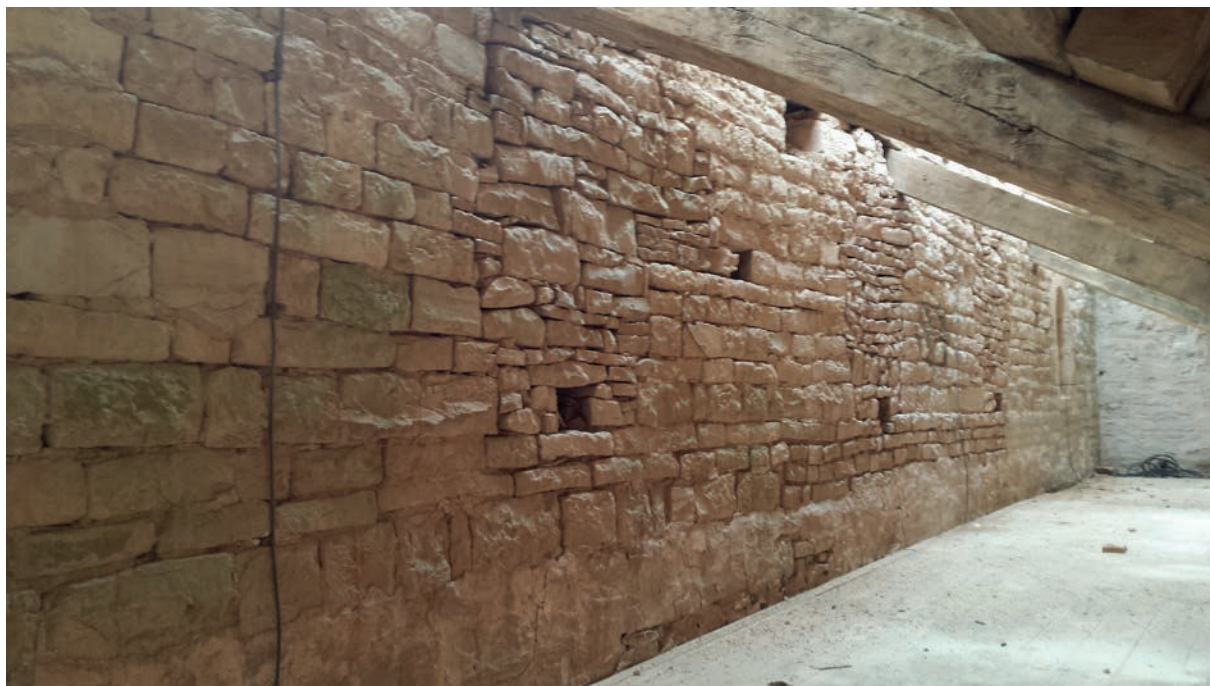
Fig. 26 – Mur gouttereau nord de la nef, parement extérieur (UM1) (cliché Cédric Moulis).
