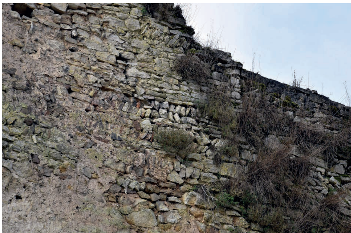
Fig. 34 – Courtine est, parement en épi dans l'élévation extérieure (cliché Cédric Moulis).
