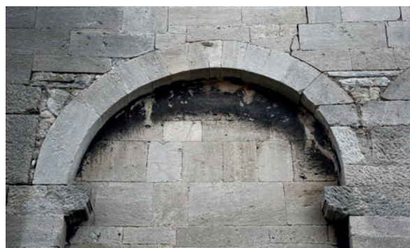
Fig. 75 – Arcature aveugle nord de la façade occidentale (cliché Cédric Moulis).
