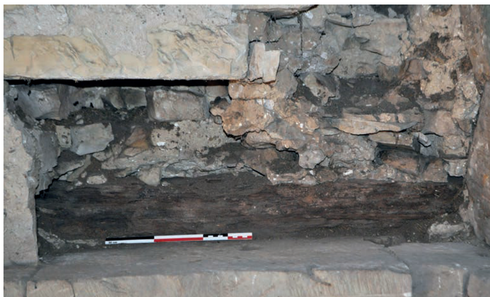
Fig. 104 – Poutre du sondage 1 dans la première travée du mur gouttereau nord (cliché Cédric Moulis).
