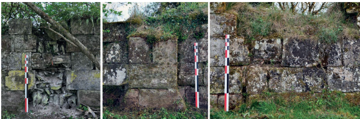
Fig. 14 – État actuel des trois contreforts de l'élévation extérieure nord (clichés Cédric Moulis).
