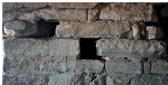
Fig. 80 – Trou de boulin dans la salle du Trésor (cliché Cédric Moulis).
