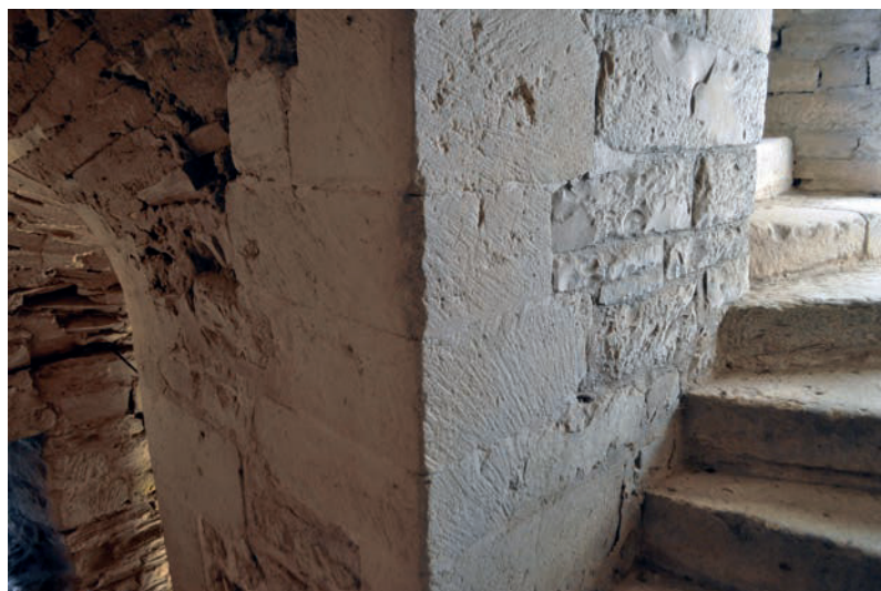
Fig. 51 – Pilier central de l'escalier (cliché Cédric Moulis).
