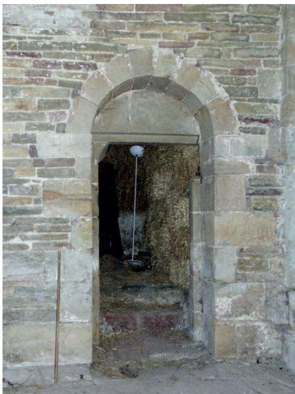
Fig. 34 – Porte d'accès à la salle capitulaire ou à la sacristie (cliché Cédric Moulis).
