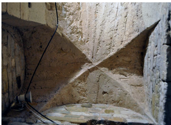
Fig. 70 – Voûte d'arêtes du rez-de-chaussée de la tour d'escalier (cliché Cédric Moulis).
