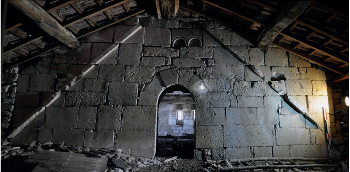
Fig. 34 – Porte d'accès à la tour-chœur et solin de pierre de la toiture primitive de la nef (clichés et photomontage Cédric Moulis).
