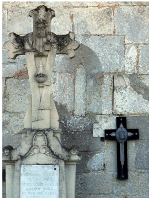
Fig. 6 – Fenêtre de la première travée de l'élévation nord de la nef (cliché Cédric Moulis).
