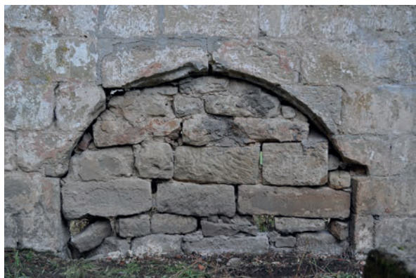
Fig. 14 – Porte bouchée faisant liaison entre le collatéral nord et le cloître (cliché Cédric Moulis).
