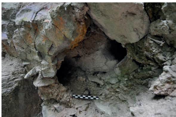
Fig. 21 – Croisement de deux trous de boulins superposés dans la maçonnerie d'angle (cliché Cédric Moulis).
