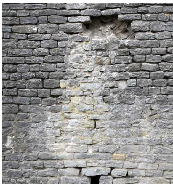
Fig. 56 – Reprise du mur au sein de l'élévation sud, UM 1 (cliché Cédric Moulis).
