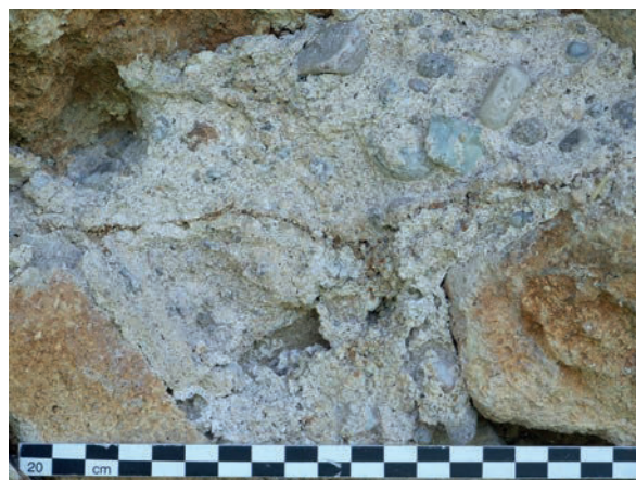
Fig. 31 – Apposition de deux mortiers à des moments séparés (cliché Cédric Moulis).
