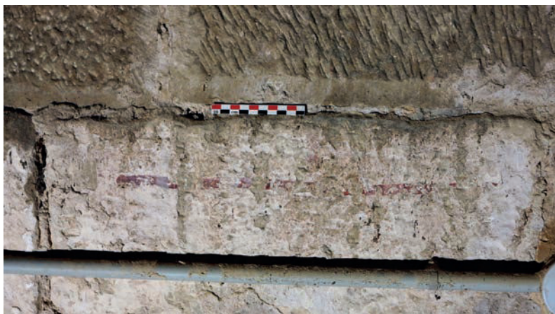
Fig. 22 – Vestiges de faux joints rubanés sur des pierres en emploi dans le mur de la bibliothèque moderne (cliché Cédric Moulis).
