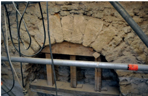
Fig. 10 – Arc en plein cintre de la porte primitive (cliché Cédric Moulis).
