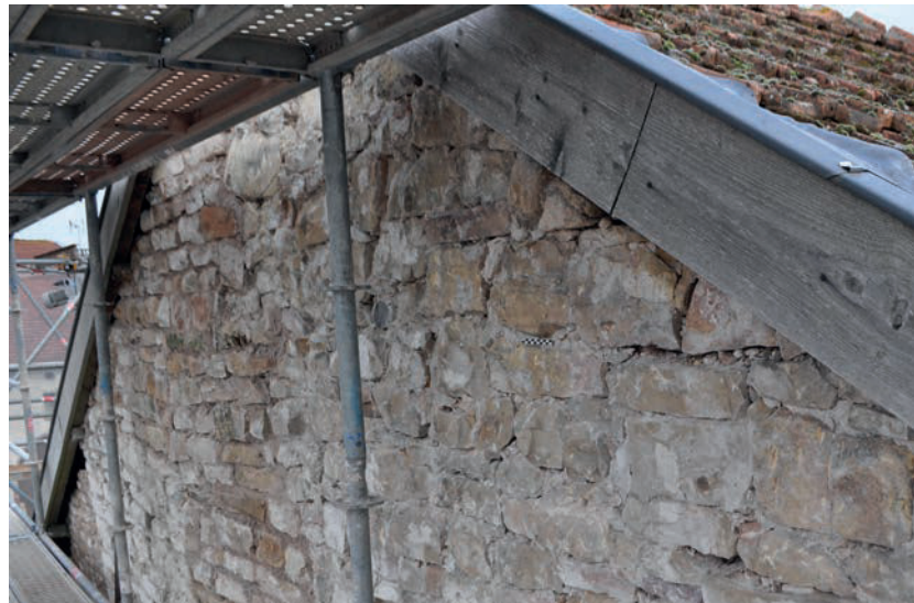
Fig. 67 – Structure du parement de la façade occidentale (cliché Cédric Moulis).
