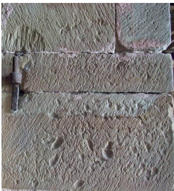
Fig. 37 – Traces de layage observables sur les montants de la porte (cliché Cédric Moulis).
