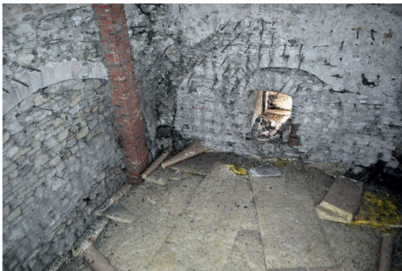
Fig. 28 – Premier niveau de la tour-porte. À gauche, se devine l'arcature surmontant les ouvertures (non visibles ici) de la tribune. À droite, l'oculus sud comblé (cliché Cédric Moulis).
