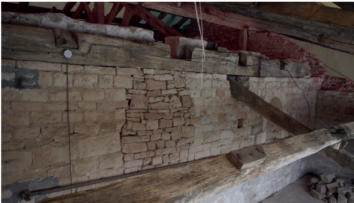
Fig. 51 – Sablière nord occidentale, la mieux conservée (cliché Cédric Moulis).
