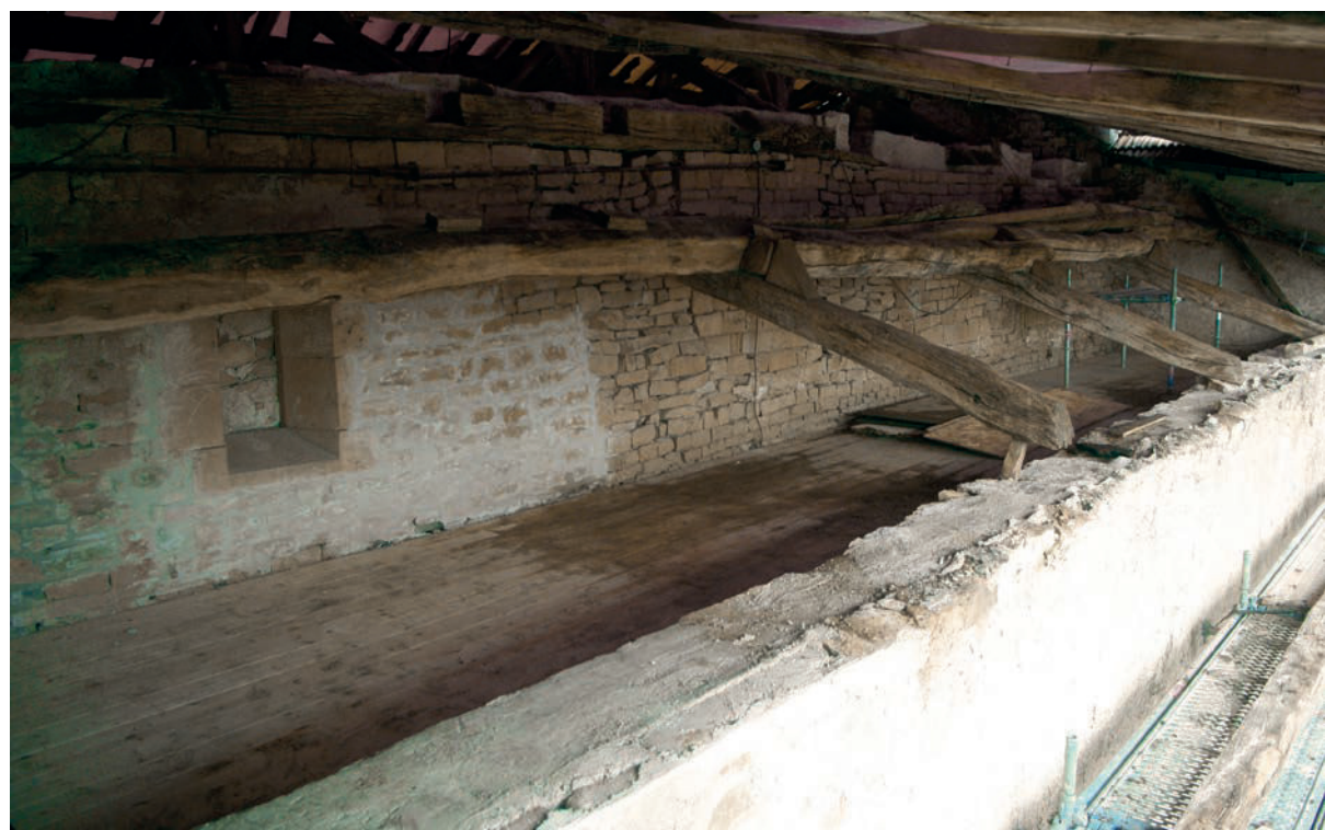
Fig. 27 – Mur gouttereau sud de la nef, parement extérieur (UM2) (cliché Cédric Moulis).
