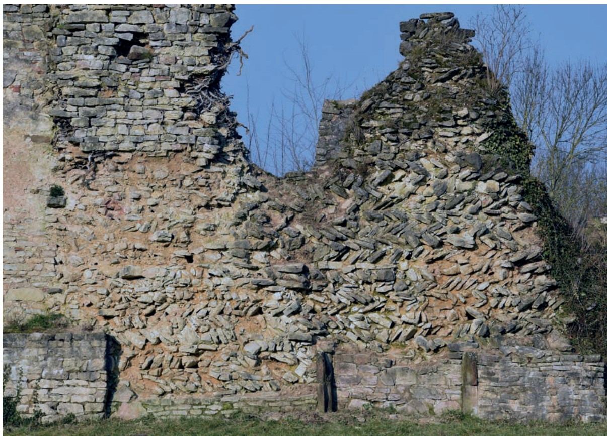
Fig. 26 – Courtine nord, partie du blocage monté en épi (cliché Cédric Moullis).
