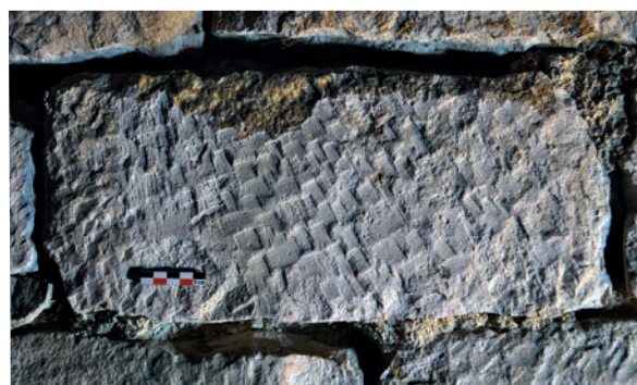
Fig. 21 – Traces de ciseau, visibles sur les pierres du parement intérieur du premier étage de la tour-chœur (cliché Cédric Moulis).
