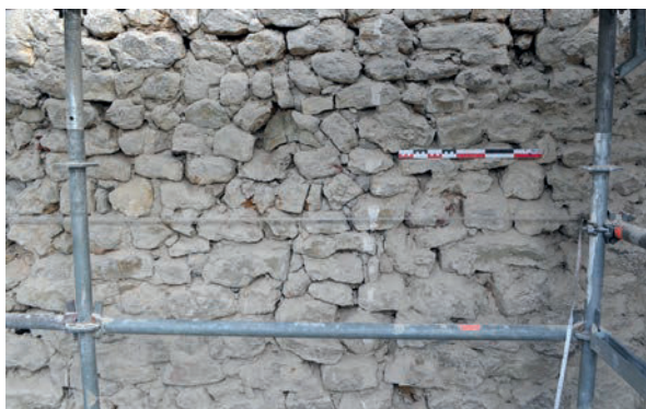
Fig. 29 – Élévation sud, assises rectilignes et plus grossières (cliché Cédric Moulis).
