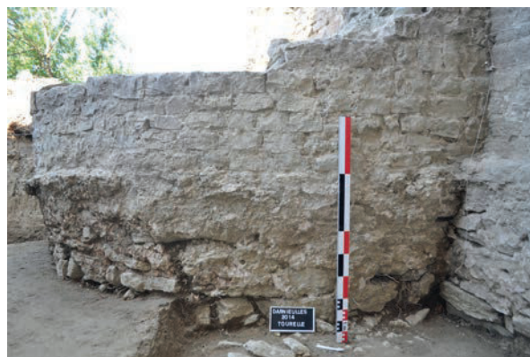
Fig. 43 – Fondations de la tourelle semi-circulaire (cliché Cédric Moulis).
