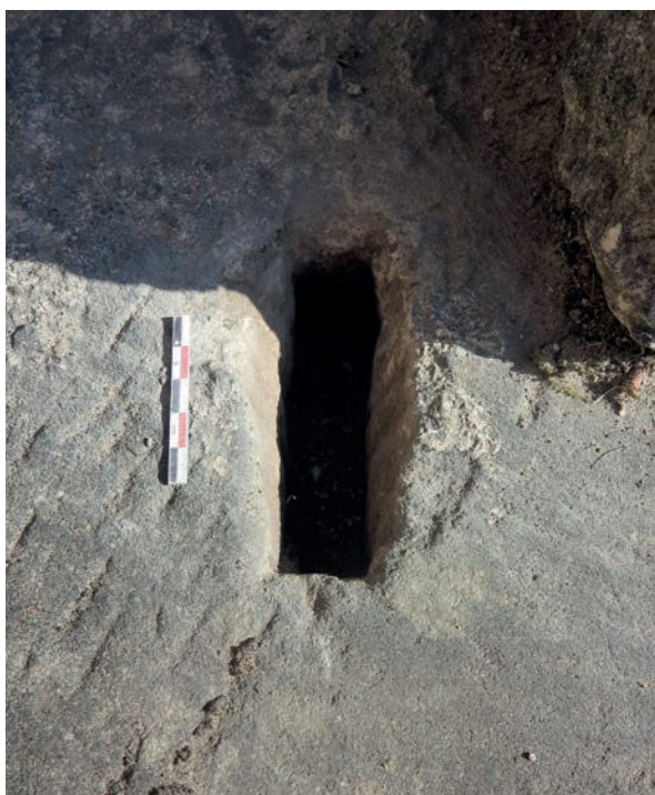
Fig. 39 – Trou de pince visible sur le lit d'attente du tailloir du pilastre séparant les travées 4 et 5 (cliché Benoit Rouzeau).
