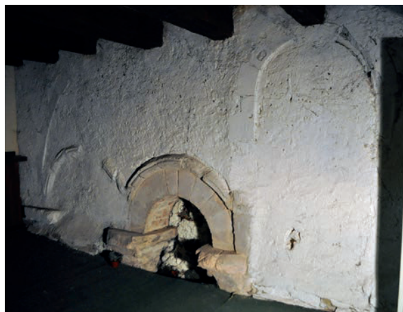
Fig. 16 – Sommet des anciennes ouvertures formant la tribune haute. La troisième arcade a été remplacée par une porte, bouchée par la suite (cliché Cédric Moulis).
