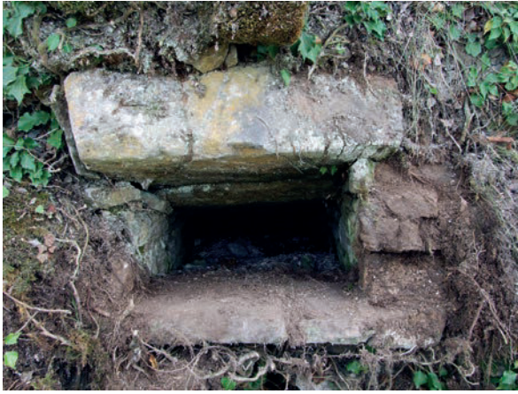
Fig. 6 – Puits de lumière de l'élévation nord-est (cliché Cédric Moulis).
