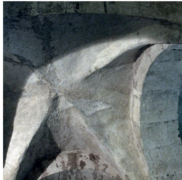
Fig. 16 – Voûte d'arêtes de la crypte d'Esley (cliché Cédric Moulis).
