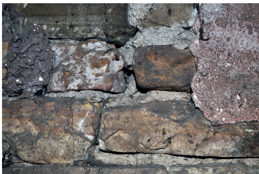
Fig. 99 – Les différents mortiers et enduits observés sur la chapelle : au centre, le mortier beige originel ; au-dessus, un liant gris ; à gauche, un mortier rose foncé ; à droite, l'enduit rose (cliché Cédric Moulis).
