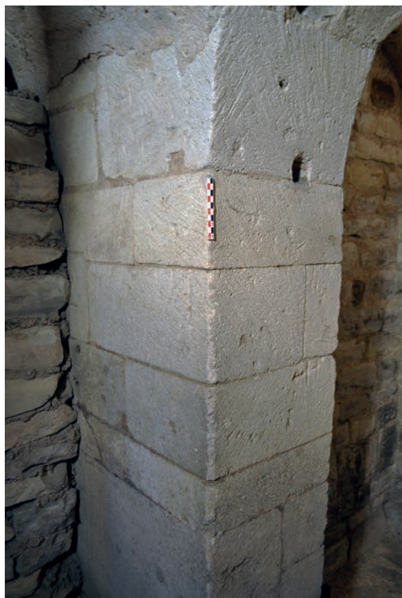
Fig. 69 – Encoches pour cintres pratiquées dans les sommiers des voûtes du rez-de-chaussée de la tour d'escalier (cliché Cédric Moulis).
