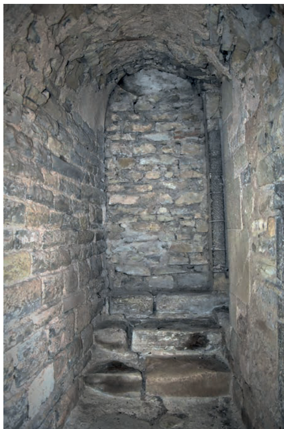
Fig. 33 – Premier étage de la tour d'escalier. Couloir (maintenant bouché) menant à la tribune haute (cliché Cédric Moulis).
