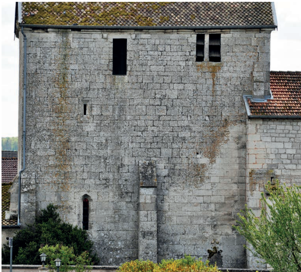
Fig. 12 – Élévation nord de la tour-chœur (cliché Cédric Moulis).
