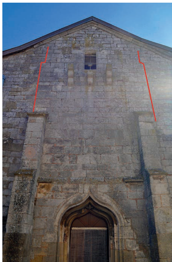
Fig. 10 – Coups de sabre dans la façade occidentale, prouvant l'existence d'une partition initiale en trois vaisseaux (cliché Cédric Moulis).
