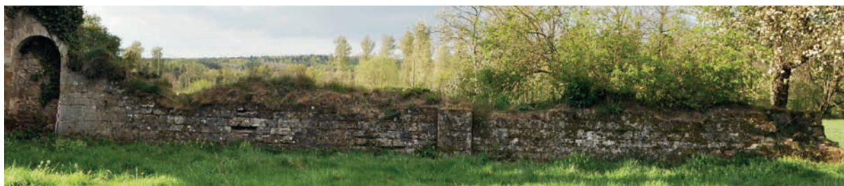
Fig. 17 – Vestiges de l'élévation intérieure nord (cliché Ellia Martin).
