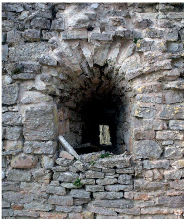
Fig. 11 – Élévation intérieure sud-ouest, fenêtre du premier étage (cliché Cédric Moulis).
