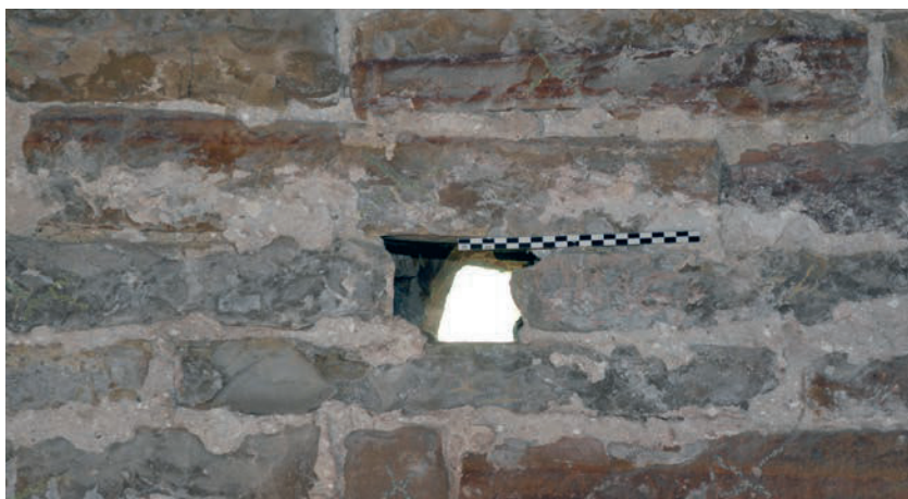
Fig. 108 – Trou de boulins maçonné dans la nef (cliché Cédric Moulis).
