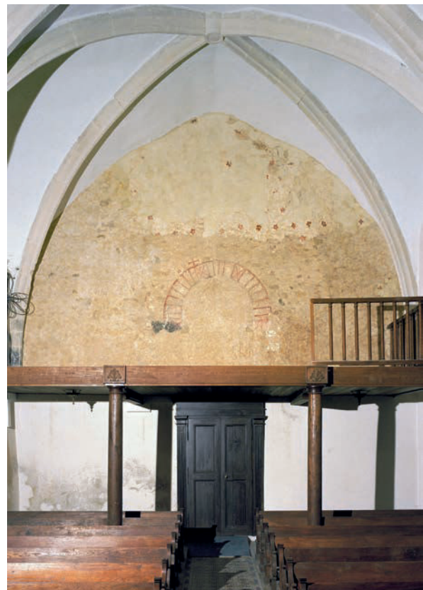
Fig. 12 – Vue d'ensemble du mur du clocher à l'intérieur de la nef. On remarque l'arc de la porte surélevée (cliché Région Grand Est - Inventaire général / Alain George).
