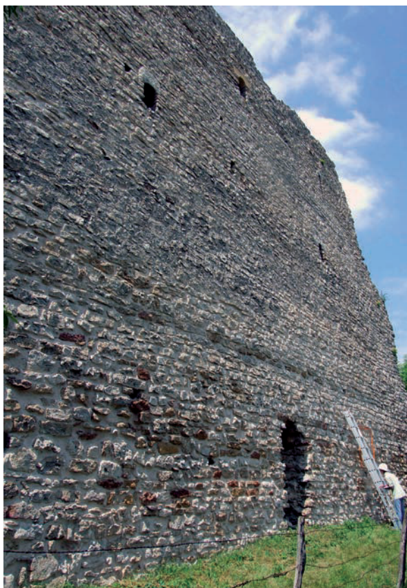
Fig. 23 – Bombements observés dans le parement de l'élévation extérieure est, dont le rythme est calé sur celui des assises de réglage (cliché Cédric Moulis).
