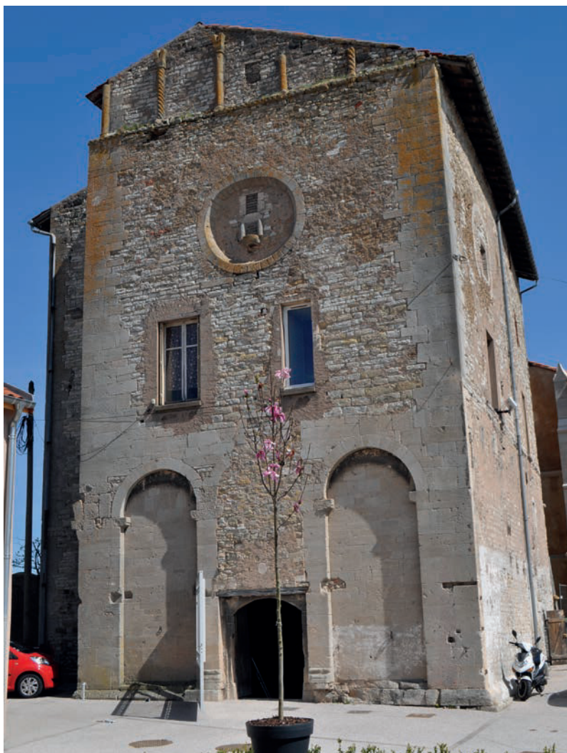
Fig. 6 – Façade occidentale de la tour-porche, vue générale (cliché Cédric Moulis).
