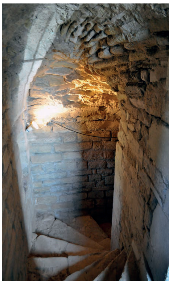
Fig. 62 – Grand escalier. Partie de la voûte sans enduit (cliché Cédric Moulis).
