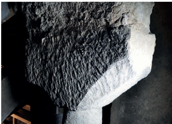
Fig. 24 – Chapiteau de la baie est, traces de marteau taillant droit ou polka (cliché Cédric Moulis).
