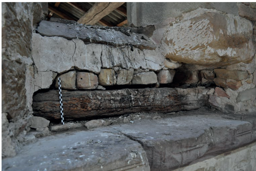
Fig. 102 – Poutre en chêne (abattage > 1157) piégée dans la maçonnerie sur la fenêtre de la seconde travée du mur gouttereau nord (UM 16) (cliché Cédric Moulis).
