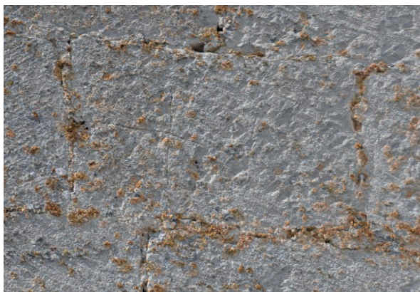
Fig. 25 – Marque de montage VX (à l'envers) sur une pierre du parement oriental de la tour-chœur (cliché Cédric Moulis).
