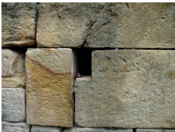
Fig. 109 – Trou de boulin façonné d'angle dans le chevet (cliché Ellia Martin).
