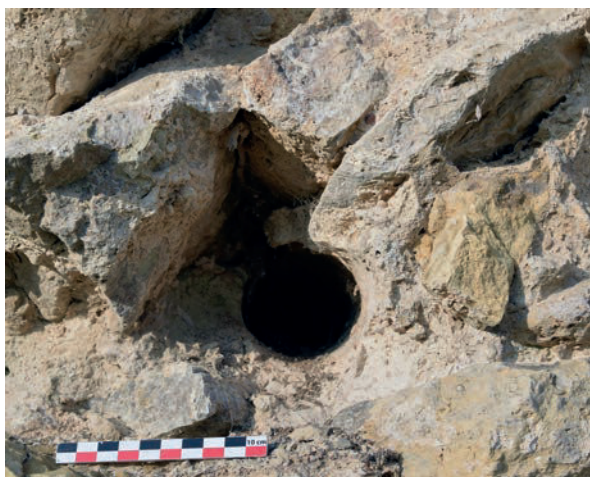
Fig. 29 – Trou de boulin n°8 sur la courtine nord (cliché Cédric Moulis).
