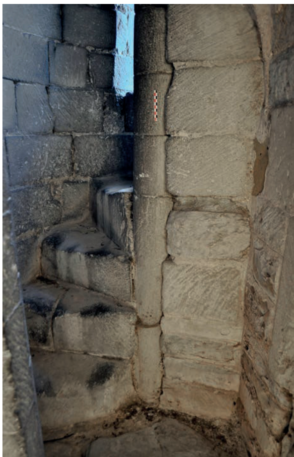
Fig. 63 – Escalier en vis (cliché Cédric Moulis).
