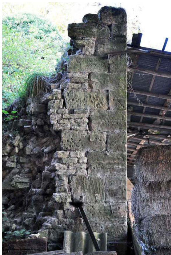
Fig. 47 – Chaîne d'angle nord-est de la tour (cliché Cédric Moulis).
