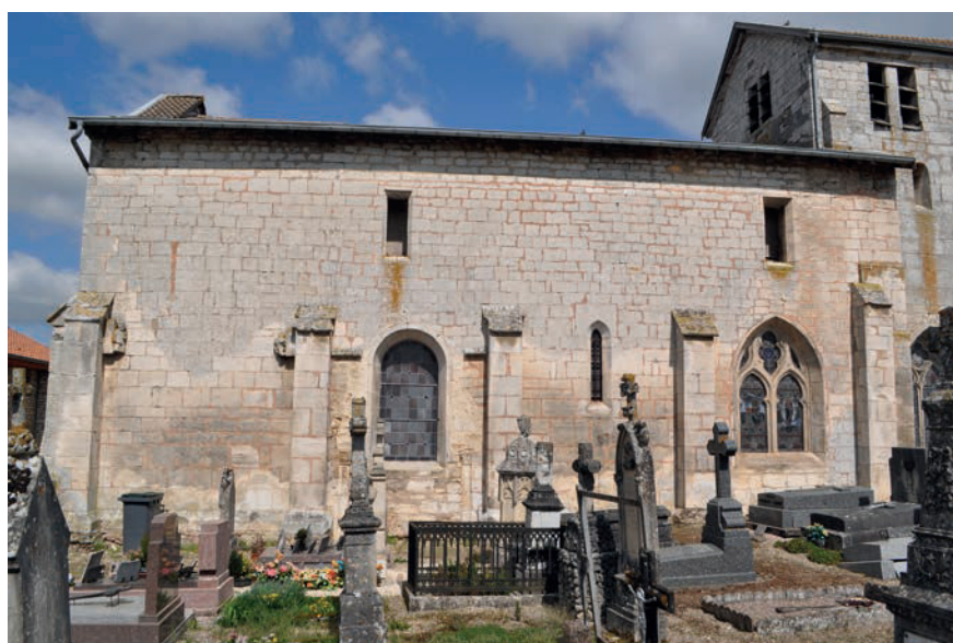
Fig. 4 – Vue générale du gouttereau sud de la nef (cliché Cédric Moulis).
