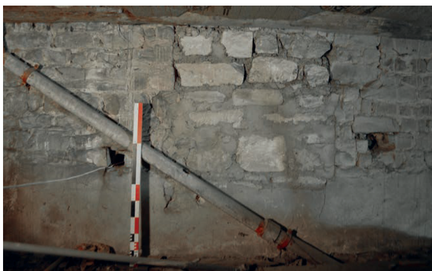
Fig. 26 – Fenêtre romane démontée puis bouchée, intérieur élévation sud. On remarque deux trous de boulin de part et d'autre (cliché Cédric Moulis).
