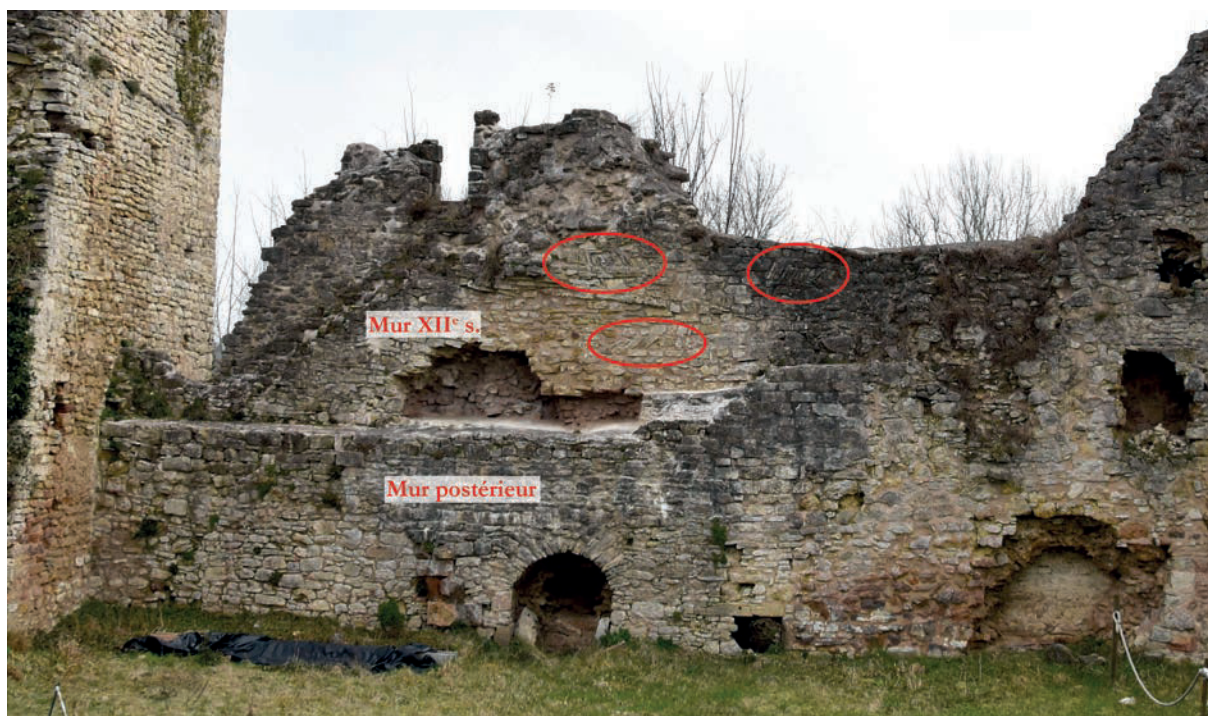
Fig. 33 – Courtine est, trois rangs simples de pierres disposées de biais dans le parement intérieur (cliché Cédric Moulis).
