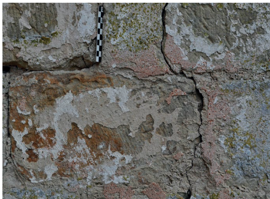
Fig. 42 – Détail des enduits de l'intérieur du collatéral où l'on remarque le pré-enduit beige et l'enduit blanc primitif ; le pré-enduit rose et l'enduit blanc moderne (cliché Cédric Moulis).
