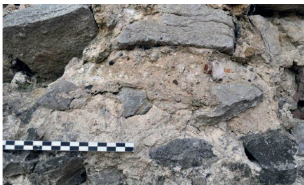
Fig. 29 – Limite entre le mortier de chaux basique (en bas) et le mortier composé d'inclusions de tuileau et de charbon (cliché Cédric Moulis).
