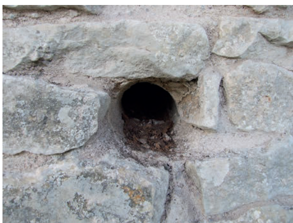
Fig. 36 – Vestiges du boulin en hêtre (cliché Cédric Moulis).
