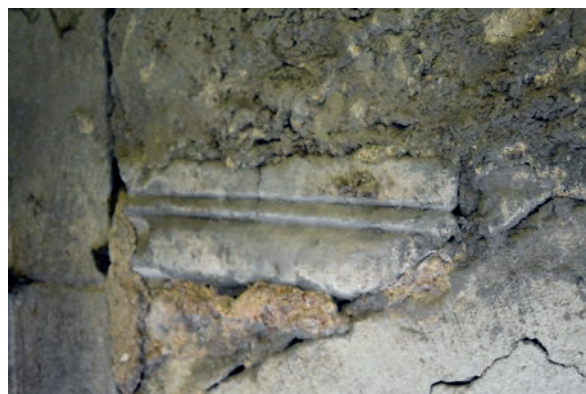
Fig. 55 – Remploi de corniche dans le remontage de la porte d'entrée de la tour-porche (cliché Cédric Moulis).
