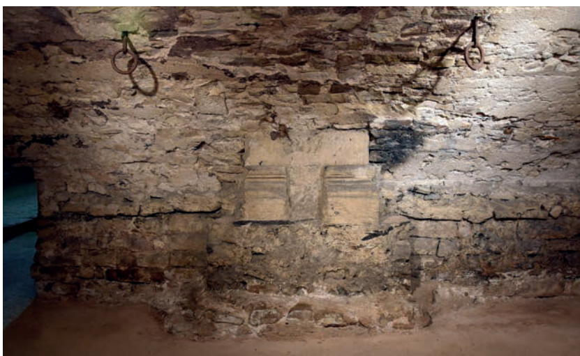
Fig. 14 – Base et fondation de pilastre sur l'élévation est (cliché Cédric Moulis).
