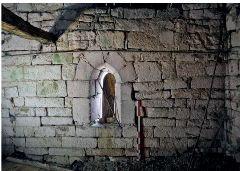
Fig. 27 – Fenêtre sud du premier étage de la tour-chœur, composée de voussoirs en rempli. On note la différence de traitement des surfaces entre les pierres du parement et celles composant la fenêtre (cliché Cédric Moulis).
