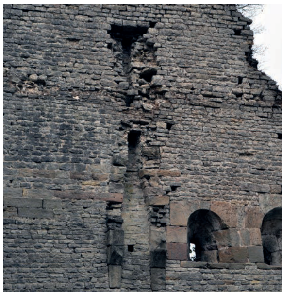
Fig. 10 – Cheminée de l'élévation ouest, UM 2 (cliché Cédric Moulis).
