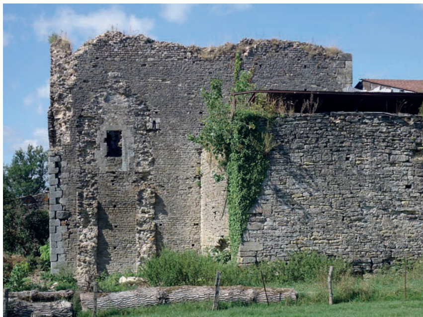
Fig. 17 – Élévation extérieure sud, UM 5 (cliché Cédric Moulis).
