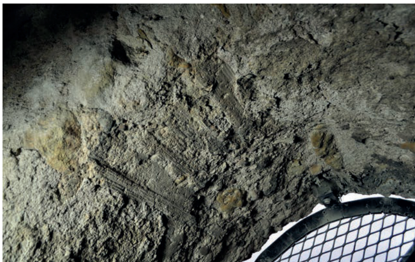
Fig. 35 – Empreintes de couchis sur l'intrados de l'un des arcs en plein cintre de la baie géminée est du 3 e étage (cliché Cédric Moulis).
