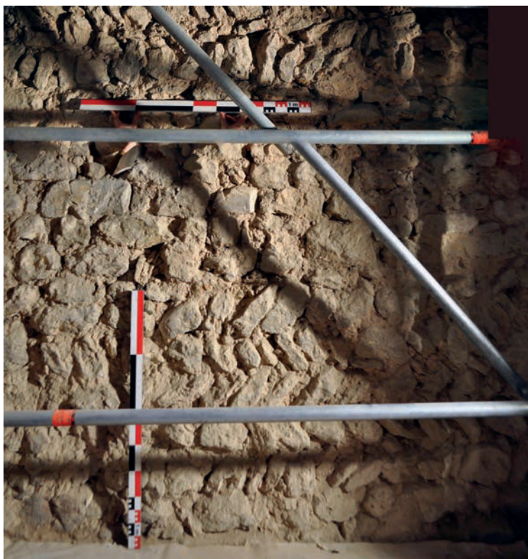
Fig. 34 – Assises en épi, élévation intérieure nord (cliché et photomontage Cédric Moulis).
