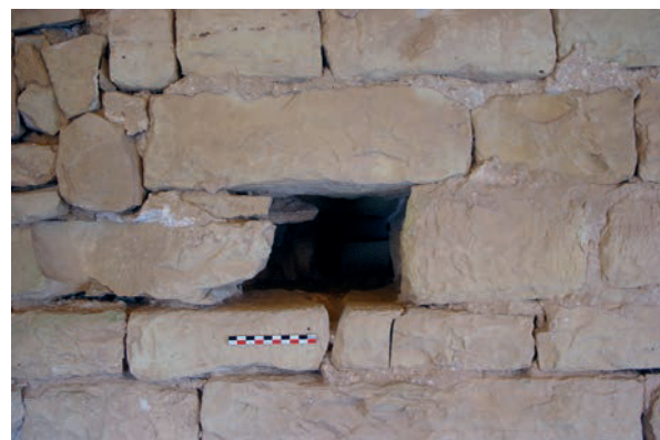
Fig. 46 – Trou de boulin UC 1.5, mur gouttereau nord (cliché Cédric Moulis).
