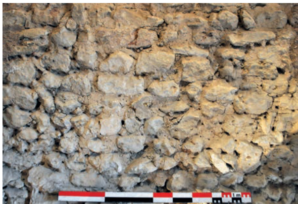
Fig. 32 – Parement intérieur, modules proches du ratio 1:1 (cliché Cédric Moulis).
