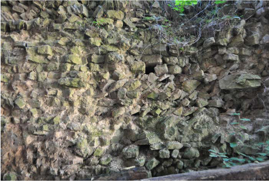
Fig. 57 – Blocage disposé à plat ou en épi, UM 8 (cliché Cédric Moulis).
