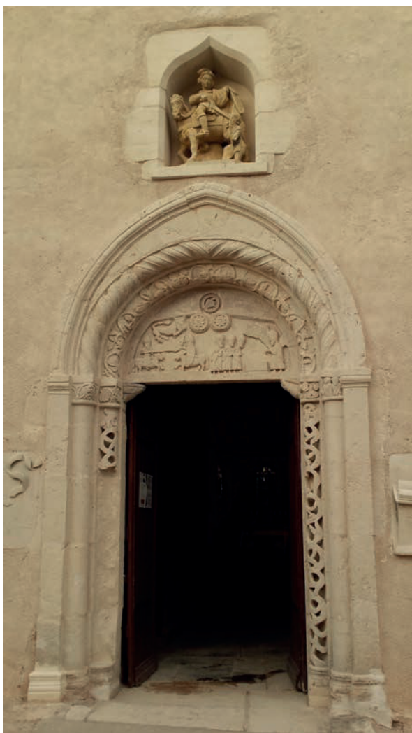
Fig. 9 – Portail occidental de l'église Vomécourt-sur-Madon (cliché Cédric Moulis).
