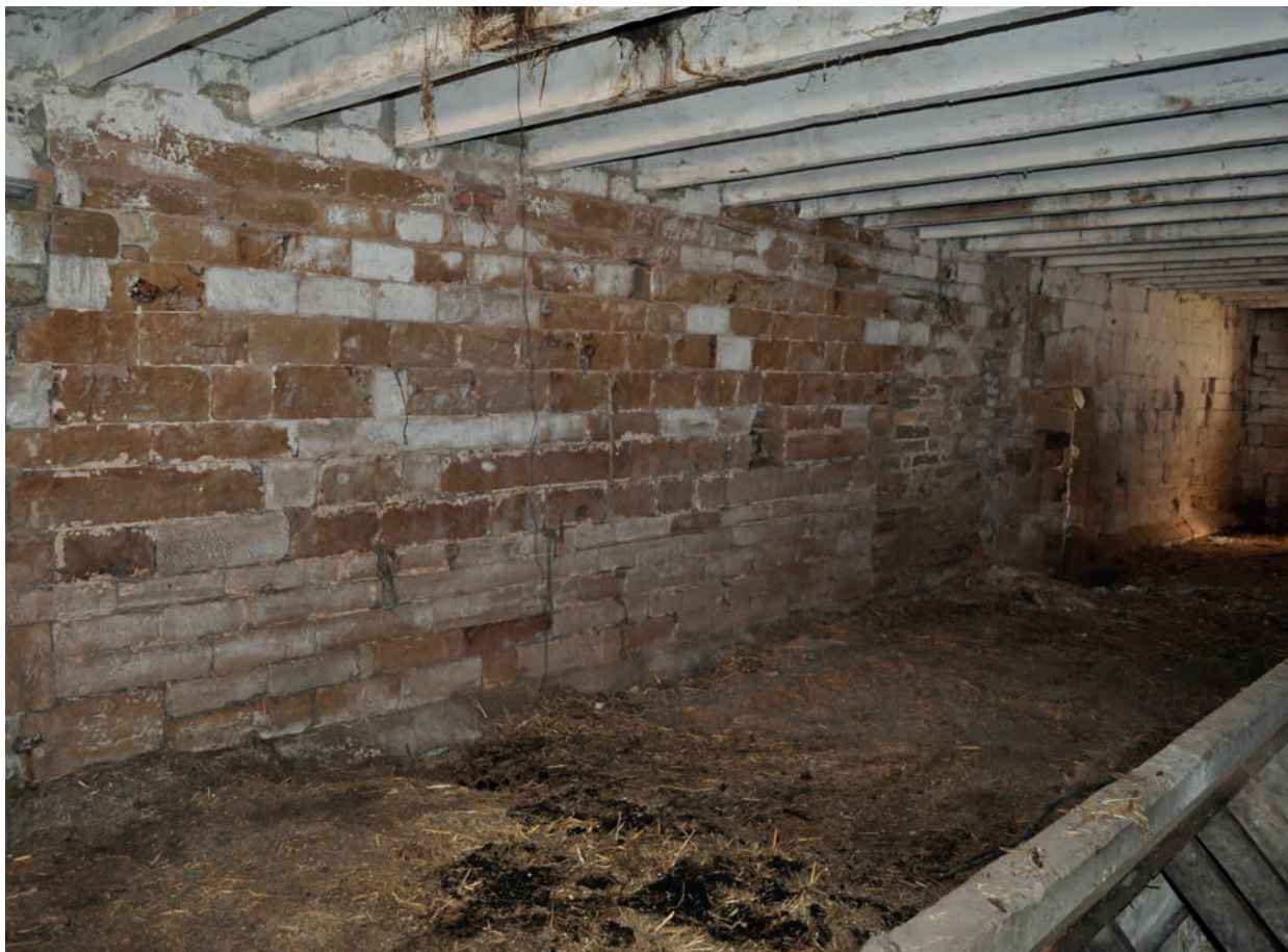
Fig. 14 – Mur gouttereau sud (UM 6), partie centrale et ouest, visible depuis le rez-de-chaussée de la grange (cliché Cédric Moulis).
