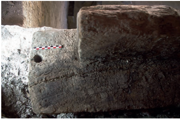
Fig. 54 – Trou de cheville à l'extrémité de la sablière nord (cliché Cédric Moulis).
