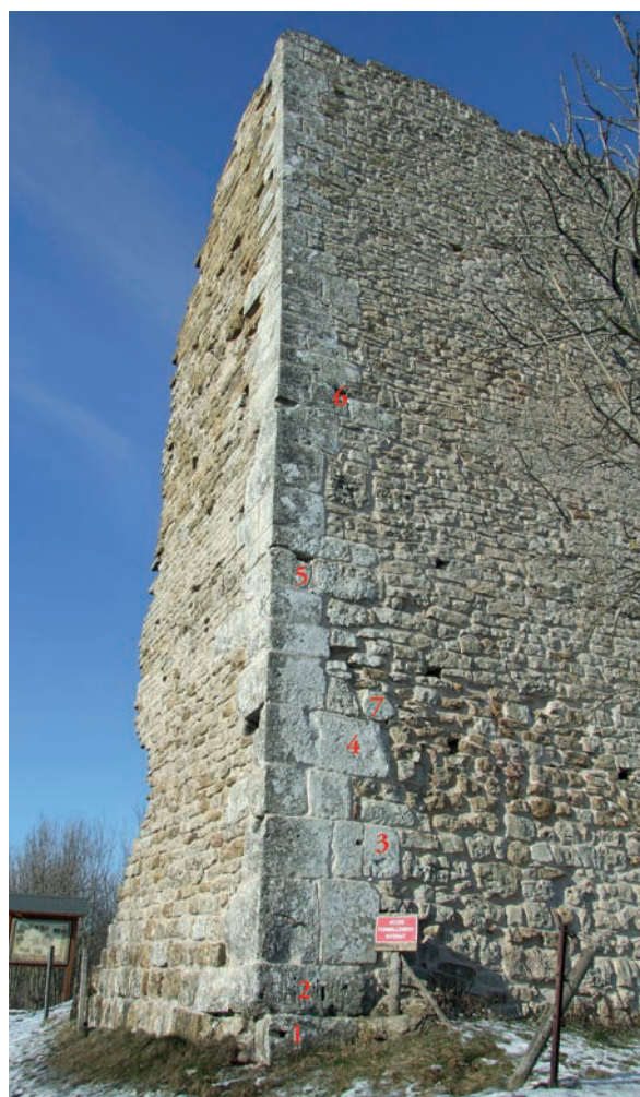
Fig. 17 – Chaînage d'angle sud composé de blocs antiques en remploi, numérotés de 1 à 7 (cliché et DAO Cédric Moulis).
