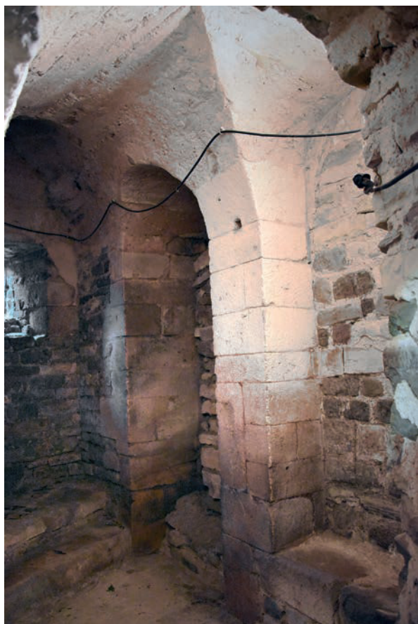
Fig. 31 – Rez-de-chaussée de la tour d'escalier. Les deux passages bouchés, notamment celui qui donnait vers le bas-côté nord de la prieurale romane (cliché Cédric Moulis).
