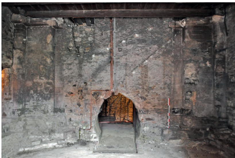
Fig. 27 – Passage vers l'ancienne nef. L'arc triomphal a été obturé pour ne laisser place qu'à un passage restreint (cliché Cédric Moulis).
