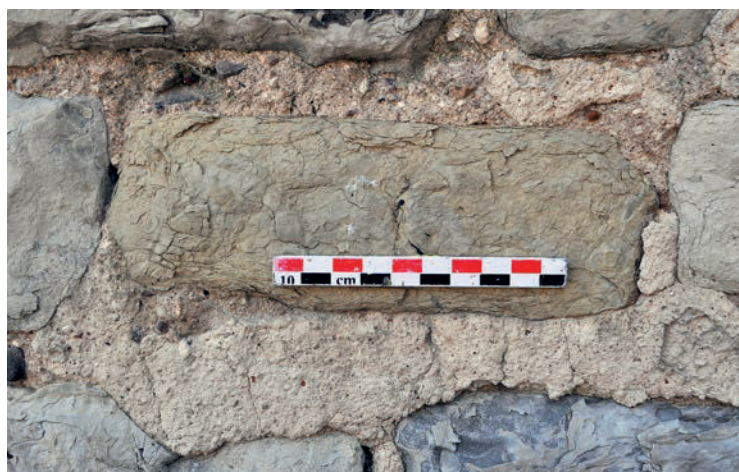
Fig. 77 – Mortier liant les pierres du parement extérieur (en haut) et enduit couvrant à pierre vue (en bas) (cliché Cédric Moulis).
