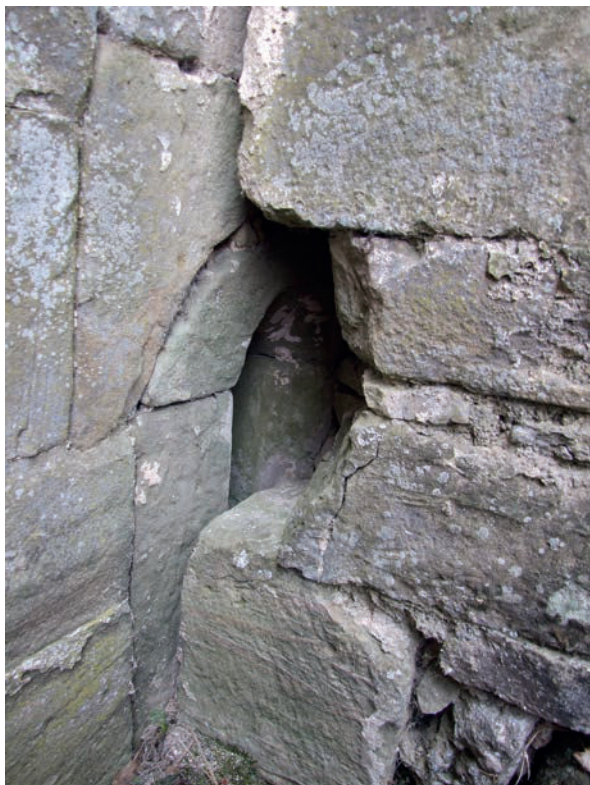
Fig. 18 – Linteau double sur l'élévation extérieure de la fenêtre axiale de l'abside centrale de la crypte (cliché Cédric Moulis).
