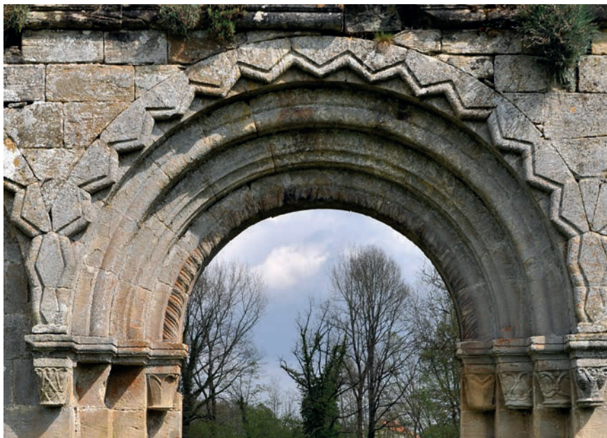
Fig. 7 – Les quatre rouleaux composant l'arc en plein cintre du portail (cliché Ellia Martin).
