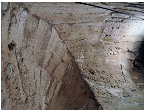
Fig. 61 – Bourrelet de mortier entre les cintres couverts de couchis (cliché Cédric Moulis).
