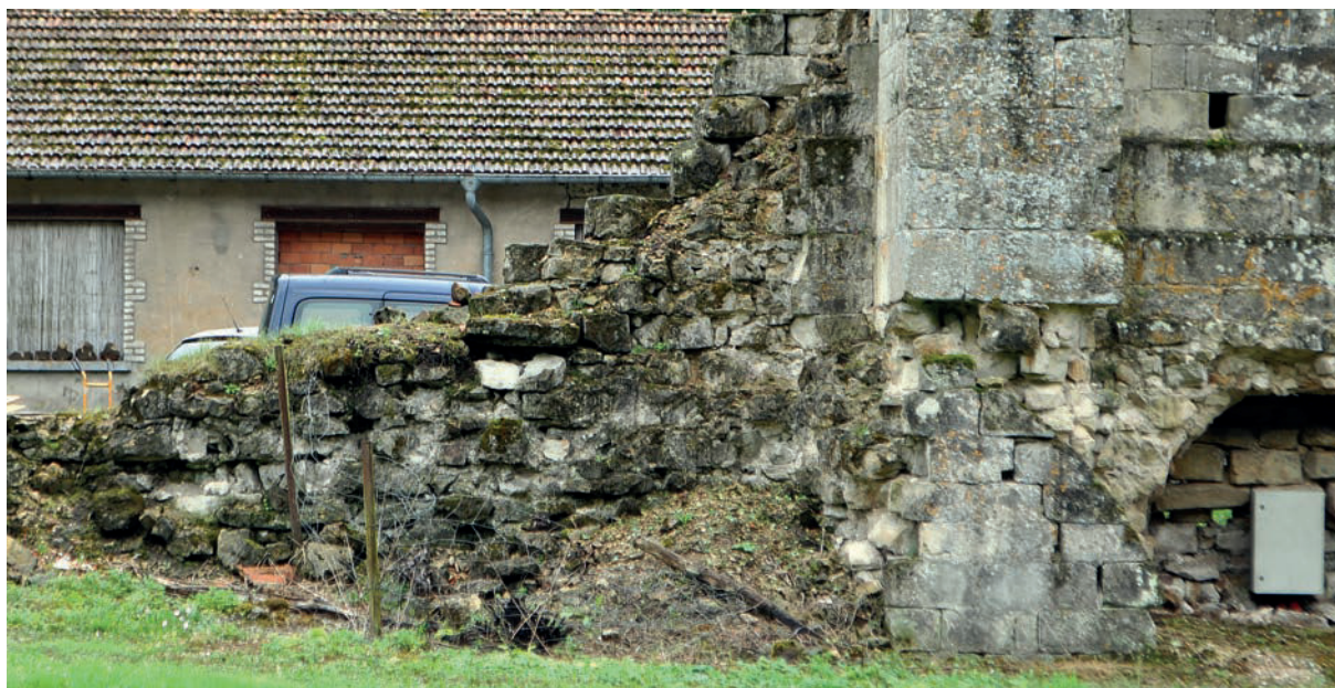
Fig. 35 – Blocage liant le collatéral de l'église abbatiale au cloître (cliché Cédric Moulis).
