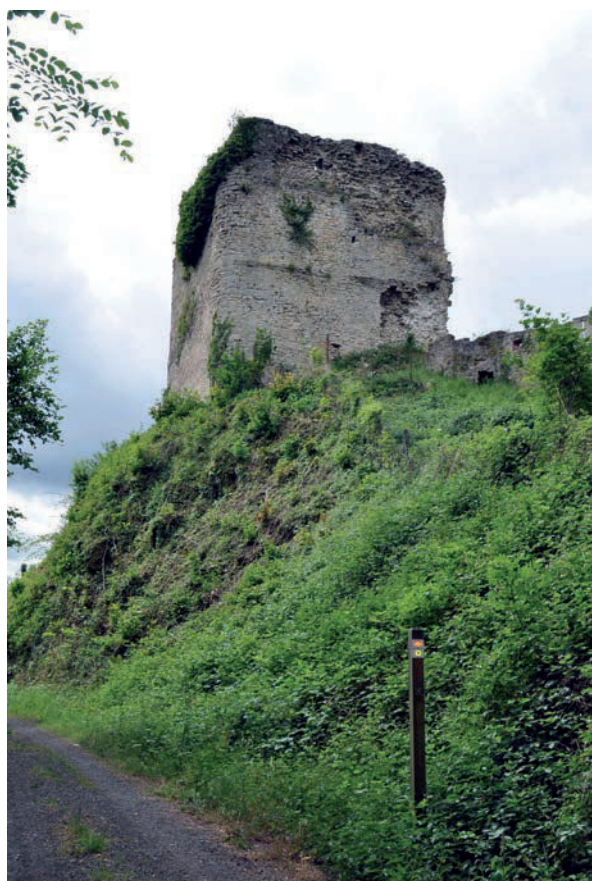
Fig. 3 – Vue du donjon depuis le fossé (cliché Cédric Moulis).
