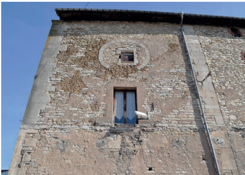
Fig. 12 – Élévation sud, on remarque les traces d'une fenêtre romane sous la grande baie actuelle, et l'oculus bouché (cliché Cédric Moulis).
