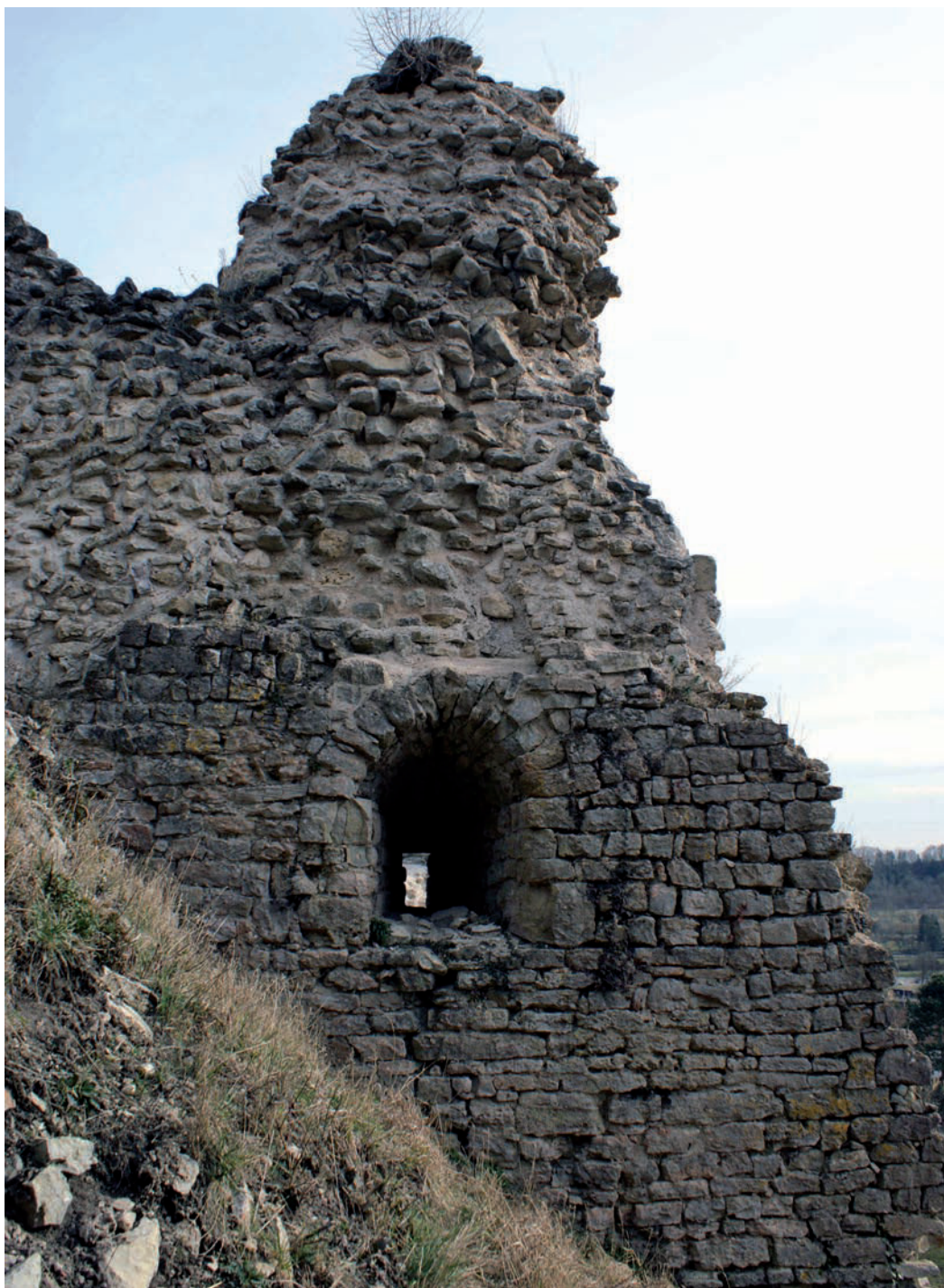
Fig. 9 – Élévation sud-est du donjon, parement intérieur (cliché Cédric Moulis).
