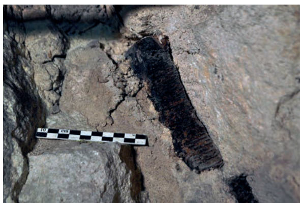
Fig. 67 – Couchis noyé dans le mortier de la voûte (cliché Cédric Moulis).
