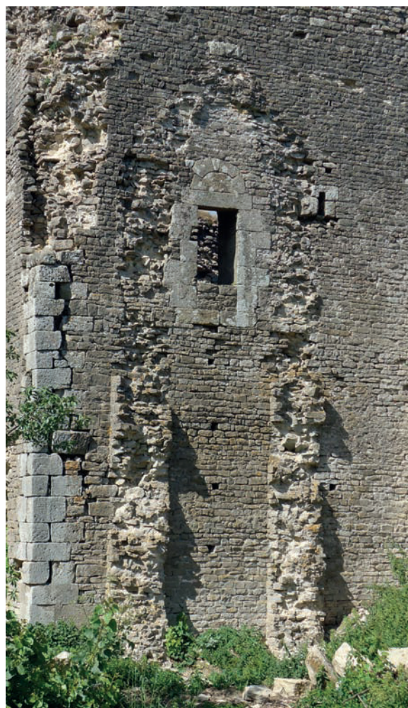
Fig. 24 – Arrachement de la tourelle semi-circulaire (cliché Cédric Moulis).
