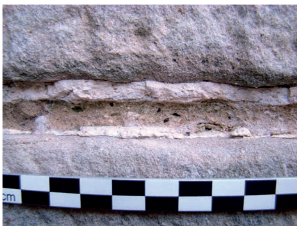
Fig. 100 – Mortier beige initial entre les pierres du parement du chevet. Le blanc est un vestige de l'enduit (cliché Cédric Moulis).
