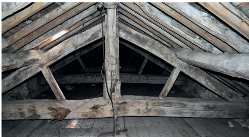
Fig. 65 – Détail de l'assemblage à mi-bois de l'entrait n°8, gouttereau sud (cliché Cédric Moulis).
