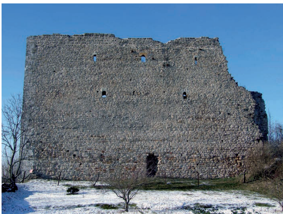
Fig. 3 – Élévation extérieure est du donjon (cliché Cédric Moulis).
