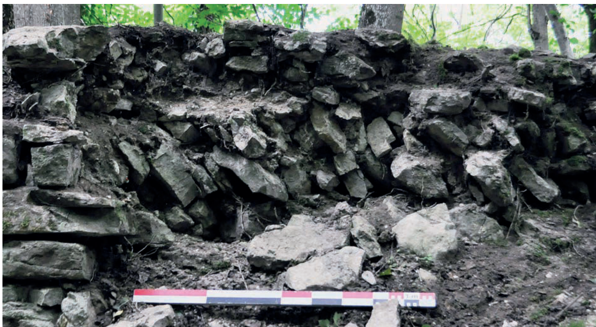
Fig. 16 – Mur 2.1 de l'aula. Blocage en épi (cliché Cédric Moulis).
