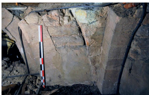
Fig. 66 – Rez-de-chaussée de la tour-porche. Départ de la voûte sud-est (cliché Cédric Moulis).
