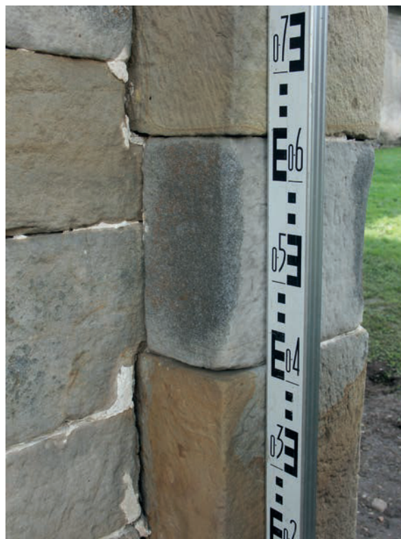
Fig. 95 – Chaînage en besace et à décrochement, visible sur le pan axial du chevet pentagonal (cliché Cédric Moulis).
