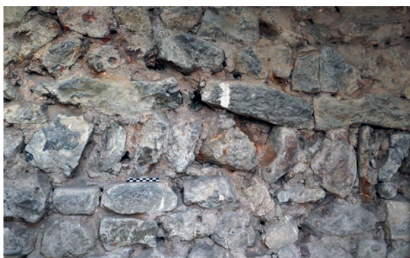
Fig. 33 – Assise partiellement en épi, élévation extérieure sud (cliché Cédric Moulis).
