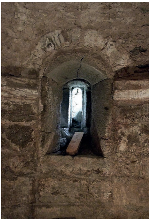
Fig. 19 – Fenêtre axiale de l'abside centrale de la crypte. Le linteau et les piédroits ont été ajoutés sur un état antérieur et le bas de la fenêtre a été comblé sur deux assises, sans doute pour renforcer la maçonnerie suite au rehaussement du chevet (cliché Cédric Moulis).
