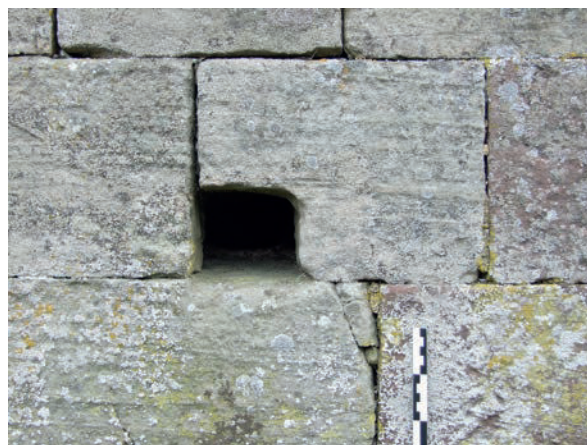
Fig. 24 – Trou de boulin n°2 façonné d'angle du collatéral nord (cliché Cédric Moulis).
