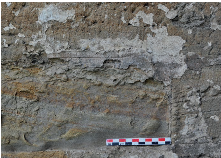
Fig. 42 – Vestiges des joints tirés en fer et de l'enduit blanc qui les recouvrent, sur le parement intérieur de la façade occidentale (cliché Cédric Moulis).
