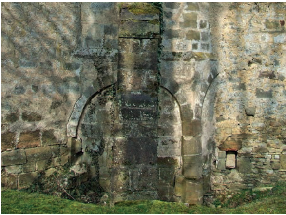
Fig. 14 – Arc aveugle du pan axial du chevet, coupé par un contrefort postérieur (cliché Cédric Moulis).
