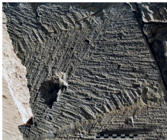
Fig. 44 – Layage oblique réalisé depuis deux angles différents. Arc doubleau de la tour-porche (cliché Cédric Moulis).
