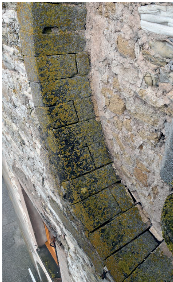
Fig. 76 – Détail de l'oculus de la façade occidentale. Certains voussoirs sont composites. En haut, on remarque une encoche servant peut-être à l'ancrage d'un cintre (cliché Cédric Moulis).
