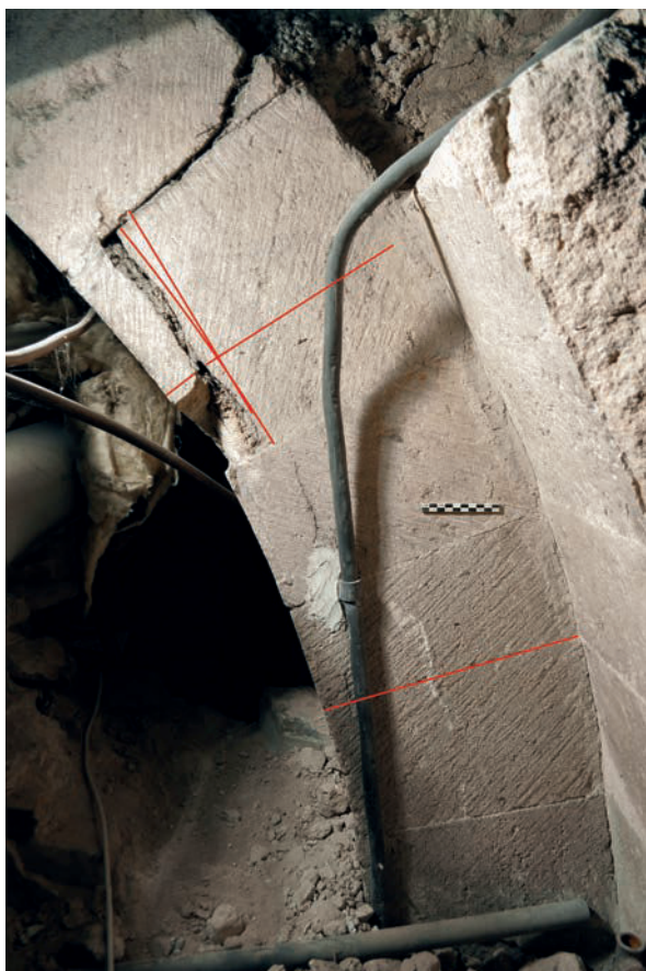
Fig. 74 – Tracés préparatoires sur l'arc séparant la tour-porche de l'ancienne nef (cliché Cédric Moulis).
