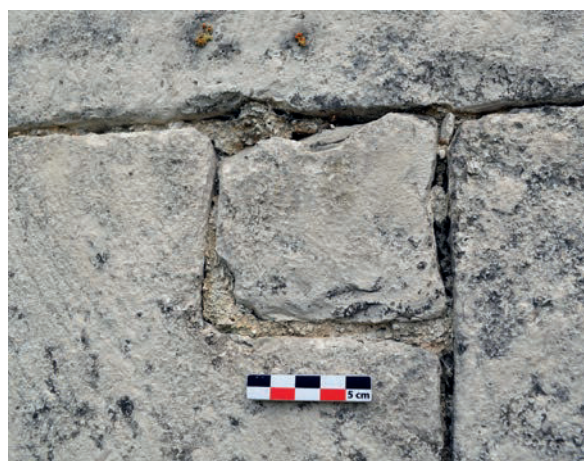
Fig. 33 – Trou de boulin façonné d'angle, élévation nord de la tour-chœur (cliché Cédric Moulis).
