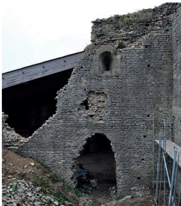
Fig. 9 – Élévation intérieure est, UM 4 (cliché Cédric Moulis).
