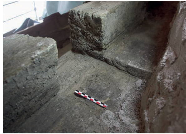
Fig. 57 – Surcreusement d'ajustement d'une ferme au niveau d'une encoche (cliché Cédric Moulis).
