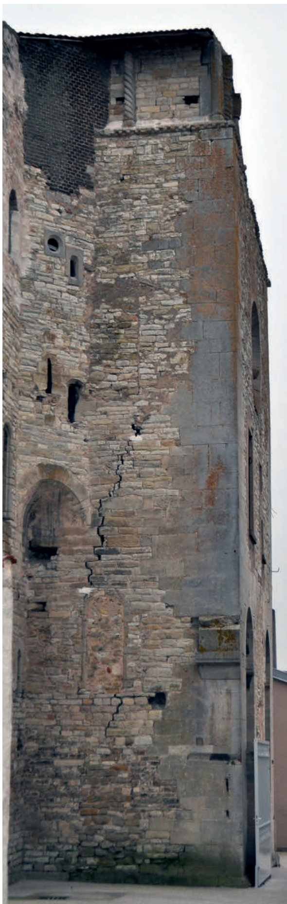
Fig. 21 – Élévation nord de la tour-porche. On distingue deux portes obturées (cliché Cédric Moulis).
