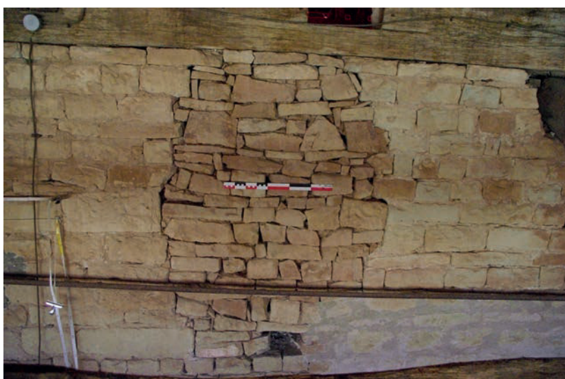
Fig. 66 – Bouchage (UC 1.11) à l'emplacement d'une fenêtre romane sur le mur gouttereau nord (cliché Cédric Moulis).
