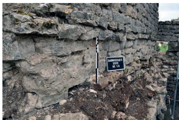
Fig. 76 – Chéneau d'évacuation des eaux de pluie sur le mur sud de la tour, UM 1 (cliché Cédric Moulis).
