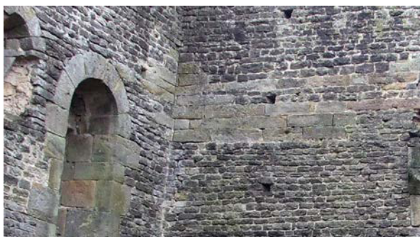
Fig. 46 – Emplacement des modules en grès dans le parement intérieur de l'angle sud-ouest de la tour (cliché Cédric Moulis).
