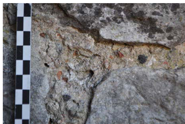
Fig. 62 – Mortier de chaux avec inclusion de tuileau (cliché Cédric Moulis).
