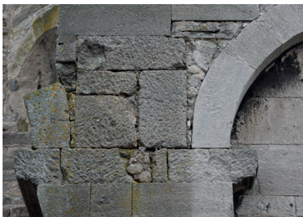
Fig. 8 – Façade occidentale, pierres retaillées au pic ou à la broche (cliché Cédric Moulis).
