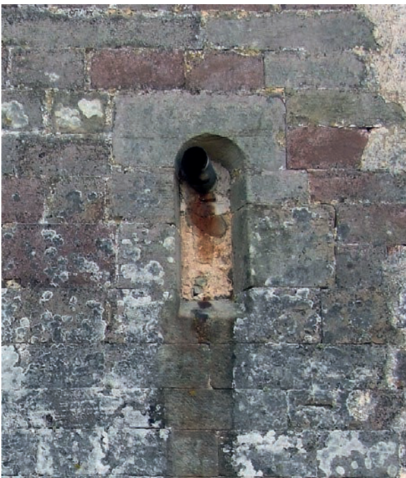
Fig. 21 – Fenêtre romane sur le parement initial du collatéral nord (cliché Cédric Moulis).
