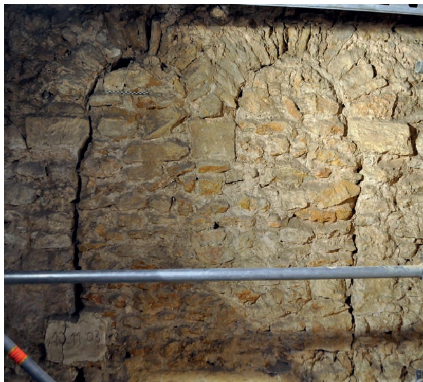
Fig. 15 – Baie géminée rebouchée au 3 e étage (cliché Cédric Moulis).
