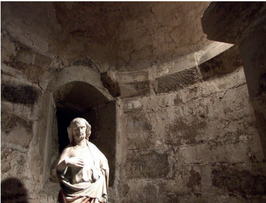
Fig. 20 – Abside nord de la crypte. On remarque la corniche chanfreinée, interrompue par la transformation de la fenêtre (cliché Cédric Moulis).
