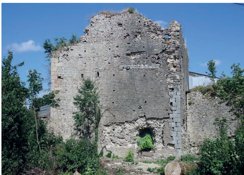
Fig. 20 – Élévation extérieure est, UM 6 (cliché Cédric Moulis).
