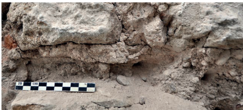
Fig. 38 – Superposition des deux mortiers, au départ du rehaussement du clocher (cliché Cédric Moulis).
