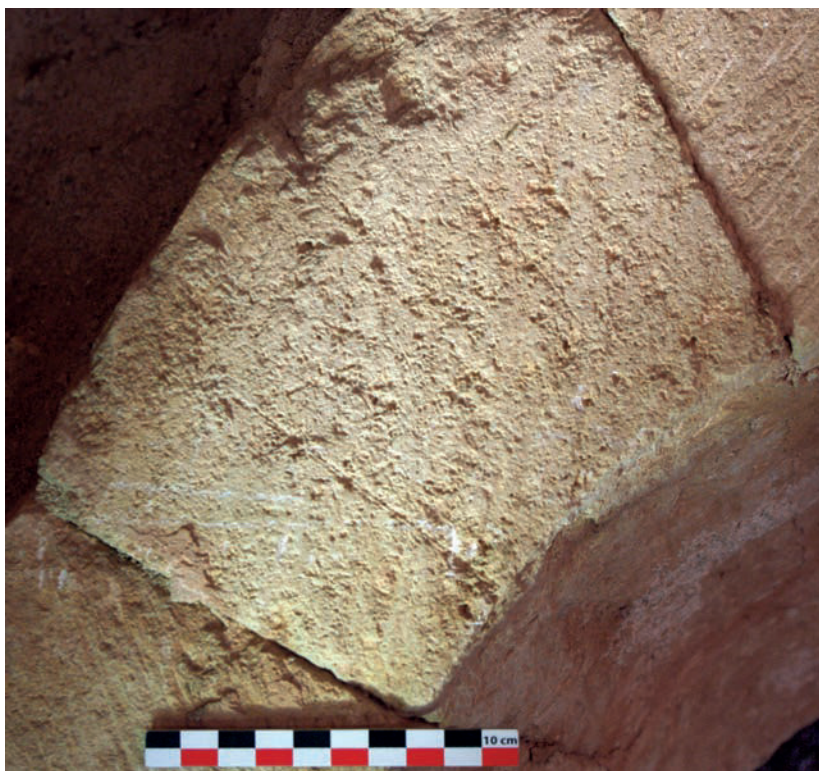
Fig. 22 – Détail du second voussoir de la fenêtre UC 1.2 (cliché Cédric Moulis).
