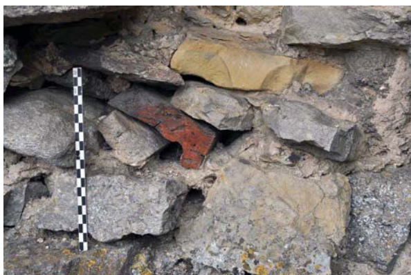
Fig. 61 – Tégula insérée dans le blocage en épi de l'élévation extérieure sud, UM 5 (cliché Cédric Moulis).
