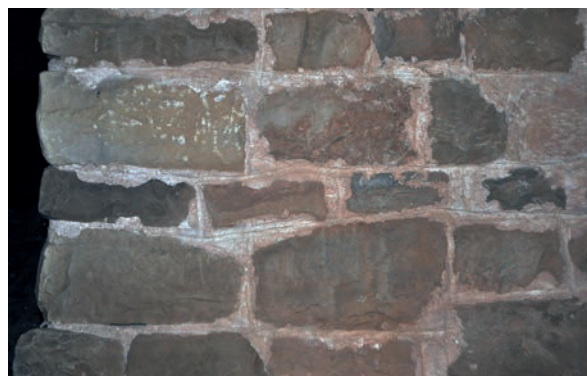
Fig. 44 – Joints de mortier beurré à pierre vue et tiré au fer sur le parement nord du clocher, sous les combles du bras nord du transept (cliché Cédric Moulis).
