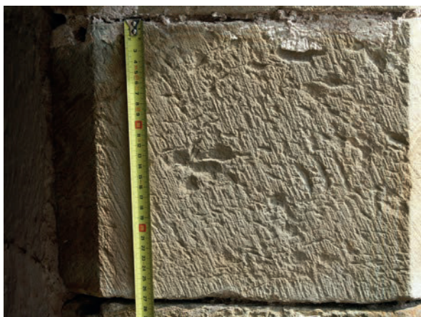
Fig. 83 – Traces de layage (cliché Cédric Moulis).
