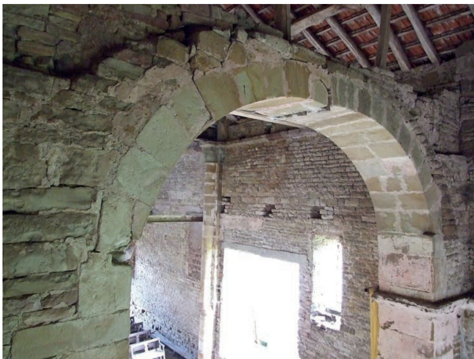
Fig. 71 – Empreinte d'un voûtement en cul-de-four au-dessus de l'arc triomphal, côté choeur (cliché Cédric Moulis).
