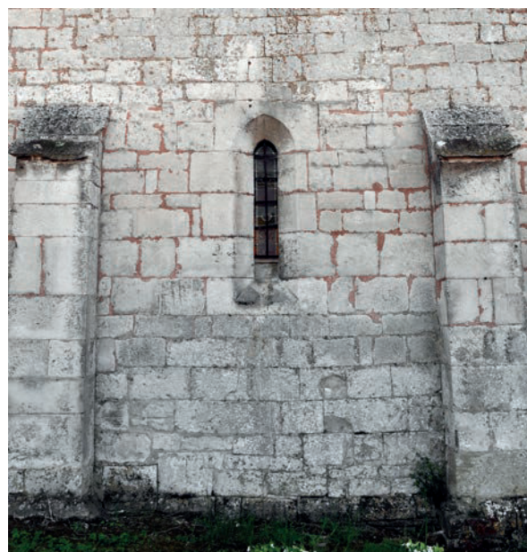
Fig. 31 – Fenêtre en arc brisé à linteau monolithe de la troisième travée nord de la nef (cliché Cédric Moulis).
