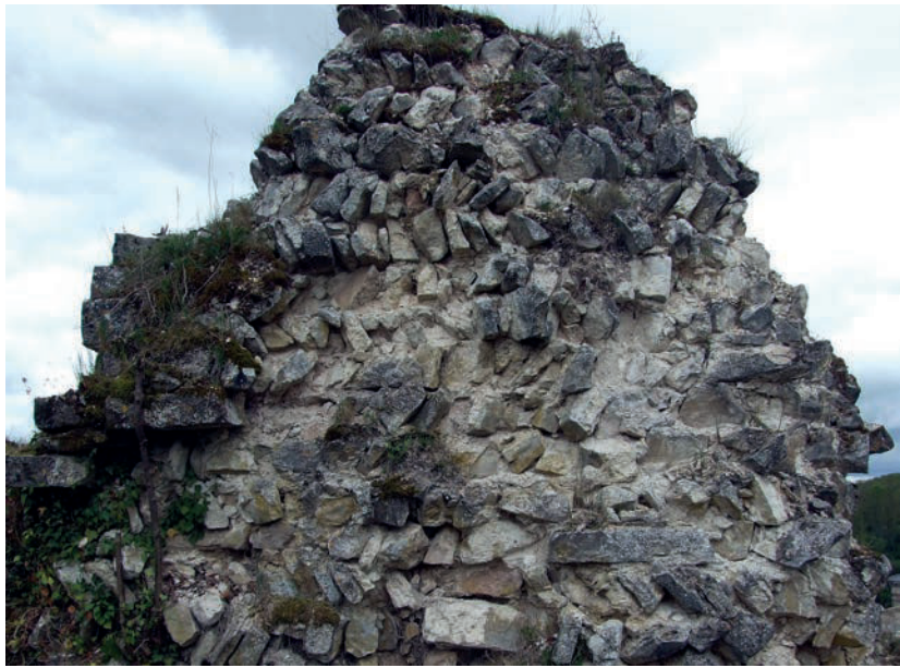
Fig. 21 – Blocage du mur nord-est, disposé en épi (cliché Cédric Moulis).
