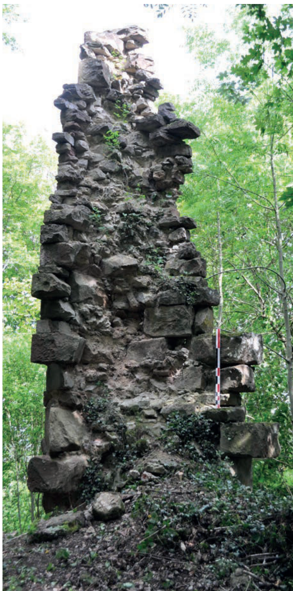
Fig. 18 – Blocage (UC 1.3) de la maçonnerie d'angle (cliché Cédric Moulis).
