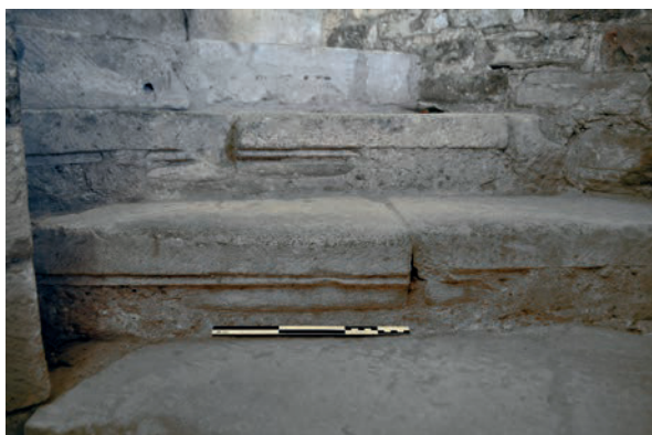
Fig. 53 – Pierres de corniche en remploi dans les premières marches de l'escalier (cliché Cédric Moulis).
