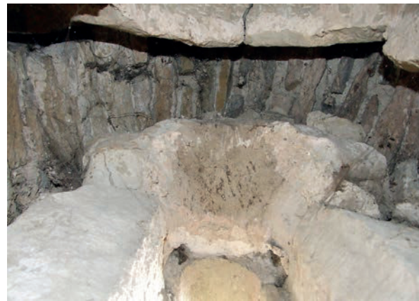
Fig. 17 – Fenêtre axiale de l'abside centrale de la crypte. On remarque entre les linteaux intérieurs et extérieurs le vouètement initial de la fenêtre (cliché Cédric Moulis).
