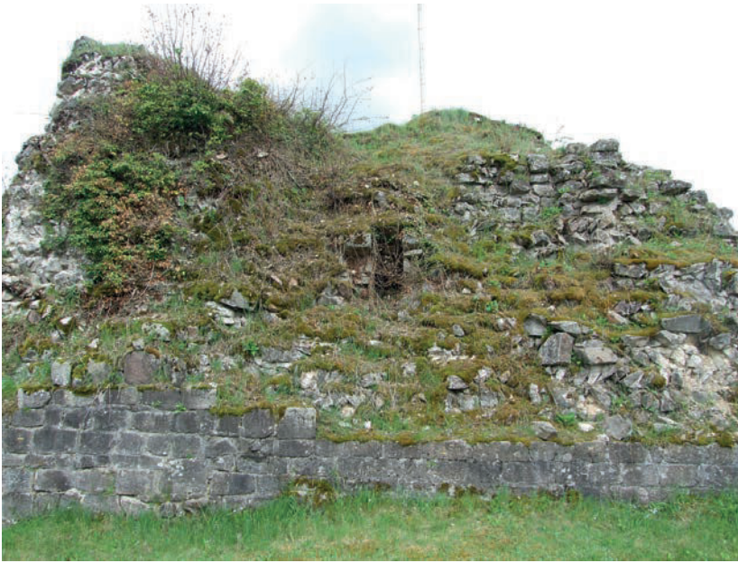
Fig. 12 – Élévation nord-ouest. Vue générale (cliché Cédric Moulis).
