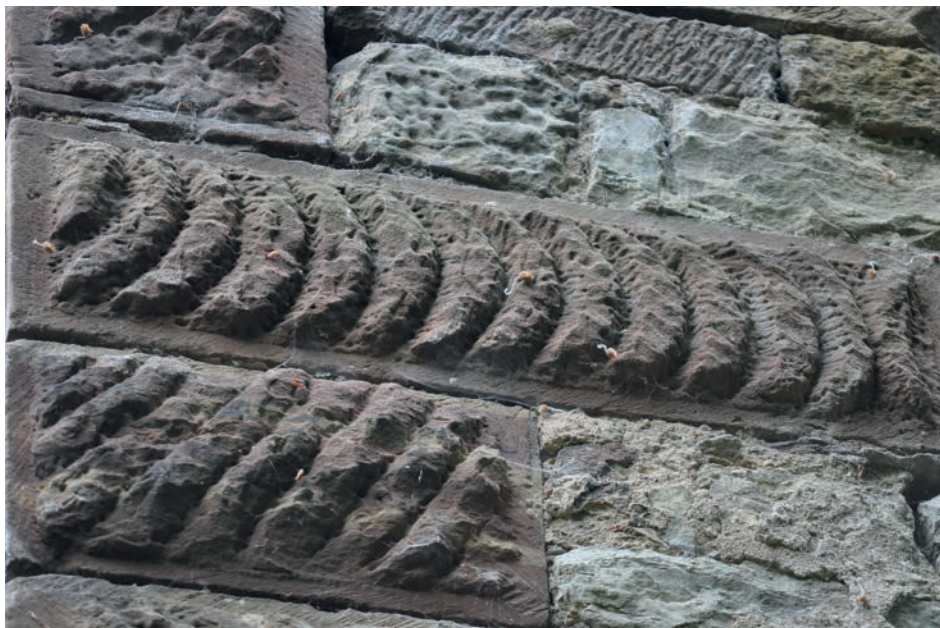
Fig. 14 – Boudins taillés en quart-de-rond sur le bossage de la maçonnerie d'angle, UC 1.2 (cliché Cédric Moulis).
