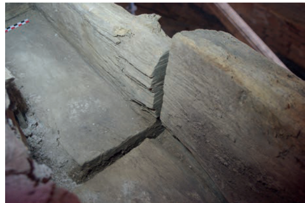
Fig. 50 – Les sablières sont simplement accolées (cliché Cédric Moulis).
