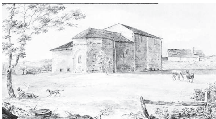
Fig. 25 – Gravure du XIX e siècle montrant le gouttereau nord et le chevet pentagonal de la chapelle. La petite porte est aujourd'hui remplacée par une large ouverture (dessin Charles Pensée).
