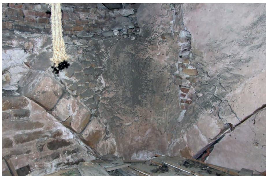
Fig. 112 – Potentiel vestige d'un tas de charge de la voûte de la première travée de la nef (cliché Cédric Moulis).
