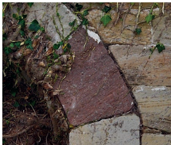
Fig. 27 – Grès rouge employé pour un voussoir de la porte du cimetière (cliché Cédric Moulis).
