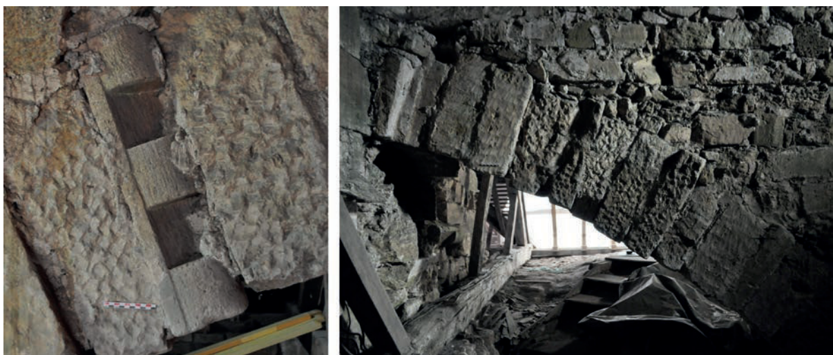
Fig. 12 – Remplois utilisés pour la confection de l'arc boutant appuyé contre la face sud (clichés Cédric Moulis).
