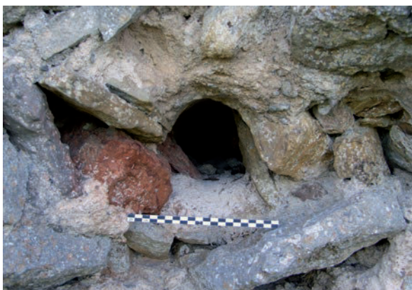
Fig. 35 – Trou de boulin circulaire (cliché Cédric Moulis).
