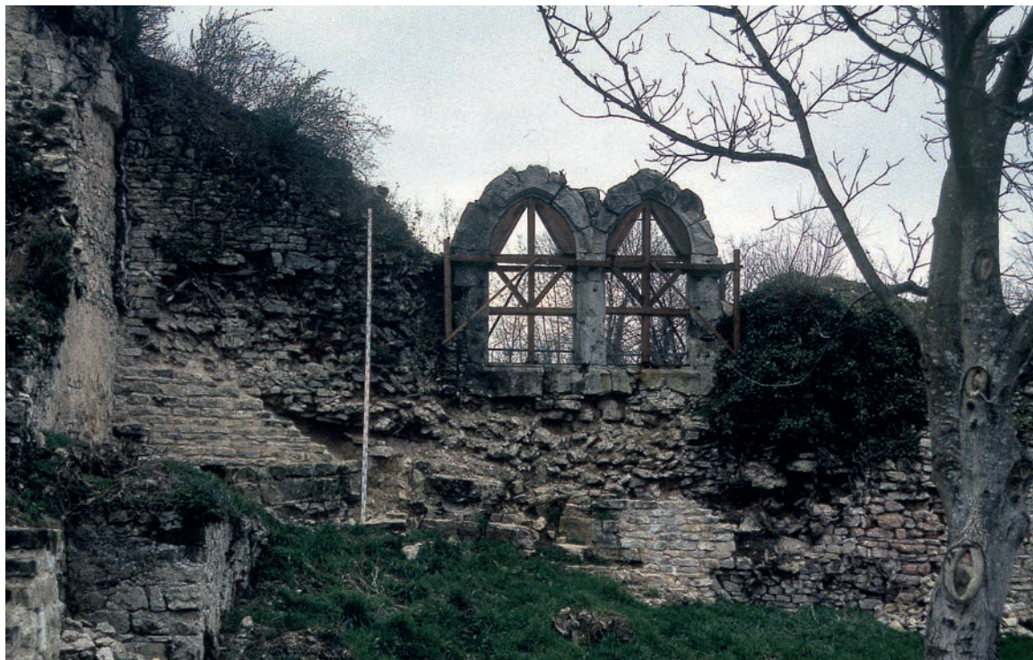
Fig. 35 – Blocage en épi sous les baies géminées de la « chapelle » (cliché Cédric Moulis).
