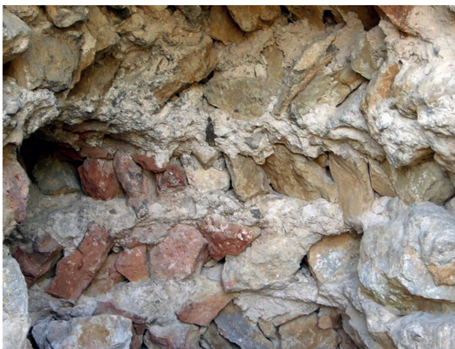
Fig. 31 – Apposition de deux mortiers à des moments séparés (cliché Cédric Moulis).
