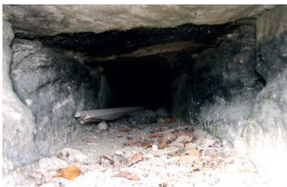
Fig. 10 – Conduit parementé visible depuis l'élévation sud-est (cliché Cédric Moulis).
