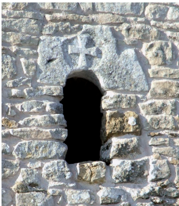
Fig. 6 – Fenêtre droite du premier niveau, avec le décor de croix pattée (cliché Cédric Moulis).
