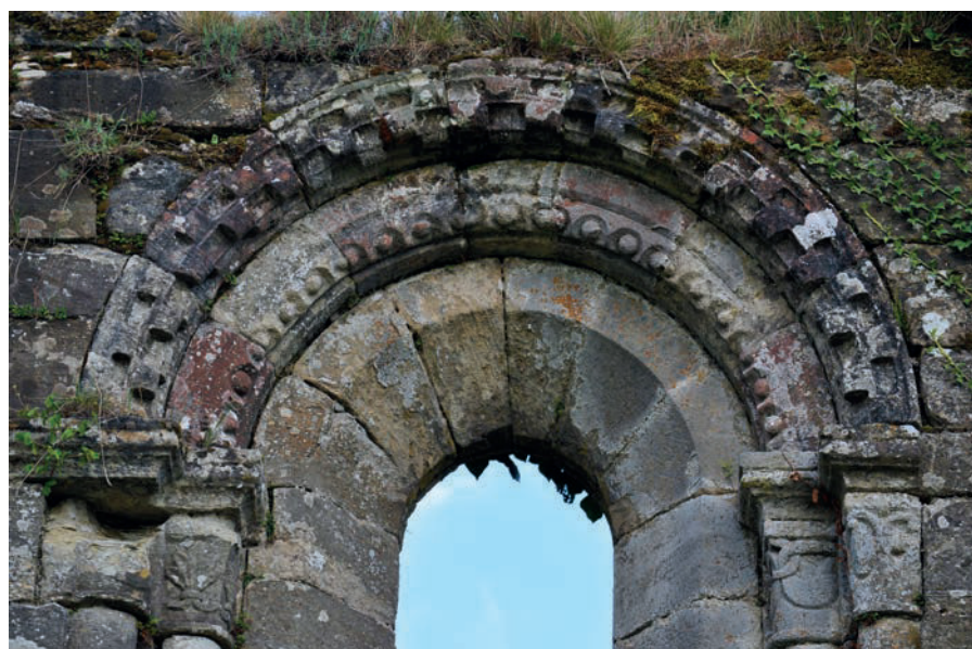
Fig. 39 – Arc en plein cintre d'une fenêtre de la façade. On distingue l'alternance de grès gris et rose qui compose les deux rouleaux sculptés (cliché Ellia Martin).
