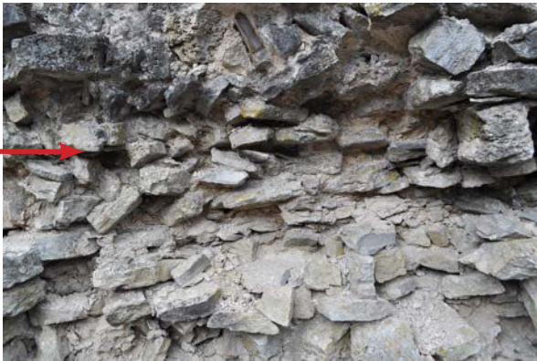
Fig. 58 – Niveau de réglage, UM 3 (cliché Cédric Moulis).
