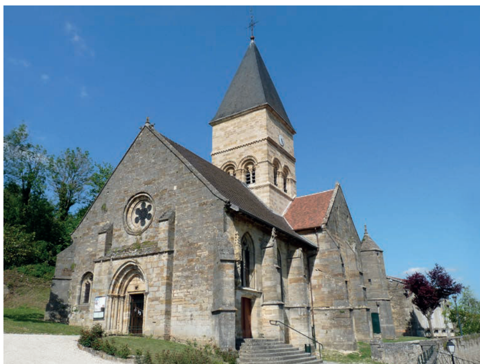
Fig. 2 – Vue générale de l'église actuelle (cliché Ji-Elle / Wikipédia Commons).
