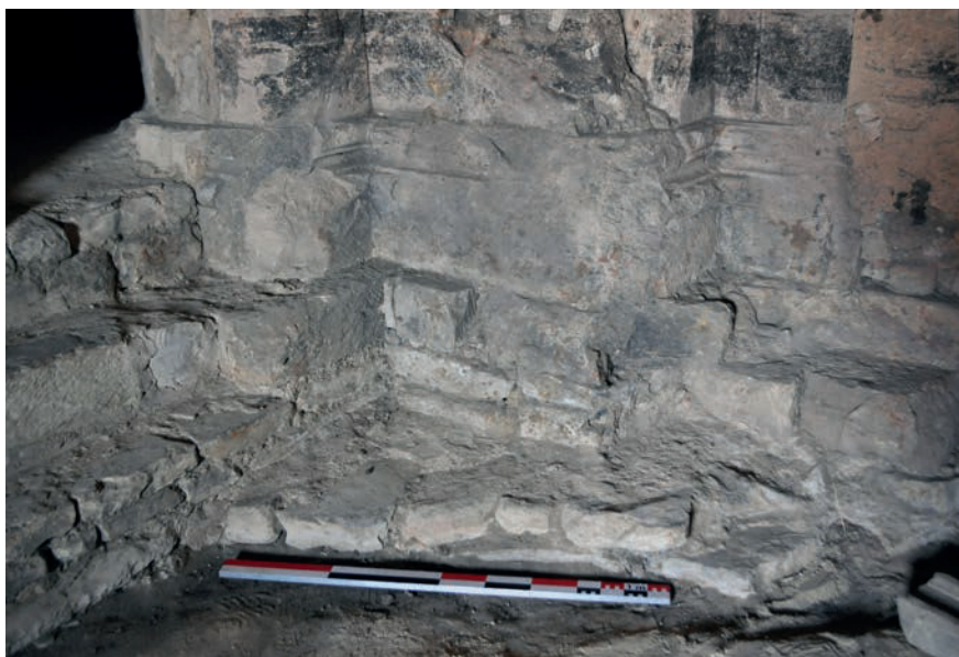
Fig. 48 – Fondations du pilier engagé dans l'angle nord-est de la tour-porche (cliché Cédric Moulis).
