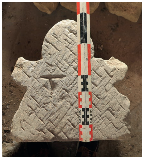
Fig. 40 – Marque de montage en forme de T sur un voussoir de la nef (cliché Cédric Moullis).
