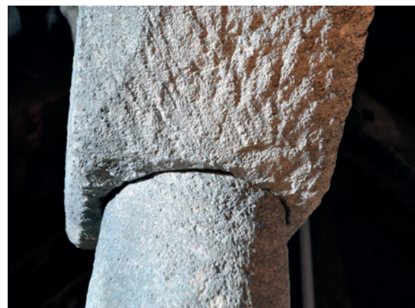
Fig. 22 – Baie nord, emboîtement de la colonnette dans le chapiteau (cliché Cédric Moulis).
