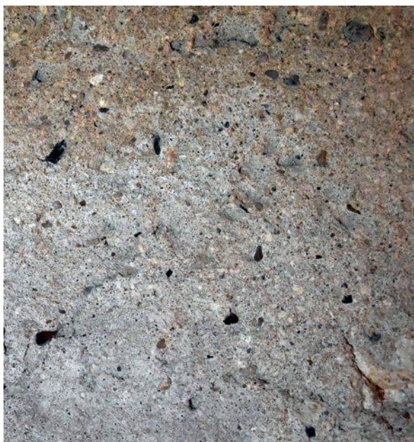
Fig. 79 – Enduit couvrant l'intrados de la voûte en plein cintre de la porte condamnée au rez-de-chaussée de la tour d'escalier (cliché Cédric Moulis).
