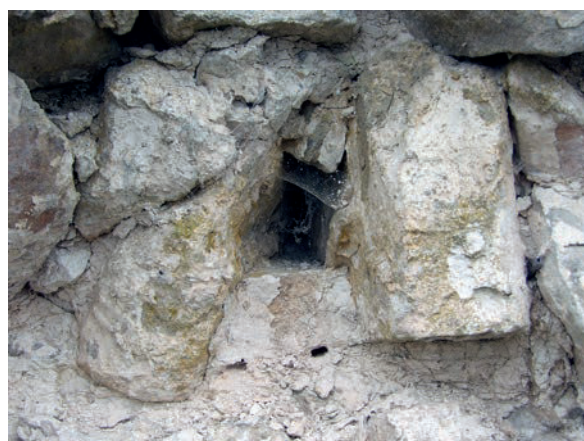
Fig. 25 – Élévation sud-est. Mortier liquide formant une surface plane au séchage (cliché Cédric Moulis).
