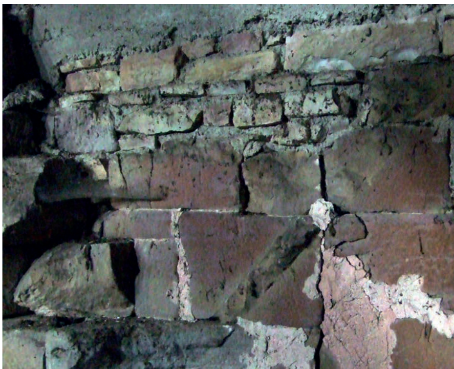
Fig. 17 – Vestige de solin visible sur le mur gouttereau sud (cliché Cédric Moulis).
