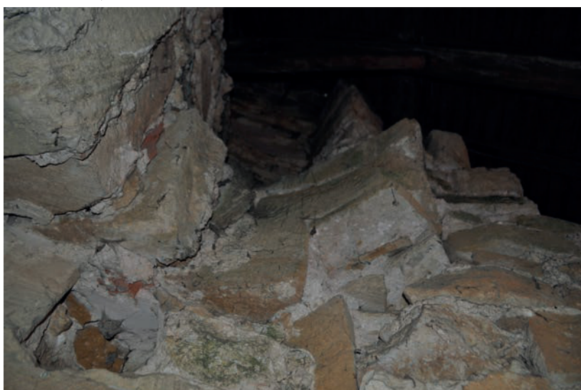
Fig. 4 – Vestige du parement intérieur curviligne de l'escalier primitif. On distingue au-dessus l'accès bouché au troisième niveau (cliché Cédric Moulis).
