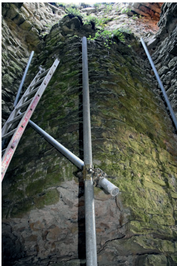
Fig. 25 – Tour nord. L'angle arrondi de la courtine vient occuper le quart de la superficie intérieure (cliché Eugénie Thouvenot).
