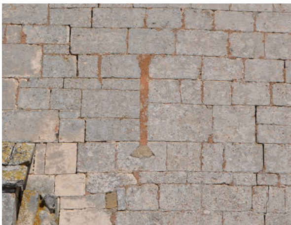
Fig. 7 – Archère à étrier rebouchée de la première travée de l'élévation sud de la nef (cliché Cédric Moulis).
