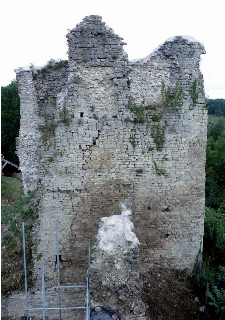
Fig. 5 – Face sud-est depuis la tour de l'escalier (cliché Vianney Muller).
