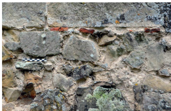
Fig. 34 – TCA employées pour niveler une pierre de parement à la jonction avec le niveau du cloître (cliché Cédric Moulis).
