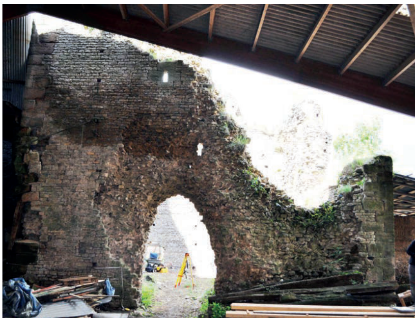
Fig. 18 – Élévation extérieure est, UM 8 (cliché Cédric Moulis).
