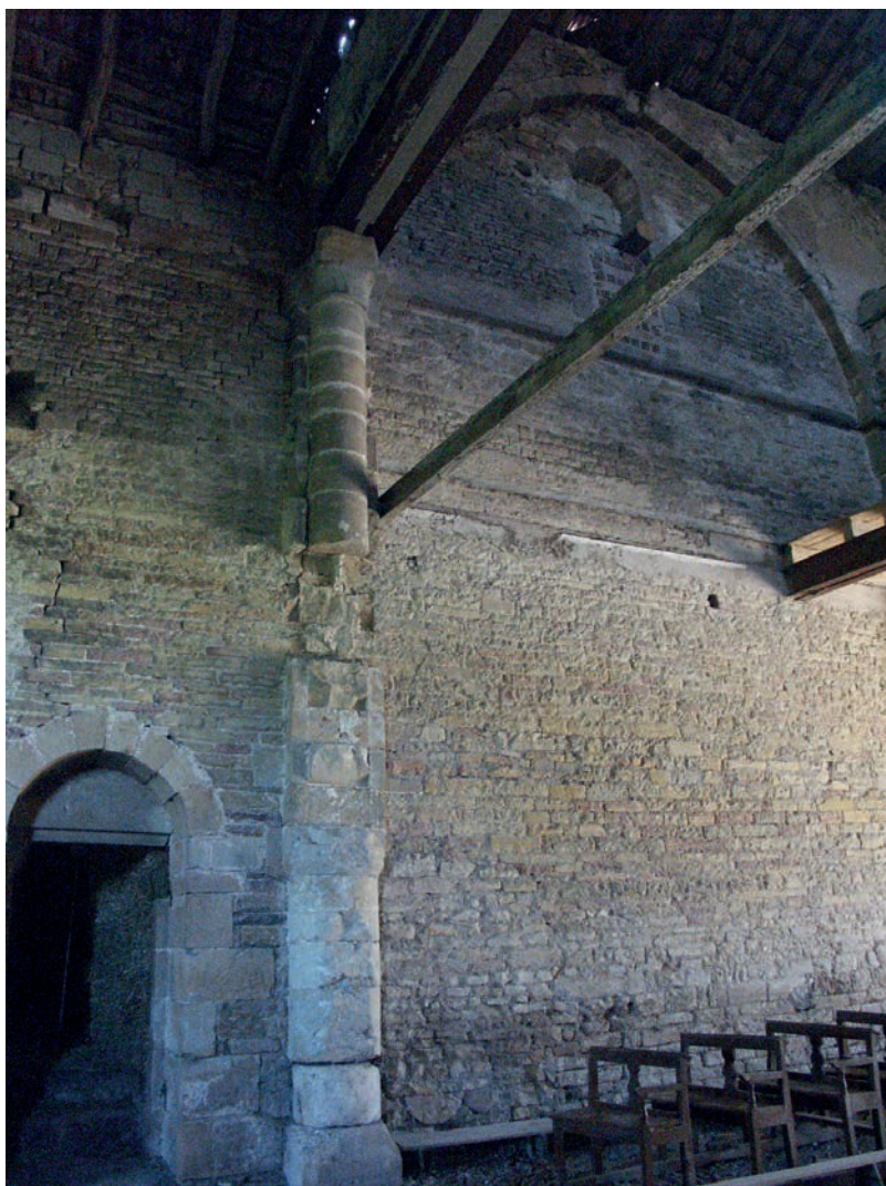
Fig. 28 – Pilier engagé séparant les travées 2 et 3 de l'élevation sud (UM 14) de la nef (cliché Cédric Moulis).
