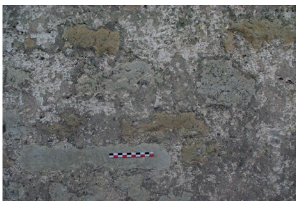
Fig. 43 – Joints de mortier beurré à pierre vue, sur le bas-côté nord (cliché Cédric Moulis).
