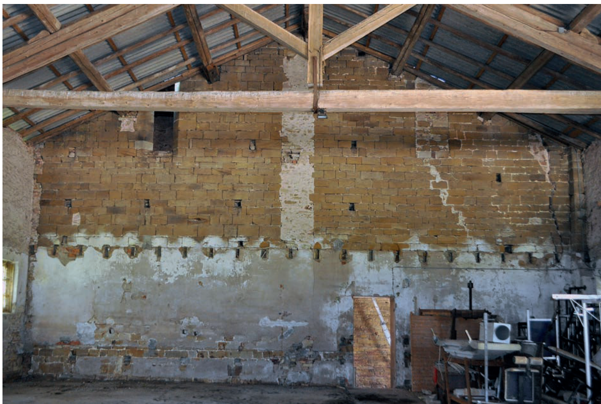
Fig. 21 – Mur gouttereau nord (UM 7), les deux premières travées (cliché Cédric Moulis).
