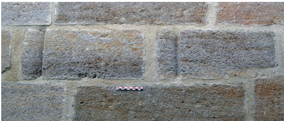
Fig. 11 – Remploi de pierres comportant des sections de colonnettes engagées en quart-de-rond dans le rehaussement du clocher (cliché Cédric Moulis).
