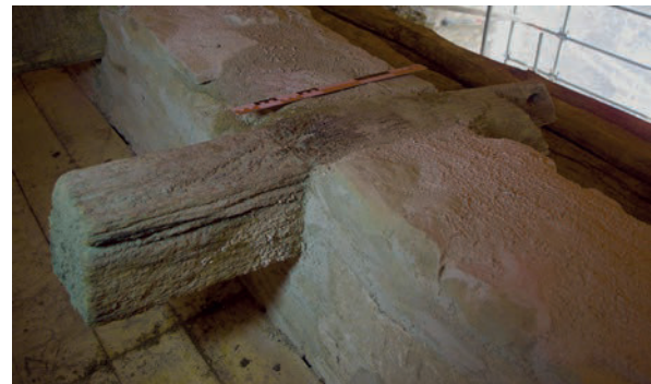
Fig. 58 – Entrait n°8, gouttereau sud, découpé lors de la pose de la charpente du XVIII e siècle (cliché Cédric Moulis).
