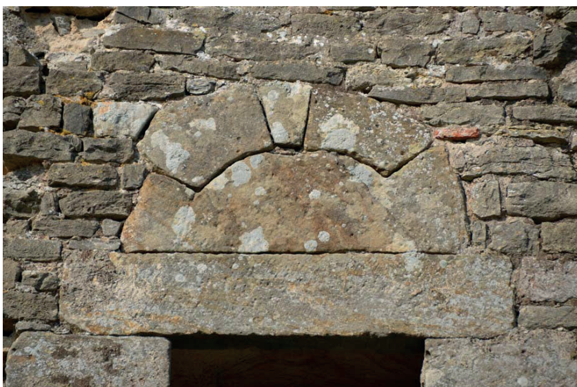
Fig. 33 – Détail du linteau de la porte de la tourelle semi-circulaire (cliché Cédric Moulis).
