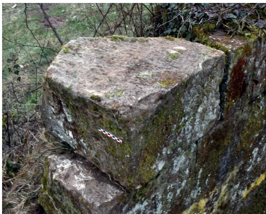
Fig. 29 – Emboîtures encore visibles sur une pierre du parement extérieur du mur nord (cliché Lionel Viana-Corréa).
