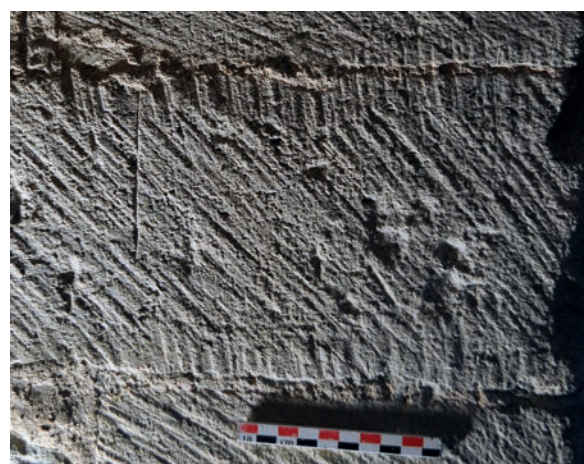
Fig. 45 – Ajustement des arêtes à la laie. Les impacts chevauchent les deux pierres, montrant ainsi leur réalisation après la pose. Rez-de-chaussée de la tour d'escalier (cliché Cédric Moulis).
