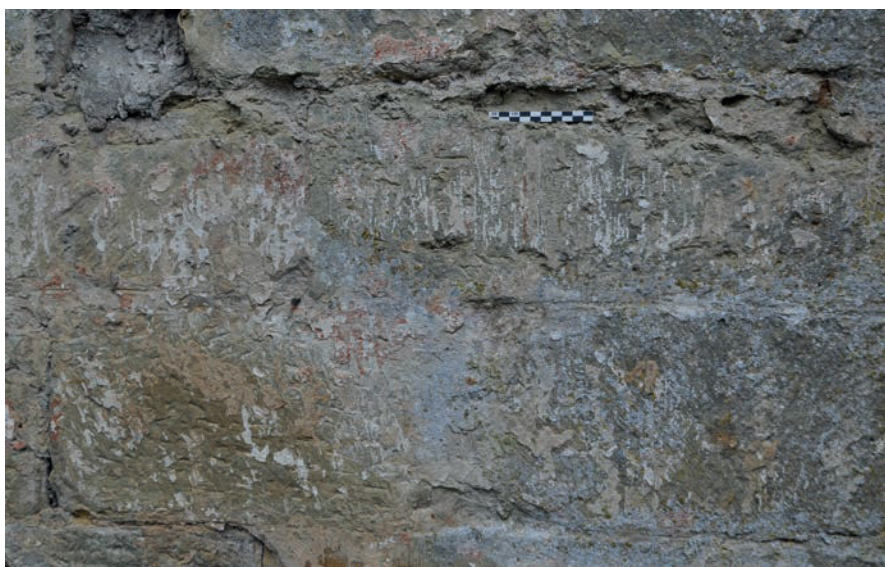
Fig. 41 – Décor de joints tirés au fer à l'intérieur du collatéral (cliché Cédric Moulis).
