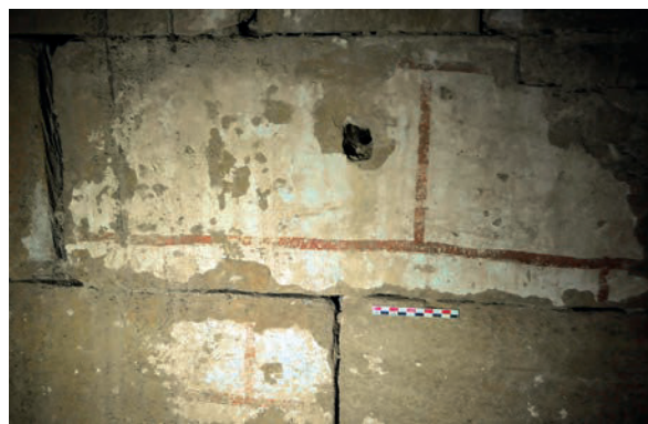
Fig. 15 – Enduit beige et décor de faux joints rouges sous le solin de la nef romane (cliché Cédric Moulis).
