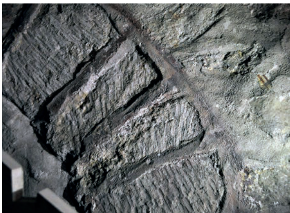
Fig. 25 – Arc de la porte primitive surélevée du clocher, traces de marteau taillant droit ou polka (cliché Cédric Moulis).
