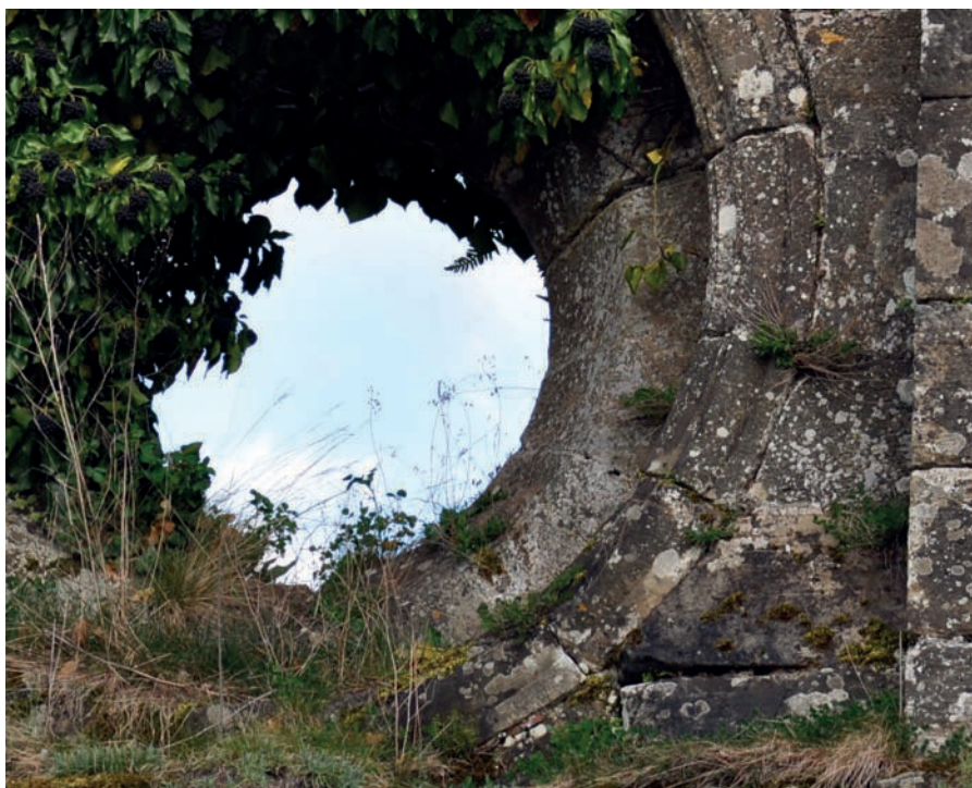
Fig. 40 – Oculus nord de la façade. On remarque deux TCA calant un voussoir du rouleau, en bas (cliché Ellia Martin).
