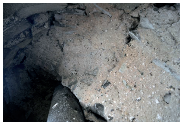
Fig. 64 – Enduit sous les marches de l'escalier en vis (cliché Cédric Moulis).
