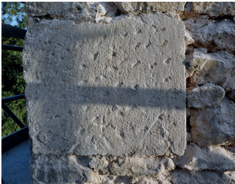
Fig. 23 – Traces de brettage sur une pierre calcaire blanche dans la chaîne d'angle du rehaussement du clocher. Les traces de broche témoignent de la pose d'un enduit sur la pierre (cliché Cédric Moulis).
