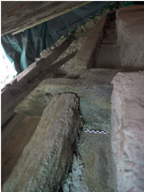
Fig. 55 – Entrait n°7 placé dans une encoche de la sablière nord (cliché Cédric Moulis).
