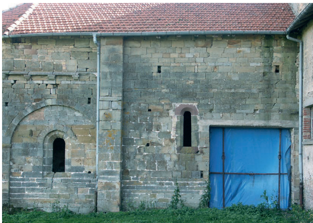
Fig. 22 – Troisième travée du mur gouttereau nord (UM 7) (cliché Cédric Moulis).
