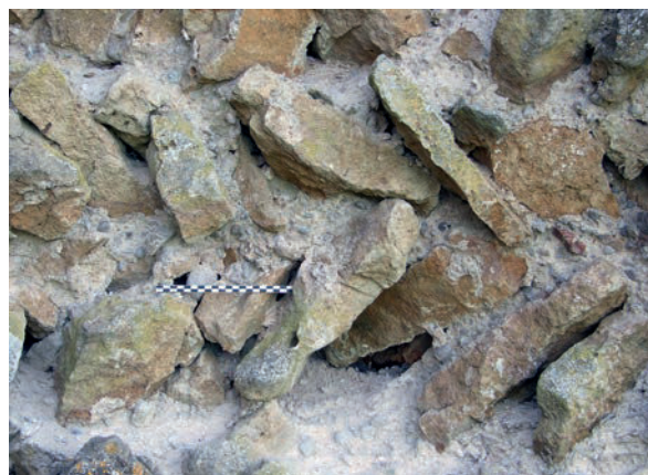
Fig. 26 – Détail du blocage en épi (cliché Cédric Moulis).
