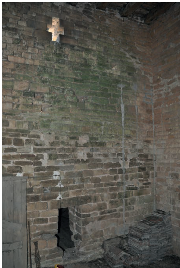
Fig. 35 – Élévation nord intérieure du premier étage. On devine la toiture en bâtière initiale, un trou de boulin, l'ouverture cruciforme et le passage, agrandi, vers les autres parties des combles (cliché Cédric Moulis).
