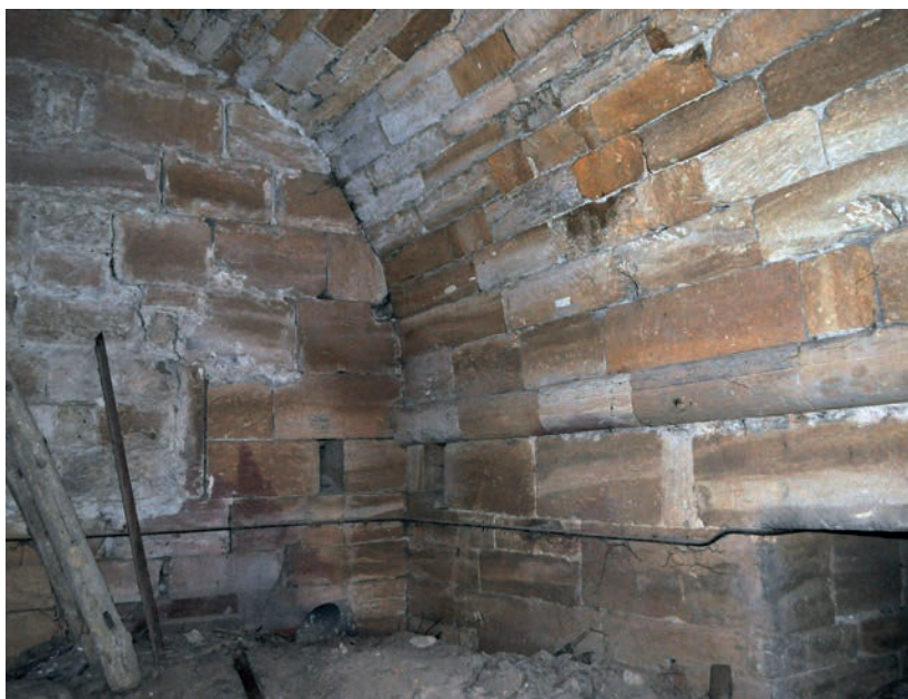
Fig. 17 – Trous de boulins du platelage inférieur placés en vis à vis, premier étage du clocher. On remarque également à droite le passage vers le transept nord et la corniche moulurée (cliché Cédric Moulis).
