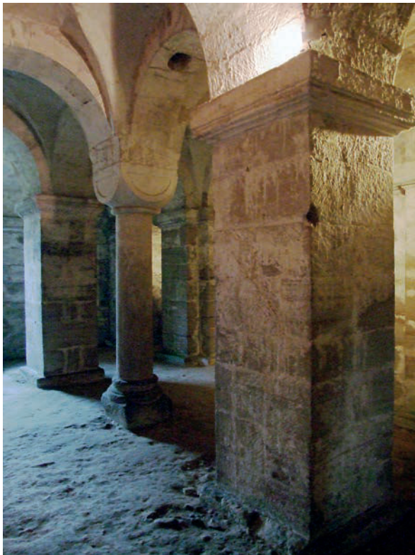
Fig. 4 – Intérieur de la crypte d'Esley. L'espace compris entre les deux piliers carrés correspond à la largeur du vaisseau central bipartite (cliché Cédric Moulis).
