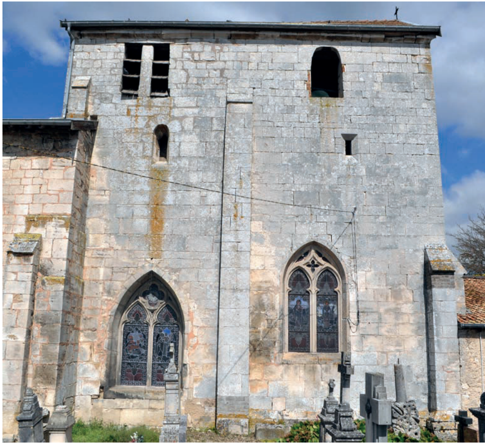
Fig. 11 – Élévation sud de la tour-chœur (cliché Cédric Moulis).
