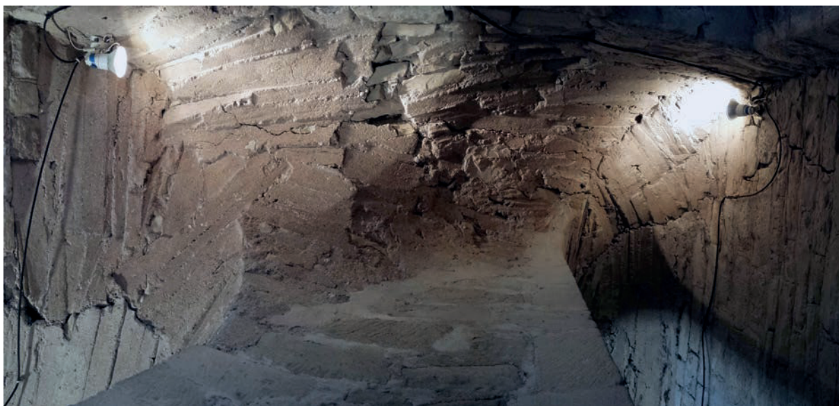
Fig. 60 – Vue panoramique de la section 2 de la voûte de l'escalier (cliché Cédric Moulis).
