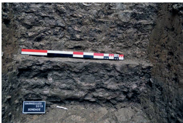
Fig. 41 – Ressaut de fondation, US 1014 (cliché Cédric Moulis).
