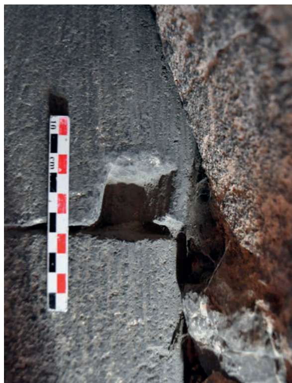
Fig. 65 – Encoche pratiquée sur le noyau central de l'escalier en vis pour maintenir un cintre destiné au montage des marches supérieures (cliché Cédric Moulis).
