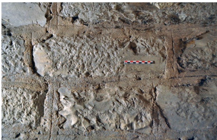
Fig. 78 – Joints tirés au fer sur le parement nord de la tour, dans la tour d'escalier (cliché Cédric Moulis).
