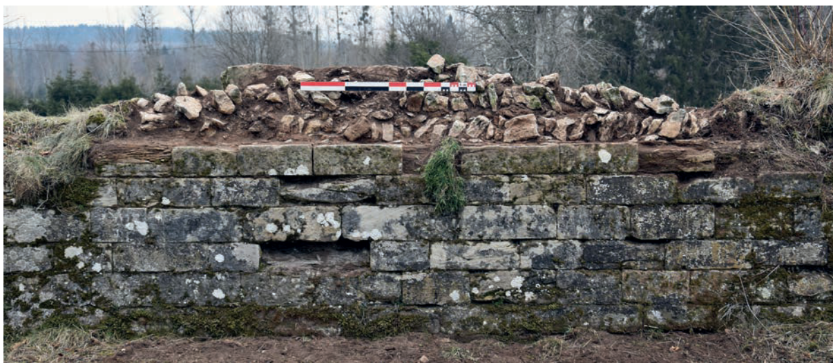
Fig. 38 – Blocage en épi observé sur le mur nord (cliché Cédric Moulis).
