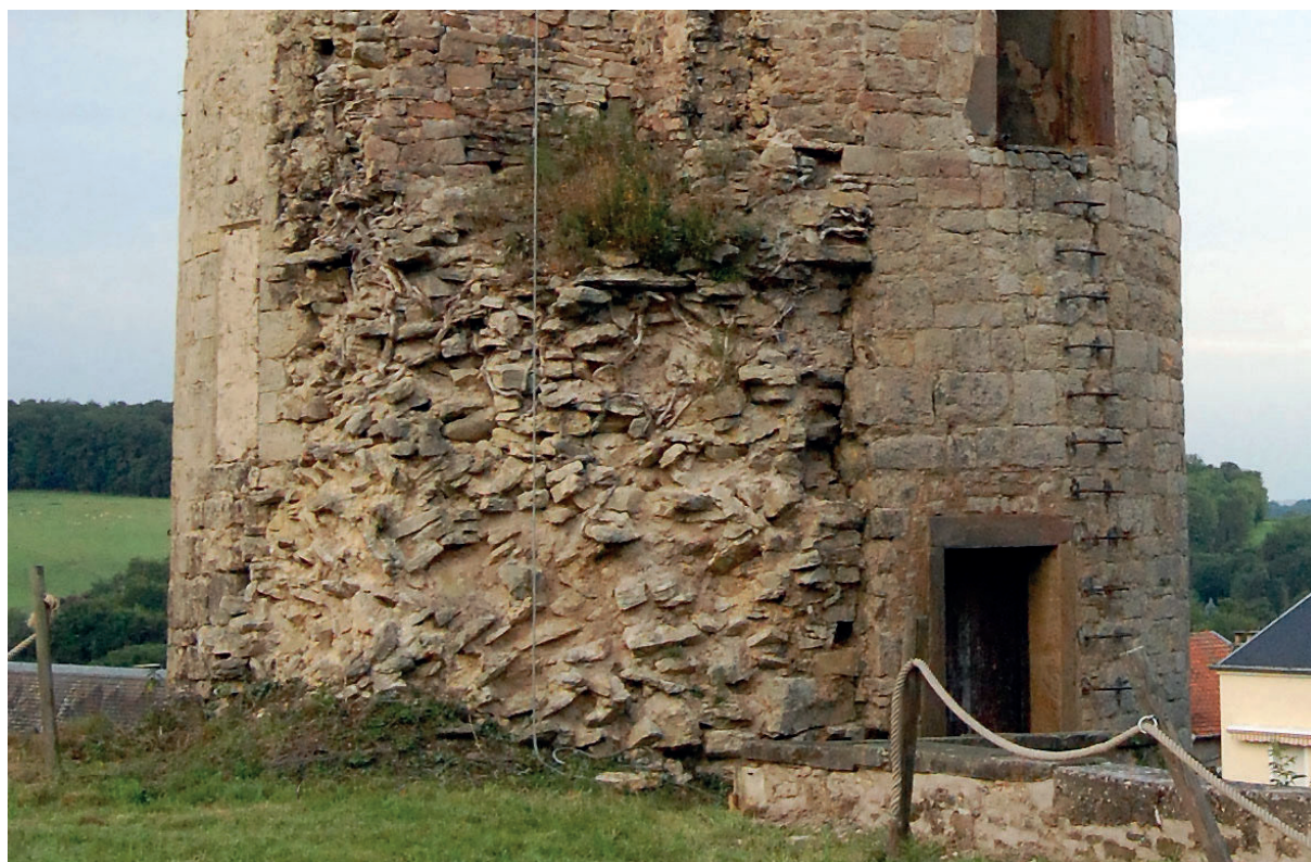
Fig. 28 – Tour sud-ouest, vestiges de l'enceinte primitive avec blocage en épi (cliché Cédric Moulis).
