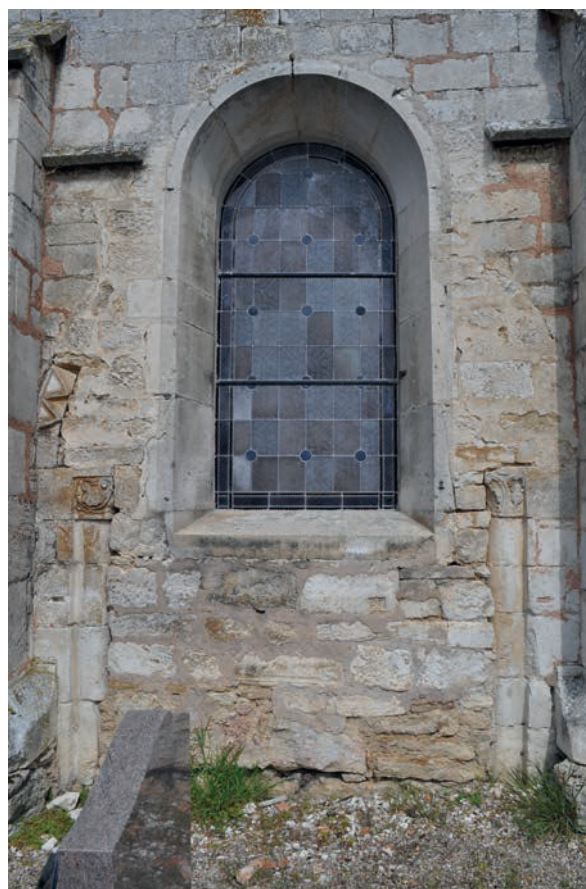
Fig. 8 – Vestiges du portail roman du mur gouttereau sud de la nef, remplacé par une fenêtre large (cliché Cédric Moulis).
