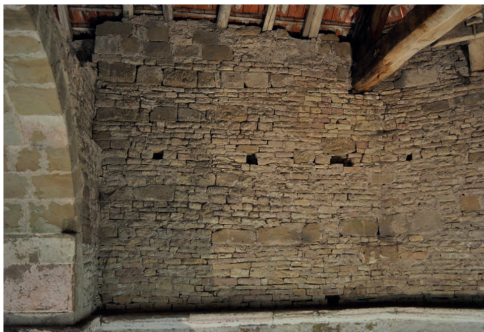
Fig. 65 – Surélévation de l'UM 9 du choeur (cliché Cédric Moulis).
