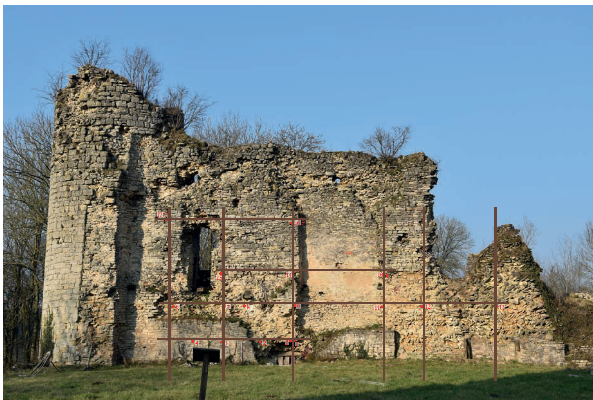
Fig. 31 – Courtine nord, emplacement des trous de boulin et échafaudage.
