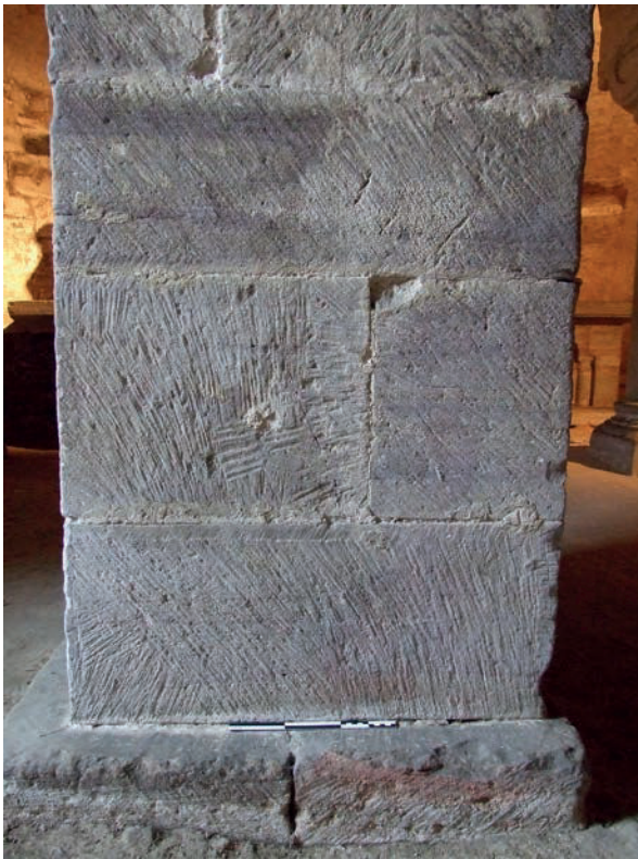
Fig. 12 – Traces de layage non organisé sur le pilier nord de la crypte d'Esley (cliché Cédric Moulis).
