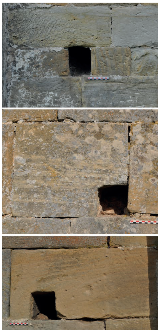
Fig. 43 – Typologie des trous de boulins observés à Haute-Seille : maçonné, façonné d'angle, façonné d'arête (clichés Ellia Martin).
