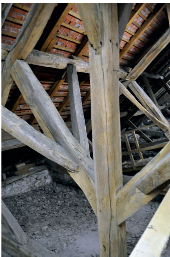
Fig. 37 – Charpente (XV siècle ?) de la nef actuelle (cliché Cédric Moulis).
