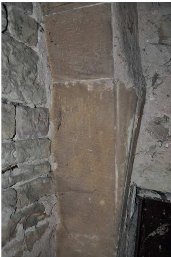
Fig. 31 – Base en sifflet de croisée dans la seconde travée, élévation nord (cliché Cédric Moulis).
