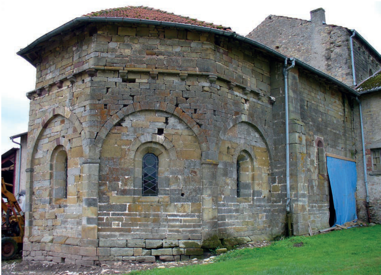
Fig. 54 – Vue générale du chevet de la chapelle, pans 3, 4 et 5 (cliché Ellia Martin).
