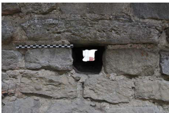
Fig. 67 – Trou de boulin maçonné traversant n°32d, UM 3 (cliché Cédric Moulis).
