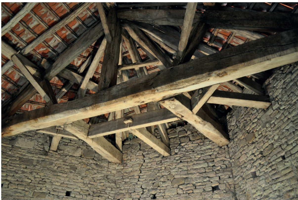
Fig. 67 – Charpente actuelle du chœur, datée par dendrochronologie de 1664 (cliché Cédric Moulis).
