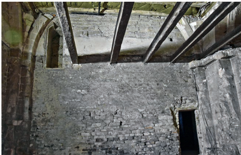
Fig. 24 – Intérieur de la tour-porche, rez-de-chaussée, élévation nord. On remarque les piliers engagés aux angles et le départ des voûtes, deux portes percées ultérieurement et les vestiges d'un plancher semblant fonctionner avec la porte haute (cliché Cédric Moulis).
