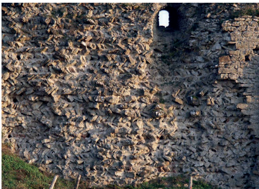
Fig. 25 – Blocage en épi dans le blocage du mur est, depuis l'intérieur du donjon (cliché Cédric Moulis).
