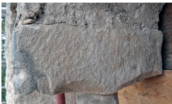
Fig. 17 – Chapiteau de la baie géminée sud (cliché Cédric Moulis).
