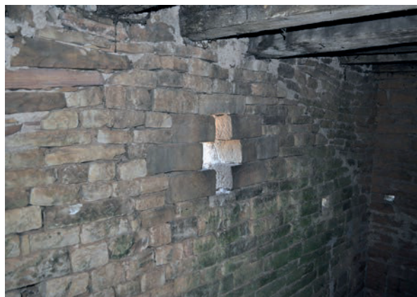
Fig. 34 – Ancienne toiture en bâtière du clocher fossilisée dans les maçonneries (cliché Cédric Moulis).
