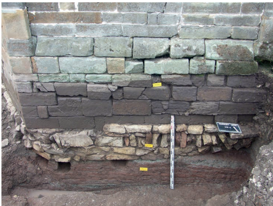
Fig. 92 – Fondations de l'UM 4 du chevet (cliché Cédric Moulis).
