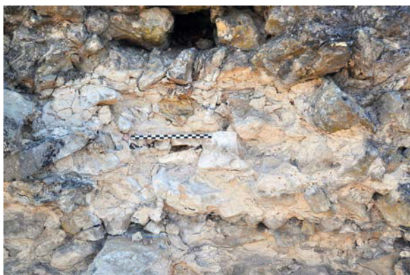
Fig. 64 – Mortier plus liquide utilisé dans le blocage, UM 1 (cliché Cédric Moulis).
