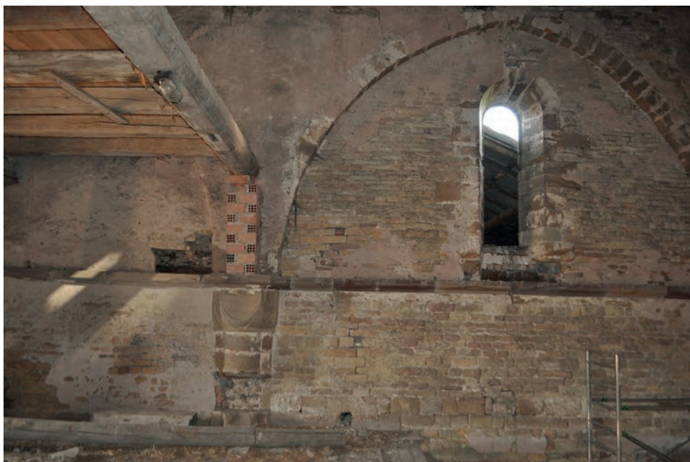
Fig. 103 – Vue de la poutre datée après 1157 (à droite) et sondage 1 montrant la poutre datée après 1138 (à gauche) (cliché Cédric Moulis).
