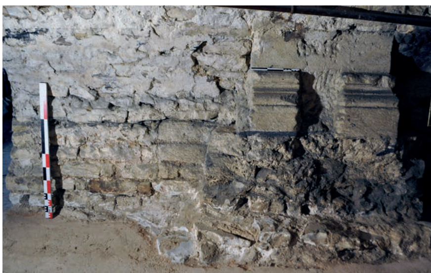
Fig. 49 – Fondations du pilier engagé de la première travée de la nef romane disparue (cliché Cédric Moulis).
