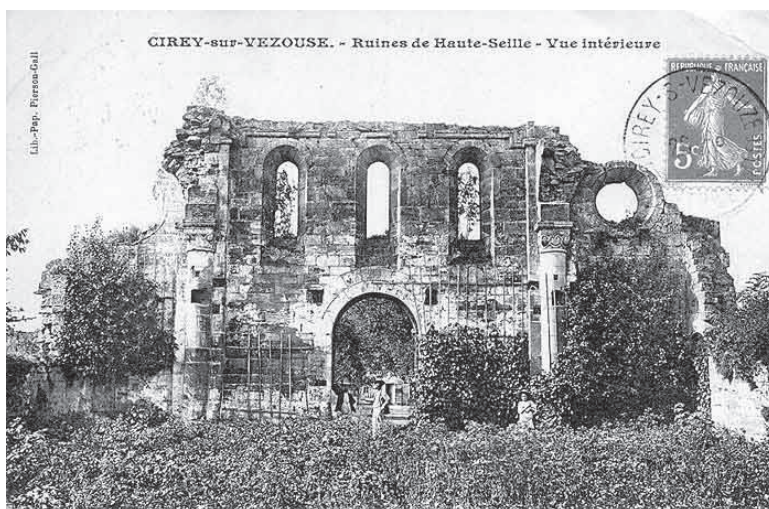
Fig. 12 – Carte postale de 1900 environ. On remarque une meilleure conservation du tas de charge de la voûte du collatéral sud (collection particulière).
