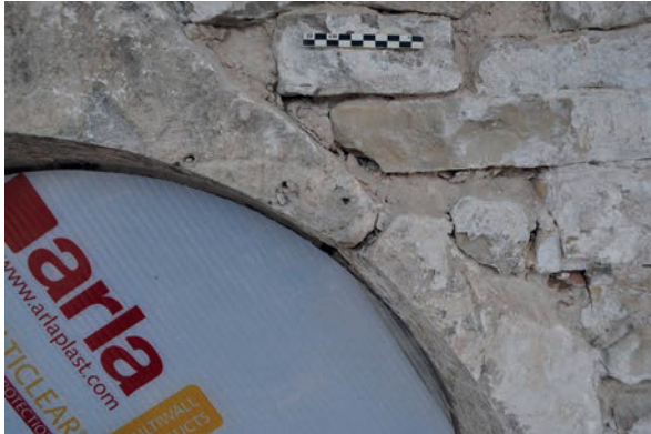
Fig. 17 – Détail de tracés préparatoires visibles sur les pierres formant l'oculus (cliché Cédric Moulis).
