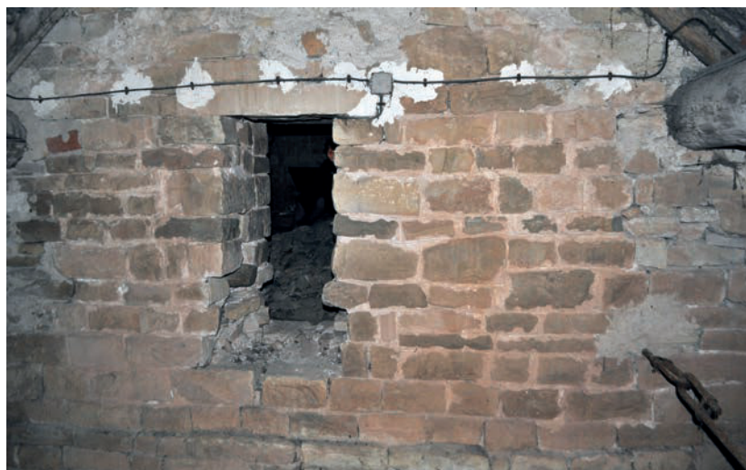
Fig. 36 – Passage entre le premier étage du clocher et les combles du bras nord du transept. On remarque l'élargissement de l'ouverture vers le bas et la poutre sectionnée (cliché Cédric Moulis).
