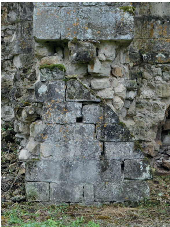
Fig. 17 – Parement sous le formeret d'une travée du cloître (cliché Cédric Moulis).
