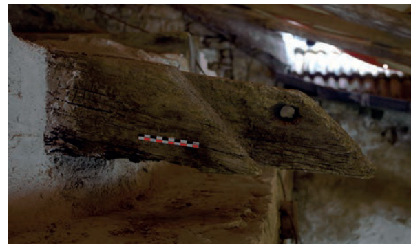
Fig. 59 – Détail de l'assemblage à mi-bois de l'entrait n°8, gouttereau sud (cliché Cédric Moulis).
