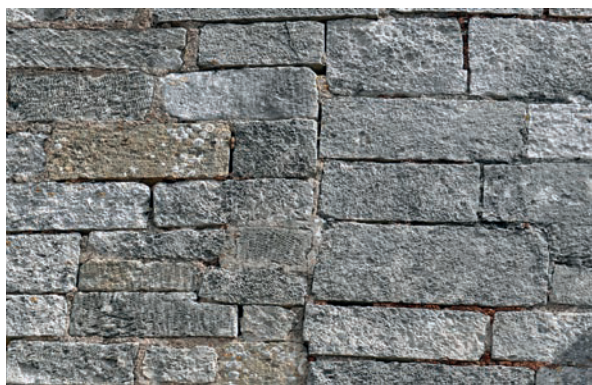
Fig. 22 – Façade occidentale de l'église, on aperçoit sur le rehaussement (à gauche du coup de sabre) des pierres de parement comportant des traces de gradine (cliché Cédric Moulis).
