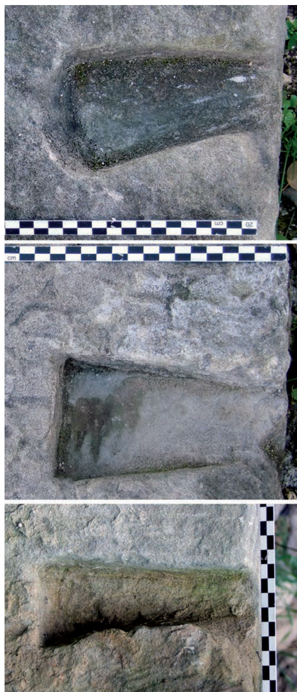
Fig. 20 – Encoches en queue d'aronde retrouvées sur les pierres du parement à l'angle nord (clichés Cédric Moulis).
