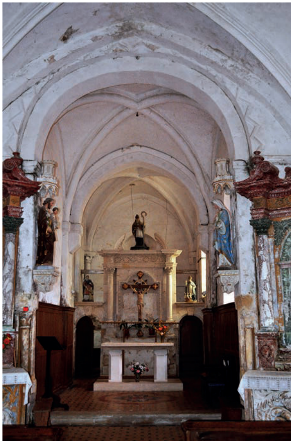
Fig. 5 – Arc triomphal à décor en zigzag, partiellement dissimulé par la voûte gothique de la nef (cliché Cédric Moulis).
