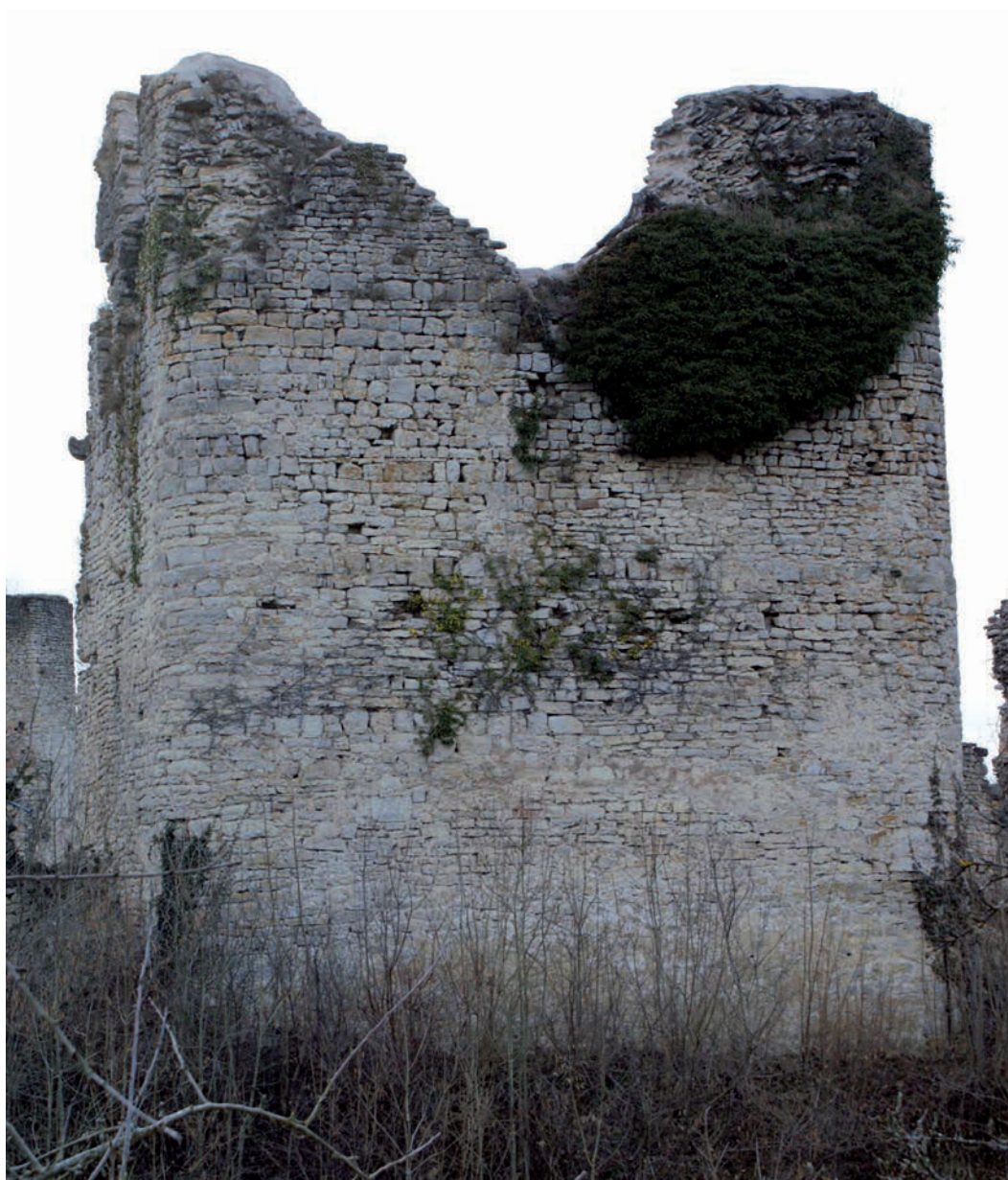
Fig. 8 – Face nord-est depuis l'autre côté du fossé (cliché Vianney Muller).
