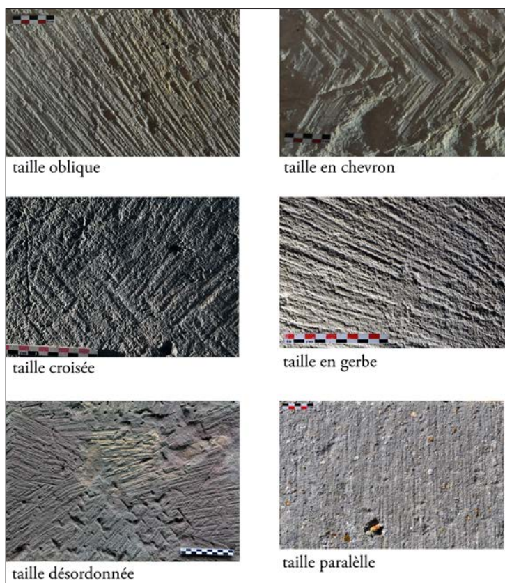
Fig. 19 – Les six types de taille de finition recensés à Champougny, Varangéville, Romont, Puxe-Laloeuf (clichés Cédric Moulis, Ellia Martin).
