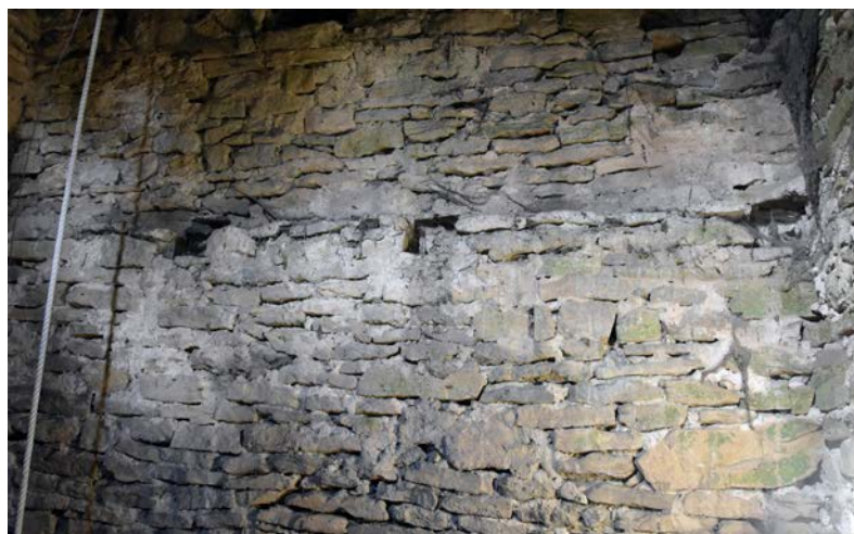
Fig. 57 – Empochements des poutres supportant le plancher d'un étage initial du clocher de Ville-sur-Illon, 88 (cliché Cédric Moulis).
