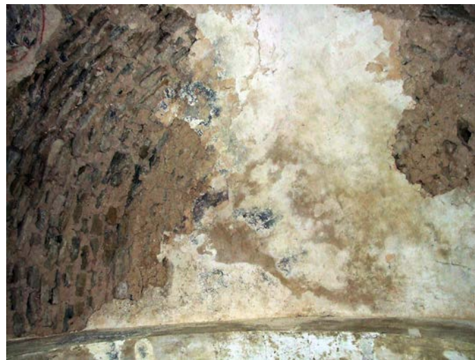
Fig. 47 – Voûte en cul-de-four composée de moellons effilés, abside de Gorhey, 88 (cliché Cédric Moulis).
