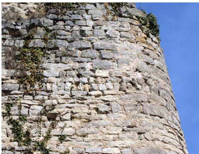
Fig. 17 – Résonance 1:1 avec des moellons, angles arrondis du donjon de Blâmont, 54 (cliché Cédric Moulis).
