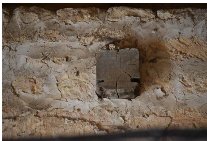
Fig. 14 – Encoches de part et d'autre de l'entrait, destinées à fixer le plafond lambrissé à la charpente, nef de l'église de Coussey, 88 (cliché Cédric Moulis).
