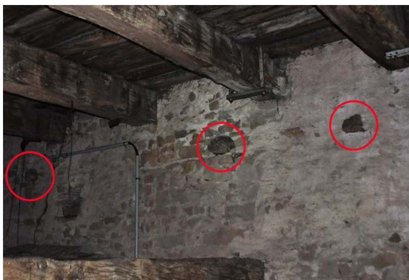
Fig. 29 – Vestiges de poutres supportant un niveau primitif du deuxième étage du clocher de Vaudeville, 54 (cliché Cédric Moulis).
