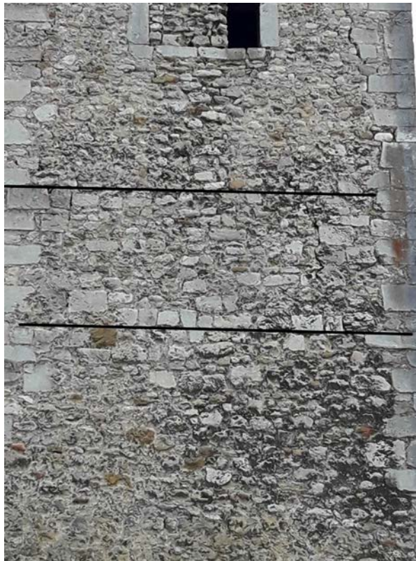
Fig. 39 – Assises de réglage dans le parement en moellons grossiers du clocher de Pagny-sur-Moselle, 54 (cliché Cédric Moulis).
