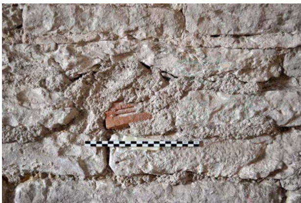
Fig. 23 – Trou de boulin bouché avec un fragment de brique creuse, chapelle de Xugney, 88 (cliché Cédric Moulis).
