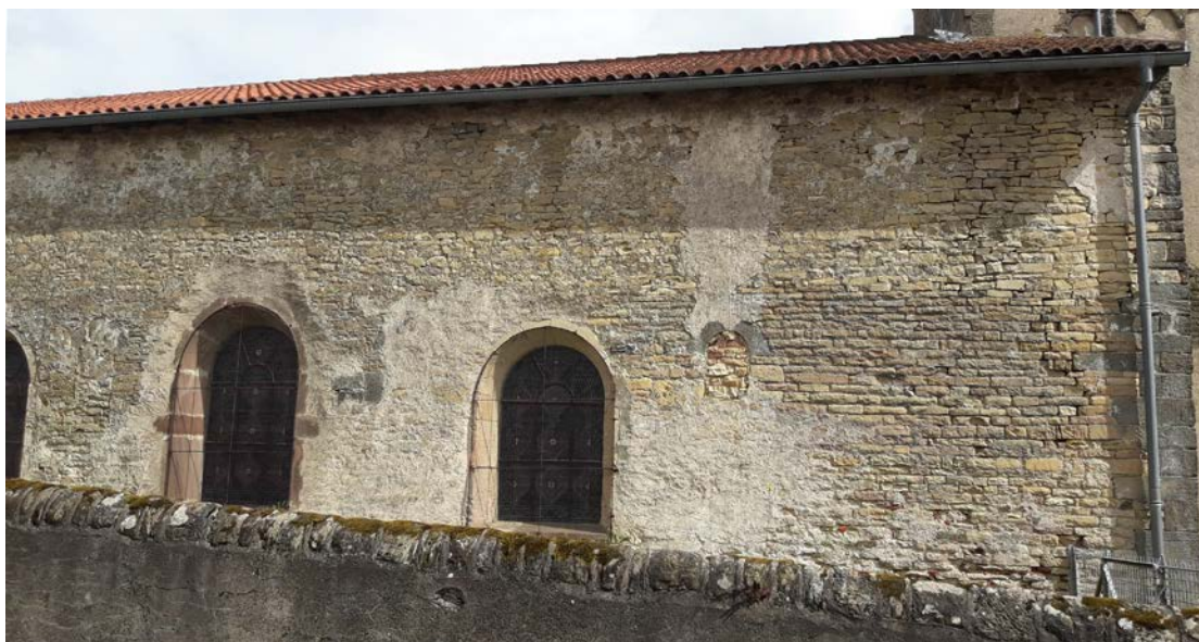
Fig. 13 – Appareillage de moellons équarris et dégrossis sur la nef de l'église de Bouzémont, 88. On remarque la présence de trois baies romanes bouchées (cliché Cédric Moulis).
