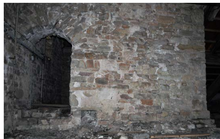
Fig. 24 – Porte à arc composé de moellons, clocher de l'église de Virecourt, 54 (cliché Cédric Moulis).
