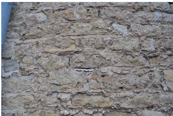
Fig. 14 – Joints beurrés de l'abside de l'église de Flin, 54 (cliché Cédric Moulis).
