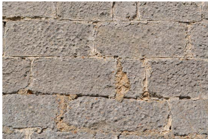
Fig. 17 – Décor de joints fins tirés au fer sur un parement de pierres de taille, église de Battigny, 54 (cliché Cédric Moulis).
