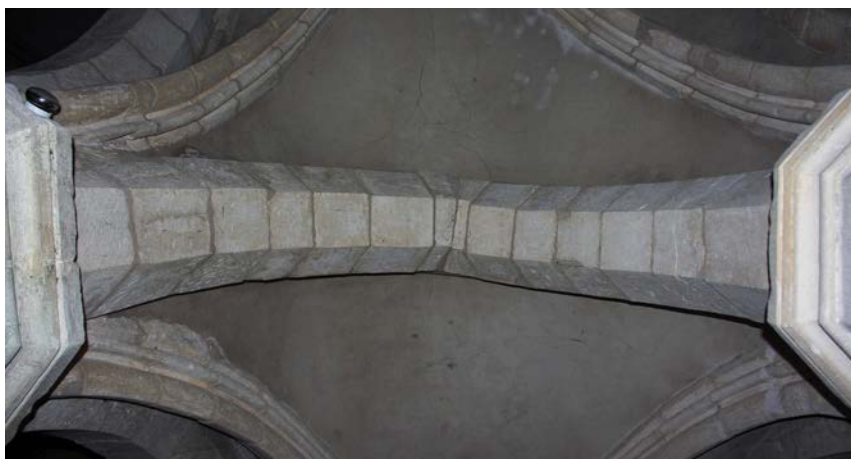
Fig. 53 – Arc brisé de section prismatique déformé lors de sa mise en tension, église d'Allamps, 54 (cliché Marion Subts).
