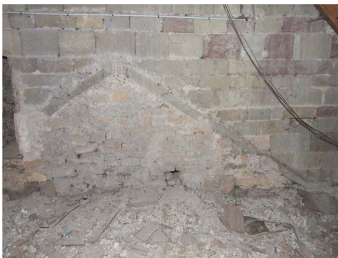
Fig. 18 – Solin de la nef initiale accolée au clocher de l'église paroissiale de Mirecourt (cliché Cédric Moulis).
