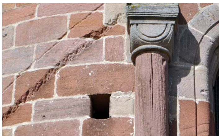
Fig. 3 – Trou de boulin maçonné dans un parement de pierre de taille, chevet demi-circulaire de Champ-le-Duc, 88 (cliché Cédric Moulis).
