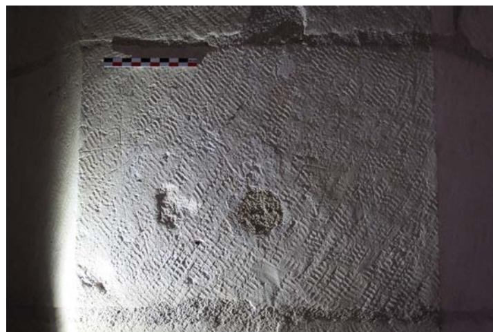
Fig. 26 – Traces de gradine sur un pilier de l'église d'Allamps, 54 (cliché Marion Subts).
