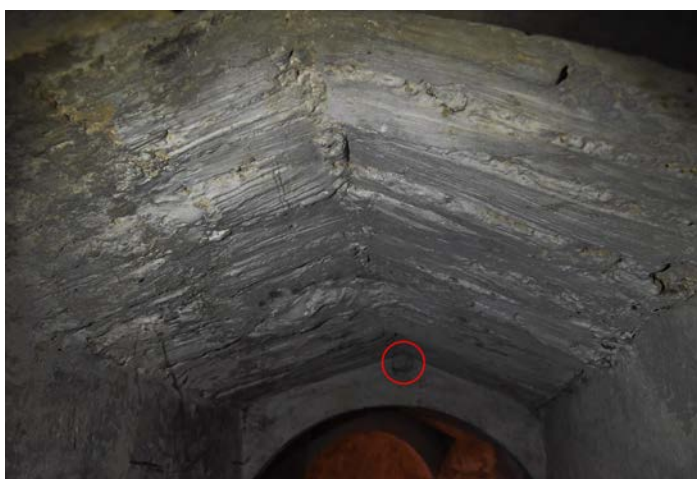
Fig. 40 – Voûte en bâtière du couloir d'accès à la crypte de Dieulouard (54). On remarque l'encoche dans l'arc permettant l'accroche d'une panne faîtière pour maintenir le cintre (cliché Cédric Moulis).
