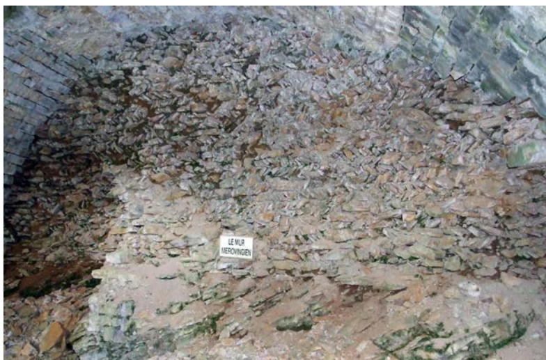
Fig. 55 – Structure en épi dans le château d'Arley (39), de même nature que celle à Vaudémont (cliché Cédric Moulis).
