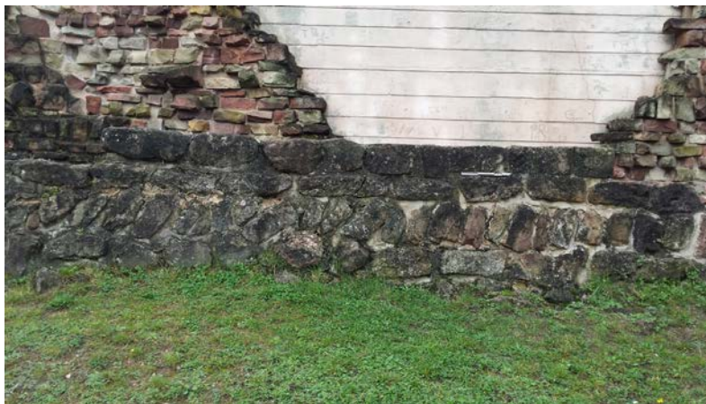
Fig. 49 – Assise en épi sur une structure précoce du château d'Épinal, 88 (cliché Cédric Moulis).
