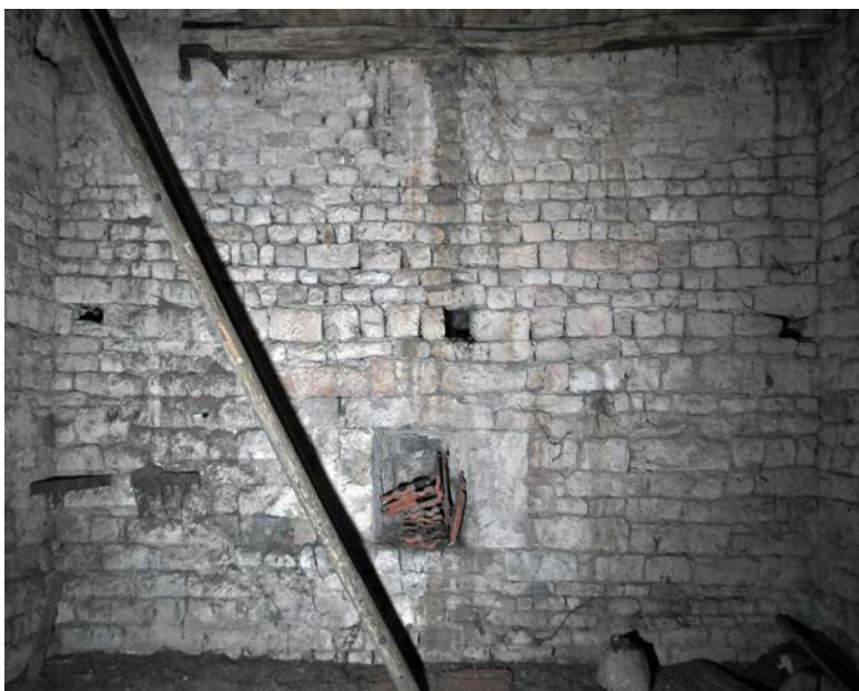
Fig. 35 – Paveint intérieur bien assisé, premier étage du clocher de Blénod-lès-Pont-à-Mousson, 54 (cliché Cédric Moulis).
