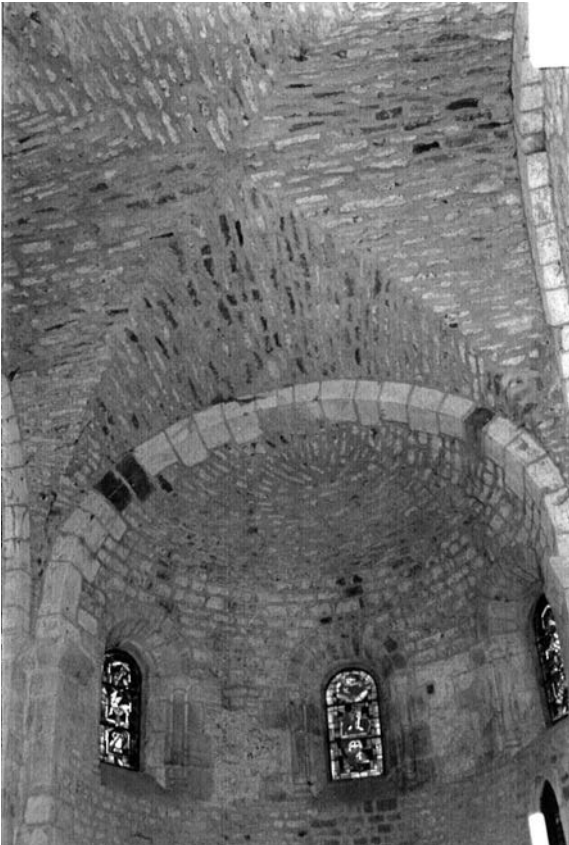
Fig. 7 – Voûte d'arêtes en moellons, travée de chœur de l'église de Champ-le-Duc, 88 (cliché Marie-France Jacops - SRI).
