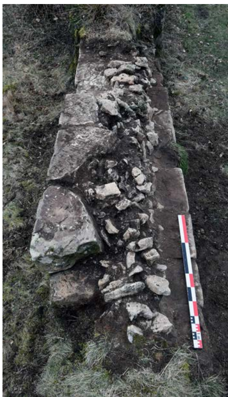
Fig. 30 – Les gouttereaux de l'abbatiale de Haute-Seille (54) sont composés en parement extérieur de pierres avec des queues et de pierres plus petites et sans queue en parement intérieur (cliché Cédric Moulis).
