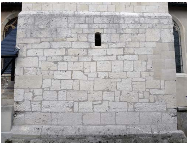
Fig. 12 – Parement à la base du clocher de Vandières, 54 (cliché Cédric Moulis).
