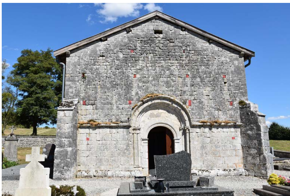
Fig. 18 – Échafaudage régulier aux boudins rebouchés, façade occidentale de l'église de Paroy-sur-Saulx, 52 (cliché Cédric Moulis).
