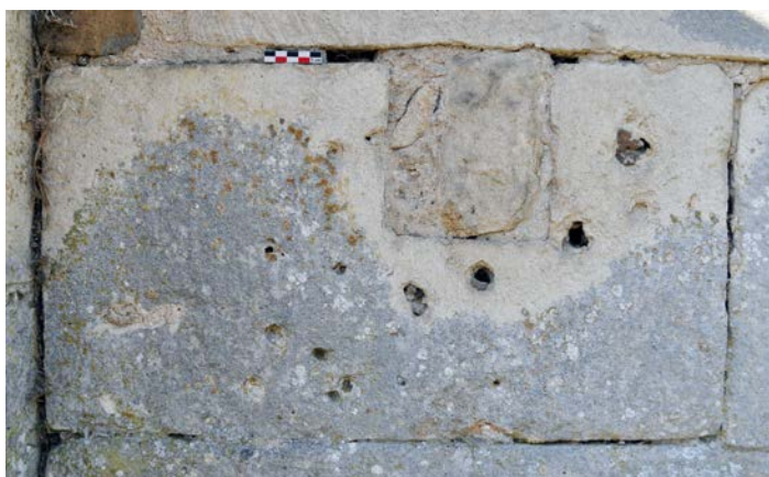
Fig. 7 – Trou de boulin façonné d'arête, chevet demi-circulaire de l'église de Puxe-Laloeuf, 54 (cliché Cédric Moulis).
