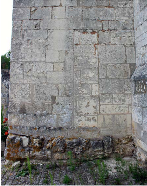
Fig. 16 – Deux assises de fondation dépassent du niveau de sol sur une partie de l'élévation sud de l'église d'Écrouves, 54 (cliché Marion Subts).
