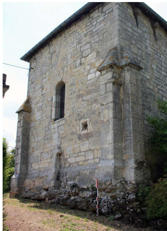
Fig. 18 – Amas de rochers faisant office de fondation pour le chevet de l'église de Barisey-la-Côte, 54 (cliché Marion Subts).
