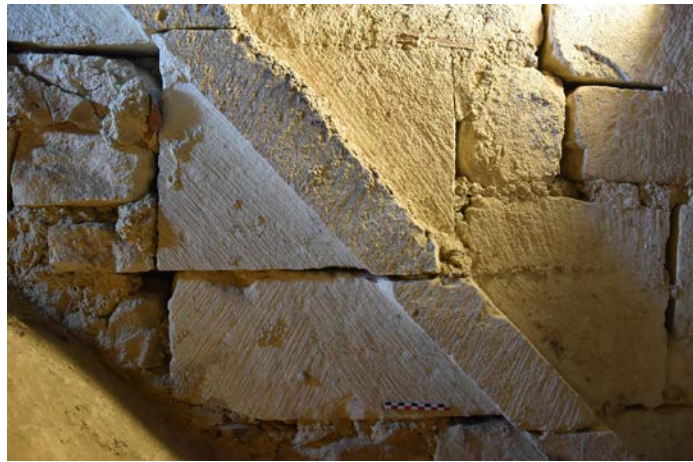
Fig. 15 – Détail d'un solin en pierre, église d'Allamps, 54 (cliché Cédric Moulis).
