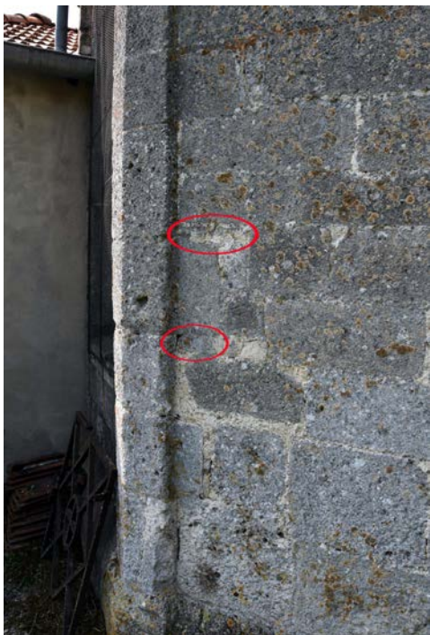
Fig. 25 – Chaînage harpé sur le chevet de l'église d'Ernecourt (55). Il a fallu insérer des cales pour récupérer les niveaux d'assises (cliché Cédric Moulis).
