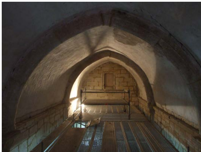
Fig. 1 – Voûte en berceau brisé, chœur de l'église d'Isches, 88 (cliché Cédric Moulis).
