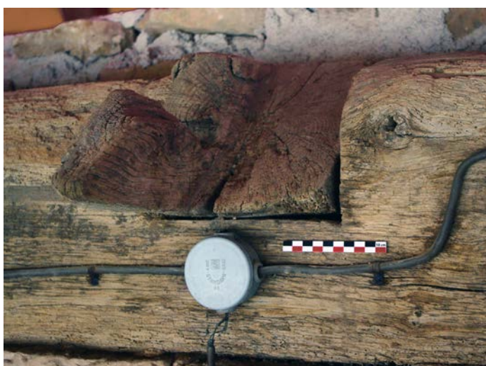
Fig. 1 – Entrant de la charpente romane de Vomécourt-sur-Madon, 88 (cliché Cédric Moulis).
