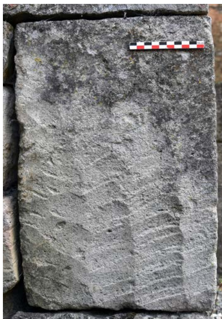
Fig. 27 – Traces de polka en ligne sur l'église de Montreuil-sur-Thonnance, 52 (cliché Cédric Moulis).
