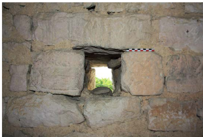
Fig. 2 – Trou de boulin traversant sur un parement de moellons, église de Sepvigny, 55 (cliché Marion Subts).
