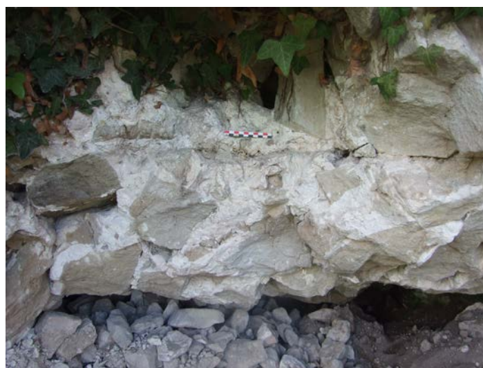
Fig. 7 – Niveau de réglage dans le blocage marqué par le contact de deux mortiers issus d'une pose décalée, donjon de Fontenoy-le-Château, 88 (cliché Cédric Moulis).
