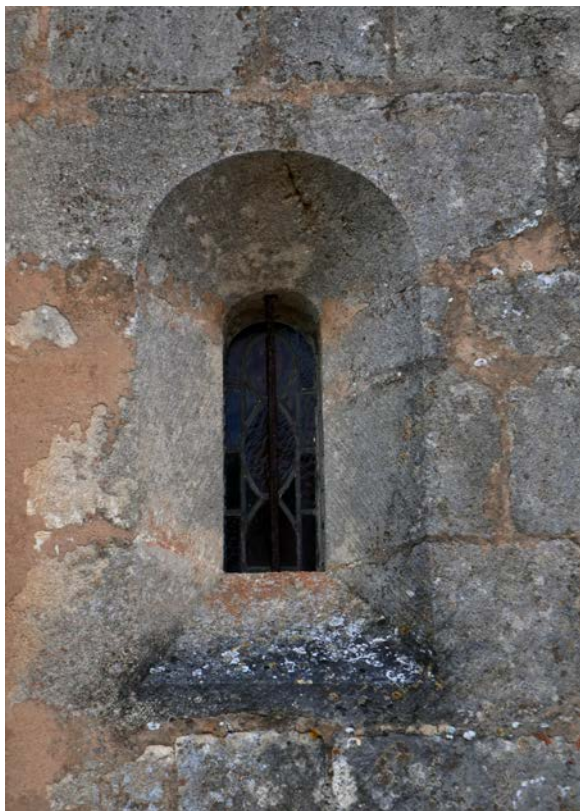
Fig. 21 – Fenêtre en plein cintre monolithe, église de Rollainville, 88 (cliché Cédric Moulis).
