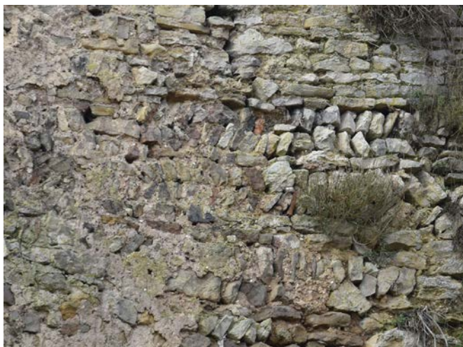
Fig. 51 – Épis sur le parement extérieur de la courtine est du château de Blâmont, 54 (cliché Cédric Moulis).
