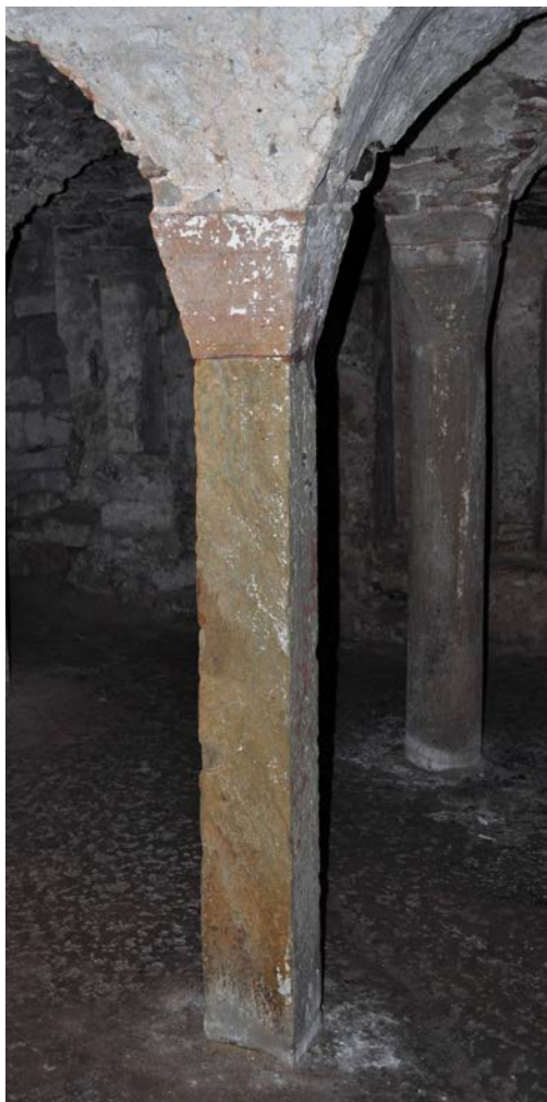
Fig. 34 – Pilier monolithe, crypte de Bleurville, 88 (cliché Cédric Moulis).
