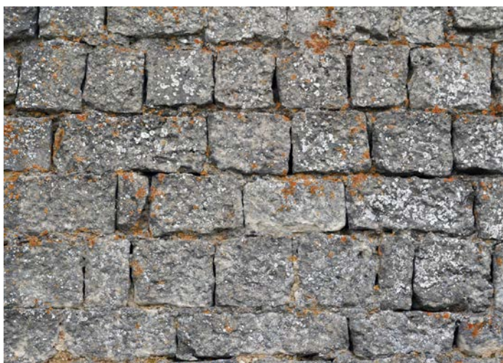
Fig. 15 – Appareillage de pierres de taille calcaires dégrossies au pic, sans taille de finition, sur le mur gouttereau nord de l'église de Battigny, 54 (cliché Cédric Moulis).
