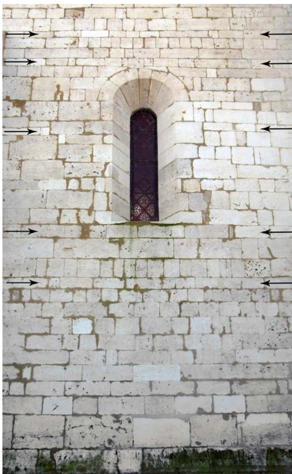
Fig. 37 – Assises de réglage plus fines que les autres assises, église de Vicherey, 88 (cliché Cédric Moulis).
