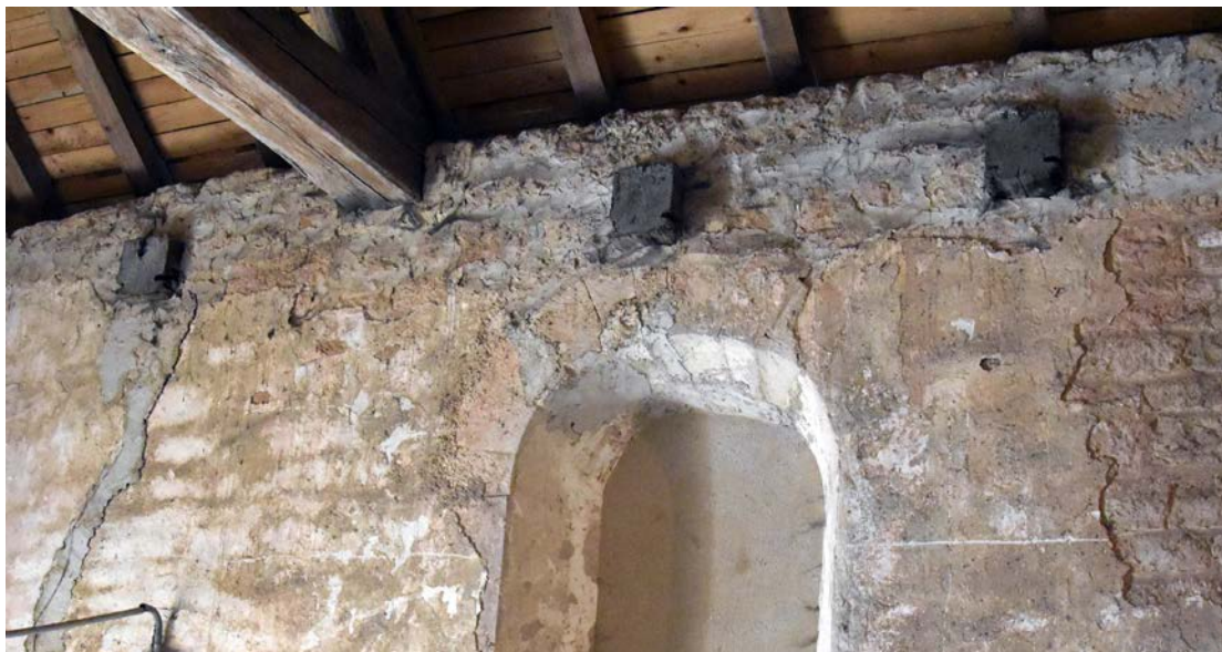
Fig. 4 – Les trois fragments d'entrails sciés vus depuis les combles de l'église de Coussey (cliché Cédric Moulis).
