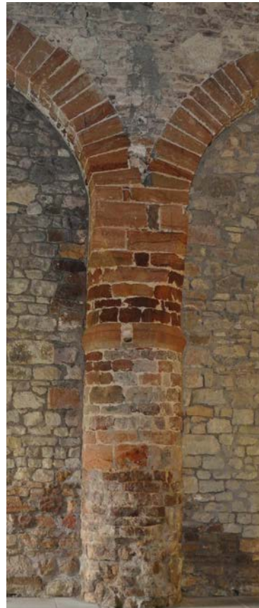
Fig. 28 – Pilier circulaire appareillé de moellons, nef du prieuré de Bleurville, 88 (cliché Cédric Moulis).
