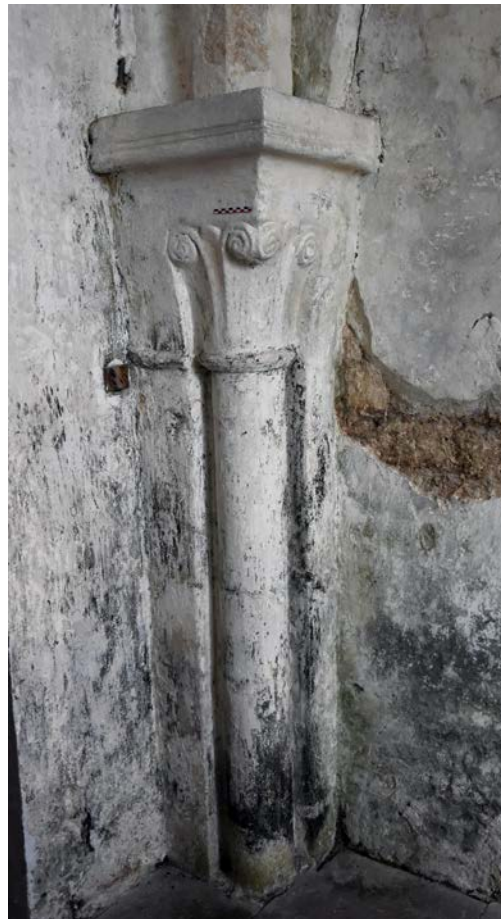
Fig. 33 – Colonnnette engagée dans des blocs de section carrée, église d'Ozières, 52 (cliché Cédric Moulis).
