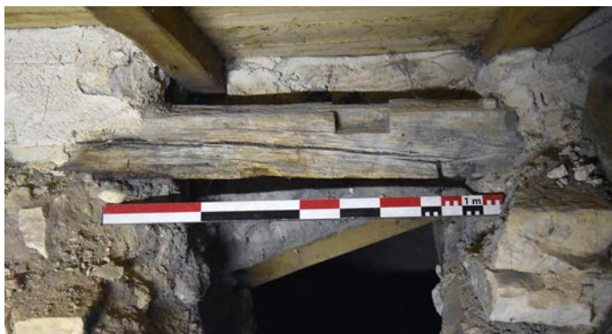
Fig. 9 – Sablière sur la croisée du transept de l'église d'Allamps (cliché Cédric Moulis).
