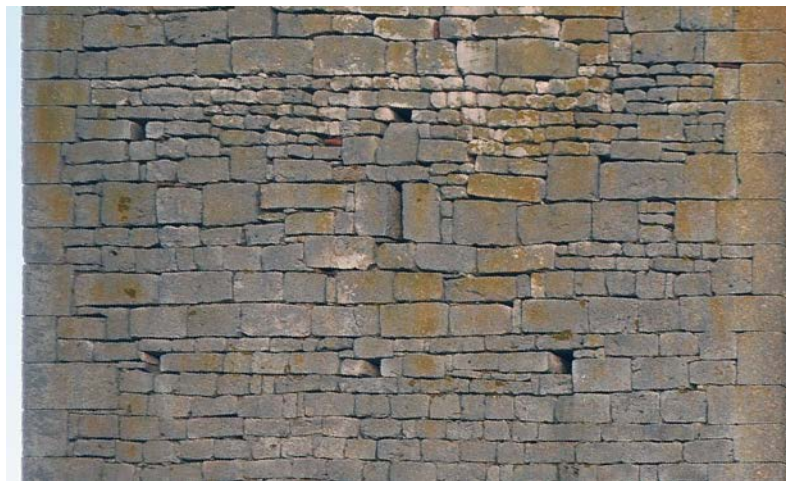
Fig. 44 – On remarque les pierres de petit calibre qui composent les assises autour des trous de boulin, clocher de Blénod-lès-Pont-à-Mousson, 54 (cliché Cédric Moulis).
