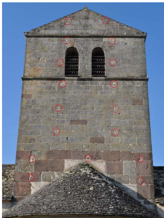
Fig. 19 – Trous de boulins rebouchés systématiquement sur le clocher de Gorhey, 88. On passe d'un échafaudage à trois perches arrimées à autant de boulins à un système à deux perches. Le changement, lisible dans la nature des pierres, pourrait correspondre à une reprise de chantier (cliché Cédric Moulis).
