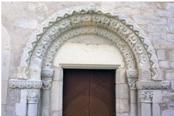
Fig. 5 – Vousures de la porte de l'église de Barisey-la-Côte, 54. Le décor en bas-relief végétal côtoie un zigzag (cliché Marion Subts).
