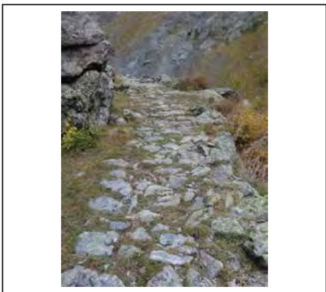
Figure 9: chemin pavé entre le Pra et le site de Salso Moreno.
