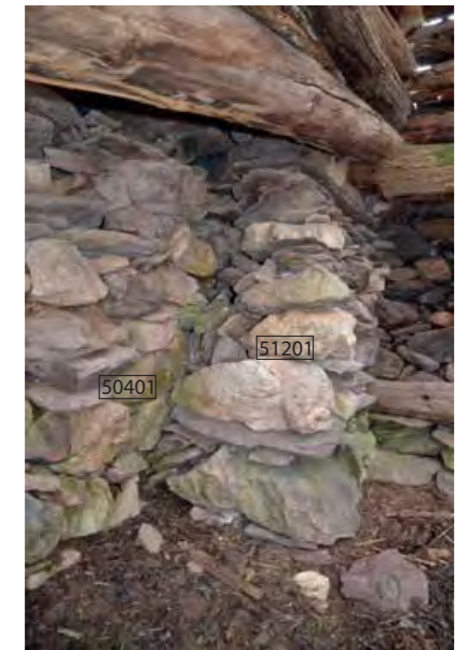
Figure 34 : Pilier 51201 accolé à l'US 50401. Cliché de V. Labbas, 2012
