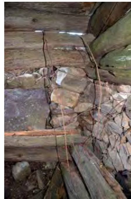
Figure 27 : Pilier 51101 dans l'angle sud est. Cliché de V. Labbas, 2012
