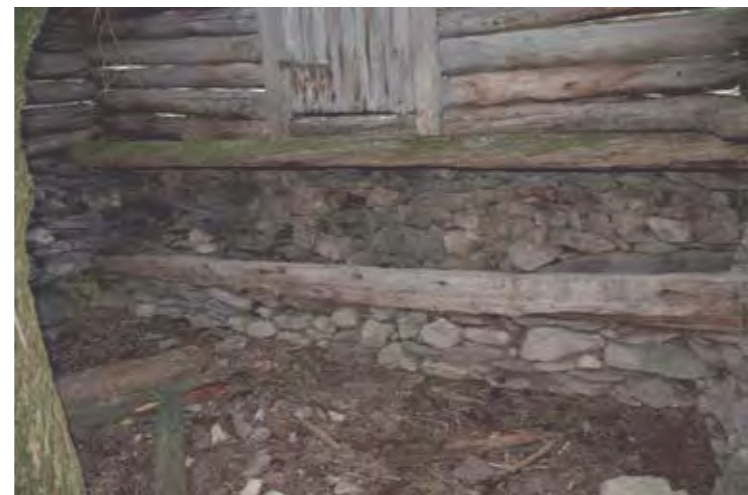
Figure 13 : MR501, vue d'ensemble de l'intérieur. Cliché de V. Labbas, 2012
