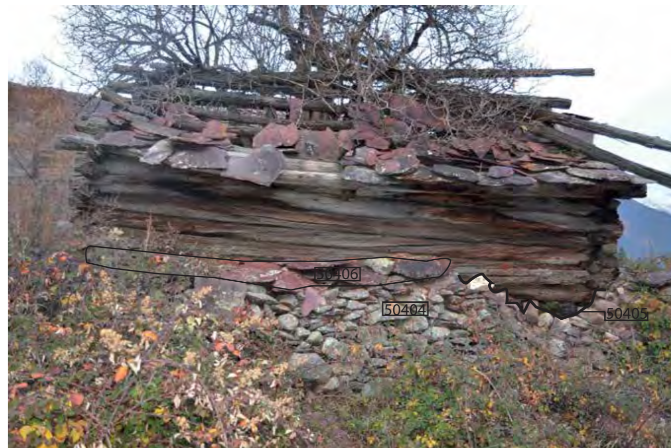
Figure 36 - MR 507 et MR 504, vue d'ensemble. Cliché de V. Labbas, 2012
