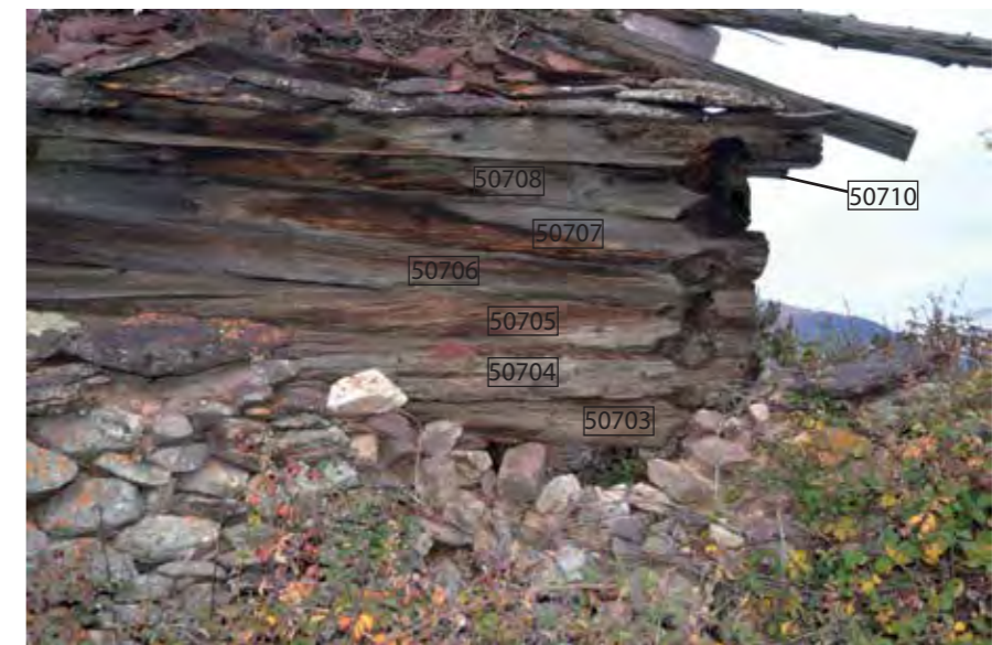
Figure 37 - MR 507 et MR 504, vue de la partie est. Cliché de V. Labbas, 2012
