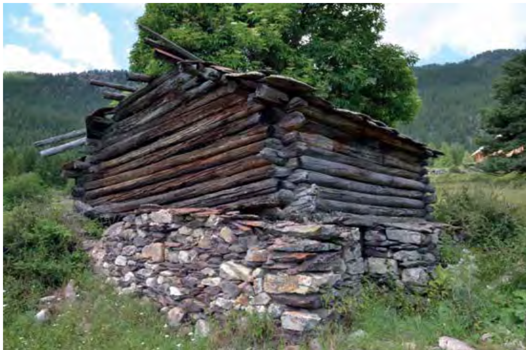
Figure 4 : RG500, vue de l'angle nord est. Cliché de V. Labbas, 2012
