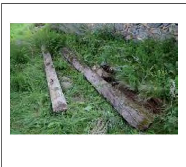
Figure 3: Bois prélevés à l'aplomb du mur est.
