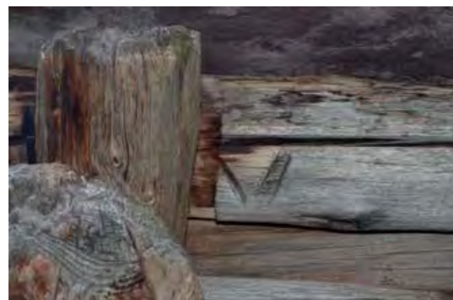
Figure 18 : Marque recoupée (50513) lors de la mise en oeuvre. Cliché de V. Labbas, 2012
