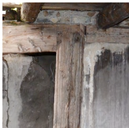
Figure 53 : bardeau réemployé en chambranle de porte en R+1. Cl. V. Labbas
