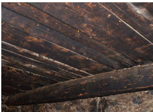
Figure 136 : détail d'un plancher de la partie logis du bâtiment BLA 1100. Cl. V. Labbas.
