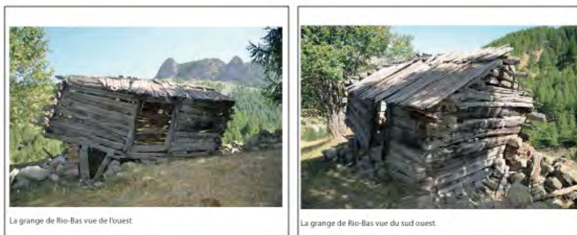
Figure 85 : la grange RIO 100 vue de l'ouest et du sud-ouest. Cl. V.Labbas
