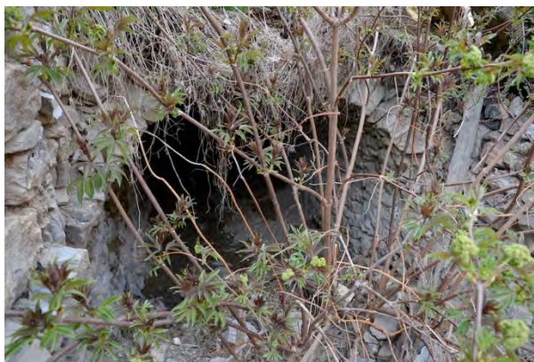
Figure 67 : La voûte VT506 vue du sud. Cl. V. Labbas
