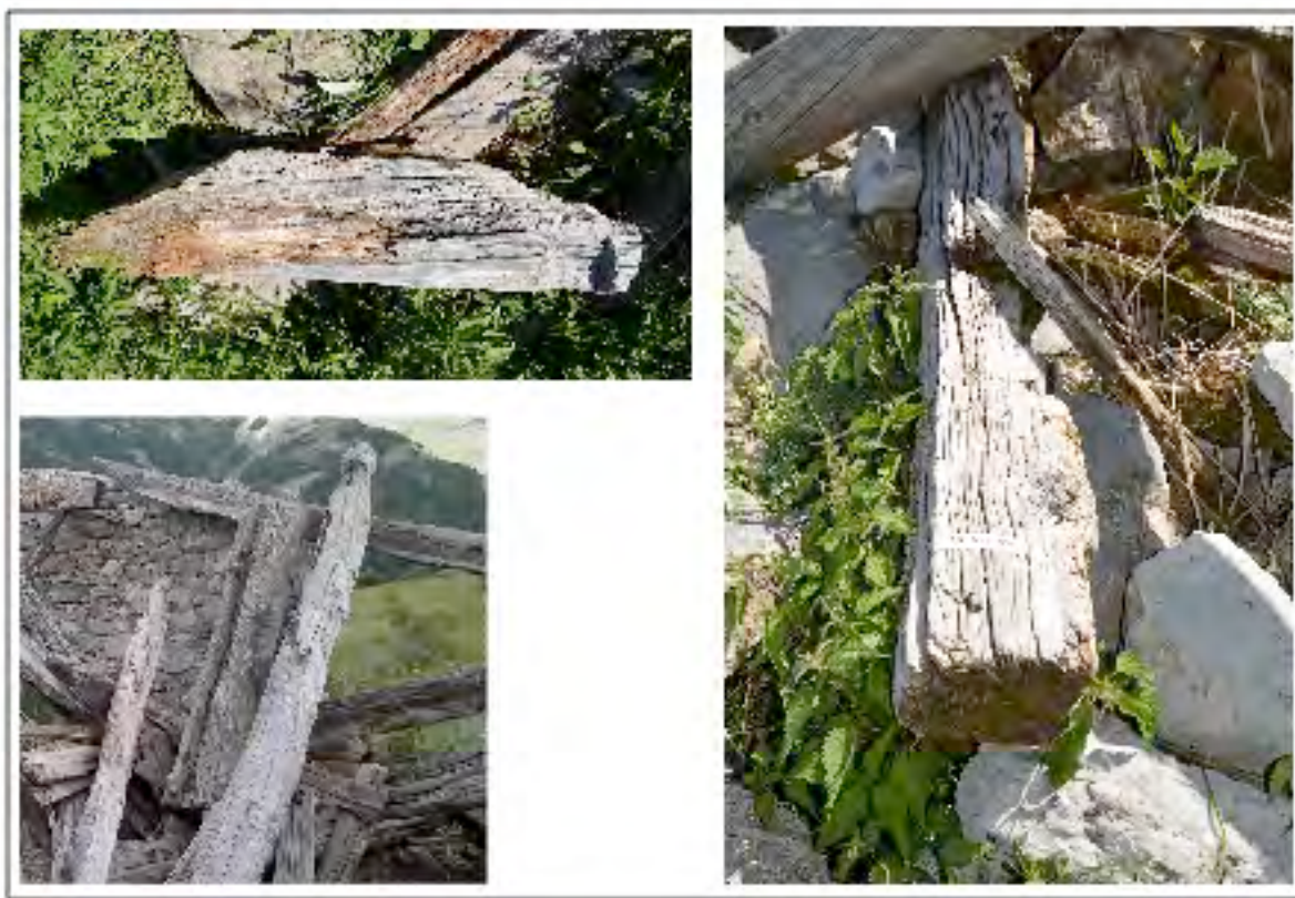
Figure 121 : Bois erratiques ou déplacés du bâtiment BLA 300. Sur la photo en bas à gauche, un ancien chambranle avec sa rainure longitudinale. Cl. de V. Labbas.
