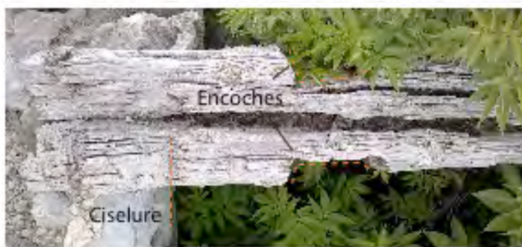
Détail de la poutre 30901.
