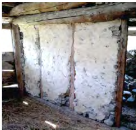
Figure 157 : Emploi du pan-de-bois dans le bâti subalpin. A gauche, le bâtiment ANL 100 (Saint-Etienne-de-Tinée) construit à l'extrême fin du XIXe siècle ou début du XXe siècle. A droite, cloison en pan-de-bois dans la grange BLA 1000 (Saint-Etienne-de-Tinée). Cl. V. Labbas
