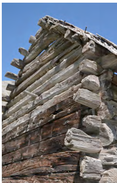
Figure 137 : Mailles empilées du pignon sud du bâtiment RUS 300. Les mailles supérieures sont circulaires et plus fines que les mailles inférieures. Cl. de V. Labbas
