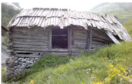
Figure 129: Vue du mur 102, gouttereau est de la grange RUS 100. Cl. V. Labbas.
