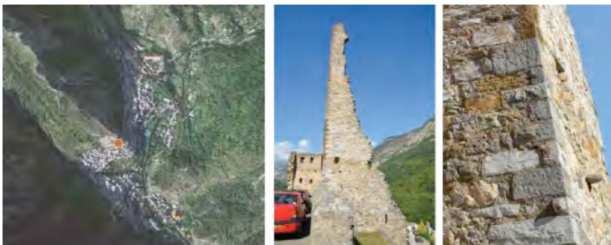
Figure 26: Vue aérienne de Tende (d'après Google Earth) avec situation de l'ancien château des Lascaris (à gauche). Vestiges d'un chaînage d'angle et détail du bossage (au centre et à droite). Cl. et DAO de V. Labbas.
