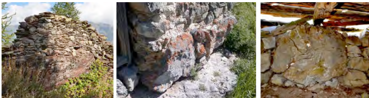
Figure 144 : Plusieurs cas d'adaptation au rocher. À gauche, un cas de rectification du rocher pour former une paroi verticale (Rougios, Roure). Au centre, les premières assises d'élévation reposent sur le rocher affleurant (BLA 700, vallon de Roya, Saint Etienne-de-Tinée). À droite, habillage d'un bloc de rocher utilisé en fondation (RIO 100, Bousieyas, Saint Dalmas-le-Selvage). Cl. V. Labbas.
