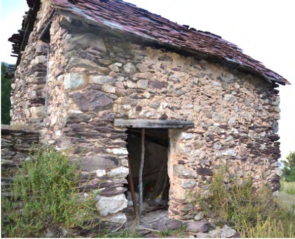
Figure 147: bâtiment construit dans le premier tiers du XIXe siècle en maçonnerie de mortier de chaux à Rougios. Cl. de V. Labbas.
