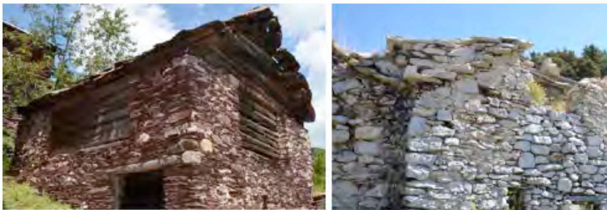
Figure 167 : Couverture en lauze de pelites sur une grange en marge du village de Roure (à gauche) et en lauze calcaire sur un état antérieur du bâtiment ANN 200 à Saorge. Cl. de V. Labbas.
