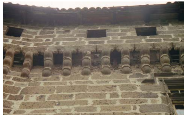
fig. 720. Détail des mâchicoulis. La Rochelambert. Saint-Paulien.
