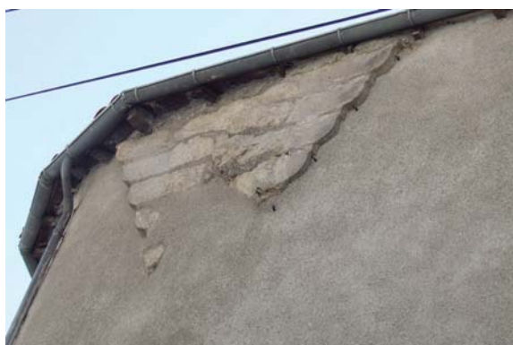
fig. 902. Consoles de mâchicoulis arasés de l'enceinte du bourg. La Chaise-Dieu.
