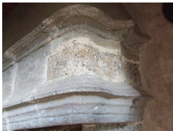
fig. 723. Cheminée du XV e s. à mouluration courbe. La Rochelambert. Saint-Paulien.
