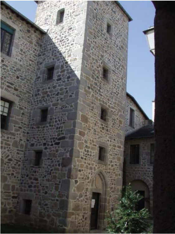
fig. 879. Tour quadrangulaire sur la face est. Hôtel urbain. Yssingeaux.
