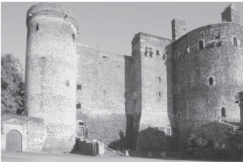
fig. 775. Courtine ouest – extérieur. Saint-Vidal.
