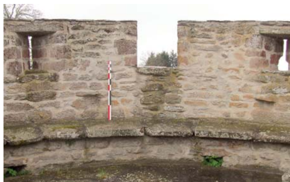
fig. 742. Parapet crénelé avec encoches de la terrasse. Mercoeur.
