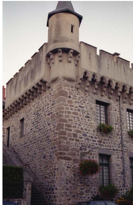
fig. 880. Échauguette reconstruite sur l'angle nord-ouest. Yssingeaux.
