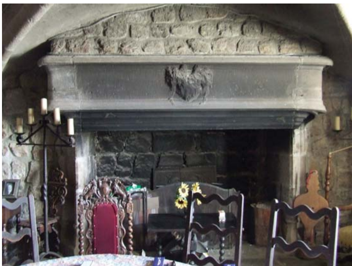
fig. 889. Cheminée du rez-de-chaussée. Treslemont. Yssingeaux.
