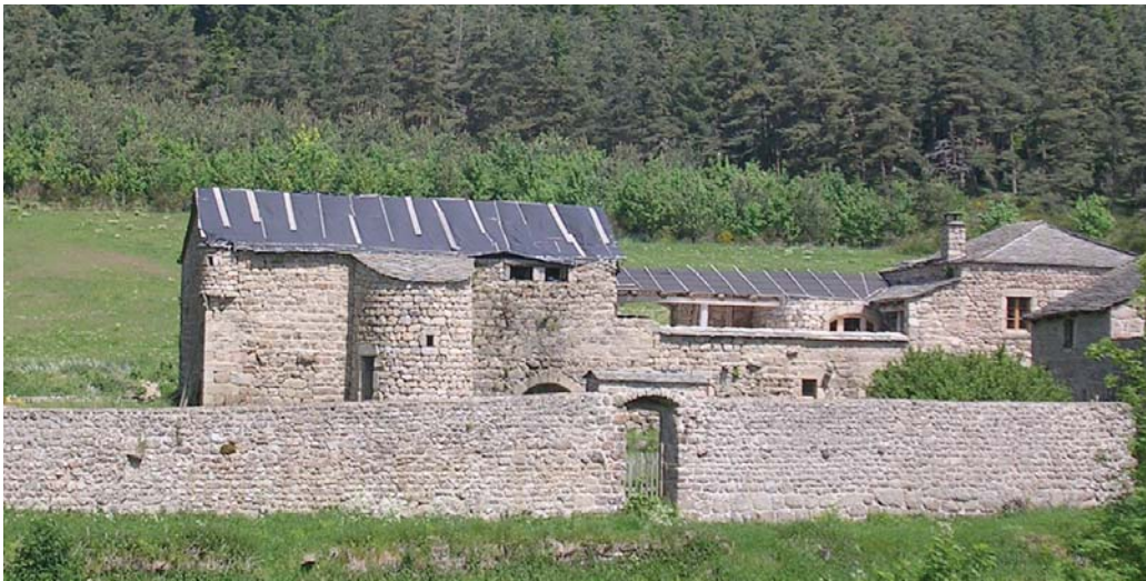
fig. 661. Vue d'un logis de la maison forte des Crozes. Saint-Jeures.
