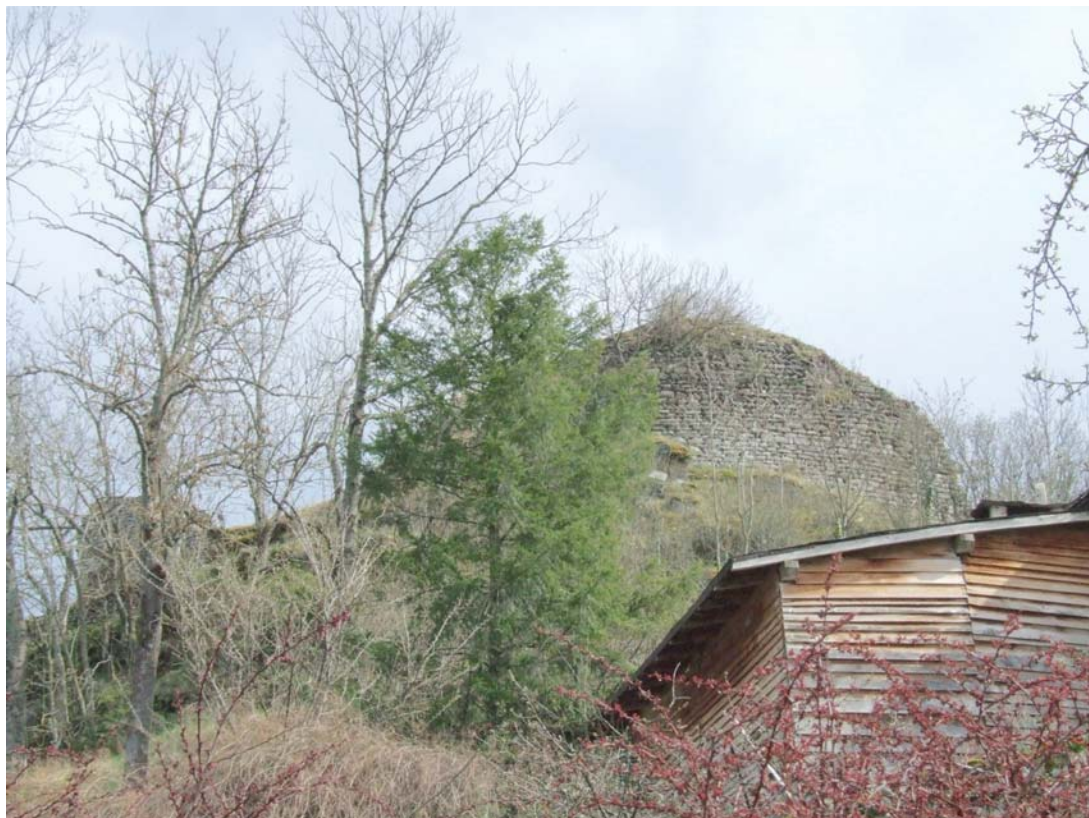
fig. 727. Vue d'un pan de mur du castrum de Lardeyrol.
