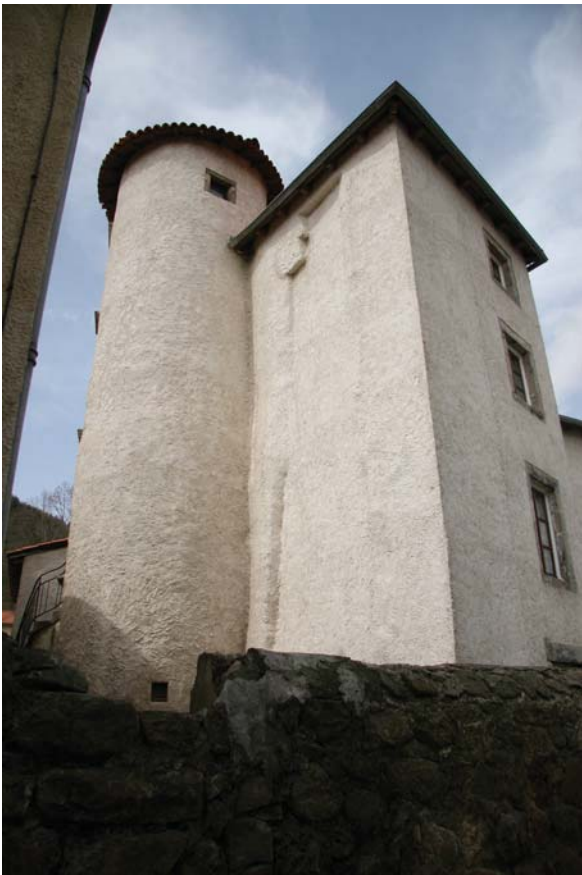
fig. 873. Vue du logis abbatial de Vorey.
