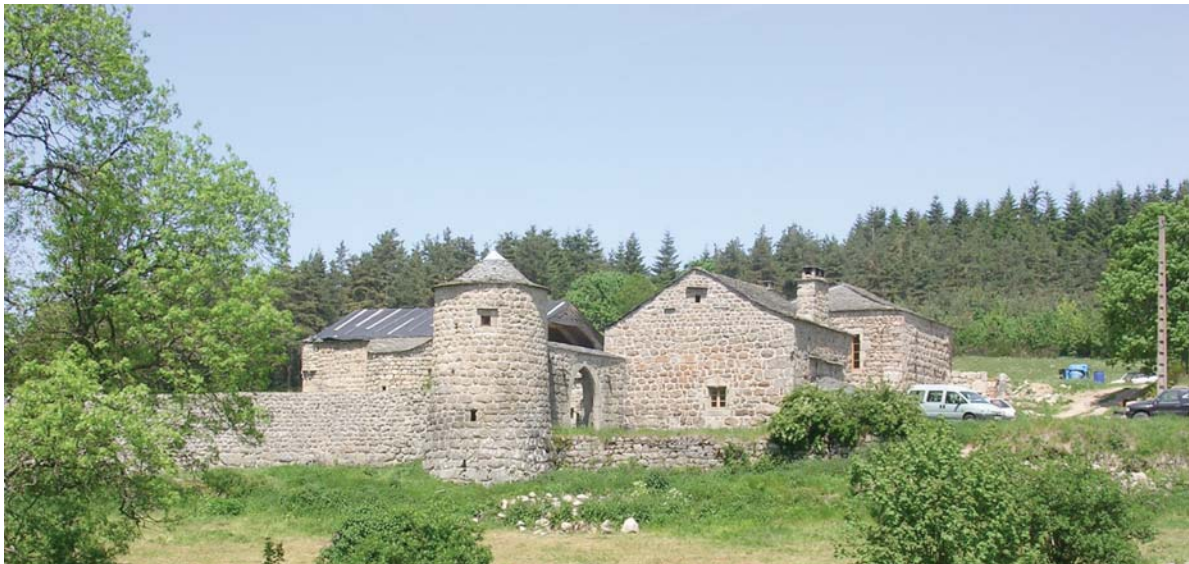
fig. 662. Vue de l'entrée la maison forte des Crozes. Saint-Jeures.
