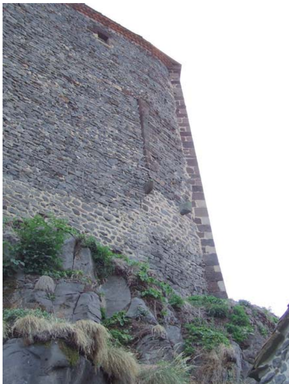
fig. 770. Vue d'un départ de courtine et de circulation haute. Saint-Privat-d'Allier.
