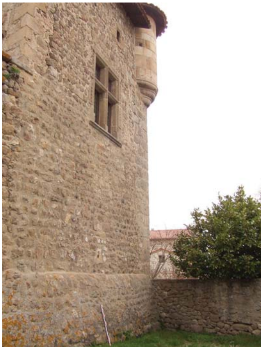
fig. 854. Flanc est : échauguette, base talutée, canonnière à trou de serrure en tir rasant. Valprivas.
