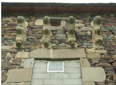
fig. 544. Détails des corbeaux de la bretèche en face sud. Chabanolles. Retournac.
