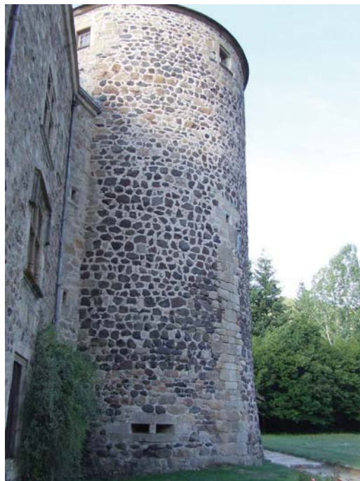
fig. 620. Logis sud : canonnière de la tour sud-est. Le Villard de Saint-Vidal.
