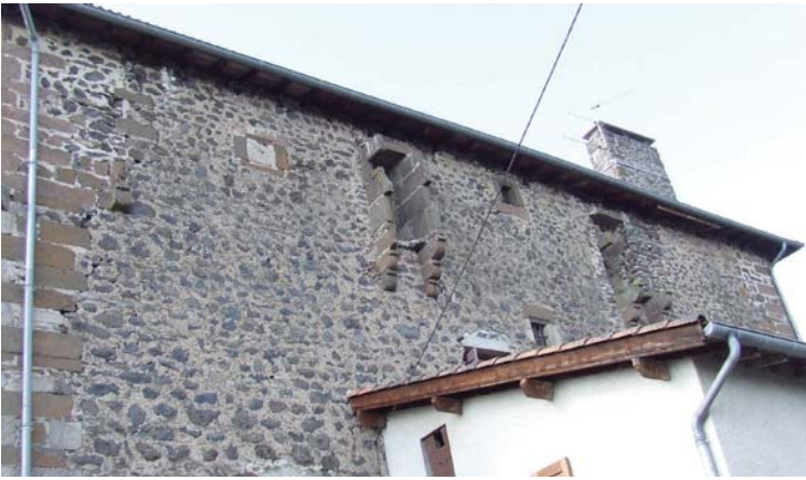
fig. 798. Vue de la face nord avec latrines et échauquettes. Le Barret.
