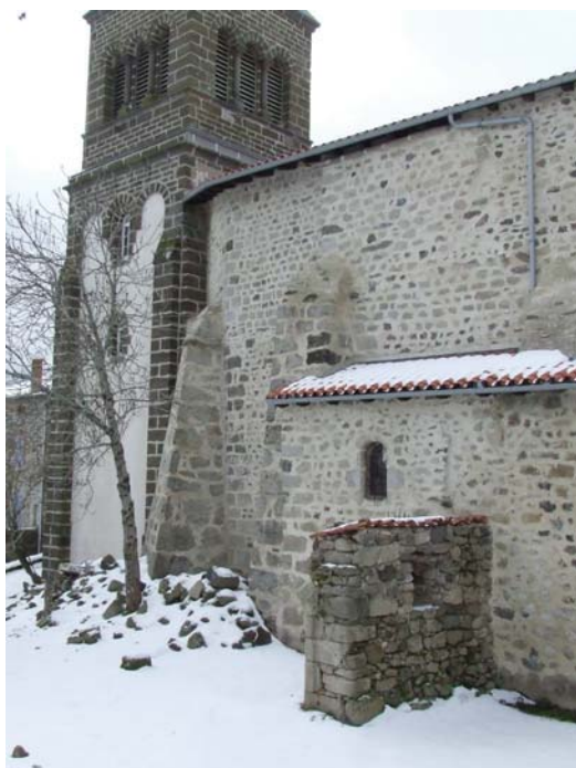
fig. 866. Mur gouttereau de l'église côté nord. Vernassal.
