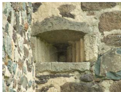
fig. 545. Détail de la canonnère à redent. Chabanolles. Retournac.
