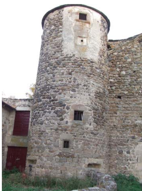
fig. 617. Logis nord : tour sud de la façade ouest. Le Villard de Saint-Vidal.
