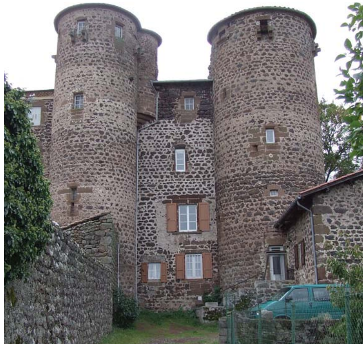
fig. 859. Face nord de la maison forte. Vergezac.
