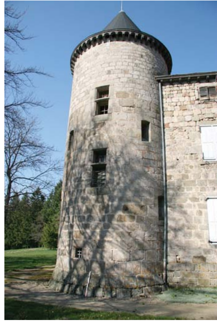
fig. 599. Vue de la tour est, face est. Le Villard de Sainte-Sigolène.
