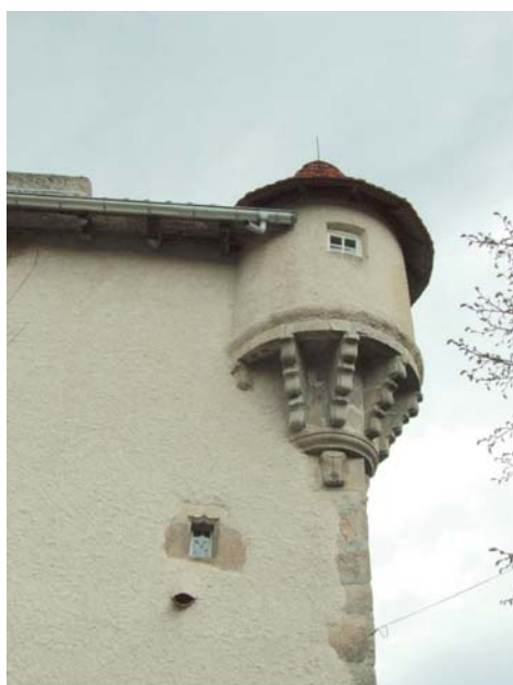
fig. 551. Échauguette sur corbeaux. Ribes. Retournac.
