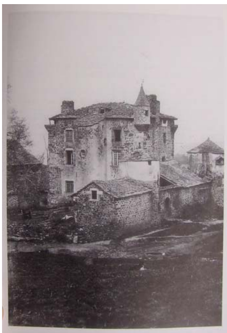
fig. 550. Vue avant restauration (Sagnard (J.), op. cit.) Mercuret. Retournac.
