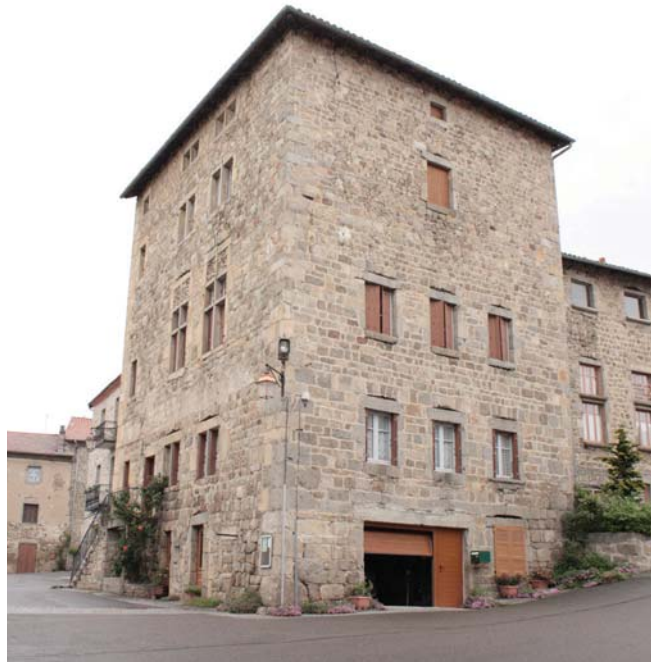
fig. 834. Vue de la maison-tour. Tiranges.
