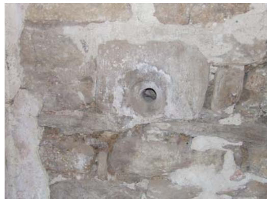
fig. 757. Ouverture pour le tir en réemploi, intérieur mur rez-de-cour. Mercoeur.
