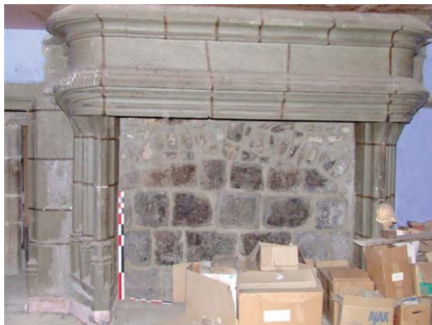
fig. 695. Cheminée du rez-de-chaussée du logis ouest. Saint-Pal-de-Chalencon.
