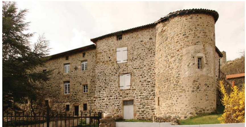
fig. 559. Retour de la muraille vers l'ouest depuis la tour. Roche-en-Régnier.
