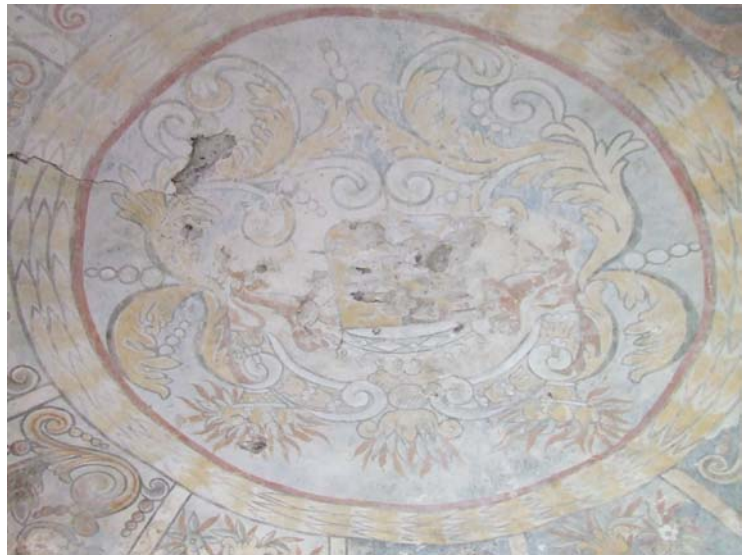
fig. 750. Détail peinture sur la voûte et trace du trou d'homme. Mercoeur.
