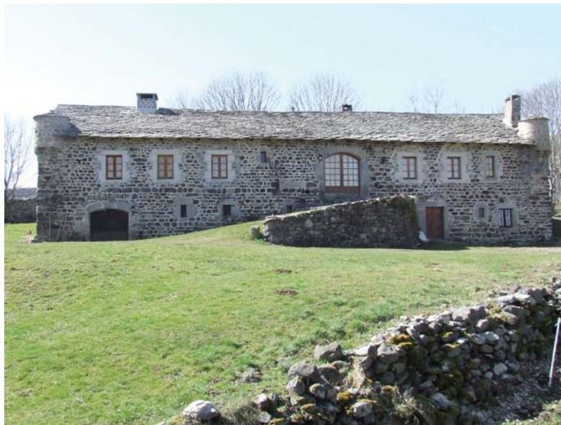
fig. 886. Vue du corps de logis principal de l'abbaye de Bellecombe encore en élévation. Yssingeaux.
