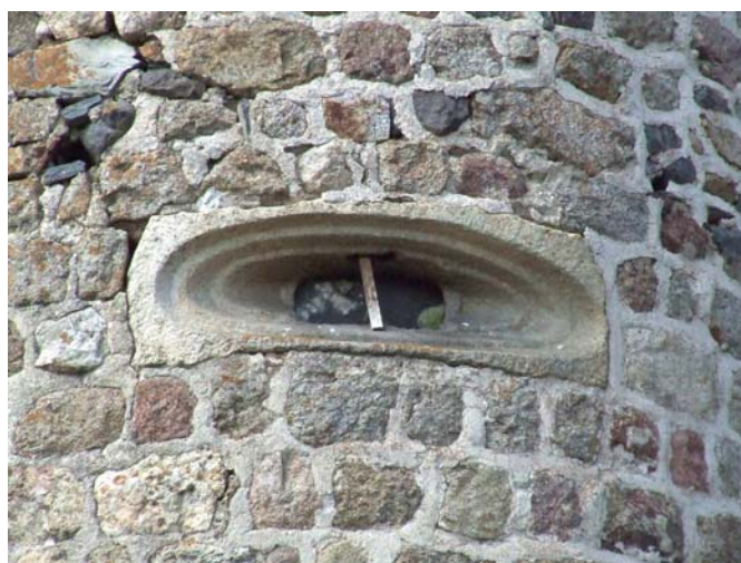
fig. 890. Canonnière à redent extérieure sur la façade sud. Treslemont. Yssingeaux.
