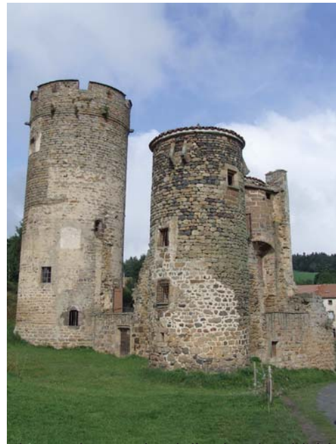
fig. 732. Site dans son état actuel vu de l'angle sud-est (cliché 2008). Mercoeur.
