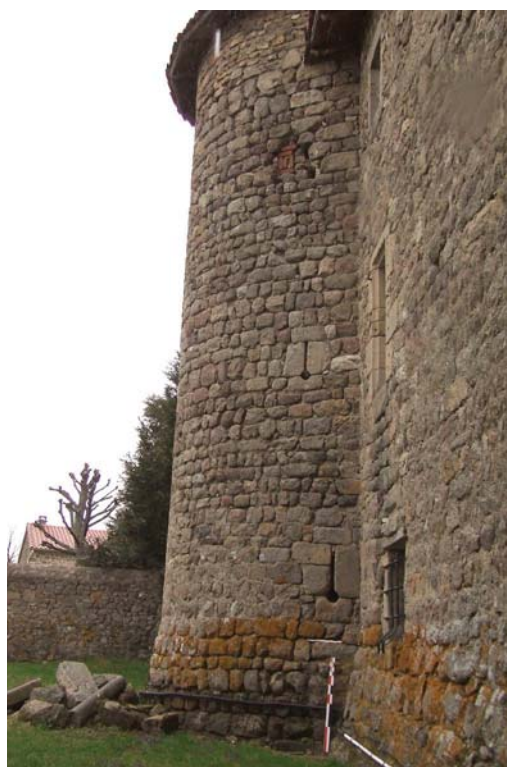
fig. 849. Détail de la superposition des archères-canonniers sur le flanc ouest. Valprivas.
