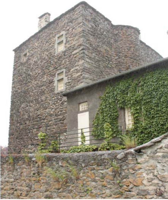
fig. 677. Vue de la face nord de Mortessaigne.
