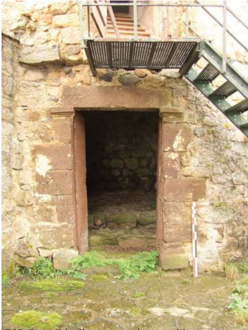
fig. 749. Portail à pilastre, rez-de-cour. Mercoeur.
