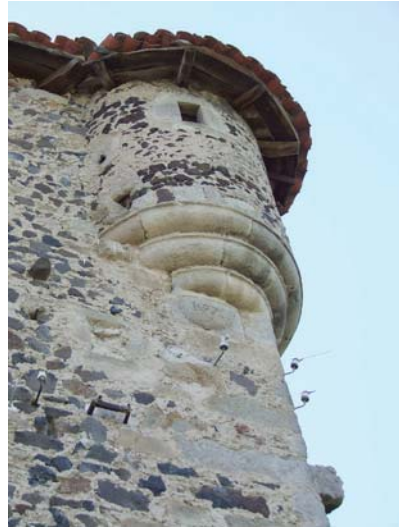
fig. 624. Détail de l'échauguette. La Coste-Saint-Germain.
