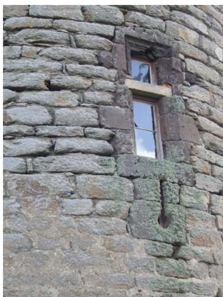
fig. 739. Archère-canonnière sous la fenêtre du niveau 3, vue extérieure. Mercoeur.
