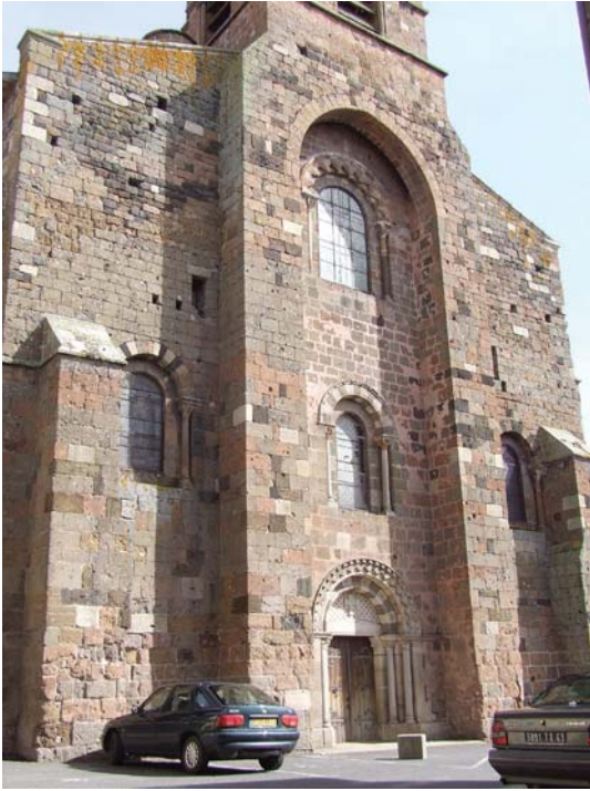
fig. 714. Vue rapprochée de l'arcade-mâchicoulis sur la tour occidentale. Saint-Paulien.
