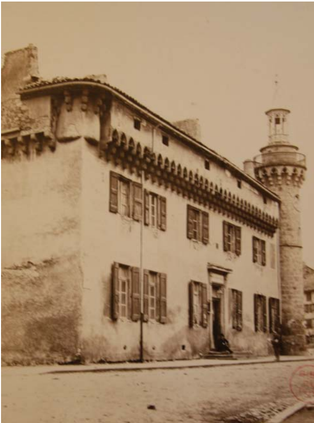
fig. 881. Vue de l'hôtel urbain avant restauration. Rouget (A.), op. cit. Bibliothèque Municipale du Puy-en-Velay. Fonds Cortial. Yssingeaux.
