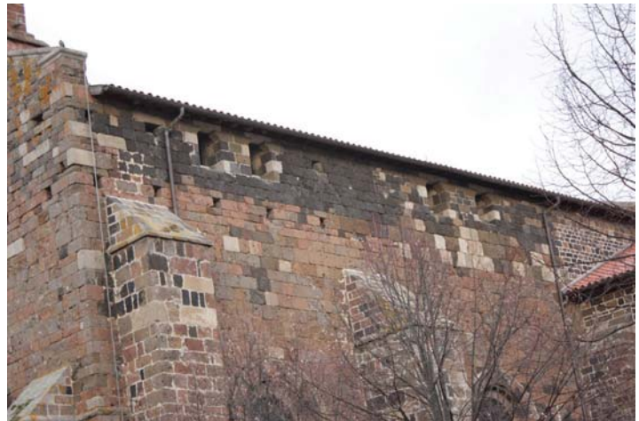
fig. 711. Vue du chemin de ronde surélevé sur la nef sur le mur gouttereau sud. Saint-Paulien.
