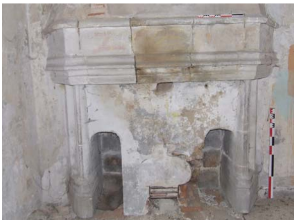
fig. 694. Cheminée du second niveau de la grosse tour. Saint-Pal-de-Chalencon.
