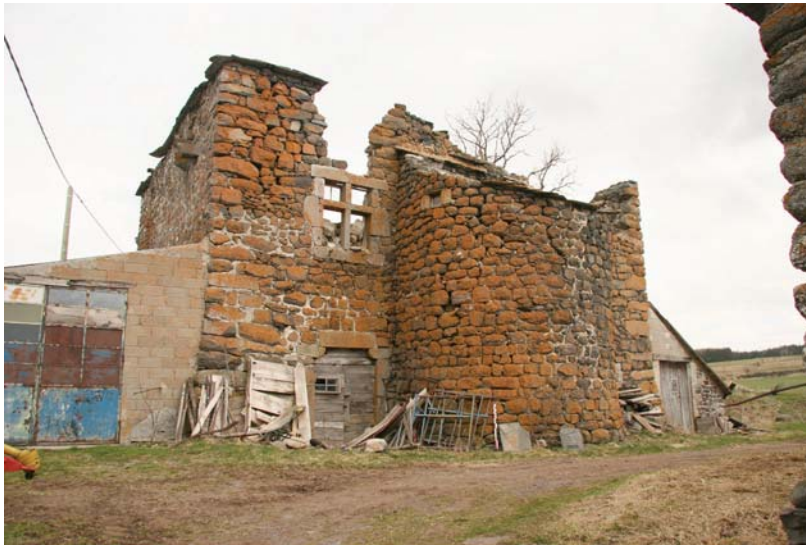
fig. 603. Vue générale de la maison forte de Pralas ou Pranlas. Saint-Front.
