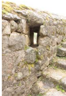
fig. 568. Seconde ouverture pour le tir sur la courtine. Chalencon.
