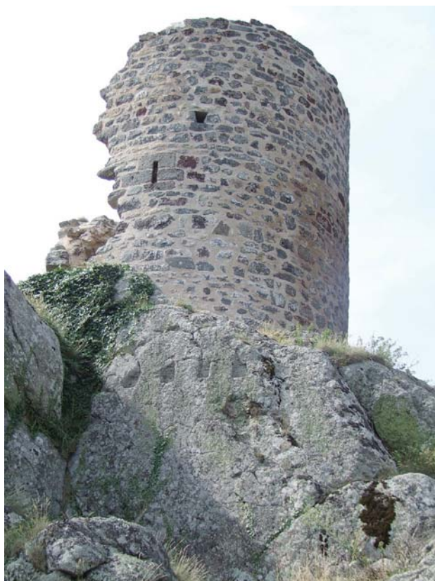
fig. 764. Tour circulaire de Rochegude avec encoches sur rocher. Saint-Privat-d'Allier.
