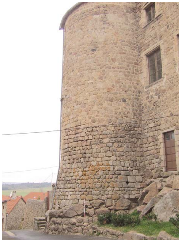
fig. 691. Grosse tour sud-ouest. Saint-Pal-de-Chalencon.
