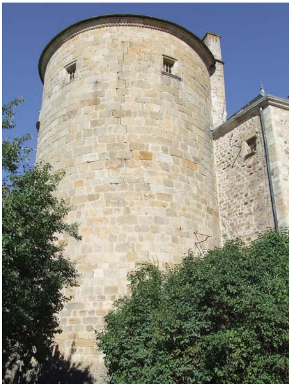
fig. 621. Logis sud : étage sommital de la tour sud-ouest. Le Villard de Saint-Vidal.
