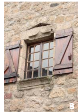
6.7.8. Éléments en réemploi : corbeau à visage humanoïde, console à main, baie à appui et accolade
