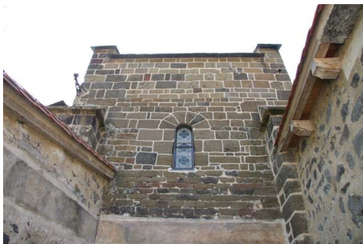
fig. 786. Détail d'une des faces de l'église, une tour du chevet plat. Saint-Vidal.
