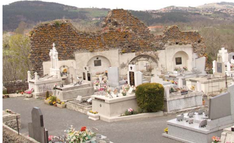
fig. 814. Pan de mur occidentaux : ancien bâtiment (aula?) Solignac-sur-Loire.
