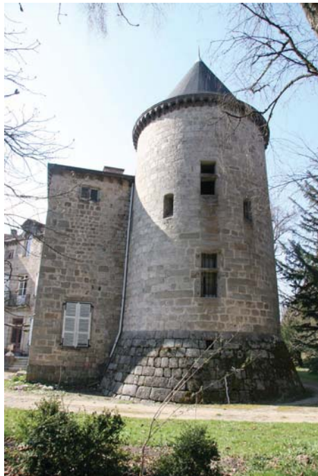
fig. 600. Vue générale de la tour sud. Le Villard de Sainte-Sigolène.
