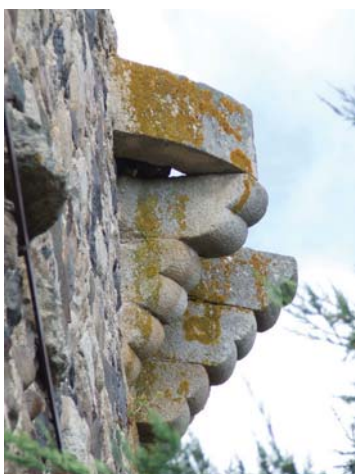
fig. 633. Détail des corbeaux des échauguettes. Le Pin.
