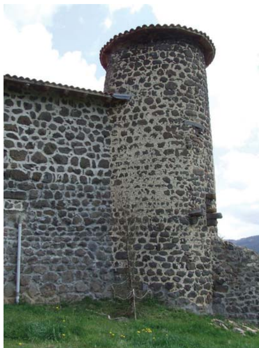
fig. 822. Tour sud de la maison forte de la Baume. Solignac-sur-Loire.
