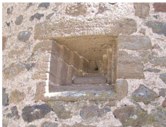
fig. 864. Canonnière à redent sur tour d'escalier. Le Thiolent. Vergezac.
