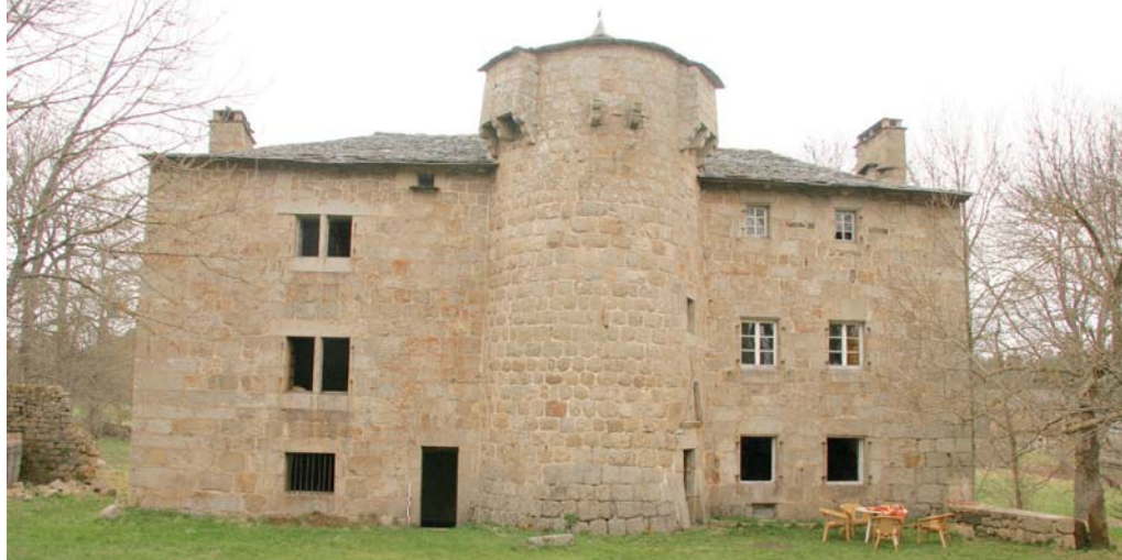
fig. 665. Vue de la face sud de la maison forte de Salcrupt. Saint-Jeures.
