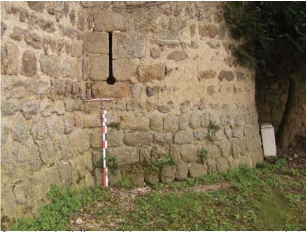
fig. 850. Détail d'une archère-canonnière en tir rasant. Valprivas.
