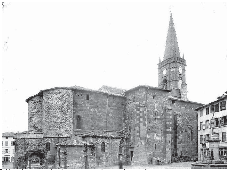
fig. 716. Vue des tours du chevet avant destruction : prise de vue avant 1894 : Base Mémoire. Jean-Eugène Durand. Saint-Paulien.
