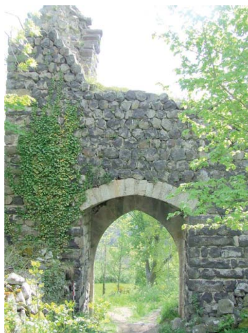
fig. 671. Porte principale. Vue depuis l'intérieur du site. Chapteuil.
