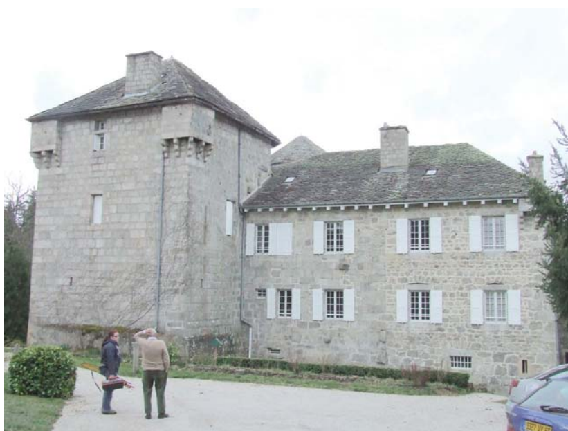
fig. 831. Vue de la face nord-ouest. Tour avec fenêtre à simple traverse. Corps de logis rectangulaire agrandi. Le Besset. Tence.
