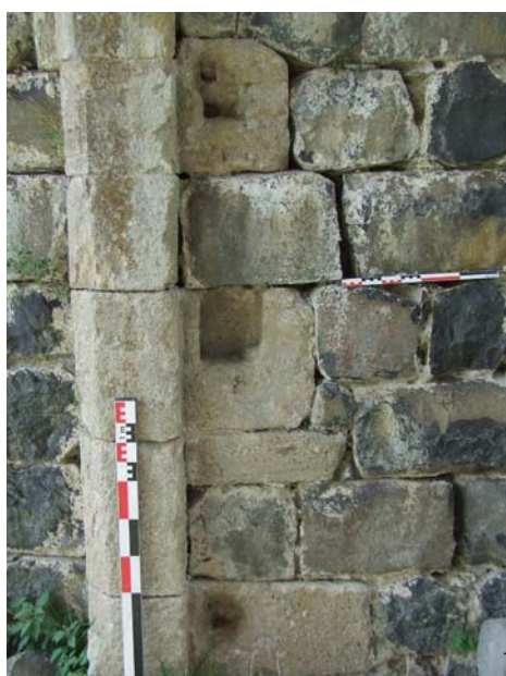
fig. 672. Porte principale. Détail de la porte à vantaux et barres. Chapteuil.
