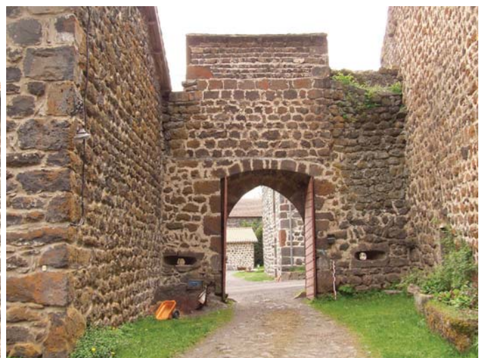
fig. 810. Vue du portail depuis la cour. Séneujols.
