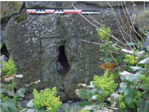
fig. 800. Détail d'une canonnière en trou de serrure. Le Barret.
