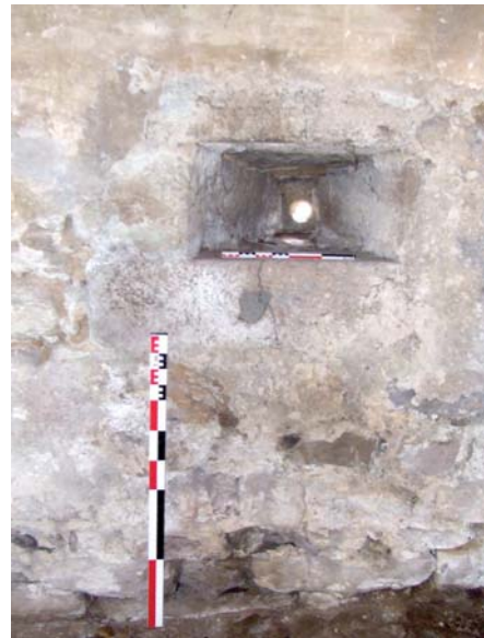
fig. 755. Détail ouverture circulaire pour le tir au mousquet, embrasure interne. Mercoeur.
