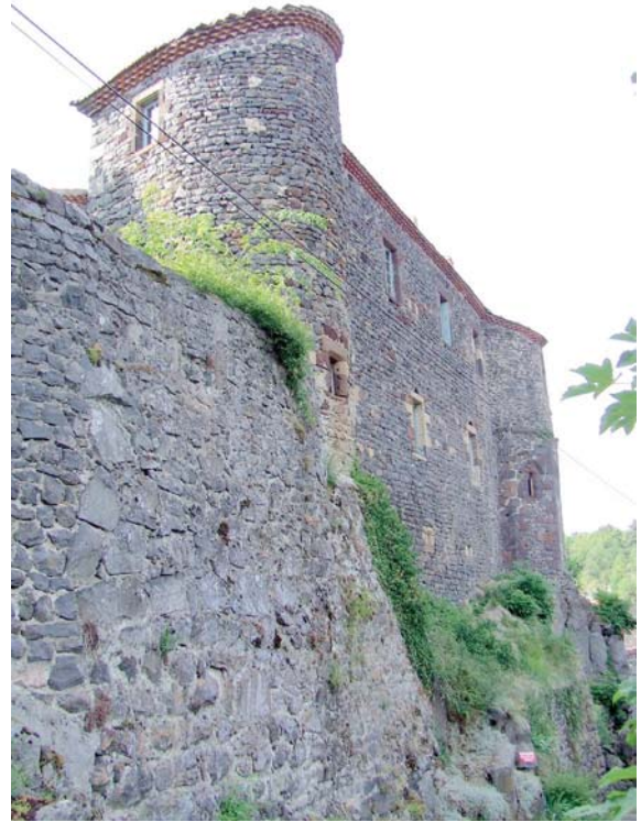
fig. 768. Vue de la courtine orientale flanquée des deux tours circulaires. Saint-Privat-d'Allier.
