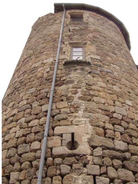
fig. 693. Détail d'une canonnrière de la base de la grosse tour. Saint-Pal-de-Chalencon.
