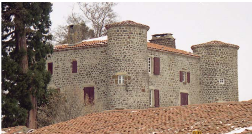
fig. 580. Vue de la façade est de la Tour Saint-Christophe. Saint-Christophe-sur-Dolaison.
