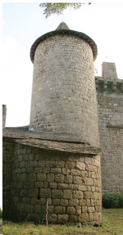
fig. 829. Vue de l'avant-corps à archère-canonnière sur la tour. La Brosse. Tence.
