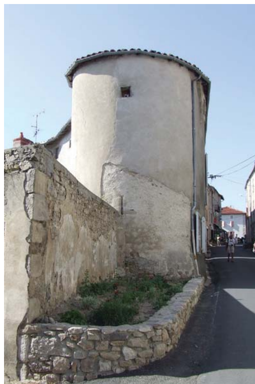
fig. 903. Tour circulaire de flanquement de l'enceinte du bourg à archère-canonnière. La Chaise-Dieu.
