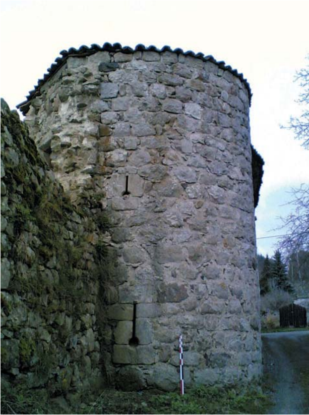
fig. 867. Tour de flanquement circulaire. Vues extérieures. Vernassal.
