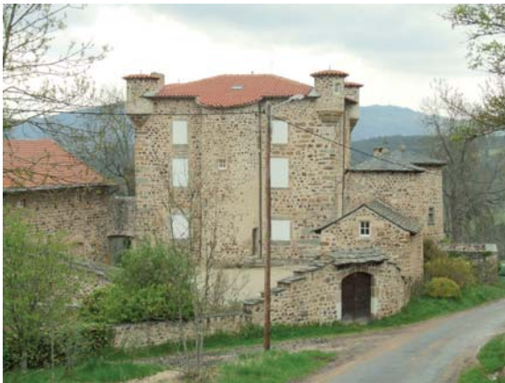
fig. 548. Façade sud de Mercuret. Retournac.
