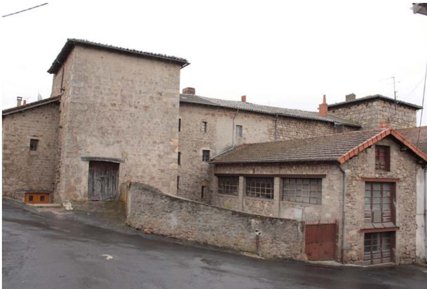
fig. 833. Vue des maisons du front ouest du bourg. Tiranges.
