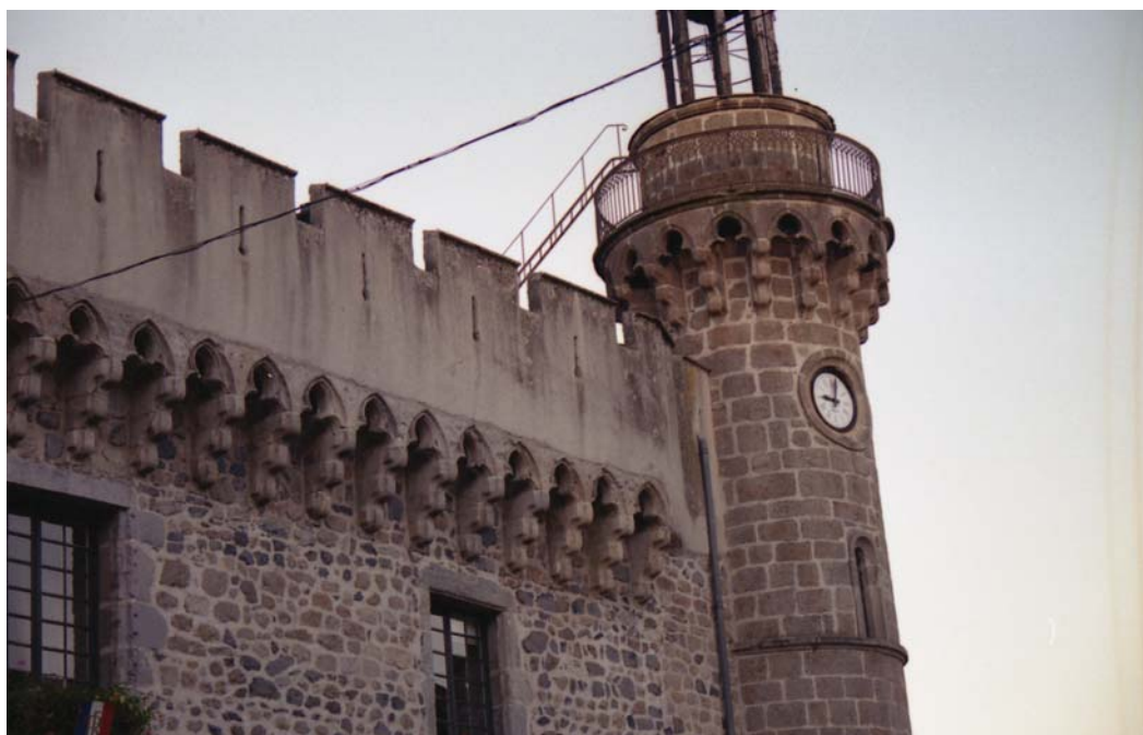
fig. 882. Mâchicoulis sur face ouest. Hôtel urbain. Yssingeaux.
