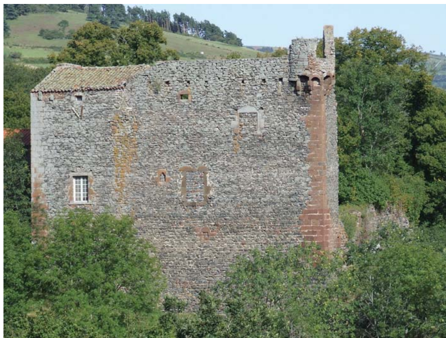
fig. 926. Vue du pan de mur occidental conservé avec écahugette. Vissac.
