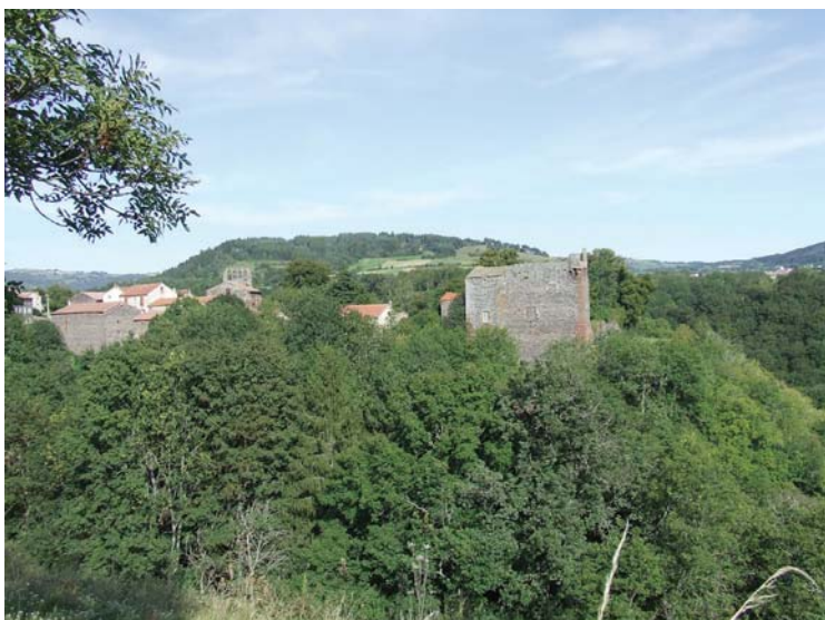
fig. 925. Vue générale du bourg de Vissac depuis l'ouest. Vissac.
