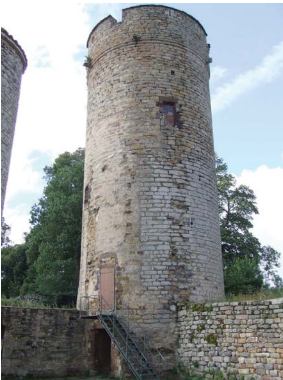
fig. 751. Arrachements des murs de courtines sur la tour, vue de l'angle nord-est. Mercoeur.
