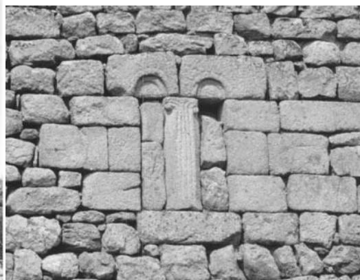
fig. 839. Détail de la baie géminée à colonnette gravée. Dossier de l'Inventaire. Usson-le-château. Usson-en-Forez.
