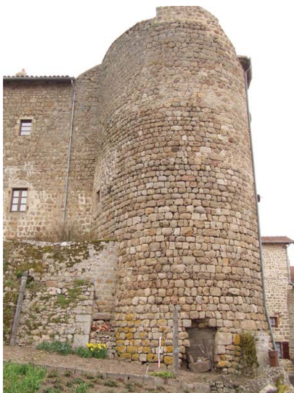
fig. 692. Grosse tour sud-ouest. Saint-Pal-de-Chalencon.
