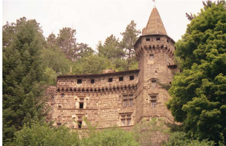
fig. 719. Vue générale de l'édifice côté vallée. La Rochelambert. Saint-Paulien.
