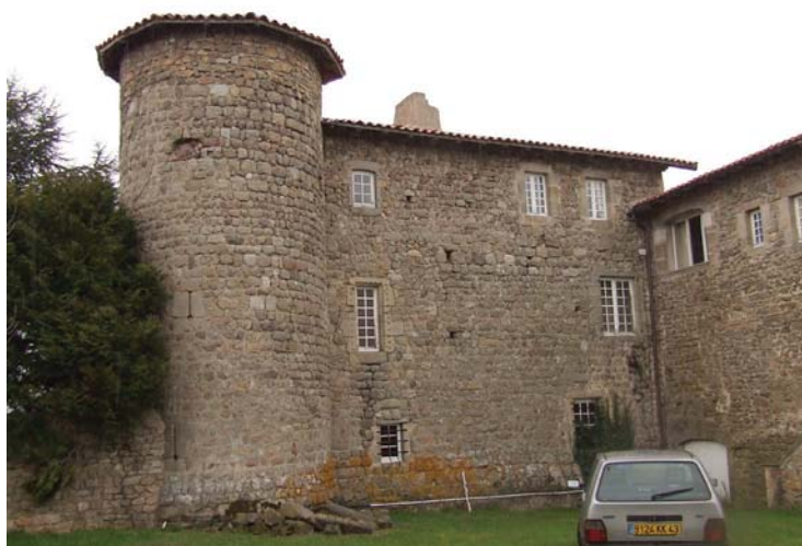
fig. 848. Tour circulaire d'angle : vue avec le flanc ouest. Valprivas.
