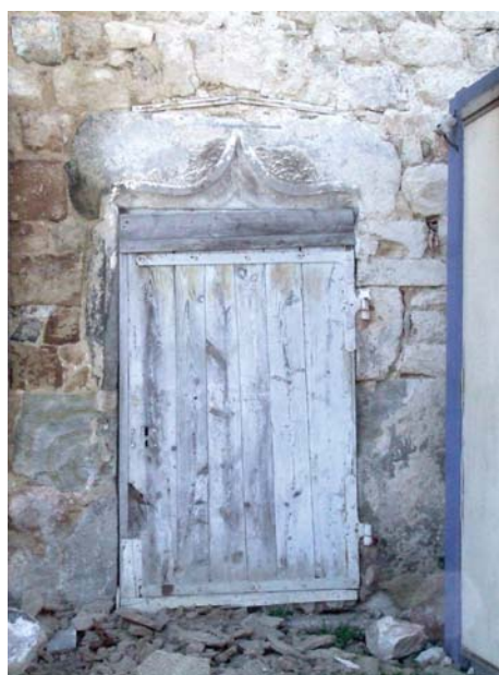
fig. 892. Porte encore en place en 2008. Choumouroux. Yssingeaux.
