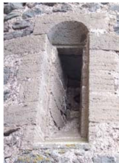
fig. 860. Canonnière à trémie. Vergezac.
