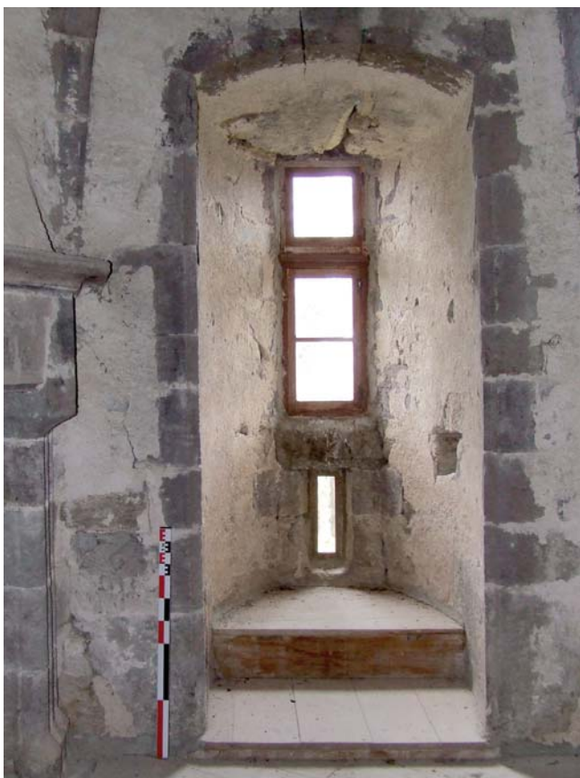
fig. 743. Ébrasement interne de la fenêtre à traverse, encoche à droite. Mercoeur.
