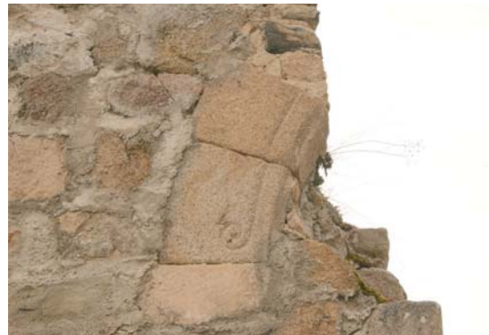
fig. 556. Détail du départ de l'arc de la porte. Roche-en-Régnier.
