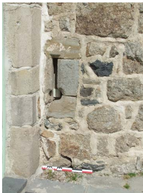
fig. 888. Archère-canonnaire sur la façade sud. Treslemont. Yssingeaux.
