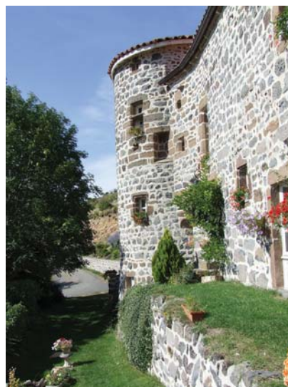
fig. 652. Vue générale de la tour circulaire septentrionale. Cereix.
