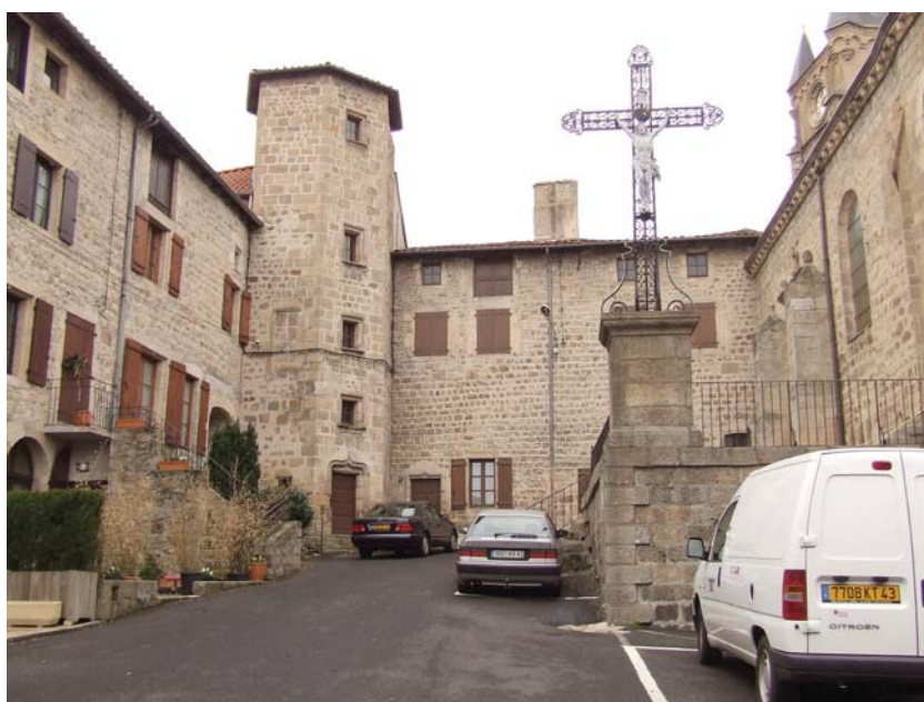
fig. 697. Tour d'escalier. Saint-Pal-de-Chalencon.
