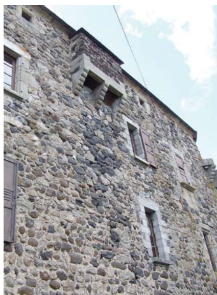
fig. 634. Face nord-ouest. Détail de la bretèche. Le Pin.
