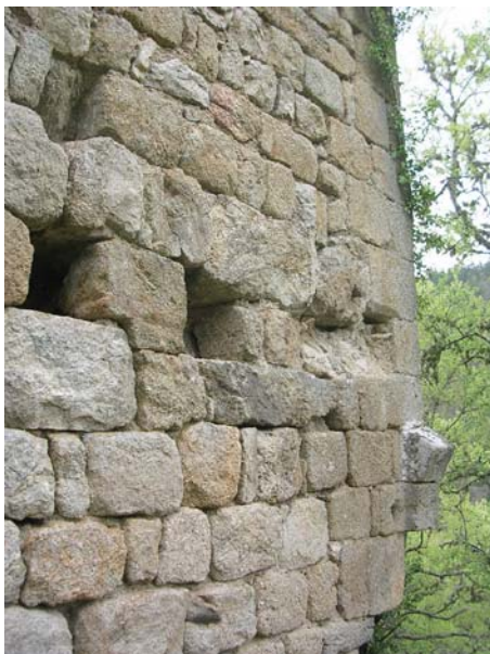
fig. 683. Détail des empottements du premier niveau et le départ d'arc d'un passage accolé. Lignon. Saint-Maurice-de-Lignon.
