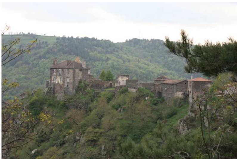
fig. 582. Vue de la face nord de la bâtisse seigneuriale. Saint-Didier-d'Allier.
