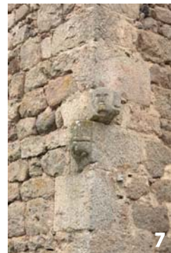
6.7.8. Éléments en réemploi : corbeau à visage humanoïde, console à main, baie à appui et accolade
