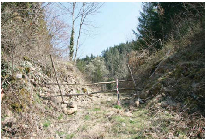
fig. 595. Vue générale d'un fossé aménagé en deçà du pic rocheux. La Tour. Sainte-Sigolène.
