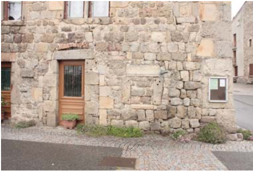
fig. 835. Détail des ouvertures du rez-de-chaussée. Tiranges.
