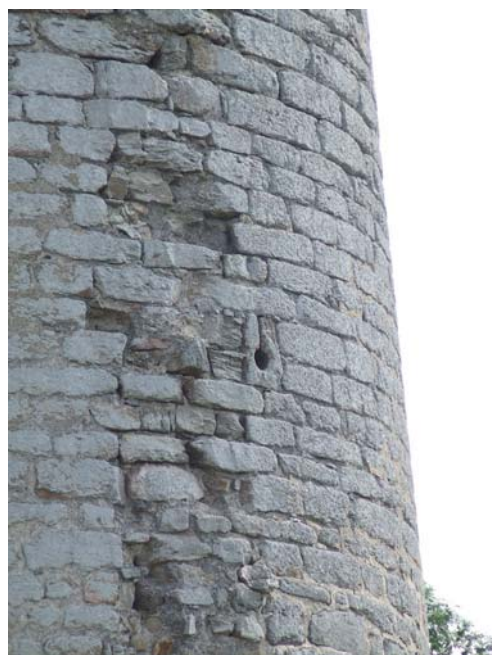
fig. 740. Archère-canonnière de l'escalier du niveau 2. Mercoeur.
