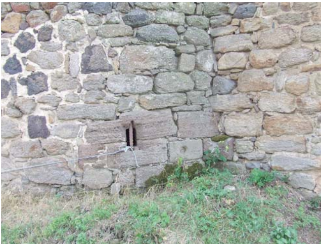
fig. 756. Ouverture pour le tir en réemploi, flanc nord de la tour sud-est. Mercoeur.
