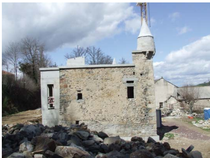
fig. 891. Vue générale de la bâtisse avec échauguette d'angle sur corbeaux en 2008. Choumouroux. Yssingeaux.
