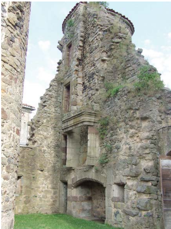
fig. 758. Élévation logis à cheminées du flanc sud. Mercoeur.
