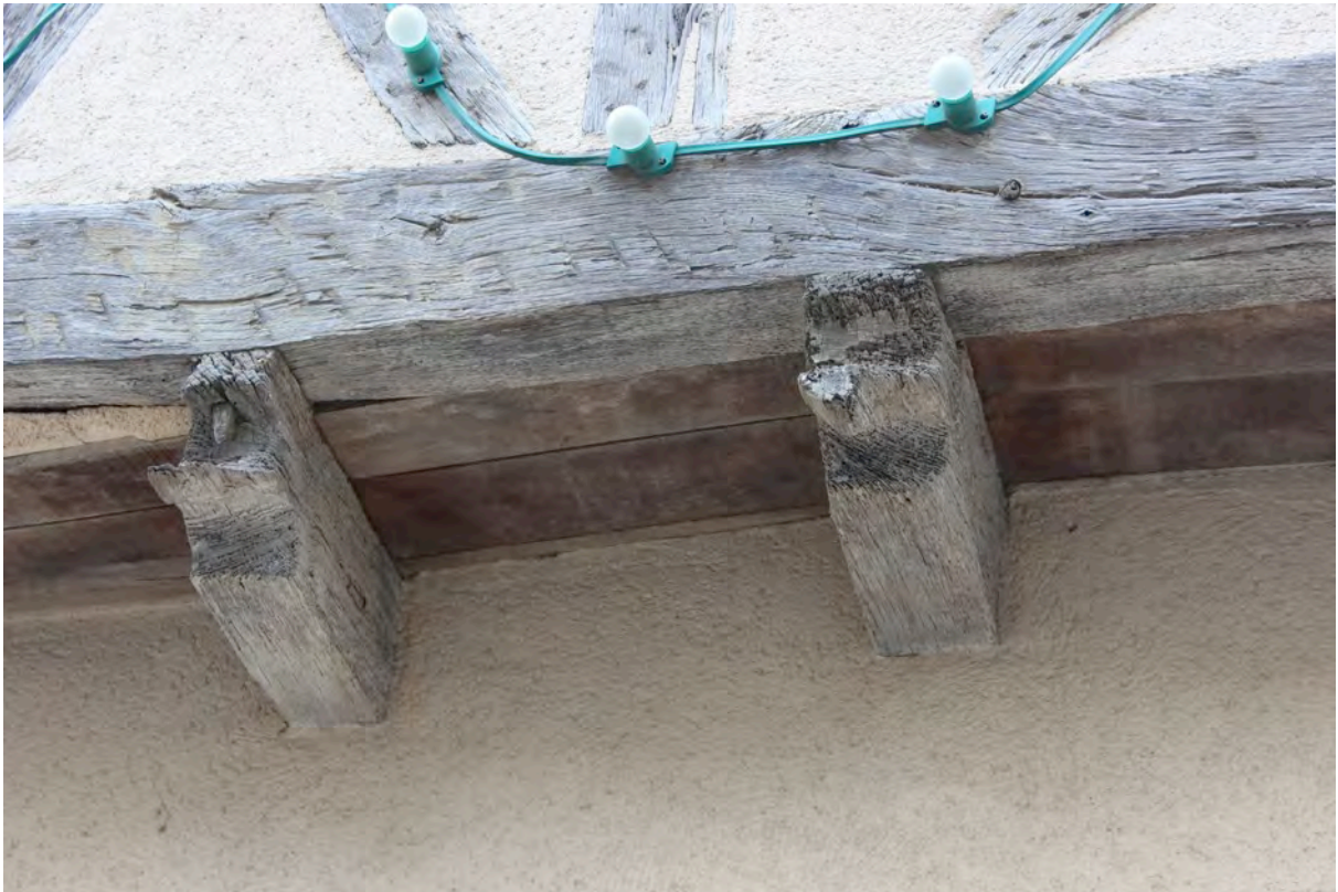
Fig. 9-92 – La Sauvetat, maison (parcelle AI 47), détail des abouts de solives.
