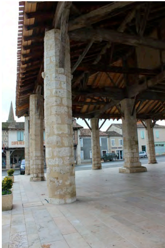
Fig. 6-138 – Solomiac, détail des piliers de la halle, vue depuis le nord.
