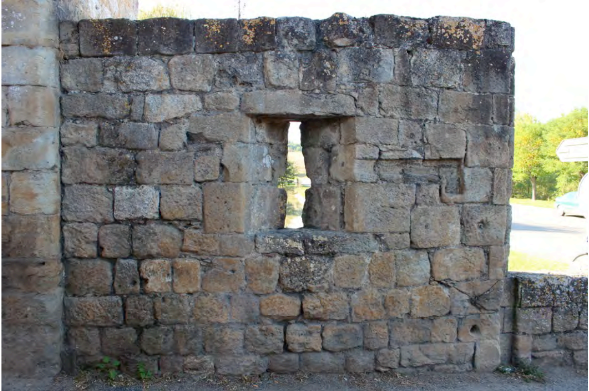
Fig. 8-5 – Barran, mur ouest du pont, vue depuis l'est.
