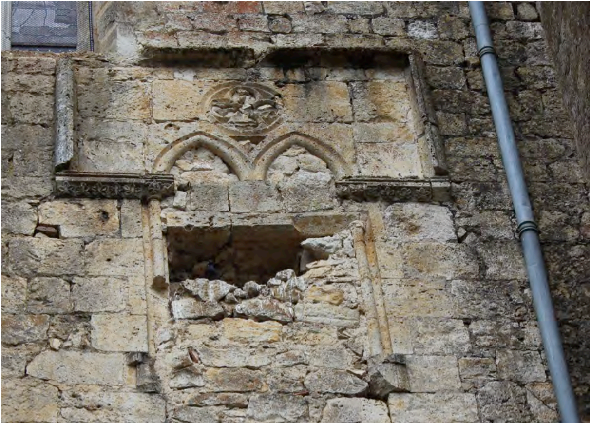
Fig. 4-41 – Montréal, église paroissiale, élévation sud, baie géminée bouchée (n°1).
