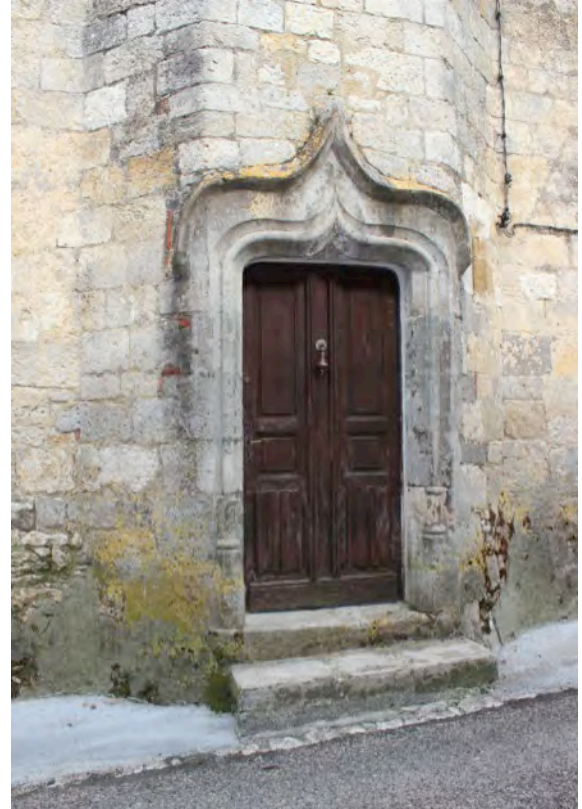
Fig. 9-105 – Montréal, maison « du bailli » (parcelle BM 213), élévation occidentale, détail de la porte à accolade sculptée.
