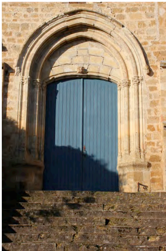
Fig. 6-121 – Barran, portail de l'église paroissiale, vue depuis l'est.
