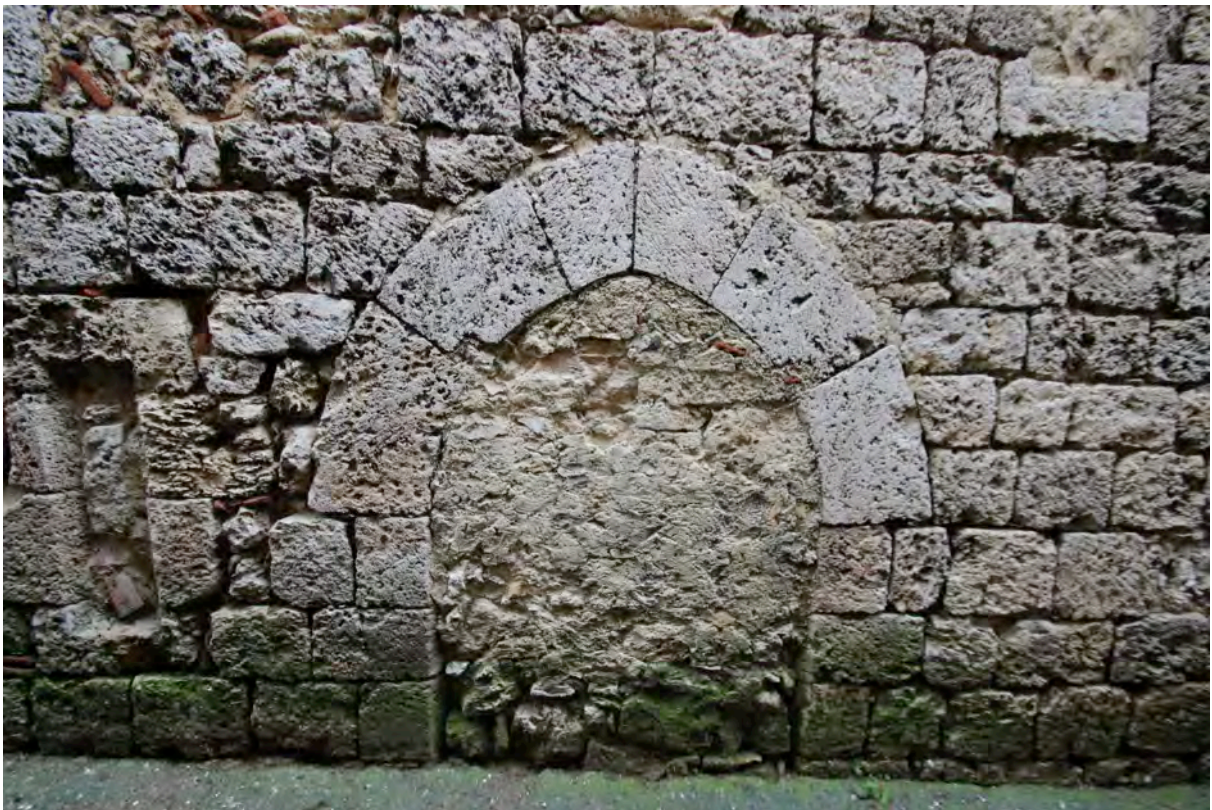
Fig. 4-85 – Montréal, maison parcelle BM 223, cave, vue extérieure de la porte et du jour donnant sur la ruelle, vue depuis le nord.
