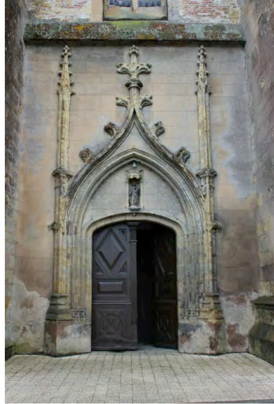
Fig. 9-39 – Barcelonne, portail de l'église, vue depuis le nord.
