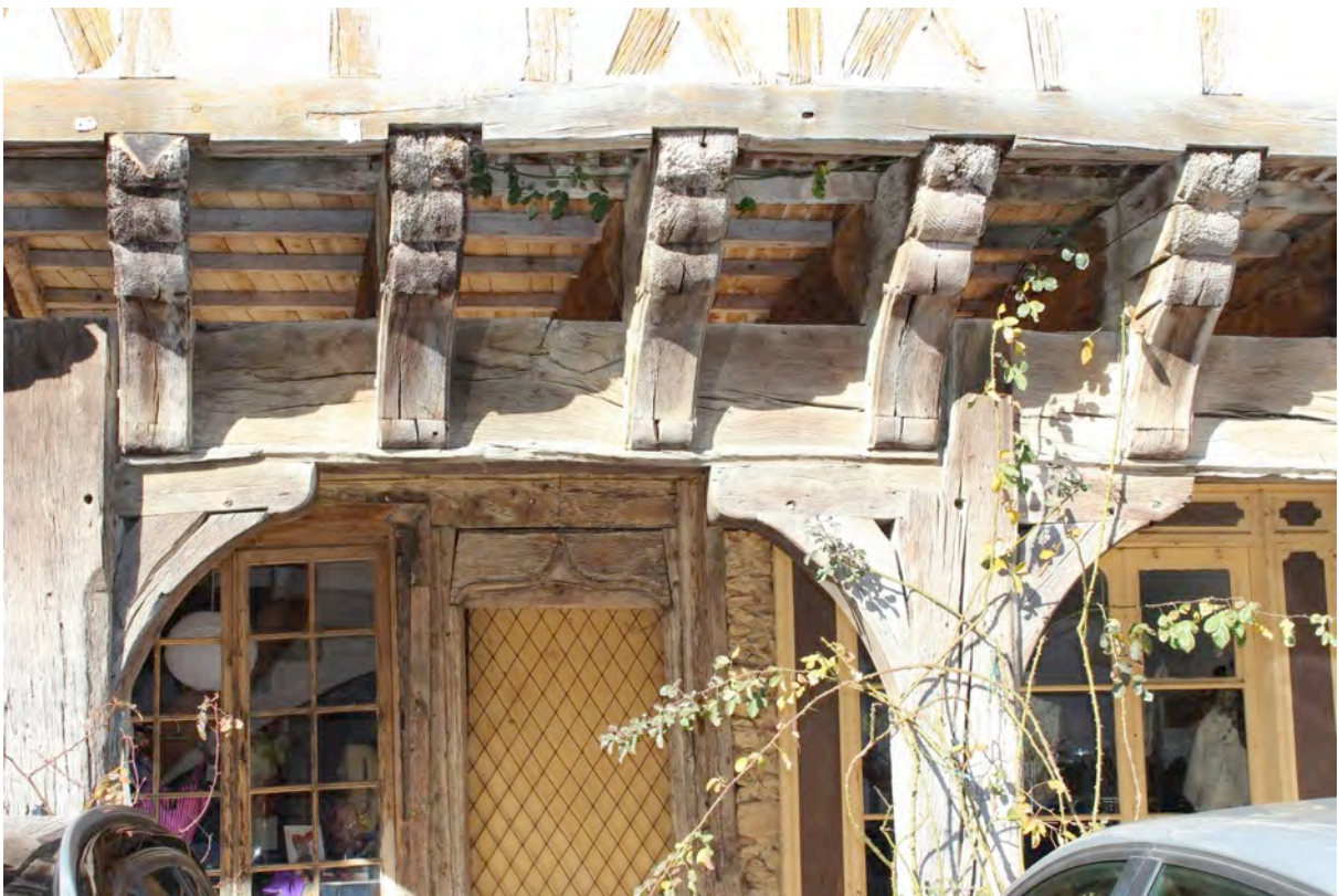
Fig. 9-91 – Bassoues, maison (parcelle AB 61), détail des solives en encorbellement et des consoles.
