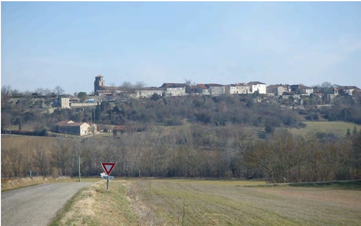
Fig. 4-1 – Tournecoupe, village vu depuis la vallée de l'Arrats, à l'ouest.
