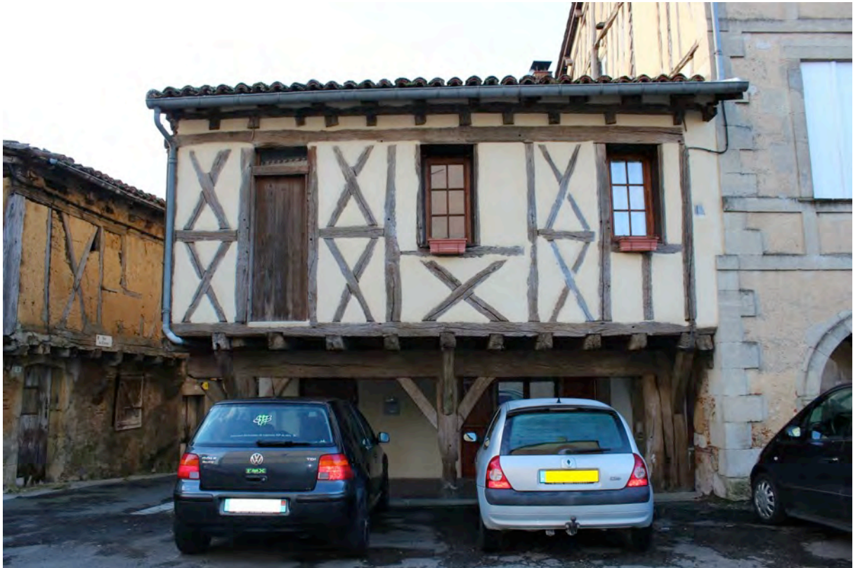
Fig. 9-7 – Cazaubon, maison à l'angle de la place (parcelle AV 394), vue depuis le nord.
