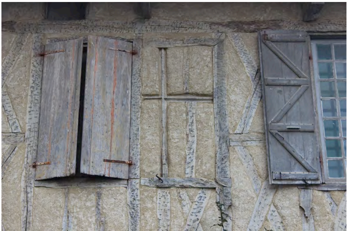
Fig. 9-62 – Monfort, maison (parcelle B 725), façade nord-est, détail de la croisée du premier étage.
