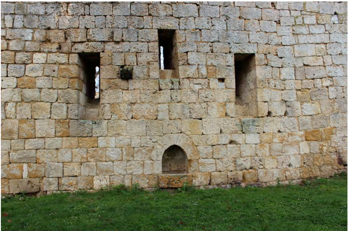
Fig. 6-76 – Larressingle, front nord de l'enceinte (parcelle AB 481), vue interne depuis le sud-est.
