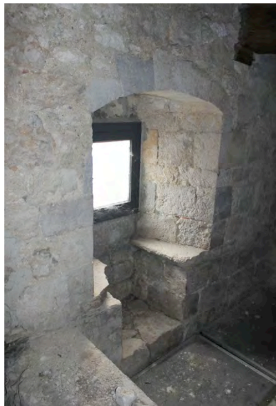
Fig. 9-102 – Montréal, maison « du bailli » (parcelle BM 213), rez-de-chaussée, pièce nord, fenêtre à double coussiège.
