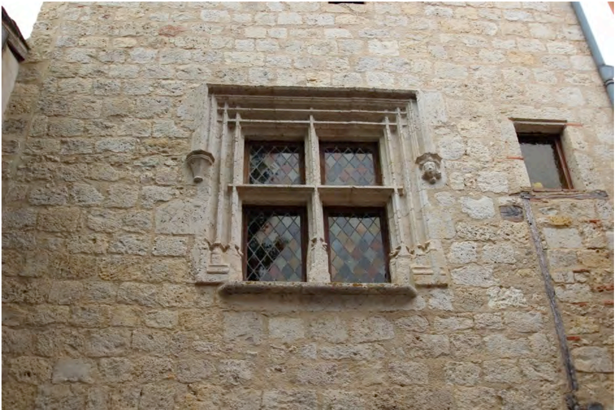
Fig. 9-123 – Montréal, maison (parcelles BM 277 et 278), élévation orientale, détail de la croisée surmontée d'un larmier aux culots sculptés.
