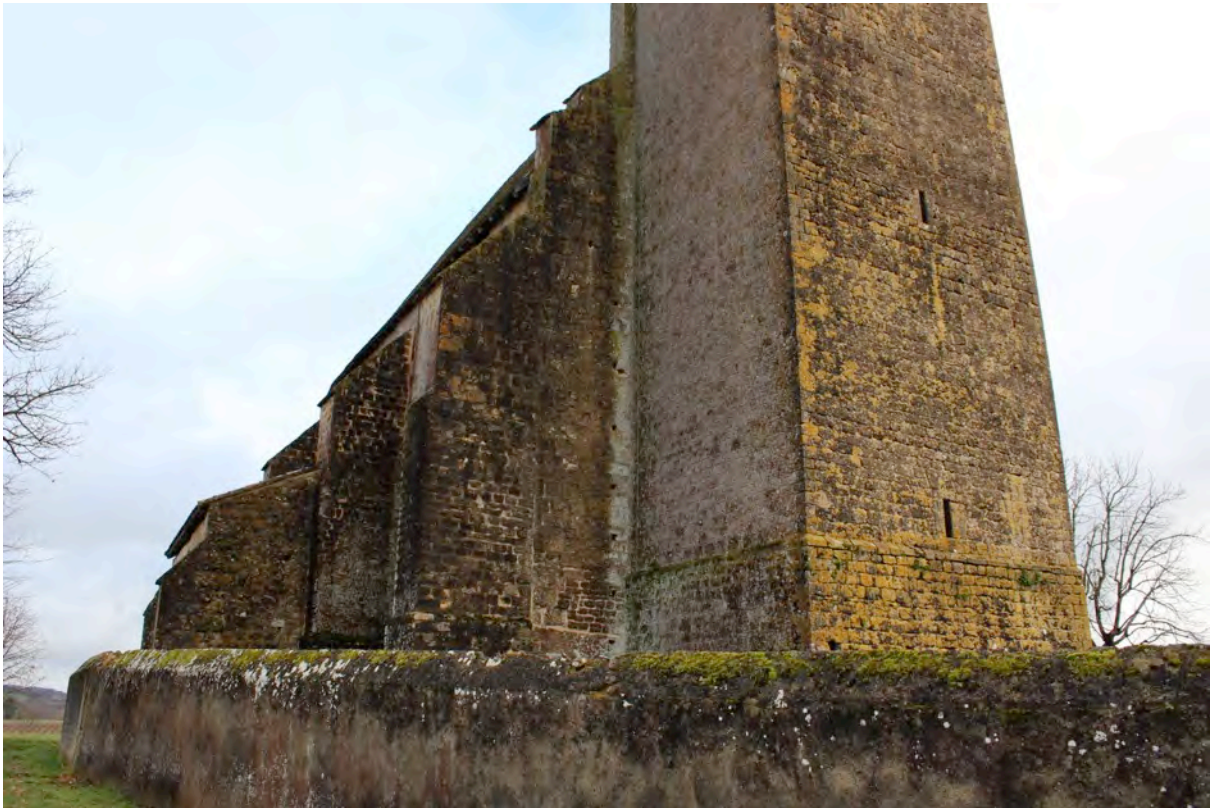
Fig. 8-36 – Sabazan, tour et élévation nord, vue depuis le nord-ouest.
