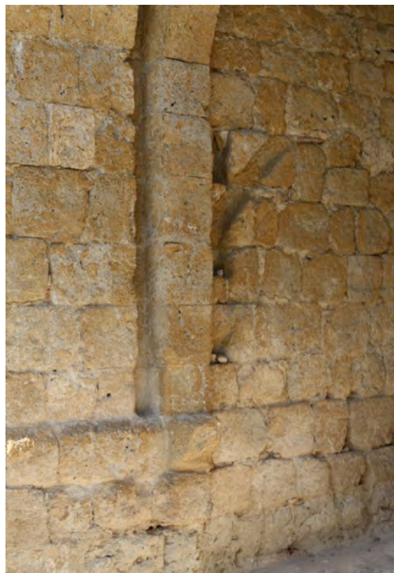
Fig. 6-68 – Terraube, tour-porte, rainure pour faire glisser la barre de fermeture des vantaux en arrière de la herse.
