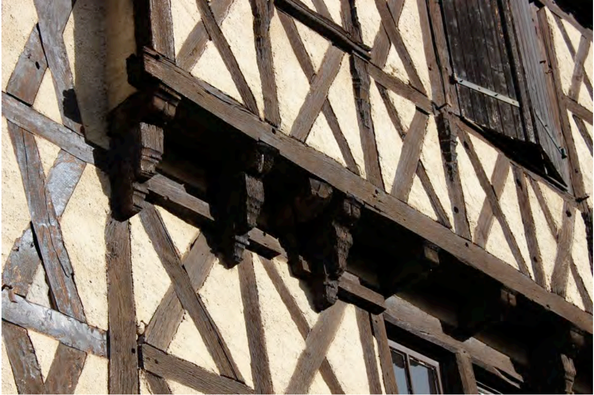
Fig. 9-67 – Pessan (parcelle AD 23), façade sud, détail des consoles du premier étage.
