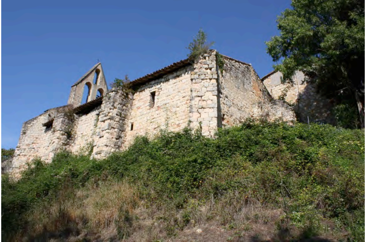
Fig. 6-106 – Le Vieux-Castéra (c. de Castéra-Verduzan), église paroissiale, vue depuis le sud –est.
