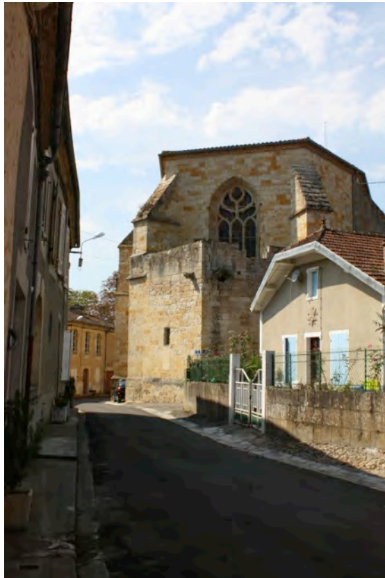
Fig. 9-27 – Saint-Puy, chevet, vue depuis le nord-est.
