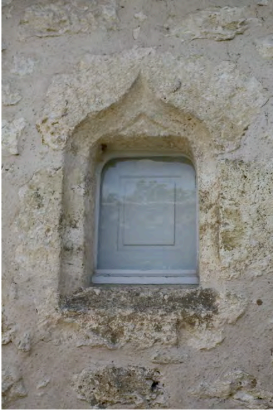
Fig. 9-112 – Avezan, maison (parcelle B 158), petite fenêtre à accolade sculptée.
