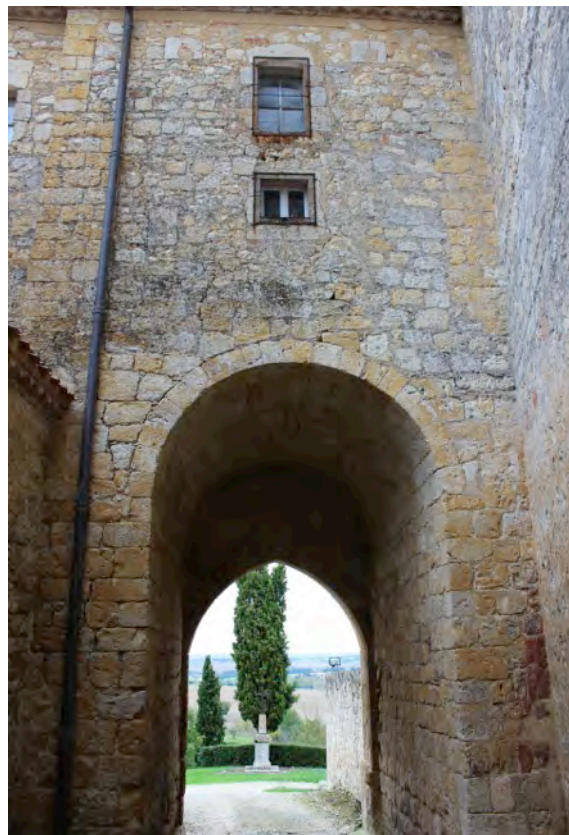
Fig. 6-11 – Terraube, face interne de la tour-porte initialement ouverte à la gorge, vue depuis le nord.
