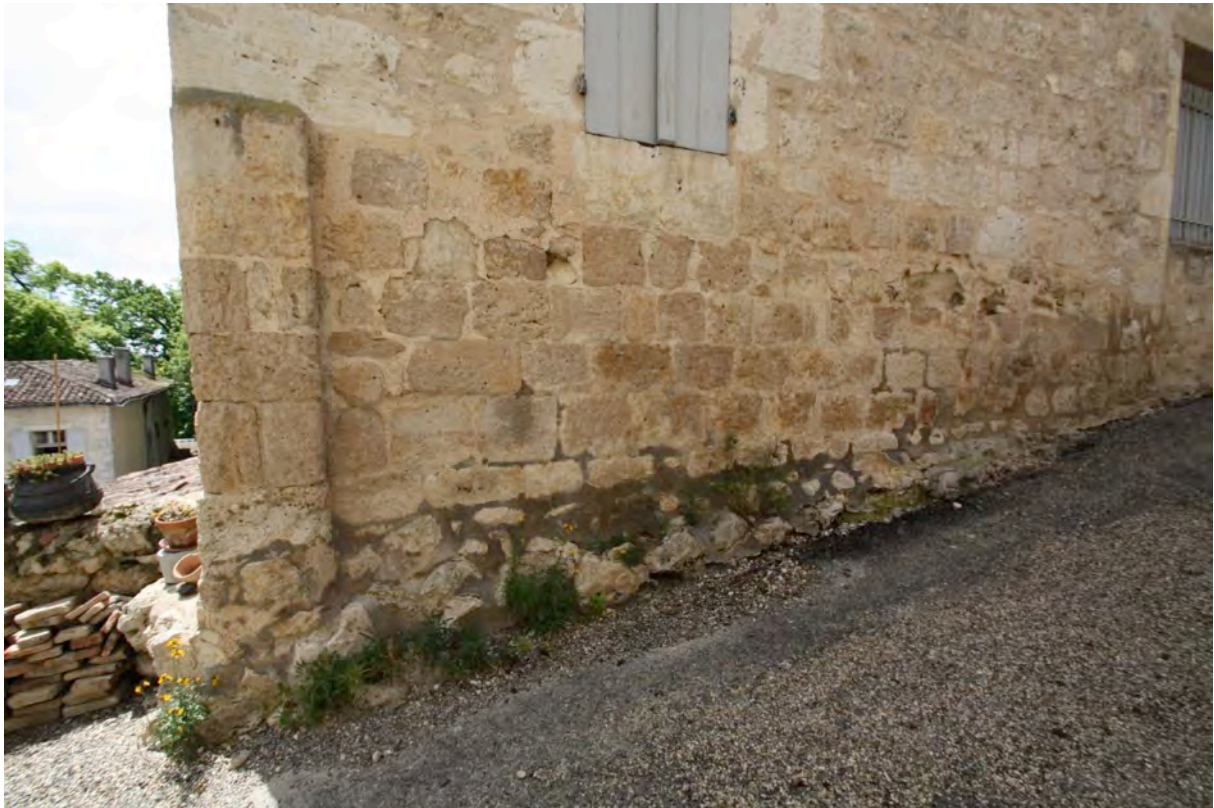
Fig. 8-11 – Plieux, porte sud-est, mur sud du couloir et piédroit de la porte, vue depuis le nord.
