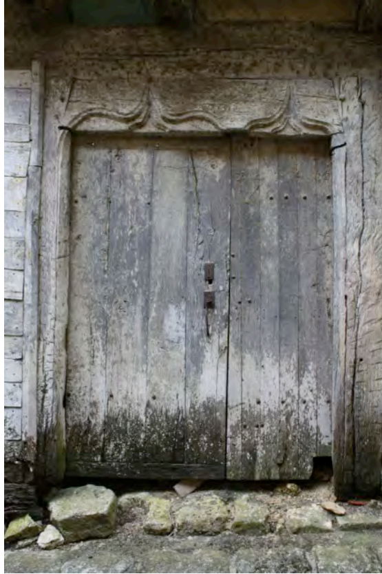
Fig. 9-84 – Gimbrède, maison (parcelle AO 19), détail de l'ouverture mixte.
