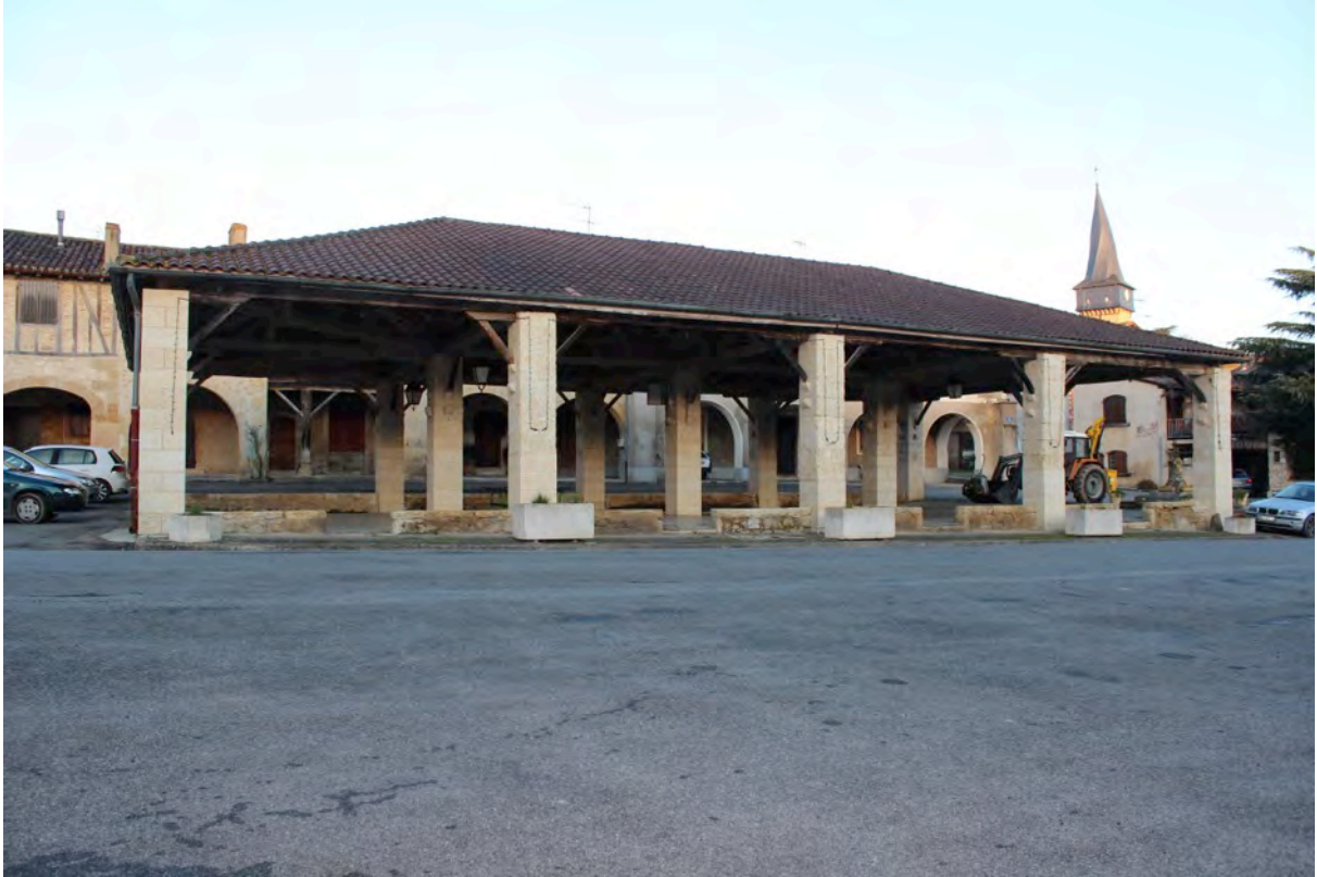
Fig. 6-130 – Barran, vue de la halle depuis le sud-est.
