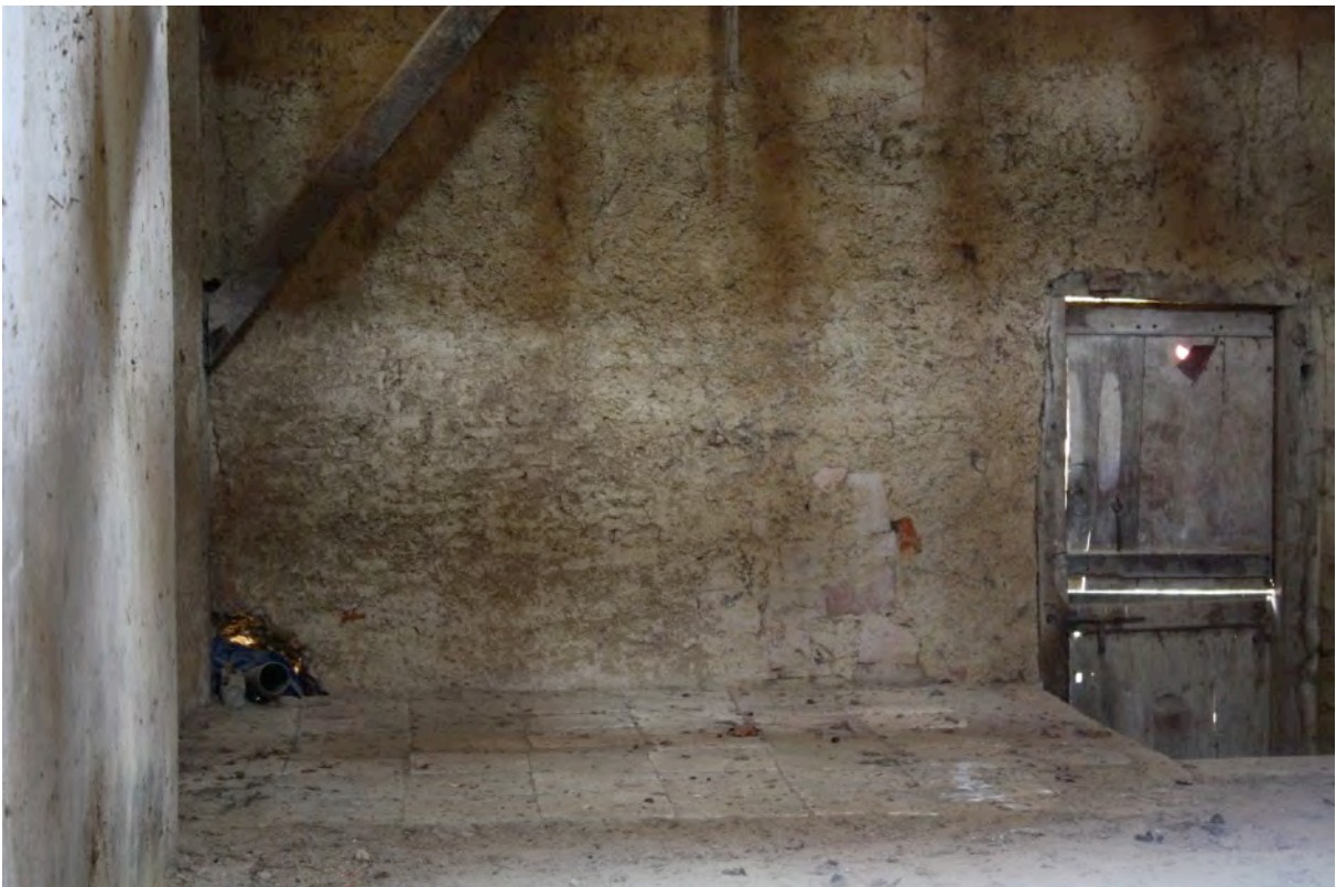
Fig. 8-51 – Villefranche, front oriental de l'enceinte (parcelle B 171), vue interne depuis l'est.
