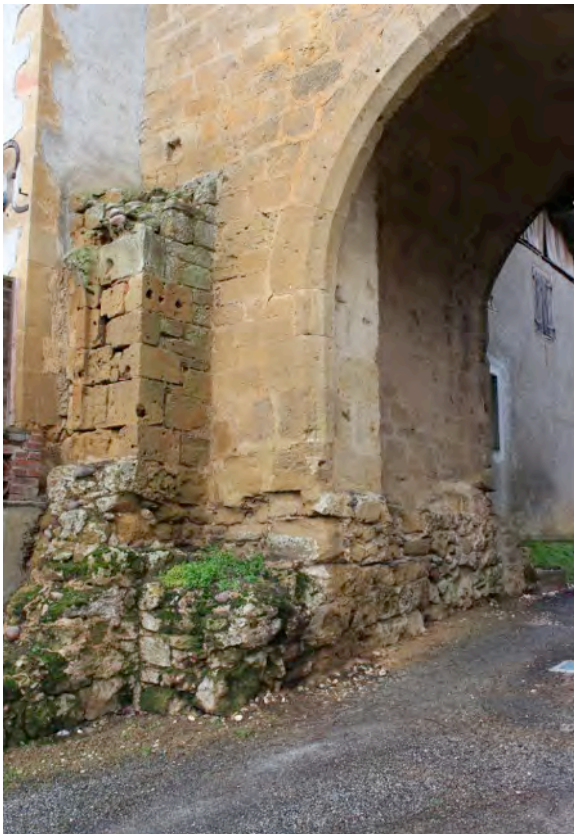
Fig. 8-70 – Mont-d'Astarac, tour-porte, détail des maçonneries ajoutées de part et d'autre de la porte, vue depuis l'est.
