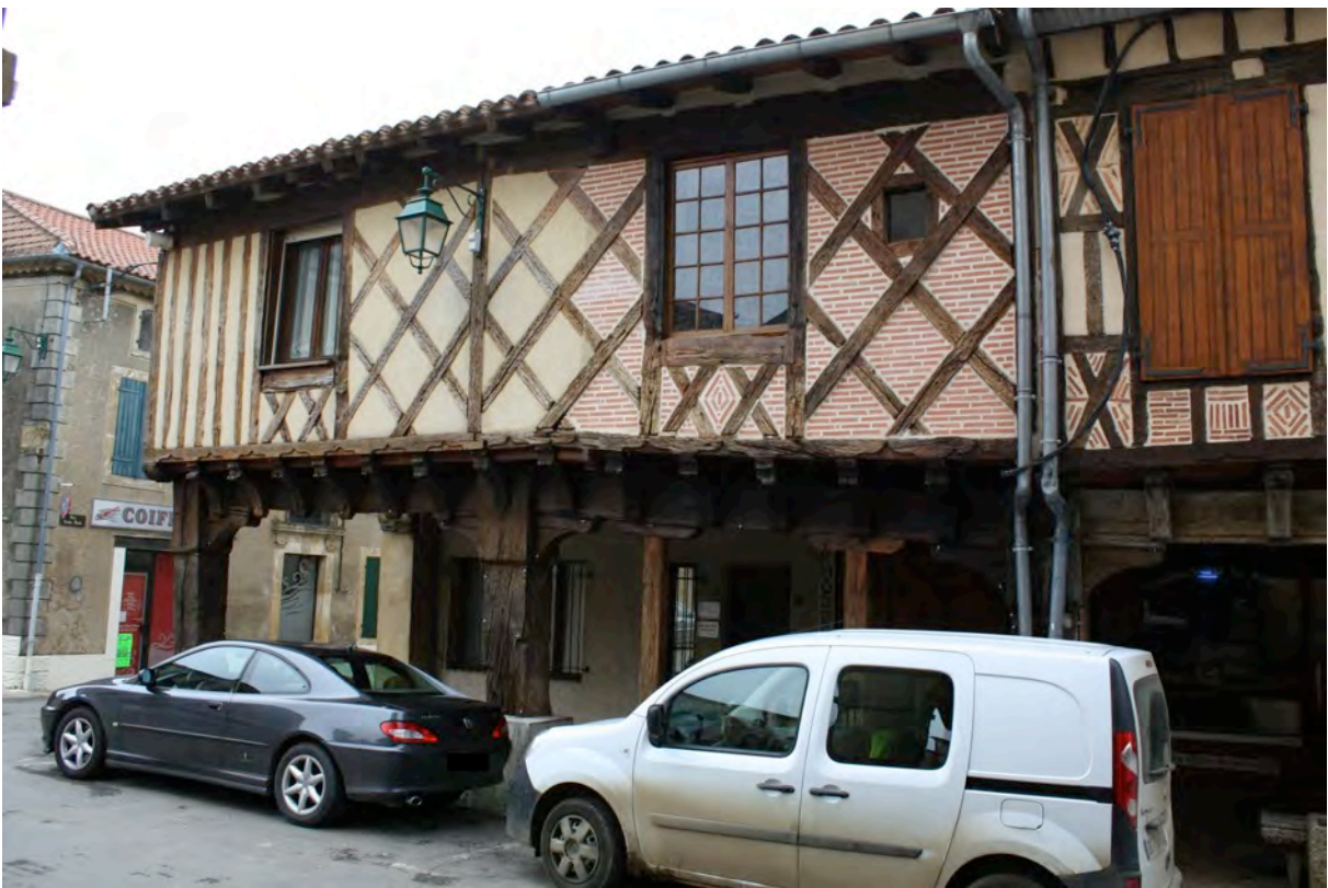
Fig. 9-72 – Miélan, maison (parcelle AD 107), façade ouest, vue depuis le sud-ouest.
