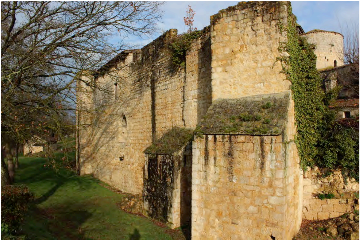
Fig. 6-19 – Larressingle, fossé et front occidental de l'enceinte, vue depuis le sud-est.
