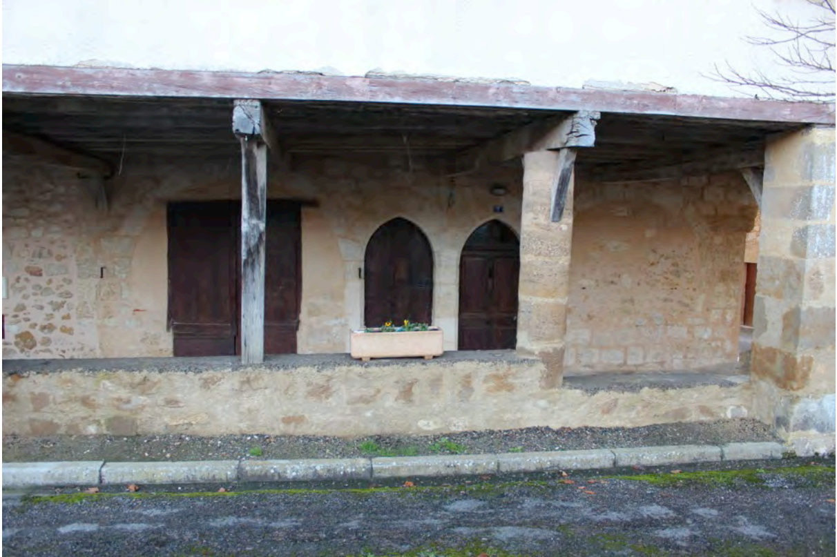
Fig. 4-89 – Barran, maison parcelle BO 241, rez-de-chaussée avec arcades de boutiques, vue depuis l'ouest.
