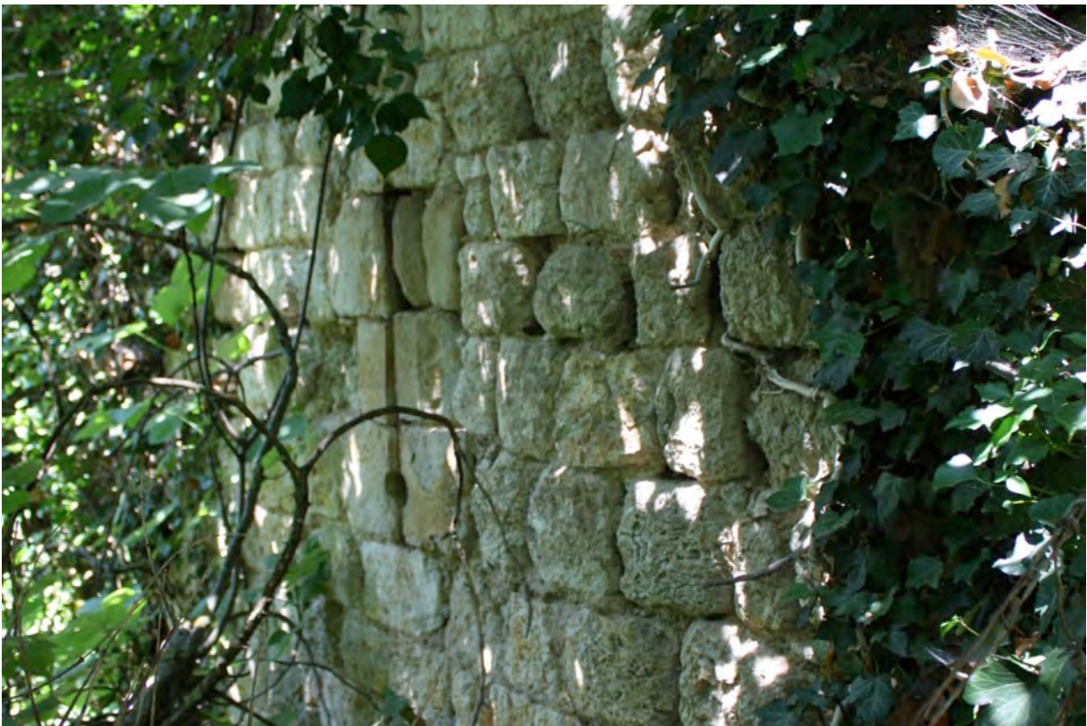
Fig. 8-67 – Castelnau-Barbarens, front sud-est de l'enceinte, détail d'une archère-canonnaire.
