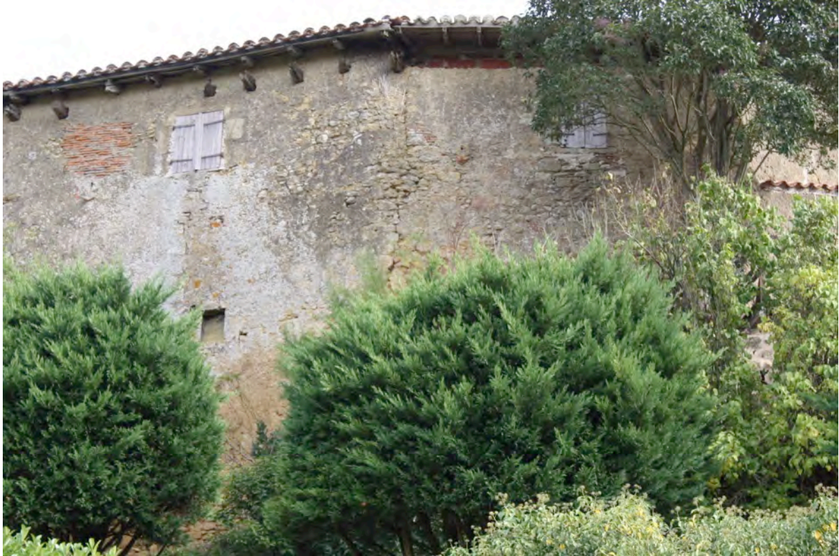
Fig. 6-41 – Montesquiou, front occidental de l'enceinte (parcelle AB 150), vue depuis l'ouest.
