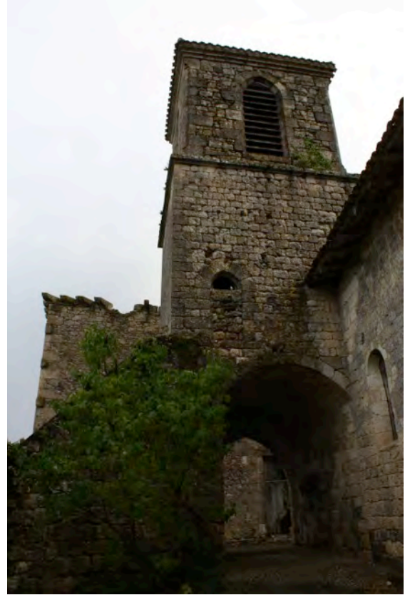
Fig. 6-57 – Lagarde, face interne de la tour-porte, vue depuis l'ouest.
