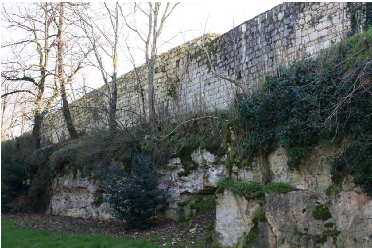
Fig. 6-24 – Monfort, front nord de l'enceinte bâtie sur le rocher retaillé, vue depuis le nord-ouest.
