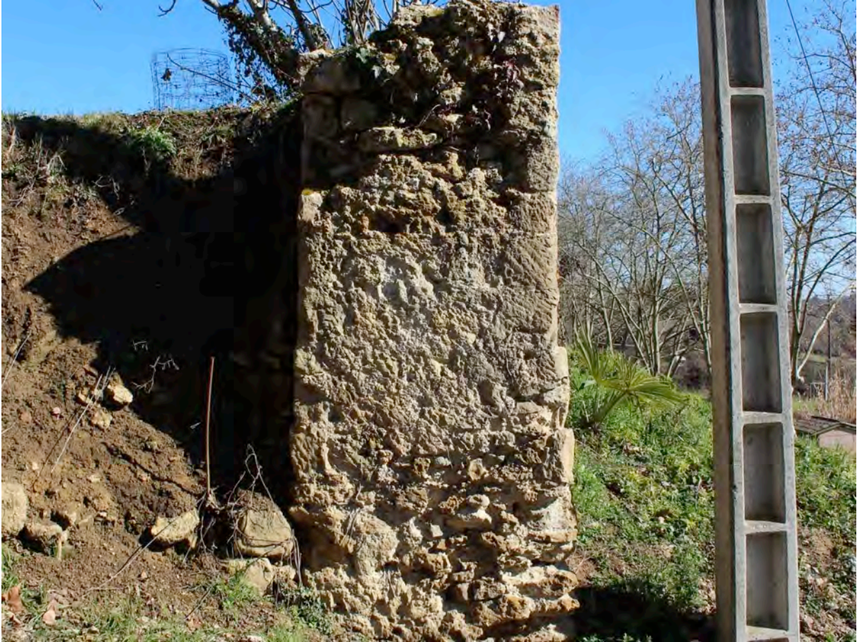
Fig. 8-48 – Bassoues, front sud, mur d'enceinte tronqué, vue depuis l'ouest.
