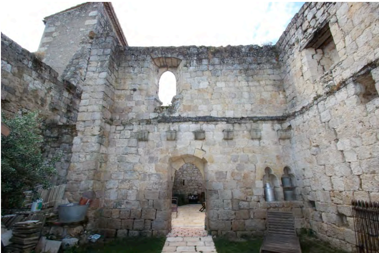
Fig. 4-76 – La Romieu, maison parcelle AB 159, façade en cœur de parcelle, vue interne depuis le nord.
