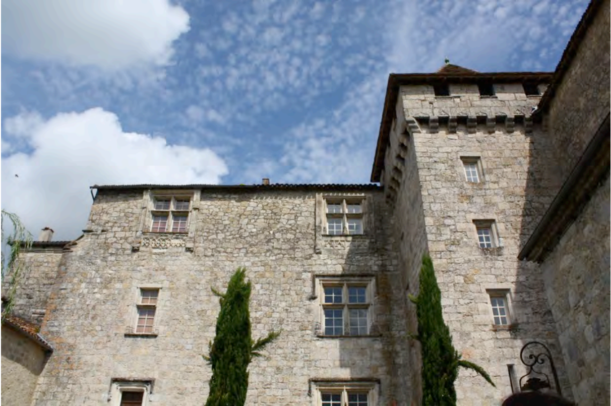
Fig. 9-5 – Fourcès, château, vue depuis l'ouest.
