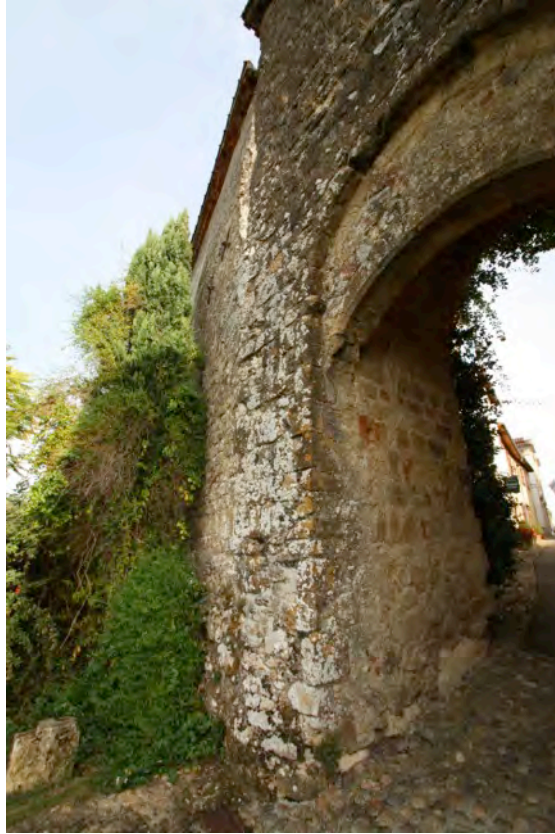
Fig. 6-5 – Montesquiou, détail de la partie gauche de la tour-porte, vue depuis le sud-ouest.
