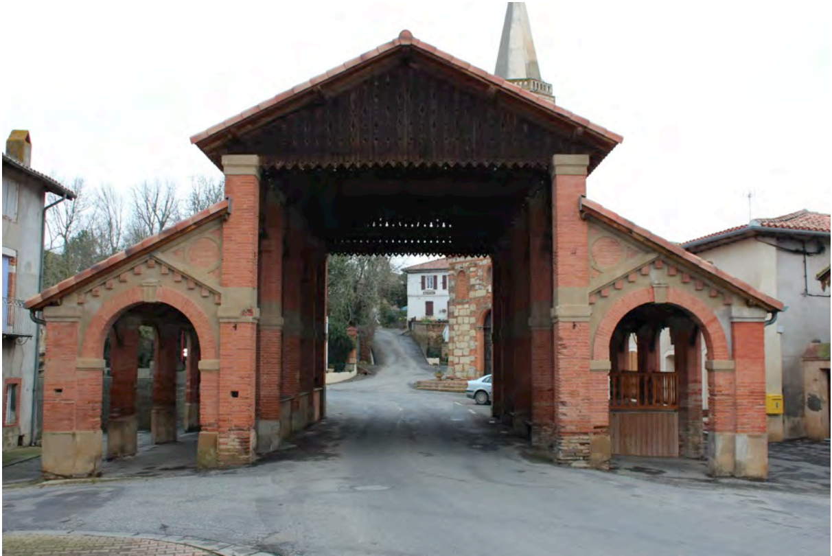
Fig. 6-133 – Montpezat, vue de la halle du XIX e siècle depuis le sud.
