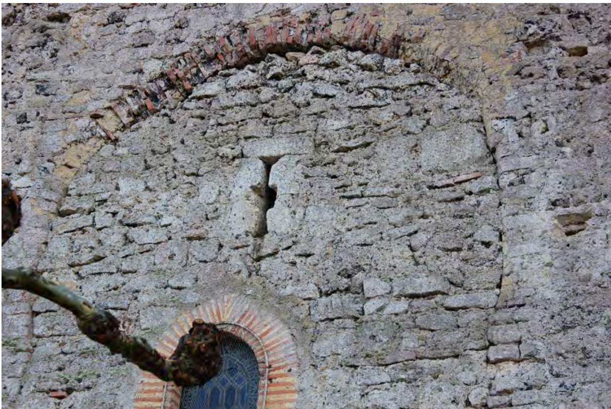
Fig. 8-42 – Mouchès, élévation nord de l'église, détail de l'arbalétrière à croix pattée.
