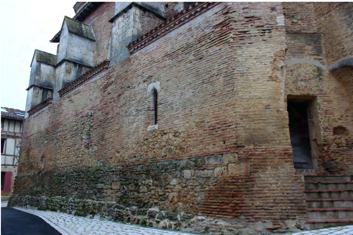
Fig. 9-19 – Cazaubon, église, vue depuis le sud-est.
