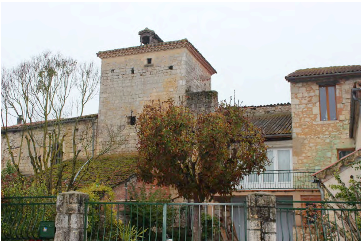
Fig. 6-48 – Cézán, élévation orientale, vue depuis le nord-est.
