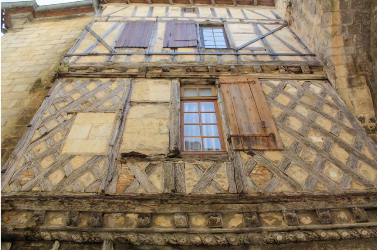
Fig. 9-76 – Saint-Émilion (Gironde), maison rue de la Cadène, vue depuis le nord-ouest.
