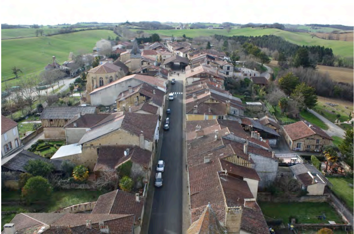
Fig. 3-8 – Bassoues, vue du village depuis la tour, vue depuis l'est.
