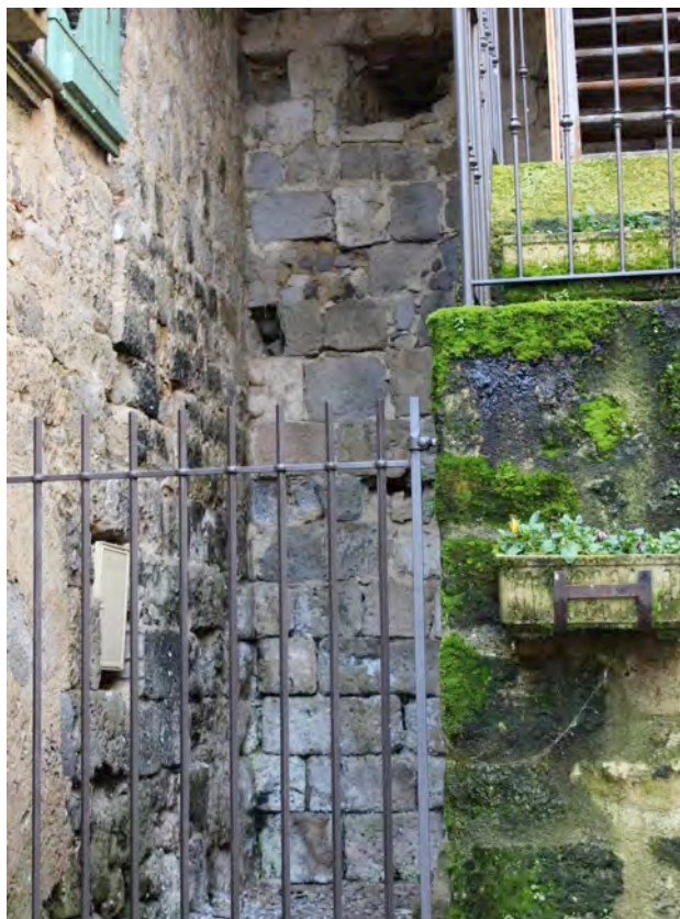
Fig. 4-79 – Fourcès, maison parcelle AD 183, jonction entre le mur d'enceinte et celui de la maison, vue depuis le nord-est.
