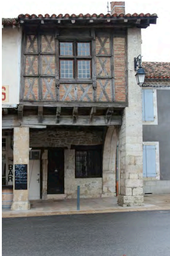
Fig. 9-98 – Solomiac, maison (parcelle B 798), façade nord, vue depuis le nord.
