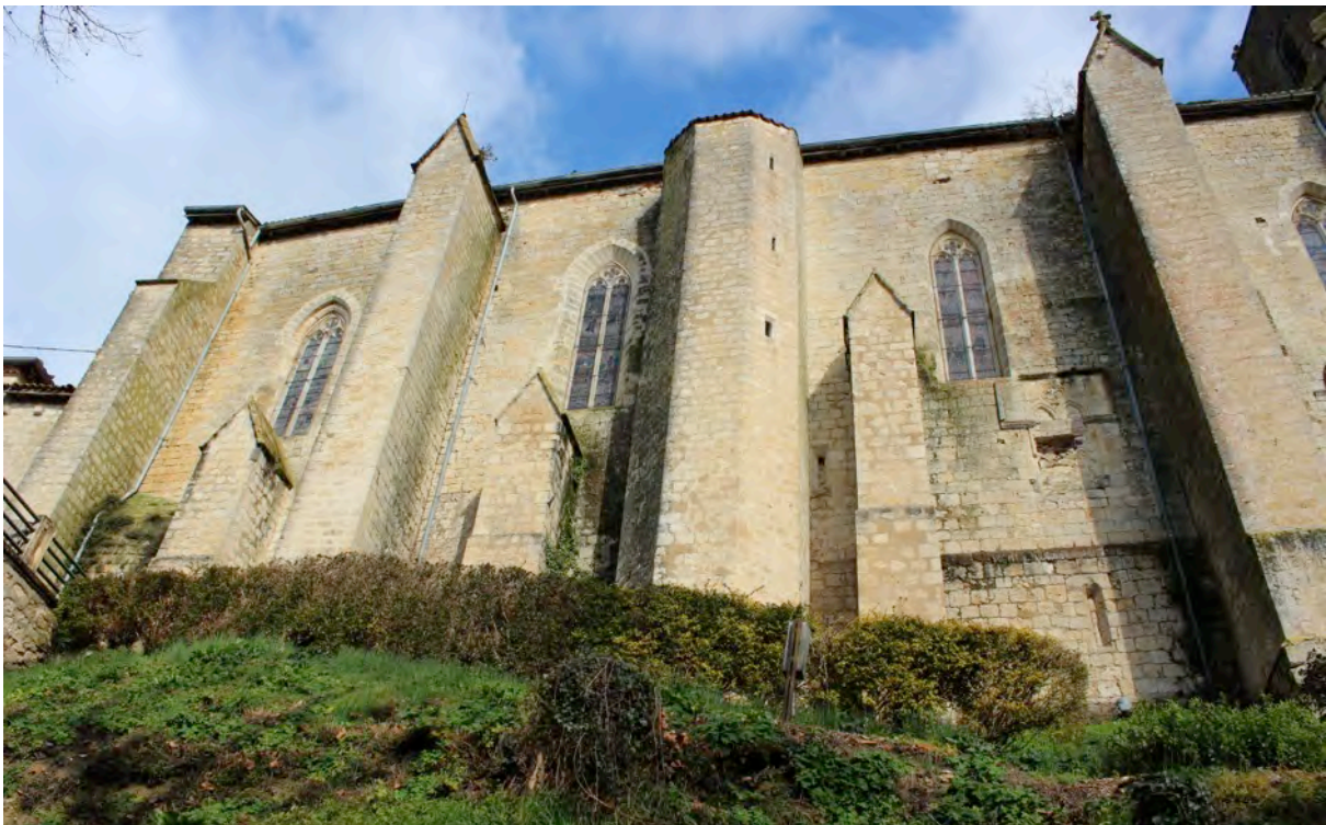
Fig. 6-98 – Montréal, église paroissiale, élévation sud, alternance entre les « petits » contreforts de la première église et les « grands » faisant suite à l'agrandissement.
