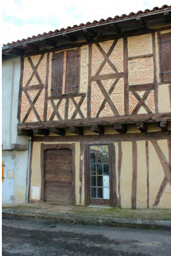
Fig. 9-59 – Castillon-Debats, maison (parcelle C 227), façade nord, vue depuis le nord.
