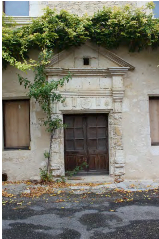
Fig. 9-126 – Monfort, maison (parcelle B 635), élévation orientale, détail de la porte.
