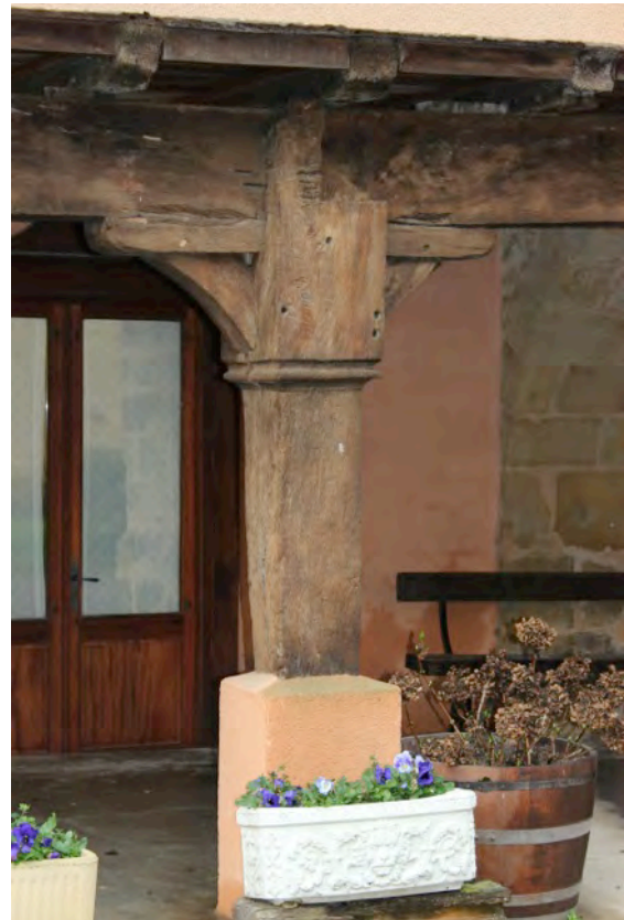
Fig. 9-150 – Lupiac, maison (parcelle AB 141), détail du poteau central, vue depuis le nord.
