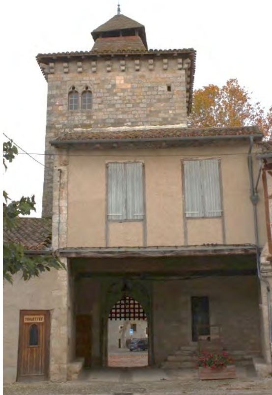
Fig. 8-27 – Sarrant, vue interne de la tour-porte depuis l'ouest.
