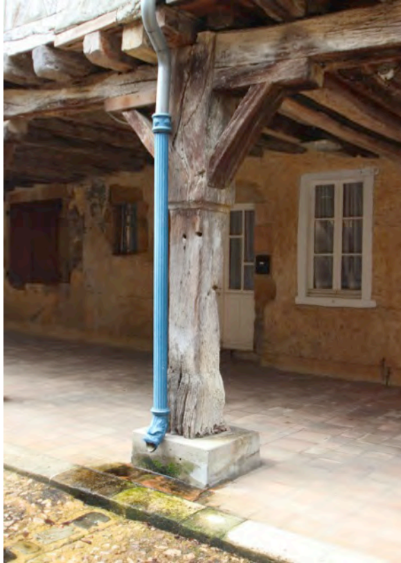
Fig. 9-142 – Tillac, détail d'un poteau sculpté supportant les couverts de deux maisons (parcelles D 991 et 992), vue depuis le sud-est.
