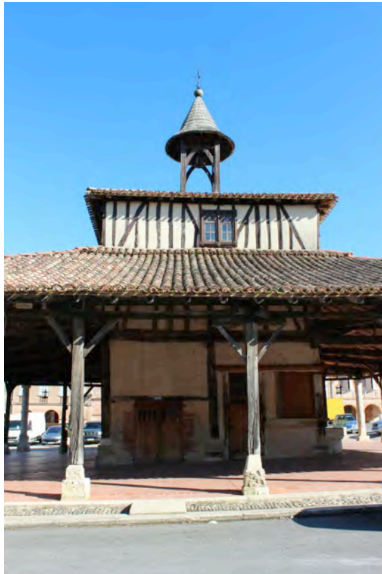
Fig. 6-135 – Cologne, partie centrale de la halle, vue depuis l'ouest.
