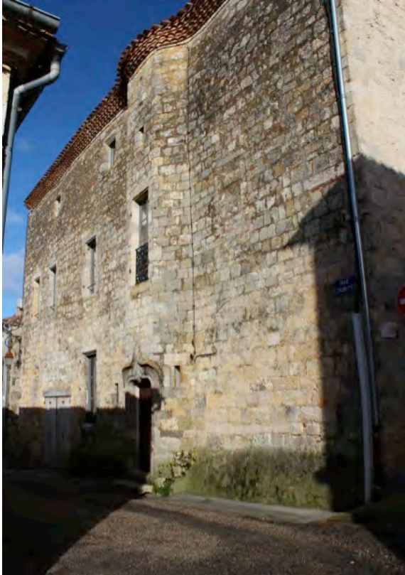
Fig. 9-104 – Montréal, maison « du bailli » (parcelle BM 213), élévation occidentale, vue depuis le sud-ouest.
