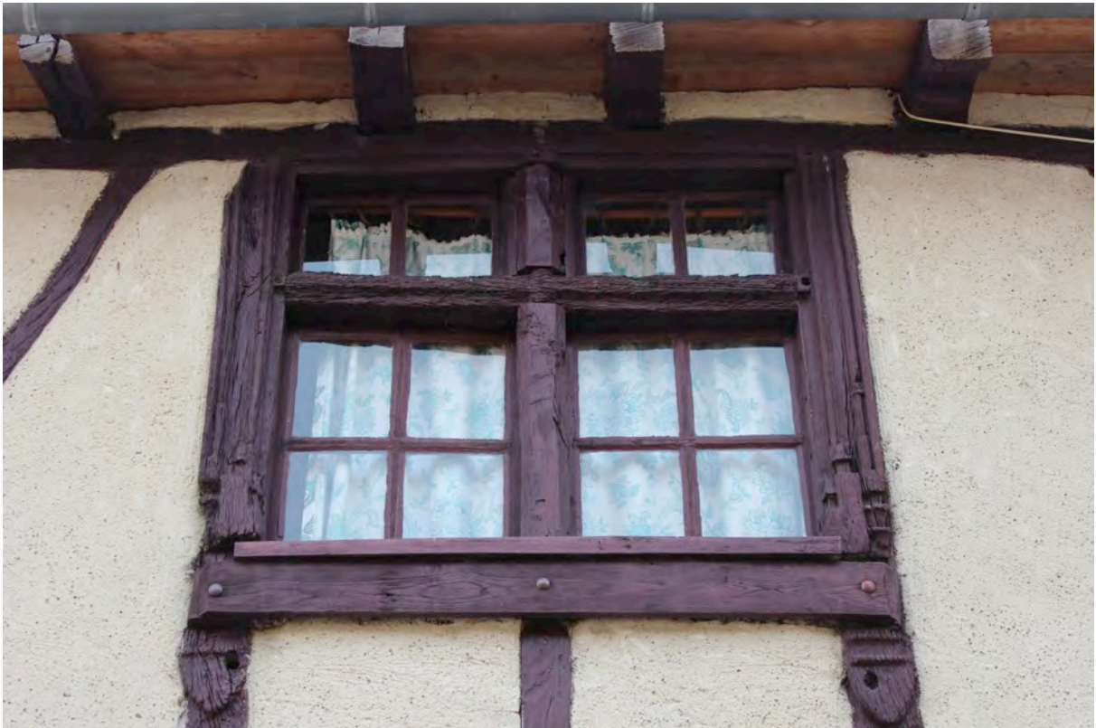
Fig. 9-87 – Castelnau-d'Arbieu, maison (parcelle D 374), détail de la croisée de l'étage.
