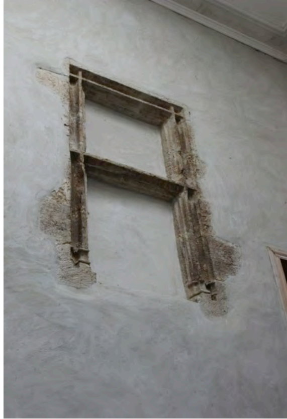
Fig. 9-121 – Montréal, maison (parcelle BM 280), cage d'escalier, demi-croisées à simples baguettes croisées ornées de doubles cavets et de bases prismatiques.
