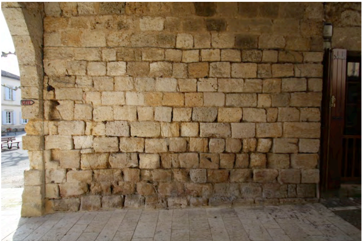
Fig. 6-64 – Saint-Antoine, couloir de la tour-porte, détail de l'encoche.
