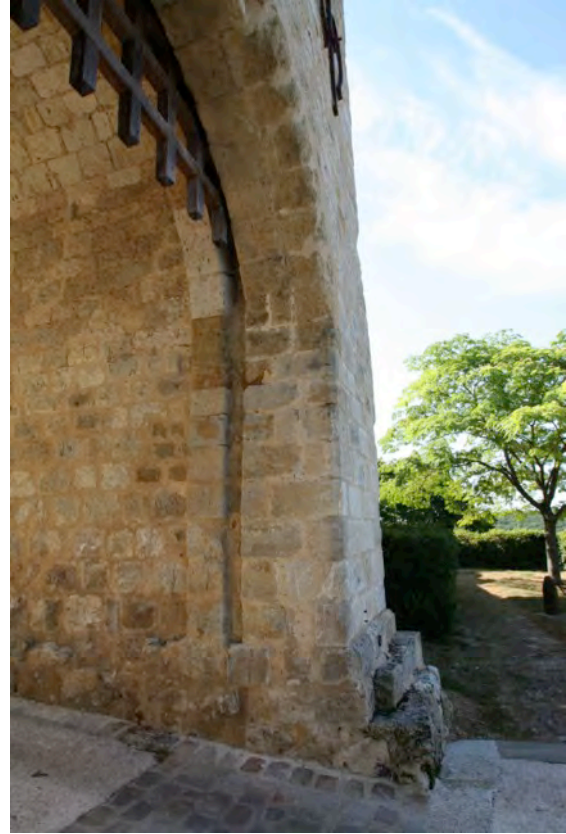
Fig. 8-73 – Montaut-les-Créneaux, tour-porte, détail du passage de herse, vue depuis le nord.
