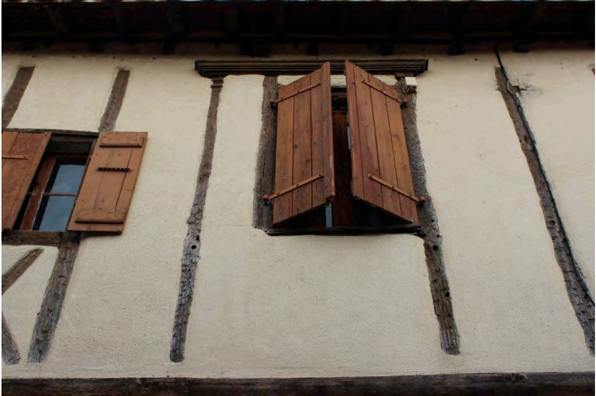
Fig. 9-129 – Montestruc, maison (parcelle AA 43), élévation sud, détail des vestiges d'une croisée en bois.
