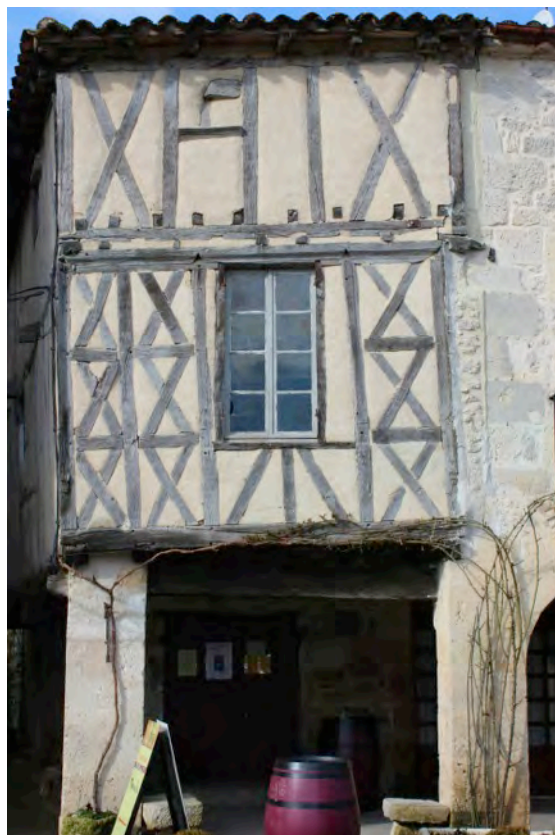
Fig. 9-89 – Fourcès, maison (parcelle AD 176), façade orientale.
