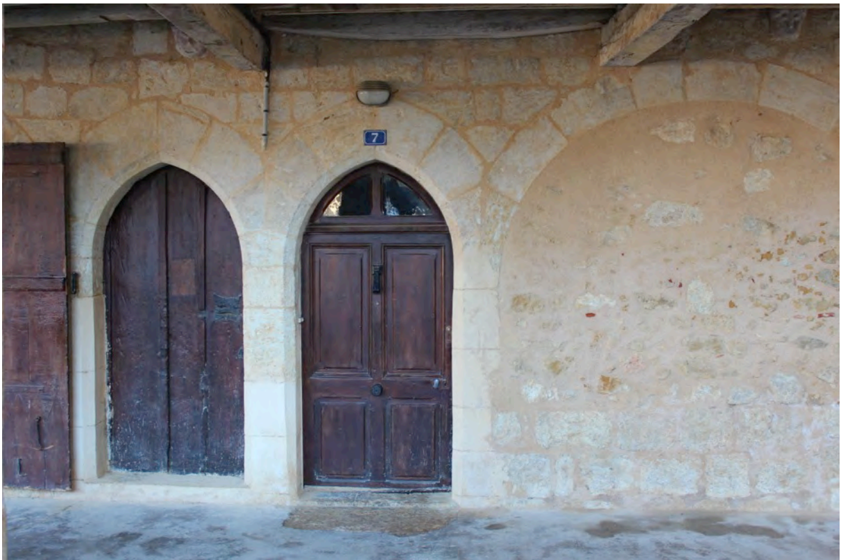
Fig. 4-90 – Barran, maison parcelle BO 241, rez-de-chaussée détail des portes d'entrée de l'habitation et d'une arcade de boutique, vue depuis le sud-ouest.
