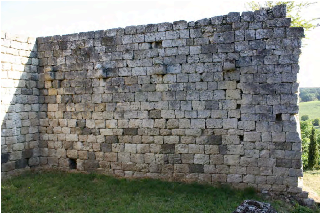
Fig. 6-28 – Lagarde, angle nord-ouest de l'enceinte (parcelle AN 43), vue intérieure depuis le sud-est.
