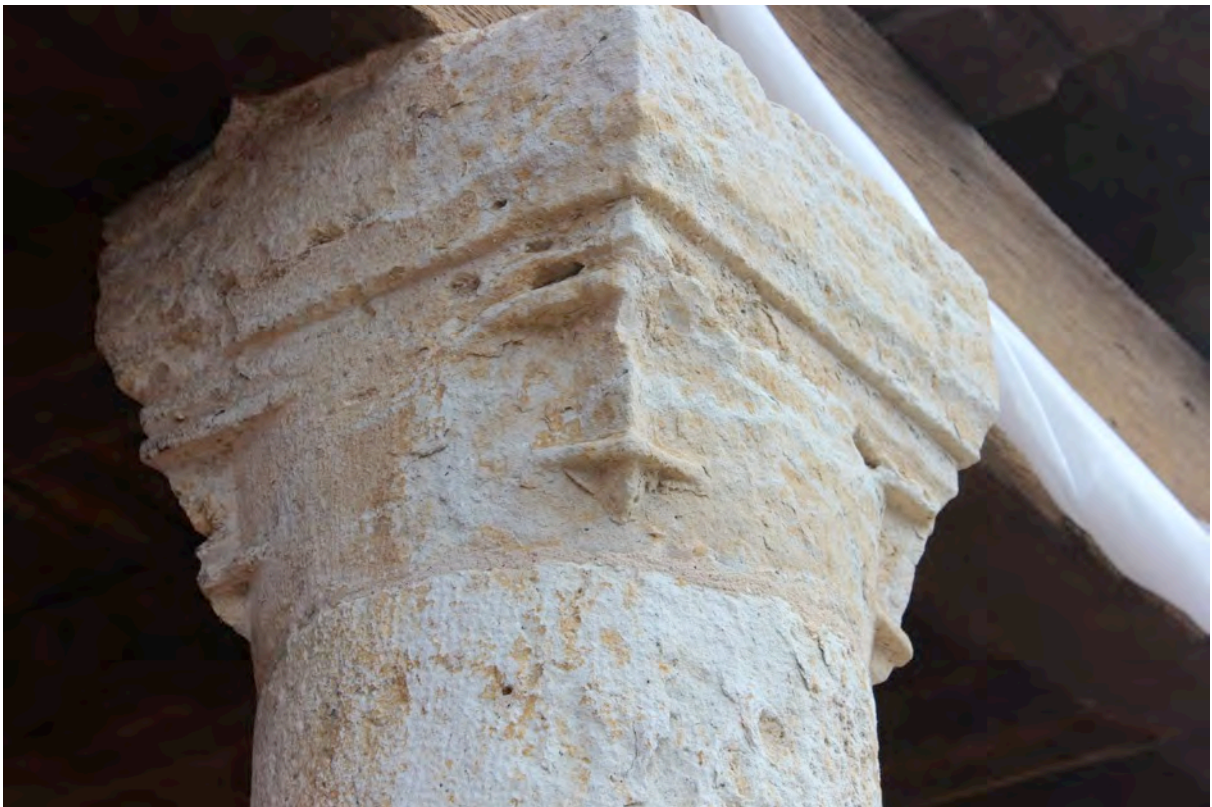
Fig. 9-141 – Cologne, maison (parcelle AA 69), façade sud, détail du chapiteau sculpté d'une des colonnes portant le couvert.
