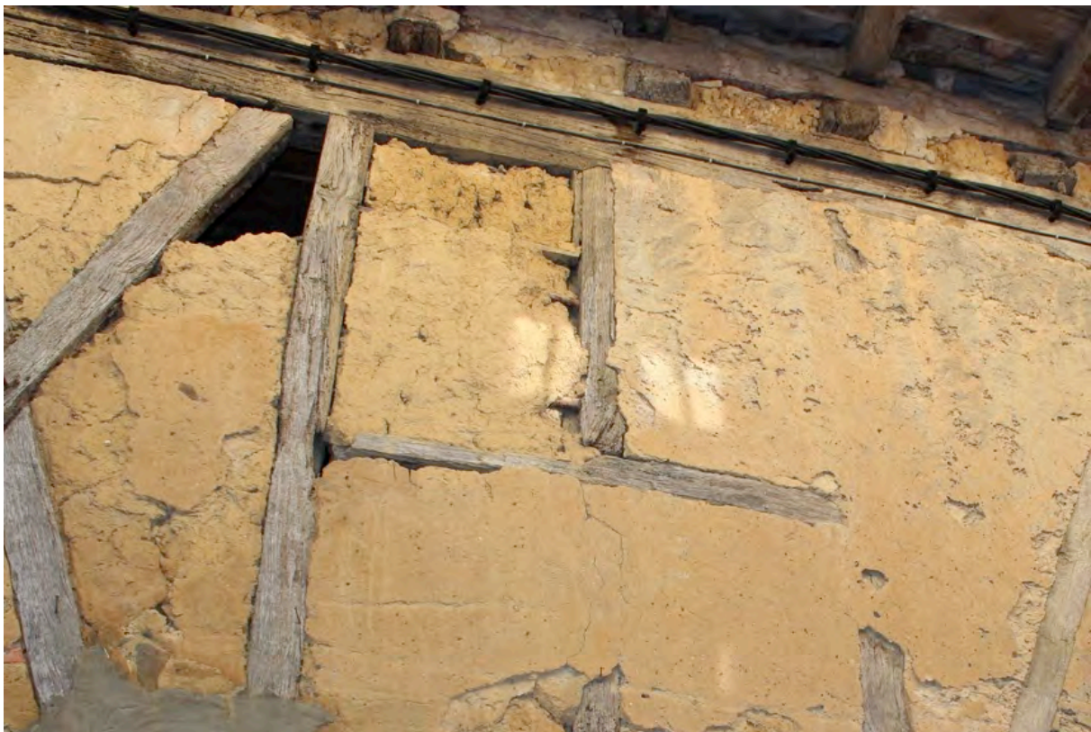
Fig. 9-54 – Cazaubon, maison (parcelle AV 168), façade ouest, détail de la fenêtre à meneau du premier étage.
