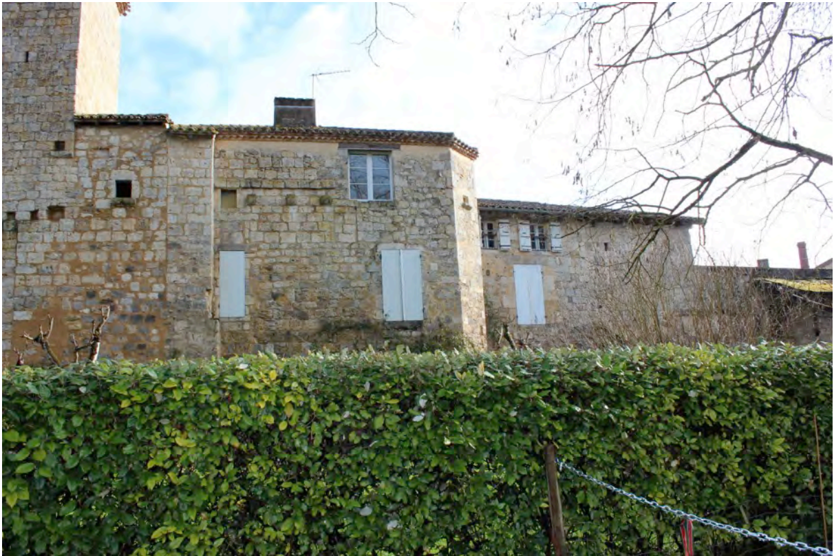
Fig. 6-39 – Fourcès, front occidental de l'enceinte (parcelle AD 183), vue depuis l'ouest.
