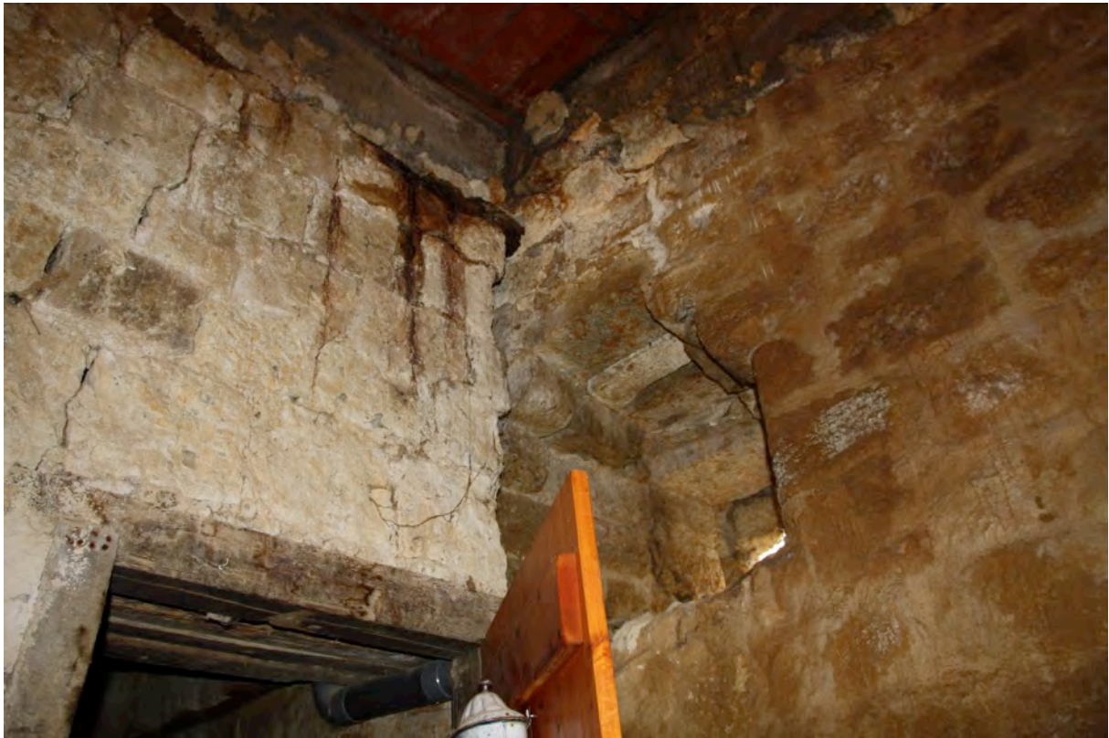
Fig. 6-33 – Castelnaud-Barbarens, mur médiéval s'appuyant contre le mur d'enceinte sur le front sud (parcelle B 254).
