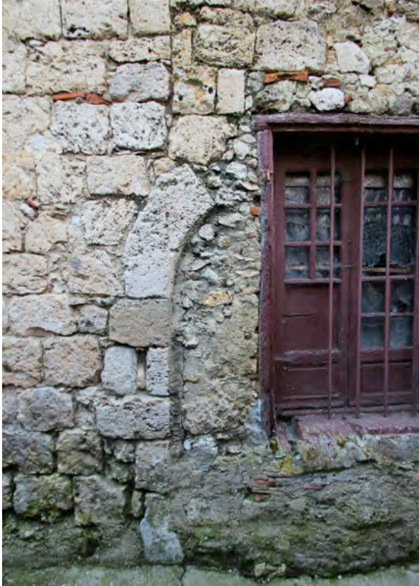
Fig. 7-20 – Montréal, maison parcelle BM 222, porte en arc brisé insérée dans la chaîne d'angle de la maison voisine, vue depuis le nord.
