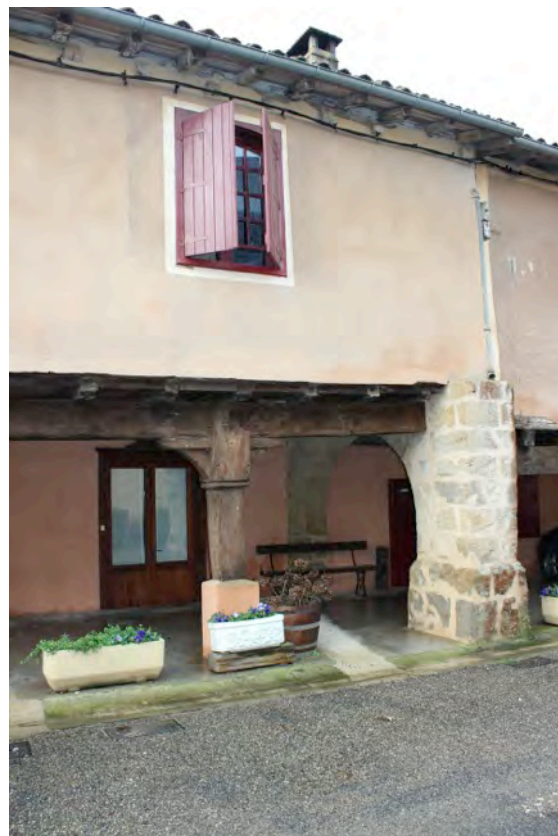
Fig. 9-138 – Lupiac, maison (parcelle AB 141), façade nord, vue depuis le nord-est.
