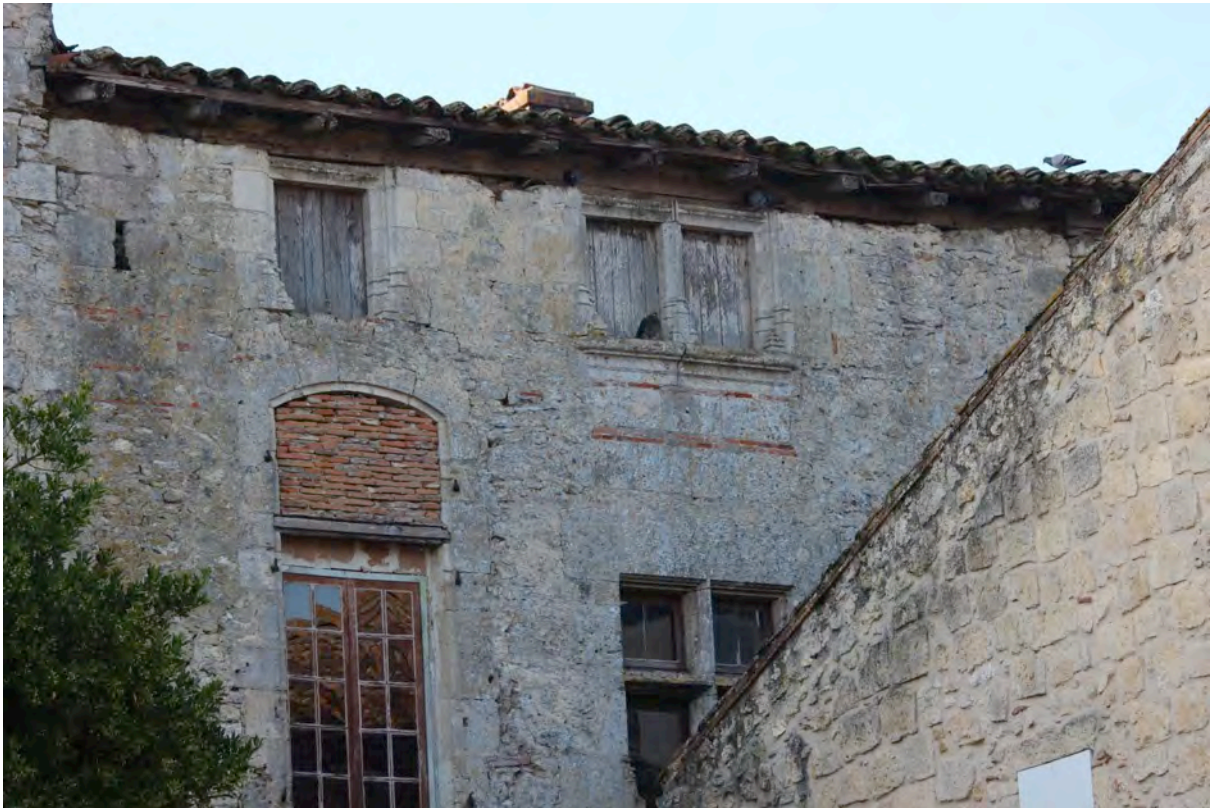
Fig. 9-115 – Montréal, maison (parcelle B 222), élévation nord, détail des croisées et de la demi-croisée aménagées à la fin du Moyen Âge.
