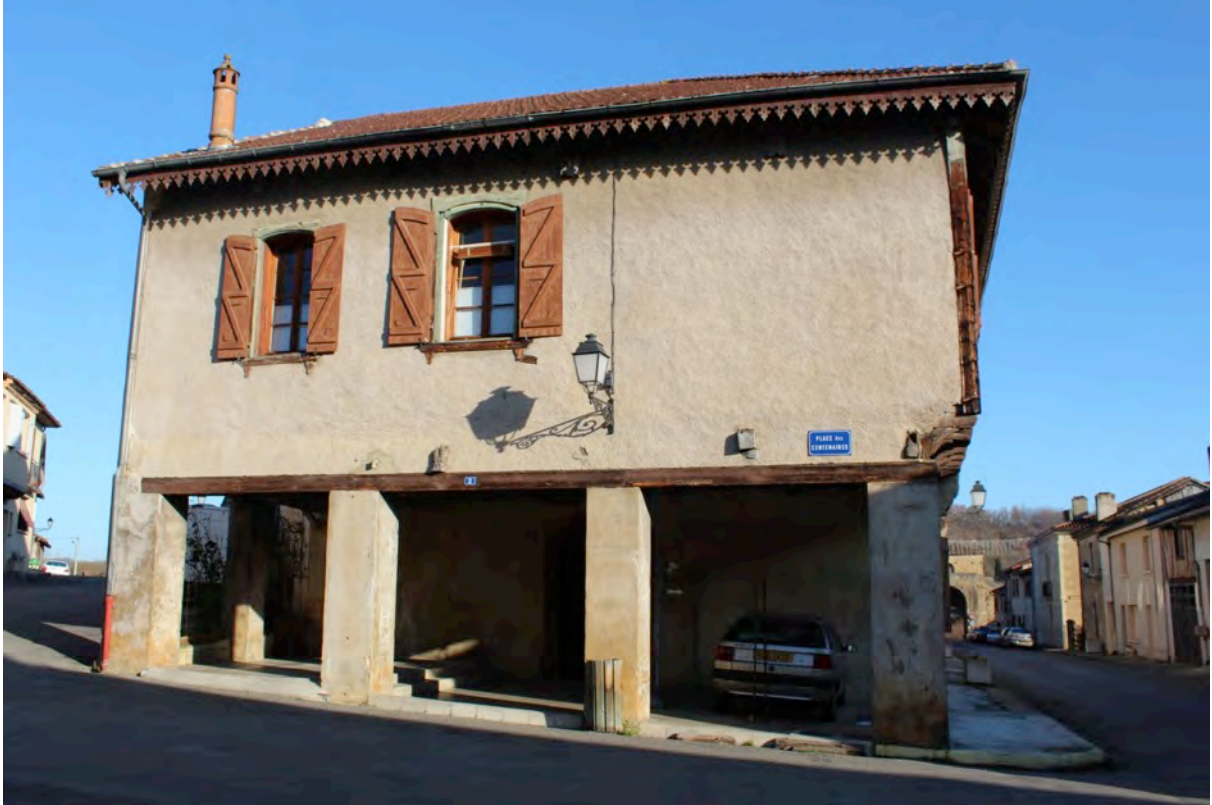
Fig. 5-34 – Barran, place à la jonction des deux parcelaires, vue depuis le sud.
