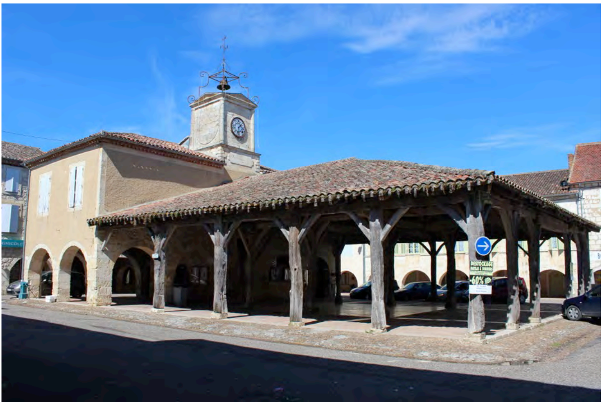
Fig. 6-140 – Saint-Clar, vue de la mairie-halle depuis le sud-est.
