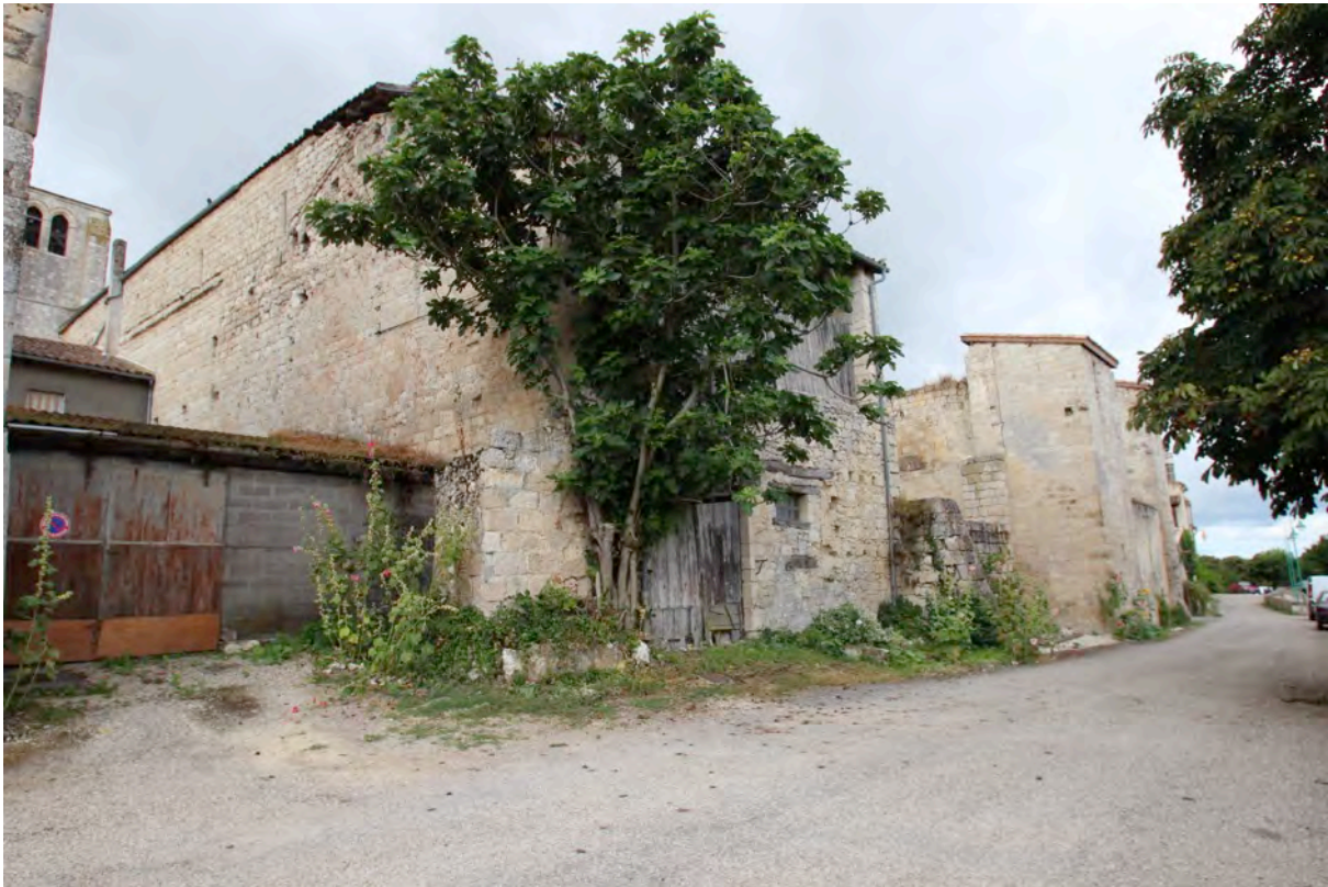
Fig. 6-31 – La Romieu, front nord de l'enceinte (parcelles AB 157, 364 et 365), vue depuis le nord-est.
