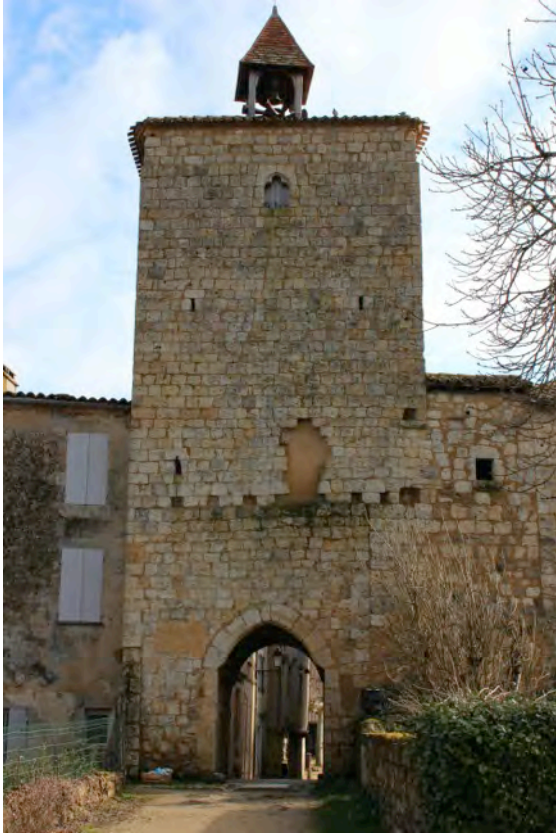
Fig. 6-56 – Fourcès, face externe de la tour-porte, vue depuis l'ouest.
