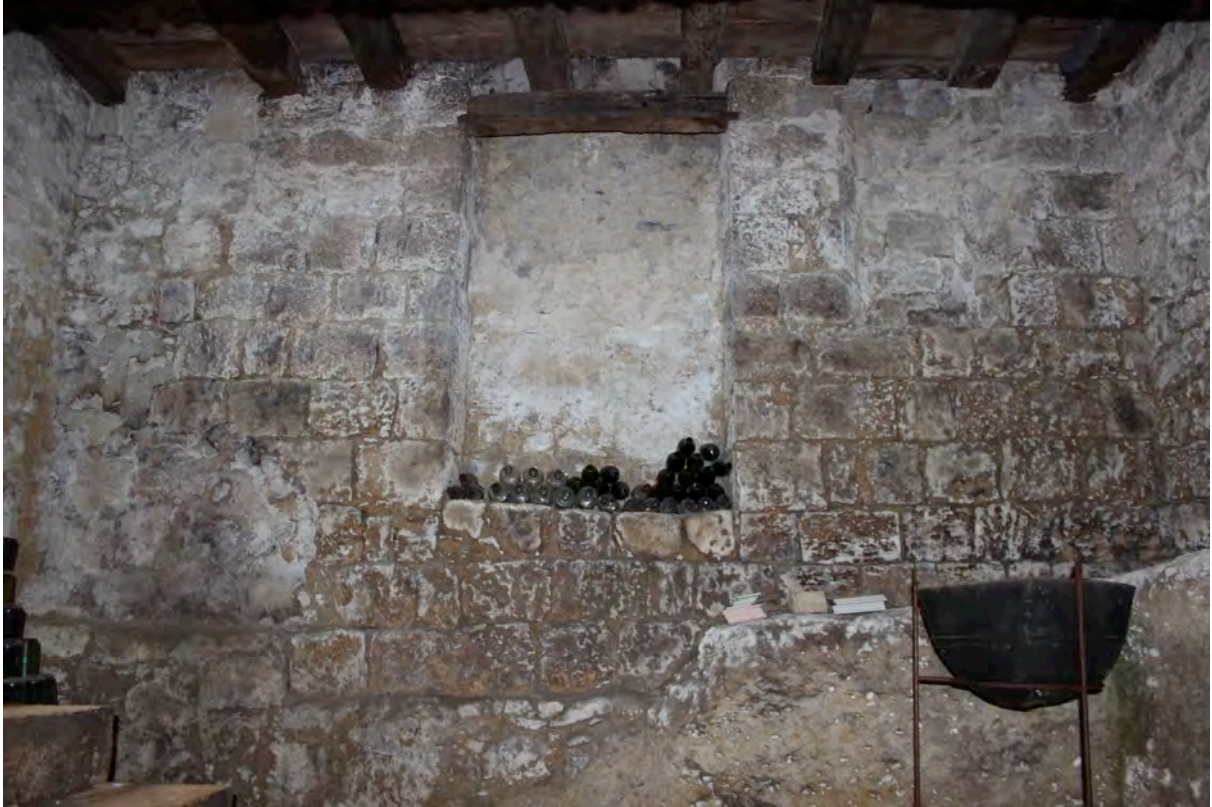
Fig. 4-84 – Montréal, maison parcelle BM 223, cave, vue intérieure de la porte donnant sur la ruelle et du mur maçonné bâti directement sur le rocher, vue depuis le sud.
