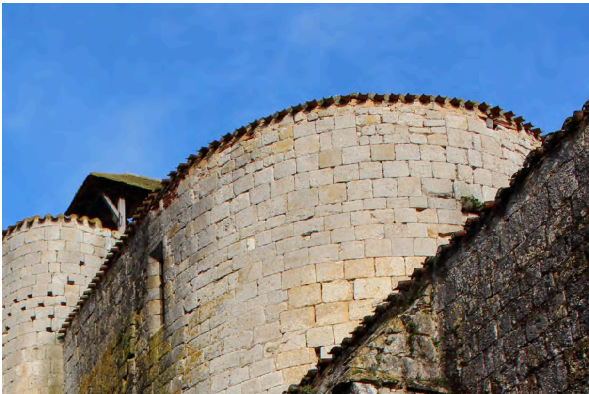
Fig. 6-117 – Larressingle, surélévation crénelée d'une partie de l'église paroissiale.
