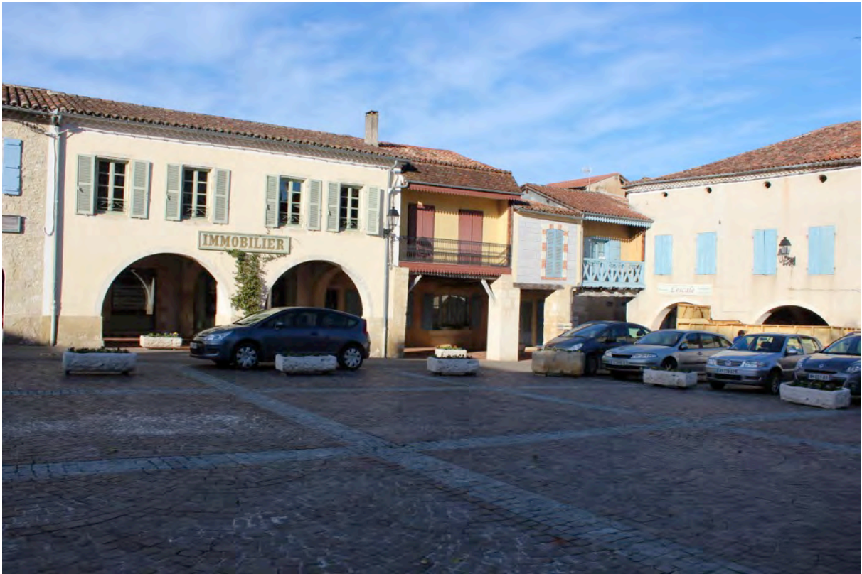
Fig. 6-125 – Montréal, vue de l'angle nord-ouest de la place depuis le sud-est.
