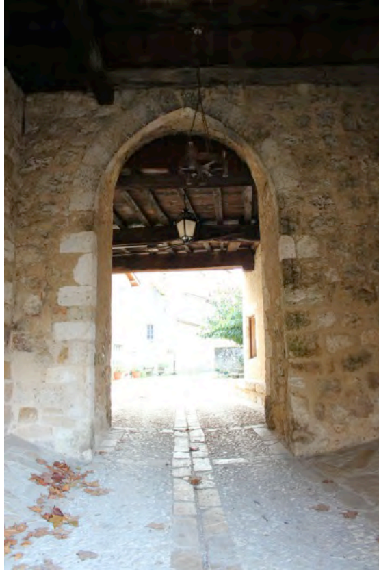
Fig. 8-26 – Sarrant, porte interne, vue depuis l'est.
