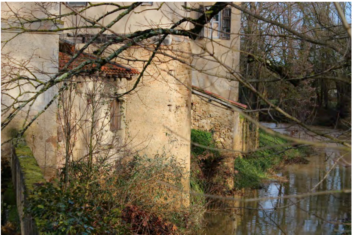
Fig. 6-22 – L'Isle-de-Noé, angle sud-est de l'enceinte, vue depuis le sud.
