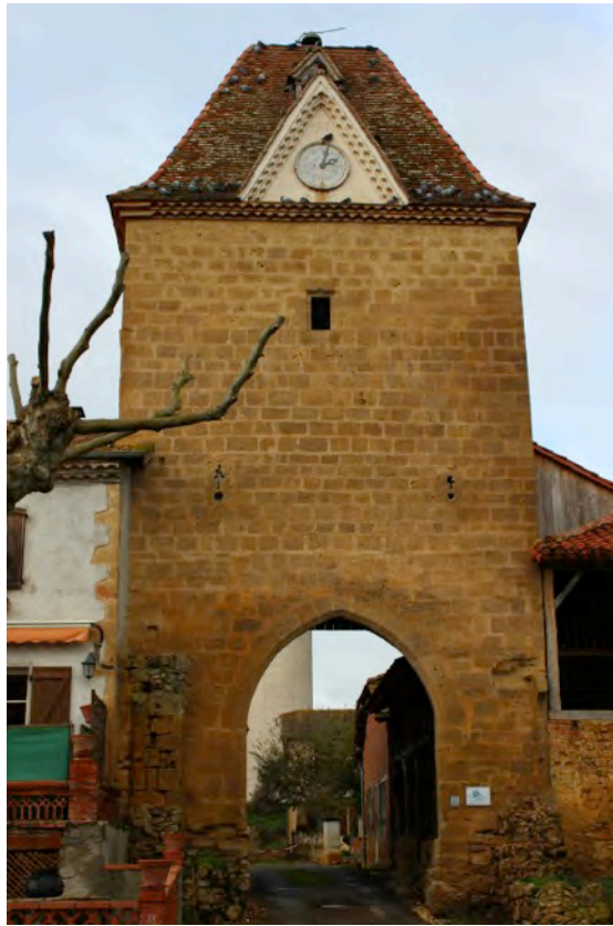
Fig. 8-68 – Mont-d'Astarac, tour-porte, vue depuis l'est.
