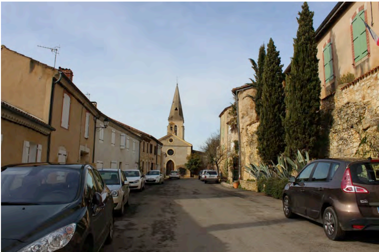
Fig. 5-16 – Ordan-Larroque, rue sud du faubourg, vue depuis le sud-est.
