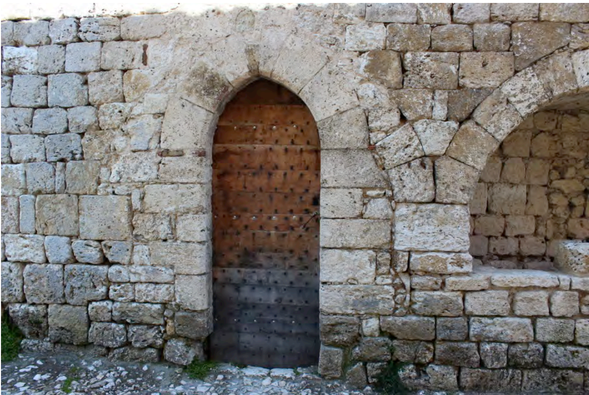
Fig. 7-28 – Saint-Clar, mur sud de la « vieille église », vue d'une porte en arc brisé recoupant un enfeu préexistant, vue depuis le sud.
