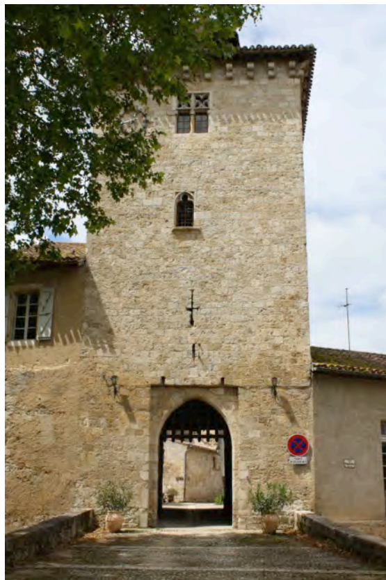
Fig. 8-29 – Sarrant, face externe de la tour-porte, vue depuis l’est.
