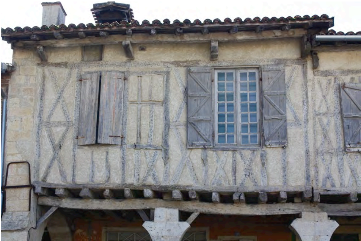
Fig. 9-61 – Monfort, maison (parcelle B 725), façade nord-est, vue depuis le nord-est.
