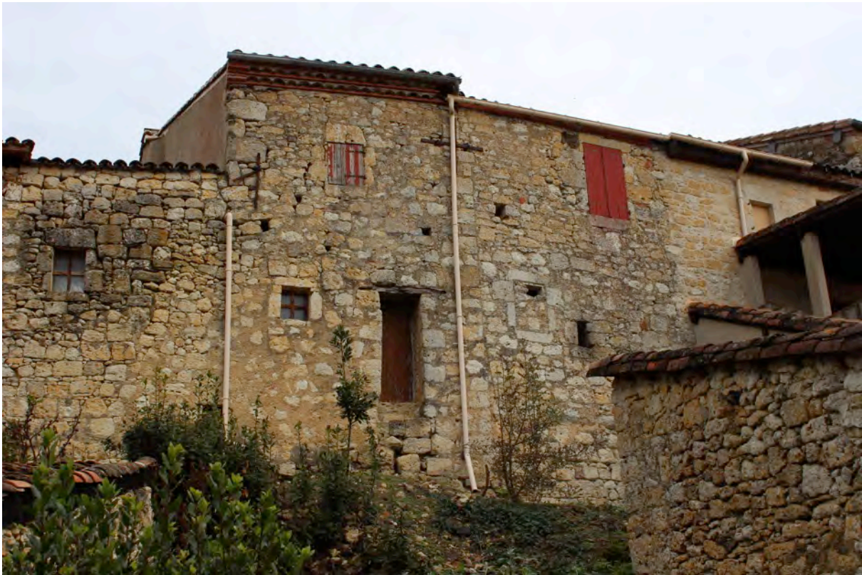
Fig. 6-27 – Castelnaud-d'Arbieu, front occidental de l'enceinte formé par le mur arrière des maisons (parcelle D 376), vue depuis l'ouest.
