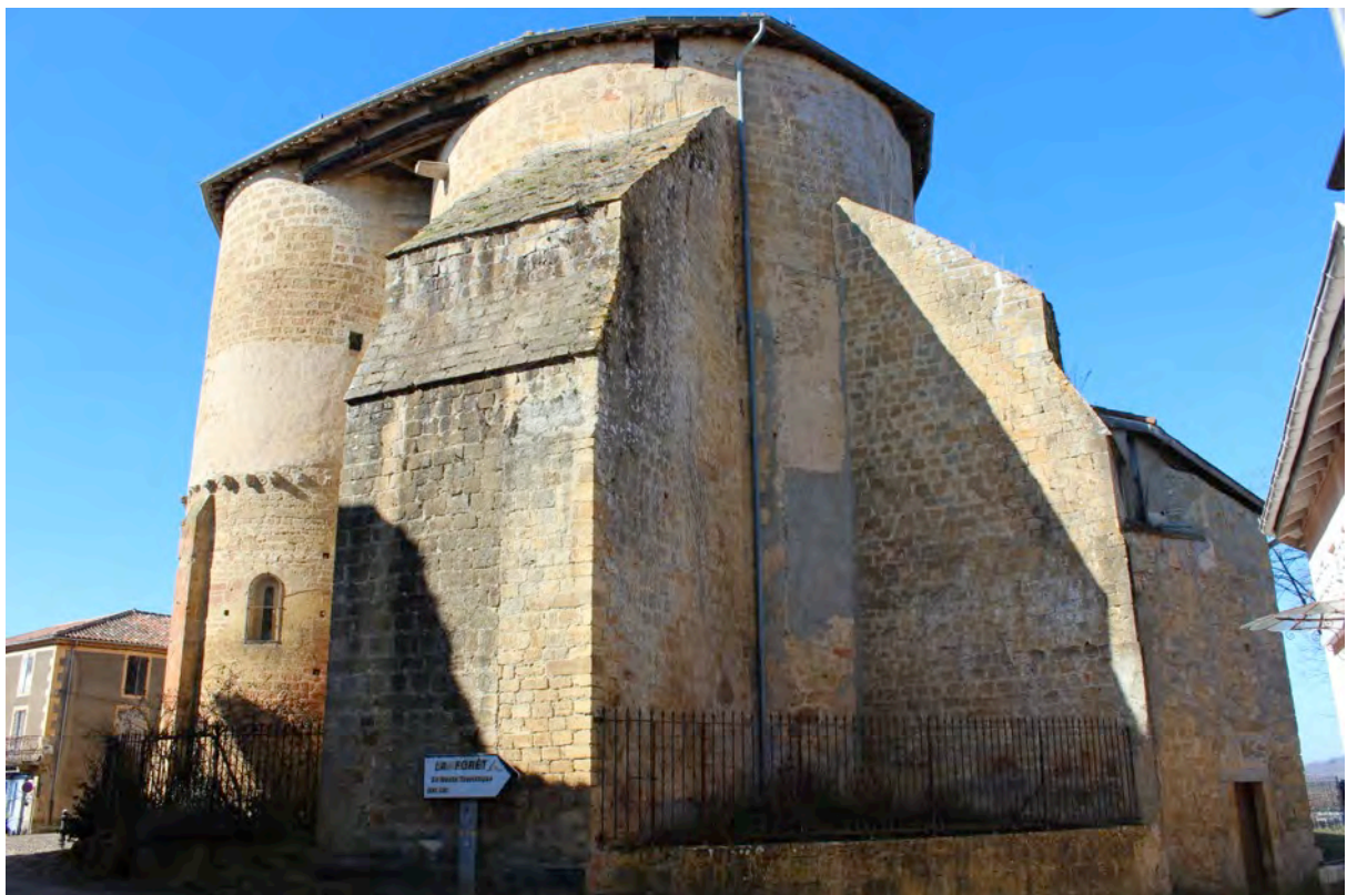
Fig. 6-89 – Aignan, vue d’ensemble depuis l’est. Les créneaux sont visibles sur l’absidiole sud, à gauche.
