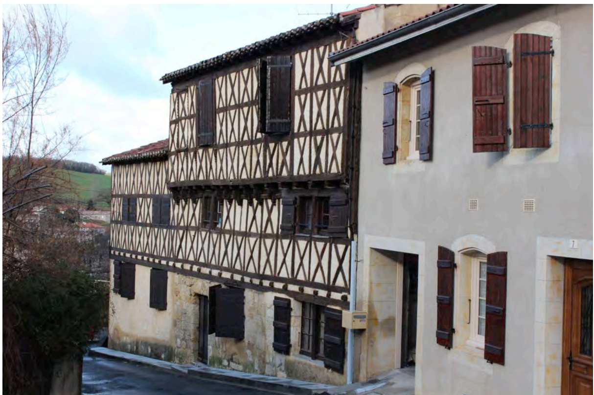
Fig. 4-52 – Pessan, maison implantée sur une rue convergente dans la pente (parcelle AD 23), vue depuis le sud-est.
