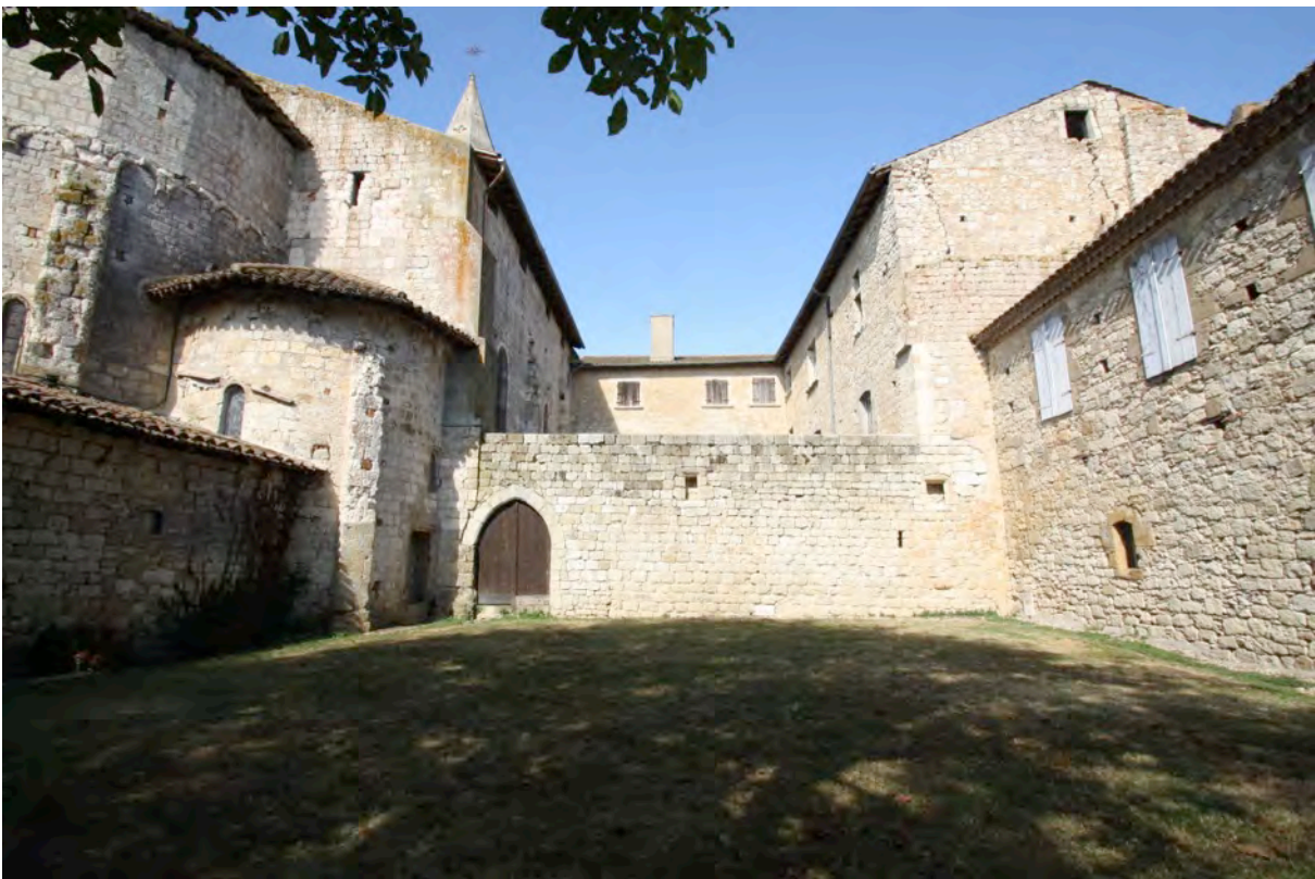
Fig. 6-85 – Montaut-les-Créneaux, vue de l'ensemble formé par l'église, à gauche, et le château, à droite.
