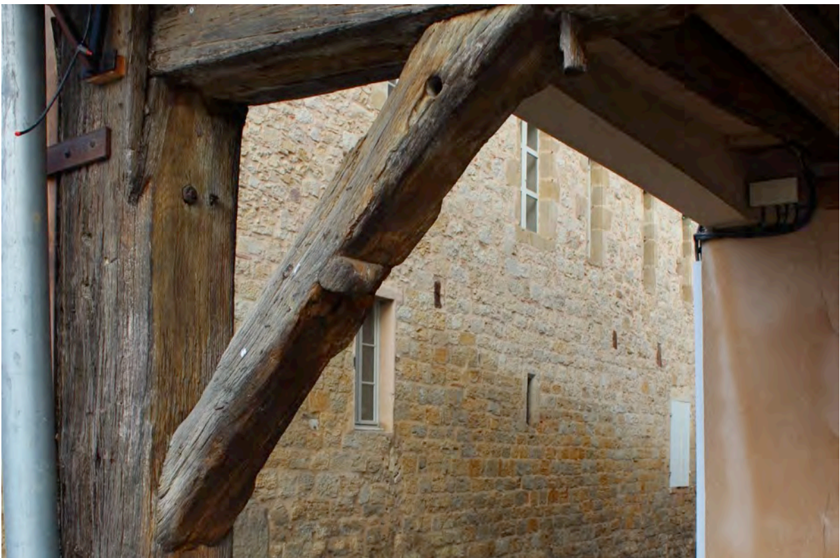
Fig. 9-153 – Aignan, maison (parcelle AB 208), façade sud, détail de l'aiselier du poteau cornier sculpté d'un simple tore au centre.
