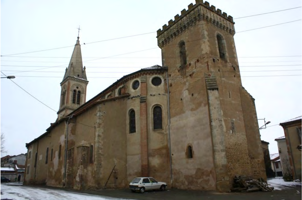
Fig. 8-39 – Saramon, vue d'ensemble de l'église depuis le sud-est.
