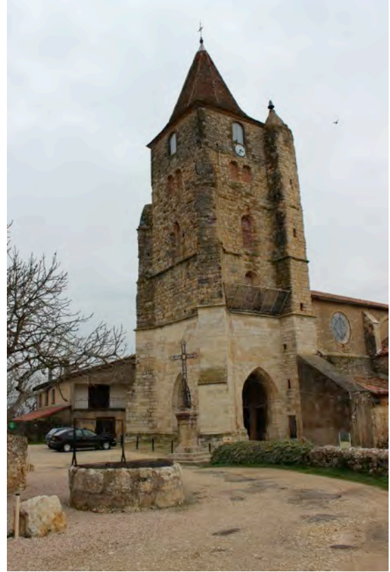
Fig. 9-31 – Lavardens, vue du clocher de l'église depuis le sud-ouest.
