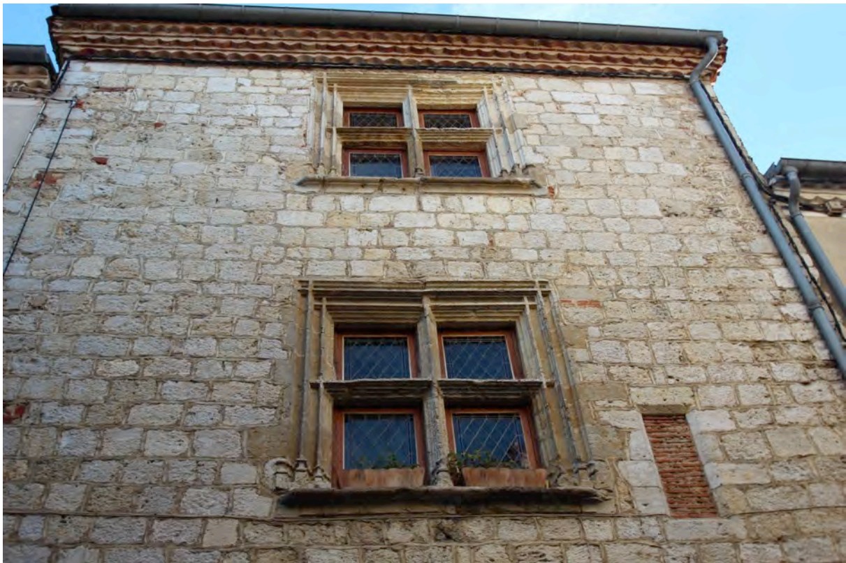
Fig. 9-122 – Jegun, maison (parcelle AT 285), élévation sud, détail des deux croisées à doubles baguettes ornées de doubles cavets et de bases prismatiques.
