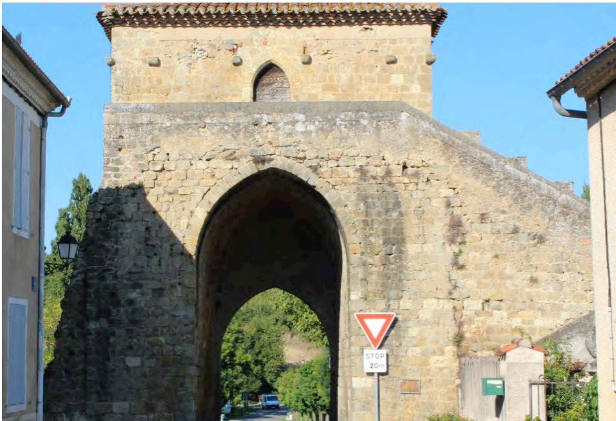
Fig. 6-58 – Barran, face interne de la tour-porte, vue depuis le sud.
