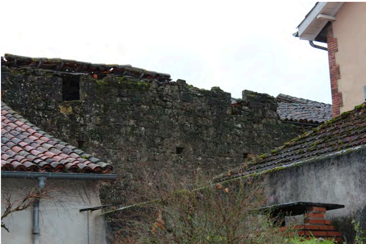
Fig. 6-36 – Masseube, vestiges du mur d'enceinte doté de créneaux (parcelle AD 138), vue depuis l'ouest.
