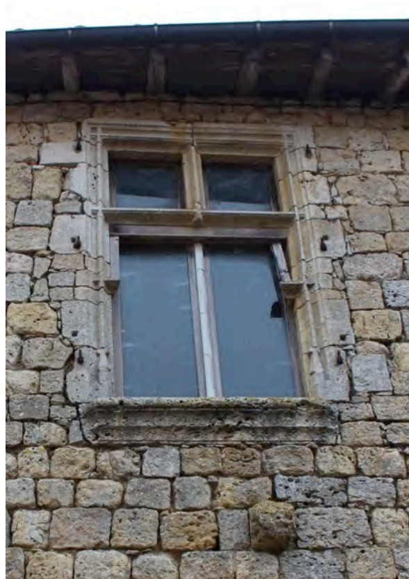
Fig. 9-116 – Monfort, maison (parcelle B 1040), élévation occidentale, détail de la croisée à deux croisillons.
