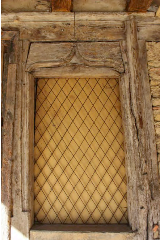
Fig. 9-81 – Bassoues, maison (parcelle AB 61), détail de la porte en accolade.
