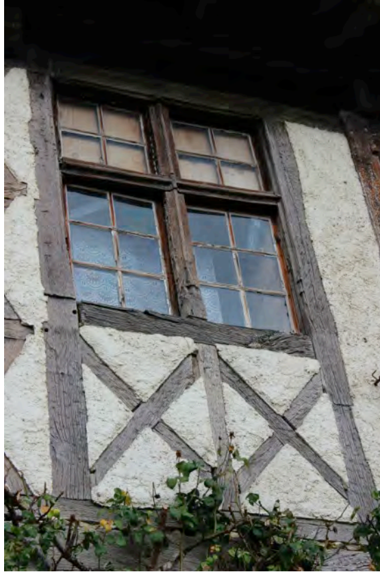
Fig. 9-86 – Solomiac, maison (parcelle B 862), élévation sud, détail d'une croisée de l'étage.
