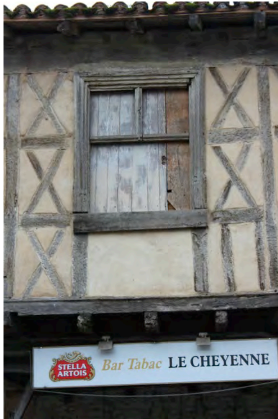
Fig. 9-65 – Solomiac, maison (parcelle B 794), façade nord, détail de la croisée sculptée.
