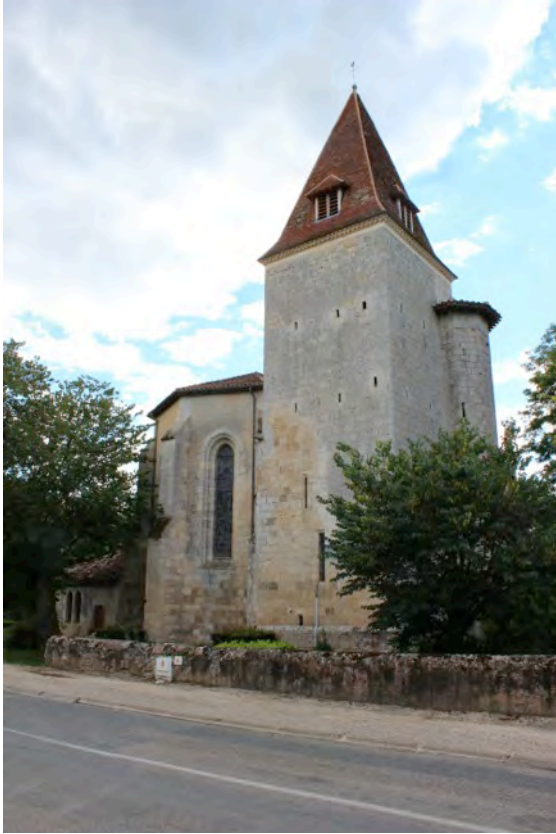
Fig. 8-33 – Fourcès, église, vue de la tour depuis le nord-est.
