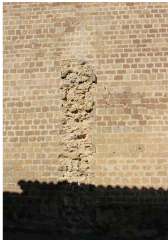
Fig. 8-19 – Bassoues, trace d'arrachement de la porte orientale du village dans le mur sud de la tour des archevêques (parcelle AB 112), vue depuis le sud.
