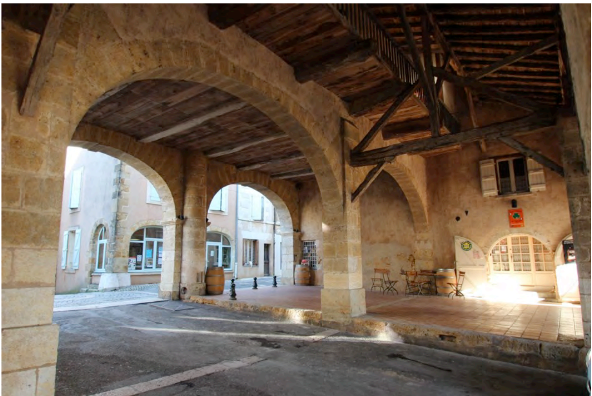
Fig. 5-31 – Jegun, mairie-halle (parcelles AT 281 et 282), vue de la partie inférieure depuis le sud-ouest.
