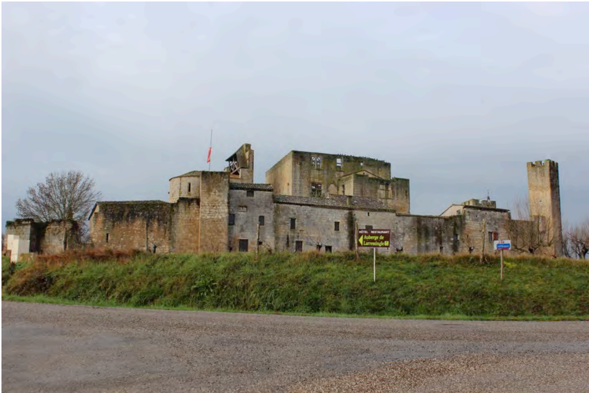
Fig. 6-84 – Larressingle, vue d'ensemble du village formé autour du couple château/église.
