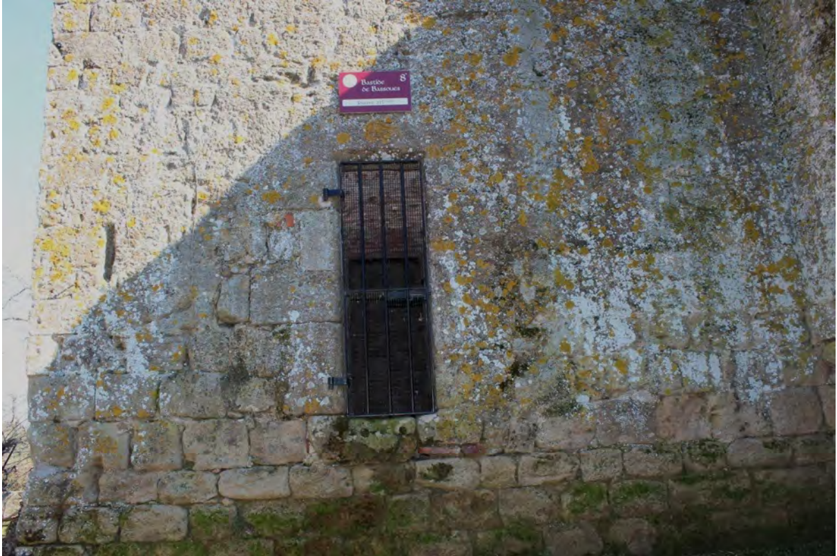
Fig. 8-56 – Bassoues, tour d’angle, face occidentale, porte du rez-de-chaussée.
