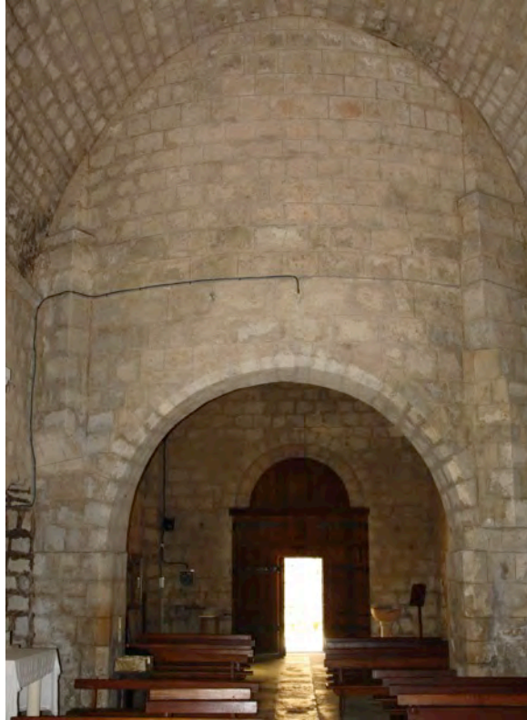
Fig. 6-110 – Larressingle, vue du chevet de l'église primitive percé lors de l'agrandissement vers l'est, vue depuis le chœur de la nouvelle église.
