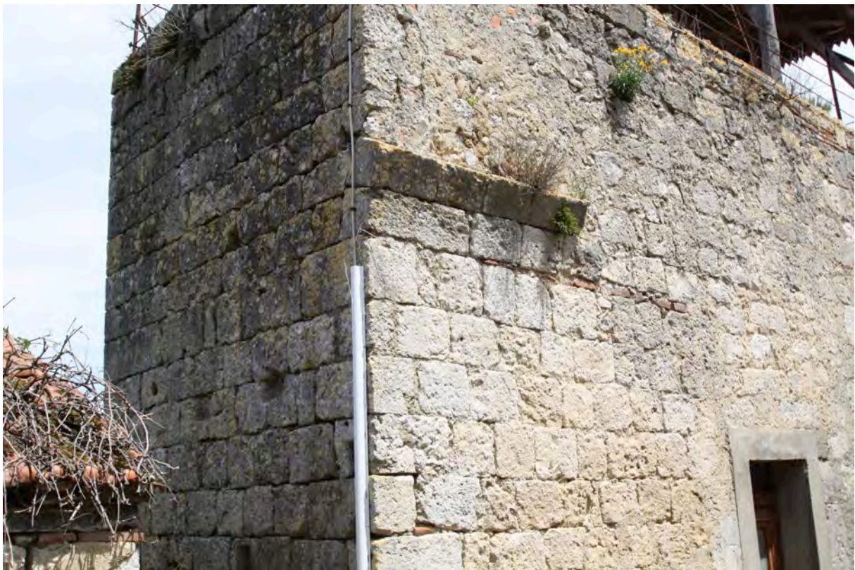
Fig. 8-12 – Plieux, porte sud-est, mur nord du couloir et départ de la voûte, vue depuis le sud.
