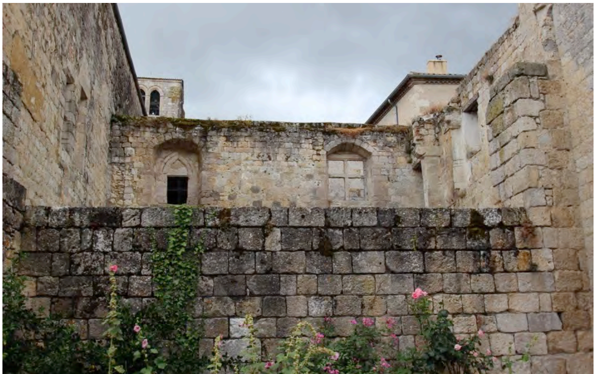
Fig. 4-78 – La Romieu, maison parcelle AB 364, mur d'enceinte et intérieur de la maison.
