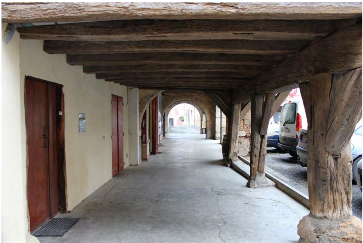
Fig. 9-8 – Cazaubon, couverts au sud de la place, vue depuis l'est.
