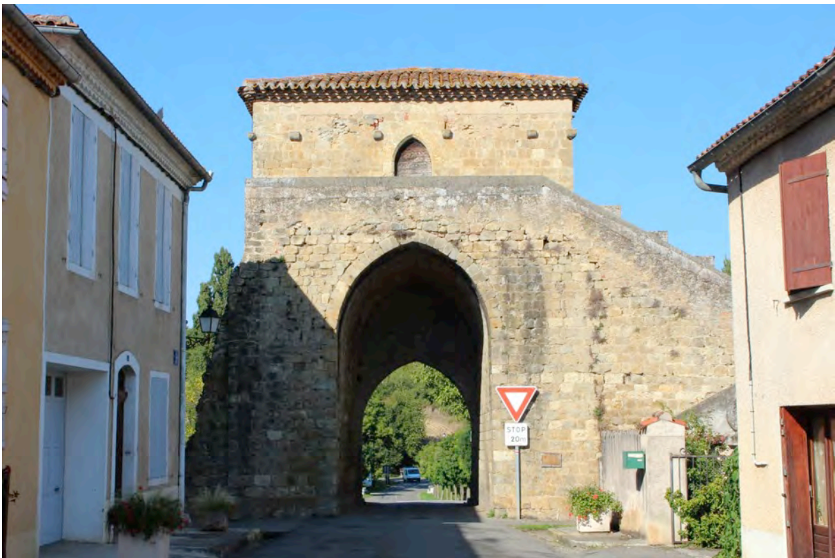
Fig. 8-62 – Barran, tour-porte, face interne et escalier maçonné, vue depuis le sud.
