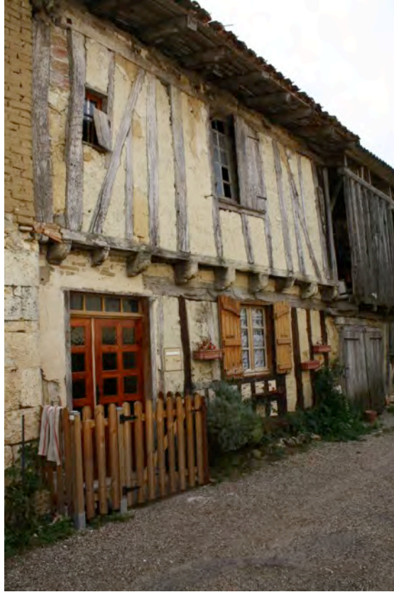
Fig. 9-50 – Gaudonville, maison (parcelle B 43), façade nord, vue depuis le nord-est.
