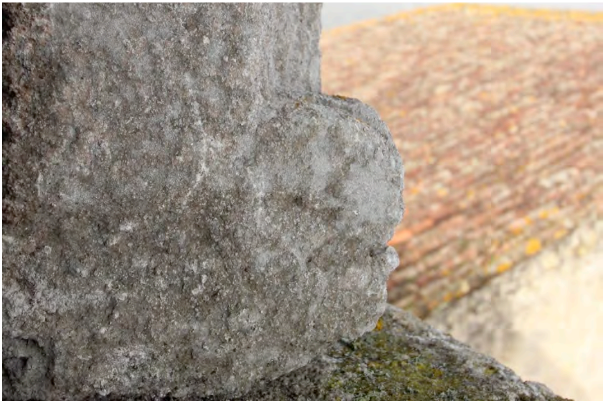
Fig. 9-120 – Montréal, maison (parcelle BM 221), élévation nord, détail du congé en boule fendue de la fenêtre à meneau à un cavet renversé.
