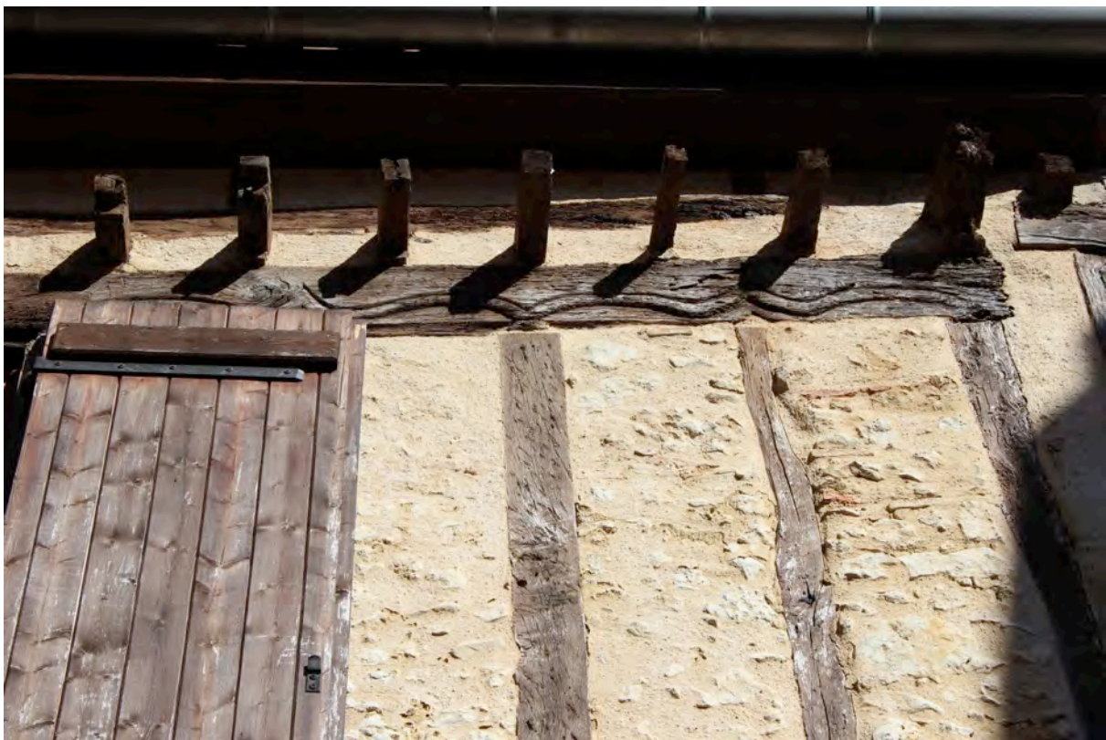
Fig. 9-64 – La Romieu, maison (parcelle AB 321), façade nord-ouest, détail des accolades sculptées au premier étage.
