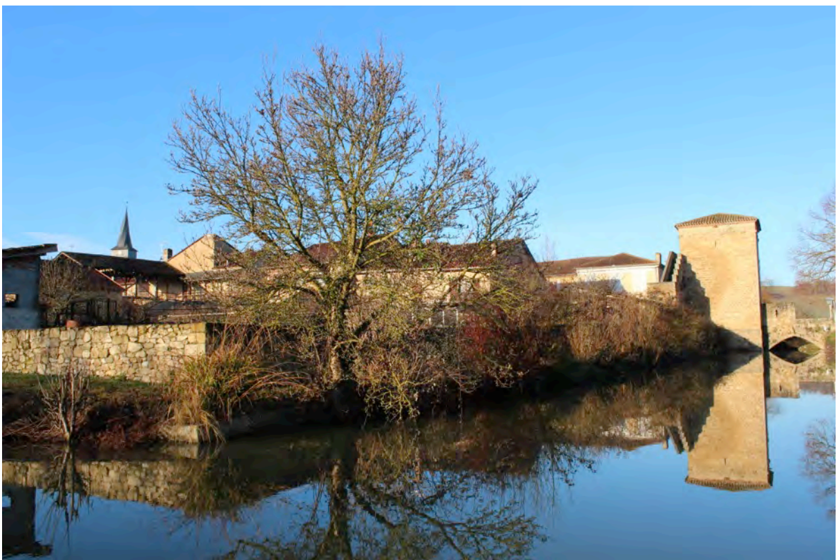
Fig. 6-20 – Barran, angle du fossé, vue depuis le nord-est.
