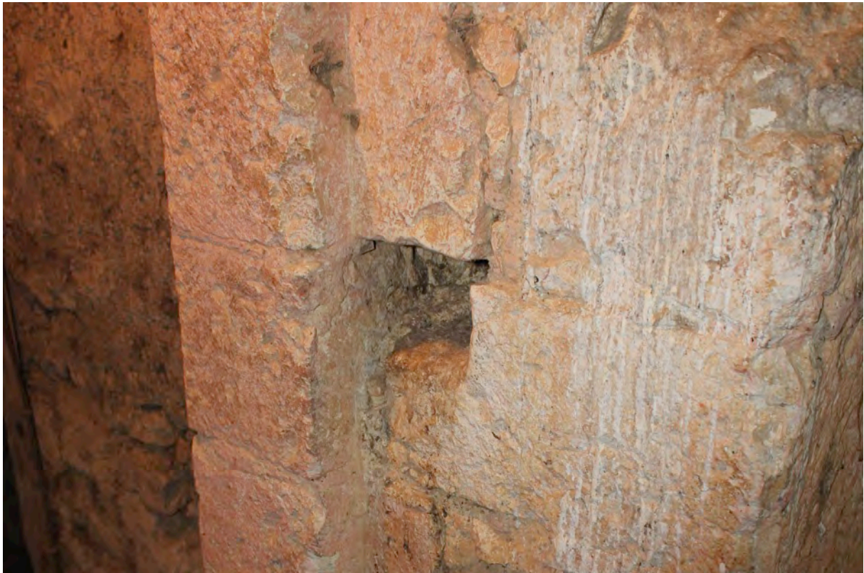
Fig. 6-51 – Pessan, galerie menant à la tour, détail du trou barrier de la porte, vue depuis le nord-est.
