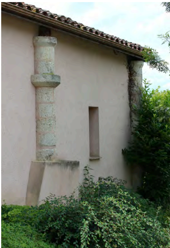
Fig. 9-45 – Montréal, deux colonnes de la halle réutilisées sur une maison (BM 455), vue depuis le nord-est.
