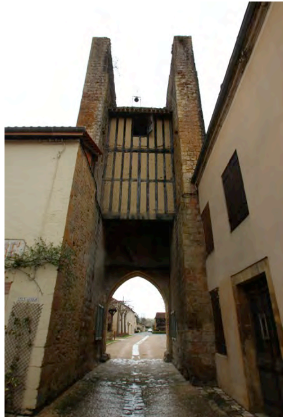
Fig. 6-54 – Tillac, face interne de la tour-porte ouverte à la gorge, vue depuis le nord-est.
