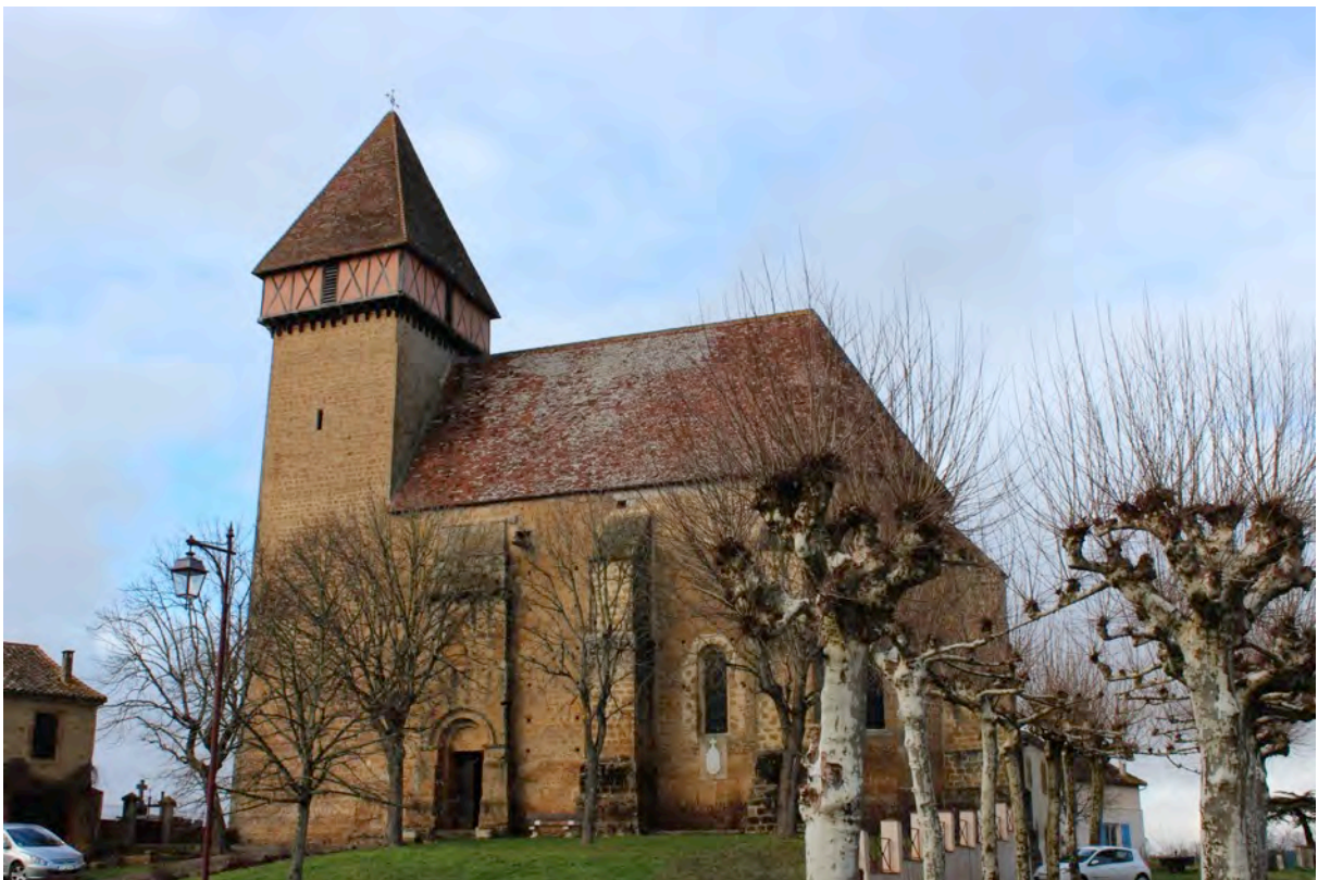
Fig. 8-35 – Sabazan, vue d'ensemble de l'église depuis le sud-est.
