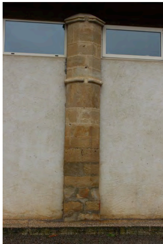
Fig. 9-46 – Beaumarchés, détail d'un des piliers de la halle.
