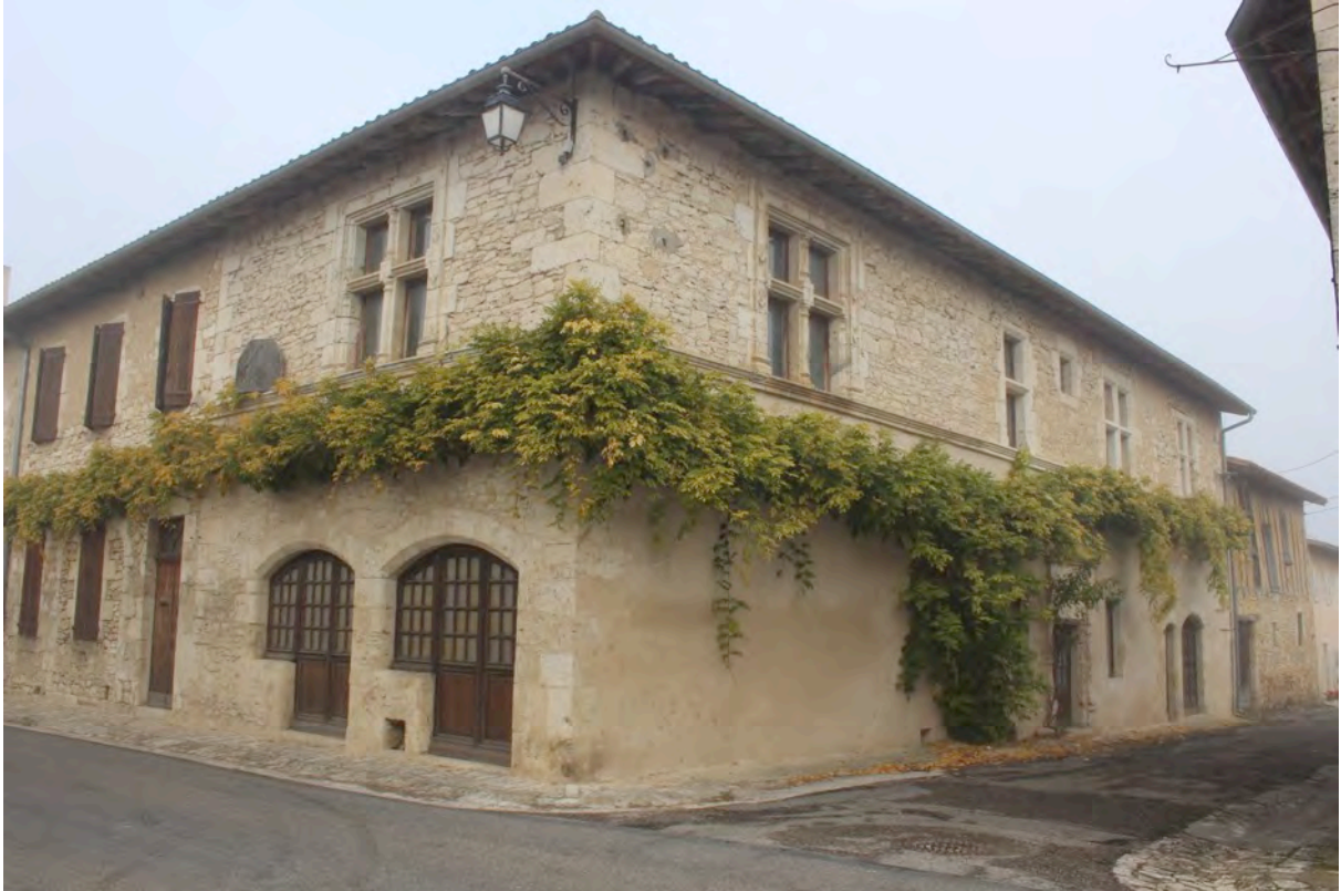
Fig. 9-125 – Monfort, maison (parcelle B 635), vue depuis le sud-est.
