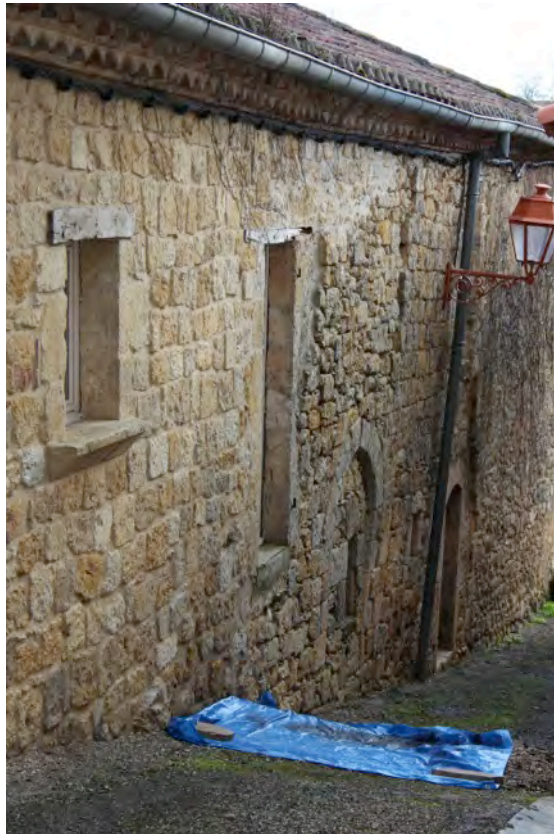
Fig. 5-9 – Cassaigne, faubourg (parcelles A 163 et 166), élévation ouest, vue depuis le nord.
