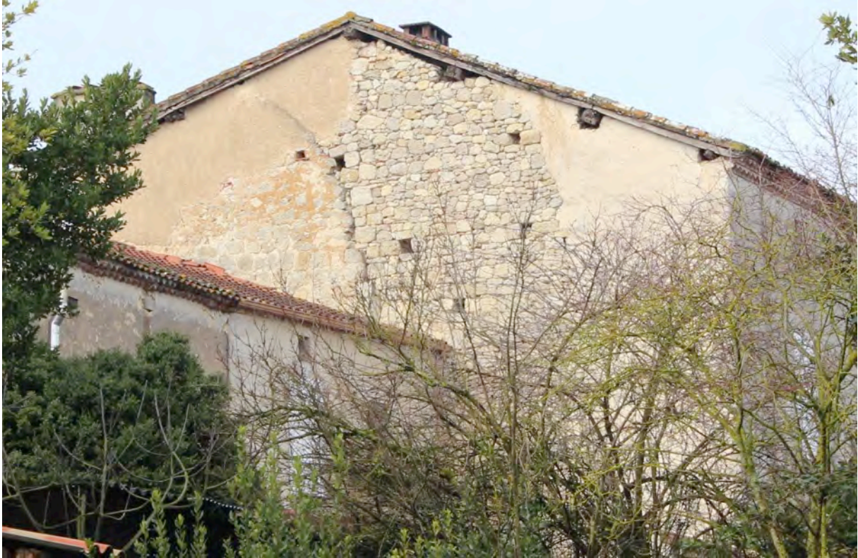
Fig. 8-8 – Larroque-sur-l’Osse, vestige de l’enceinte du faubourg (partie gauche du mur, en légère saillie), vue depuis le nord-est.
