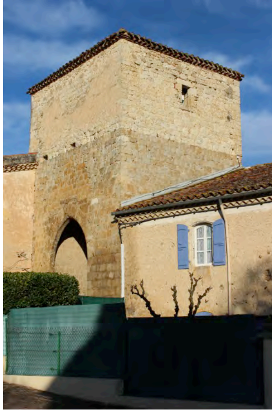
Fig. 8-75 – Marambat, tour-porte, vue depuis le sud-est.
