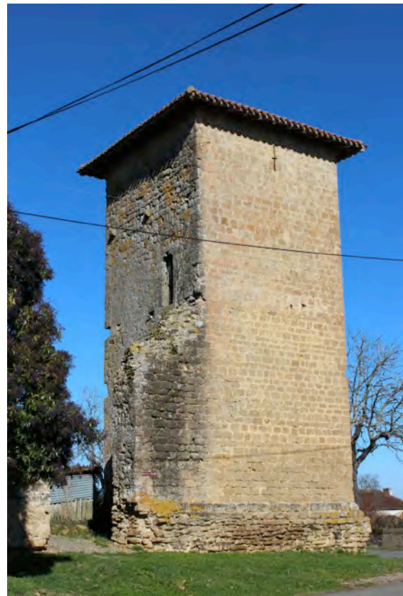
Fig. 8-17 – Bassoues, tour d'angle de l'enceinte (parcelle AB 166), vue depuis le sud-ouest.
