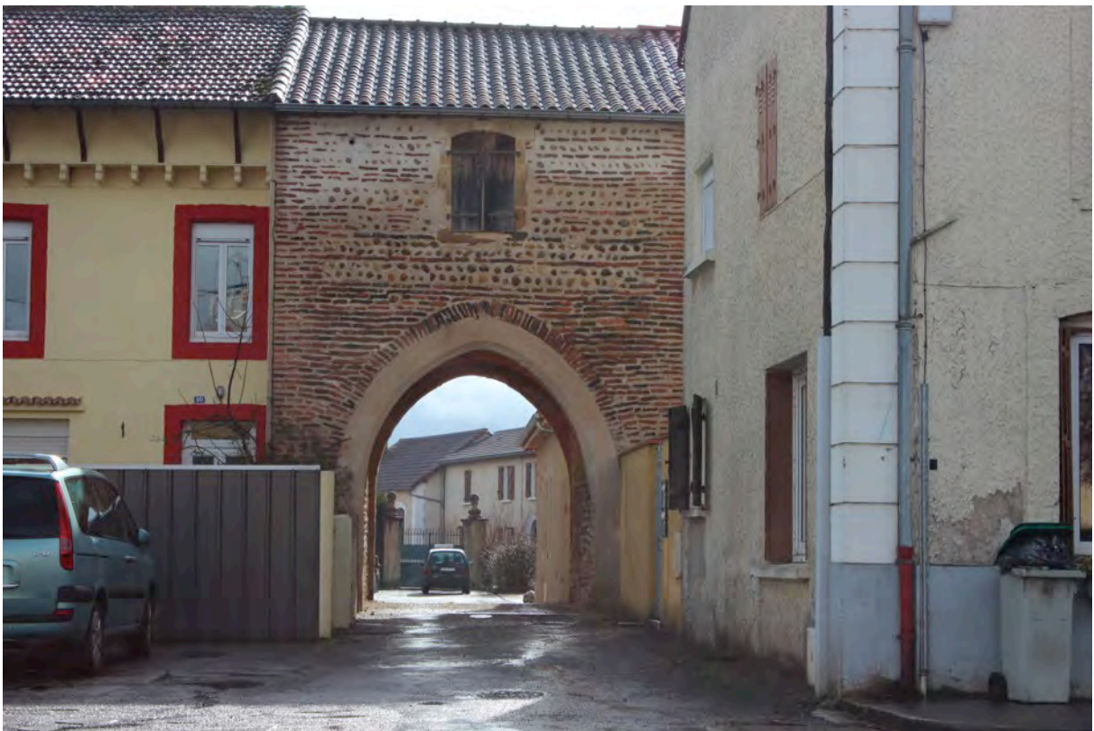
Fig. 8-49 – Villecomtal-sur-Arros, face externe de la tour-porte, vue depuis le nord.
