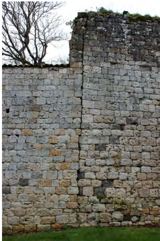
Fig. 6-30 – Gizaupouy, front occidental de l'enceinte, détail de la suture.
