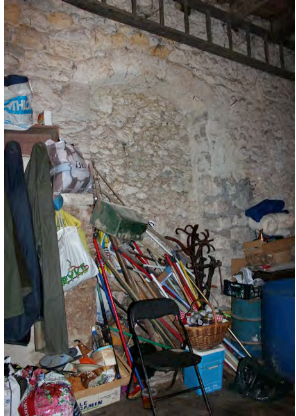
Fig. 7-21 – Montréal, maison parcelle BM 222, arrière-voussure de la porte centrale sur le mur de refend, vue depuis le nord.
