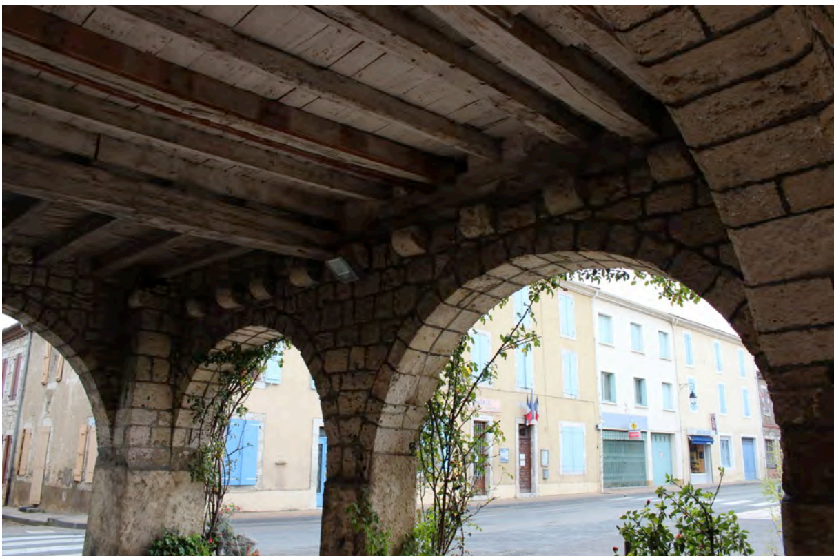
Fig. 6-142 – Solomiac, maisons à couverts au nord de la place (parcelles B 862 et 863), détail des arcades et de l'alignement de corbeaux portant le plancher.
