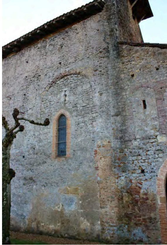
Fig. 8-41 – Mouchès, élévation nord de l'église, emplacement de l'ancien bras nord du transept.
