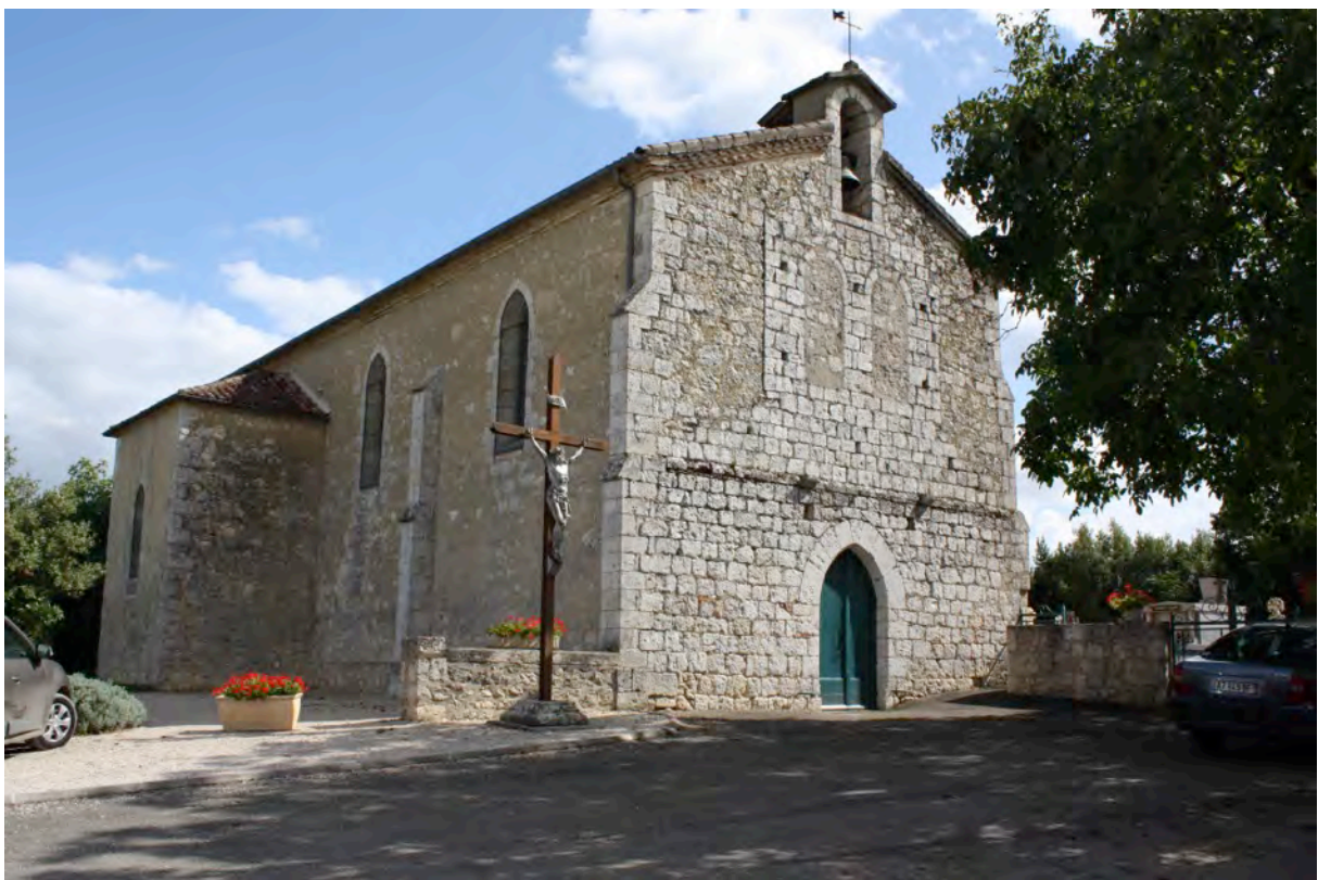
Fig. 6-91 – Avezan, vue de l'église depuis le nord-ouest. Le mur-clocher d'origine est encore visible sur la façade occidentale.
