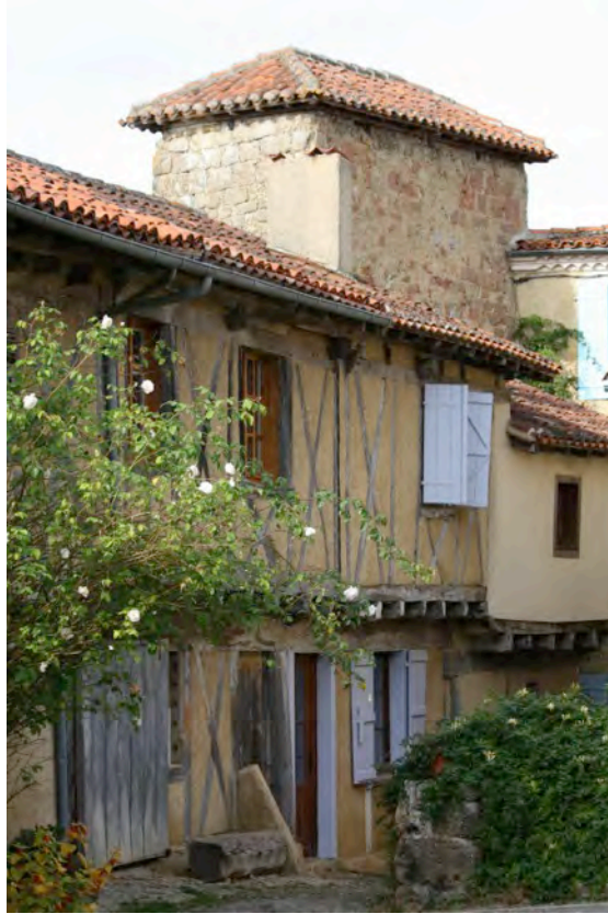
Fig. 9-55 – Montesquiou, maison (parcelle AB 154), façade est, vue depuis le sud-est.
