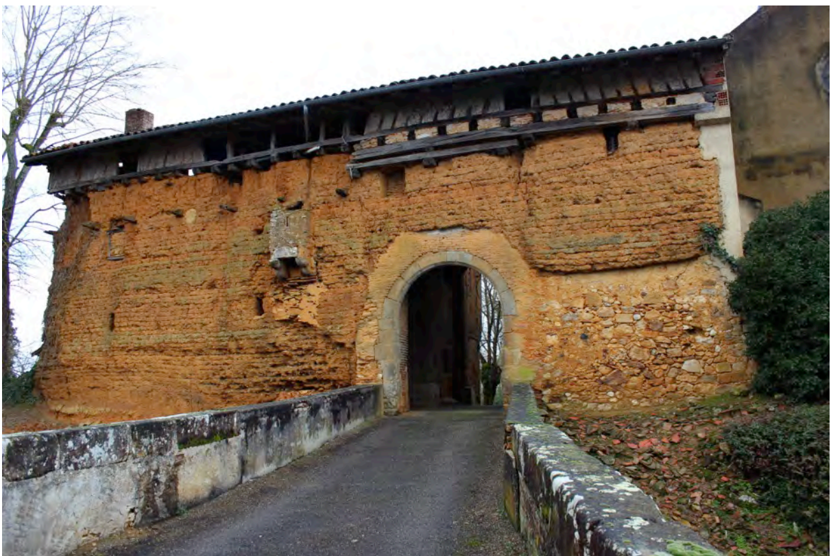
Fig. 6-82 – Sainte-Christie-d'Armagnac, mur du castet (parcelle OC 420), vue depuis l'ouest.
