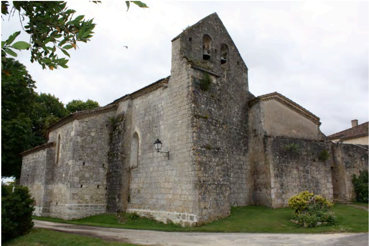
Fig. 6-88 – Berrac, vue d’ensemble de l’église et de l’angle de l’enceinte collective depuis le nord.
