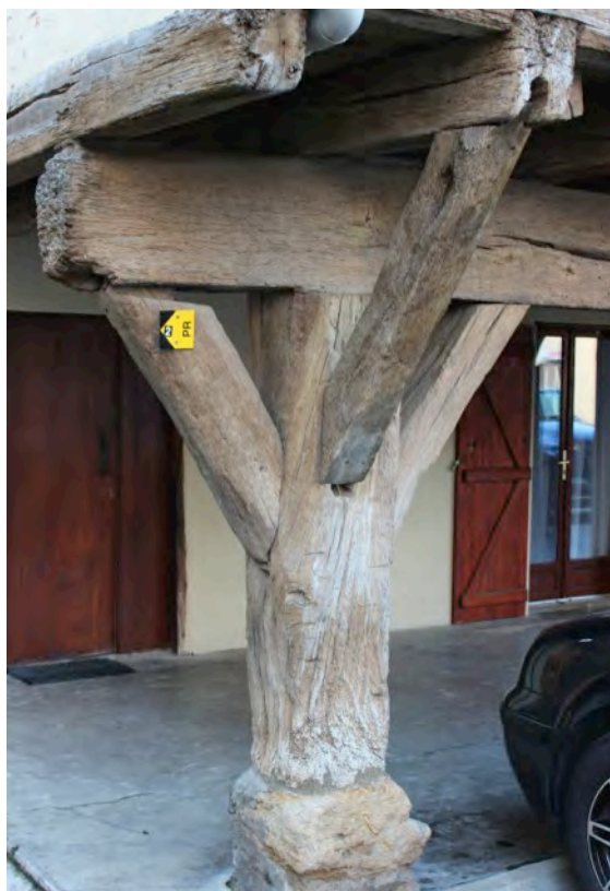
Fig. 9-144 – Miélan, maison (parcelle AD 107), détail des couverts et du poteau cornier dans lequel s'insère la sablière de plancher, vue depuis le nord.
