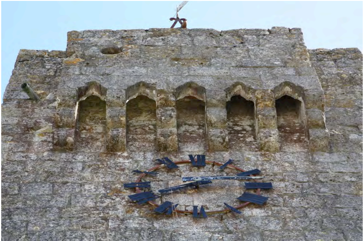
Fig. 6-70 – Larressingle, face externe de la tour-porte (parcelles A 480 et 9480), détail de la bretèche, vue depuis l'ouest.
