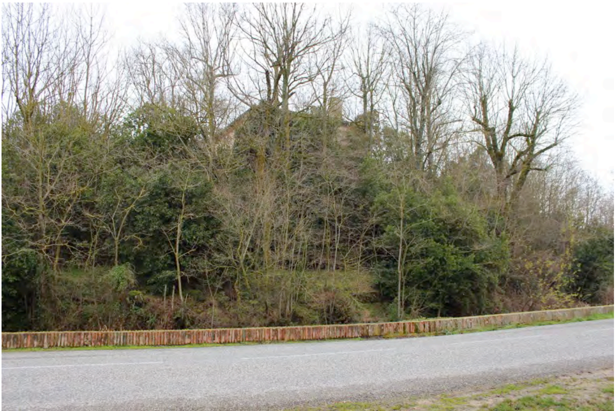
Fig. 4-37 – Montpezat, vue de la motte depuis l'ouest.
