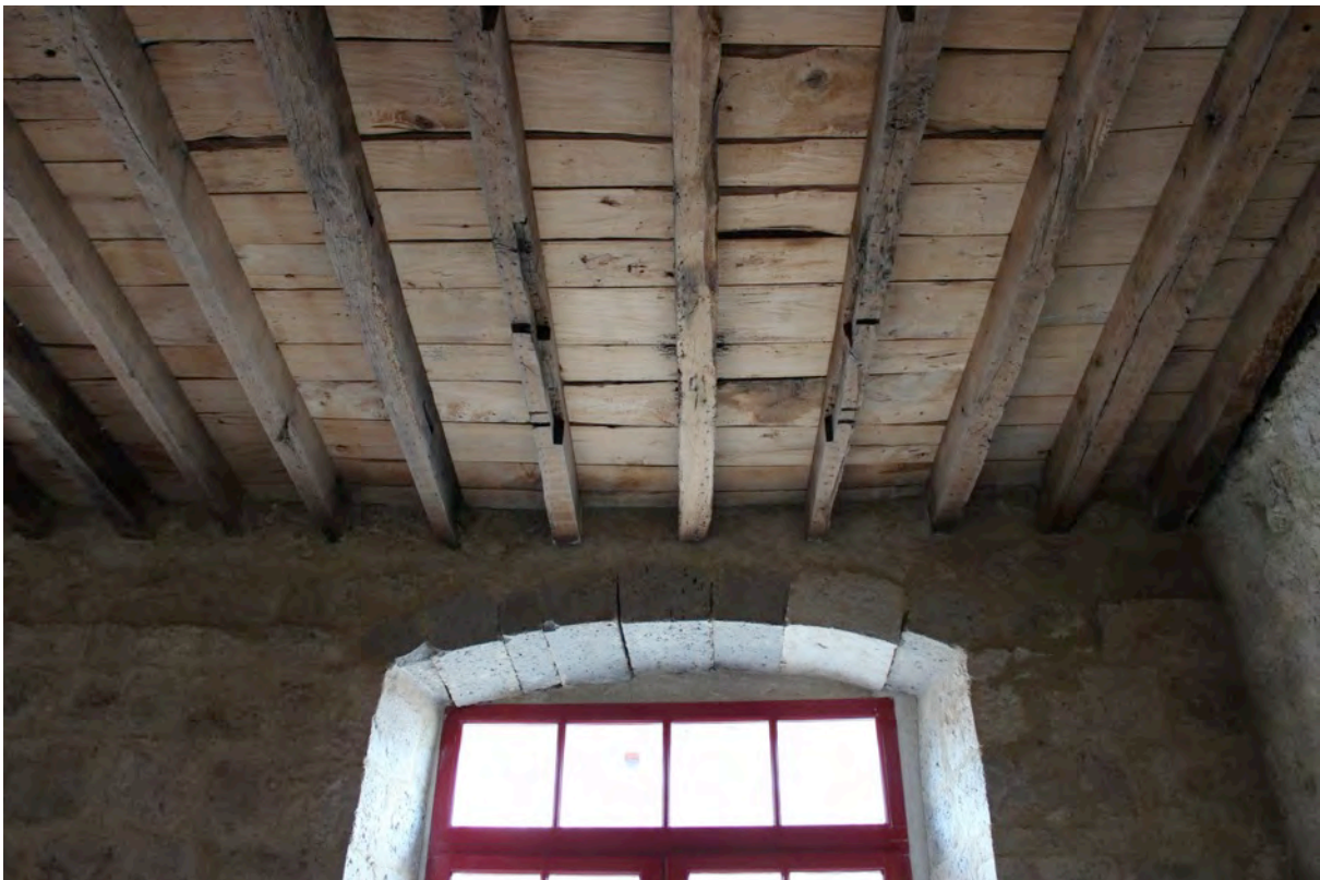
Fig. 9-111 – Montréal, maison « du bailli » (parcelle BM 213), premier étage, pièce sud, arrière-voussure d'une croisée et retrait supportant initialement le plancher.
