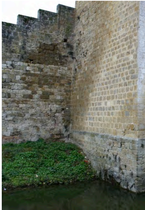
Fig. 8-6 – Barran, angle oriental formé par le mur d'enceinte et la tour-porte, détail des pierres laissées en attente sur la tour (à droite) pour accueillir le mur (à gauche).
