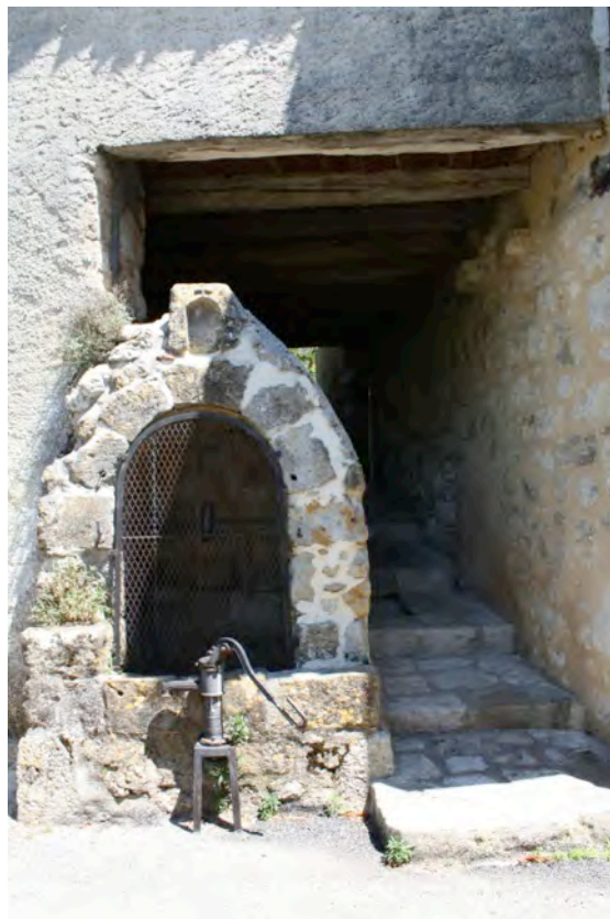
Fig. 9-49 – Castelnau-Barbarens, puits, vue depuis le sud-ouest.
