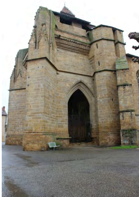
Fig. 9-11 – Beaumarchés, porche de l'église, vue depuis le sud-ouest.
