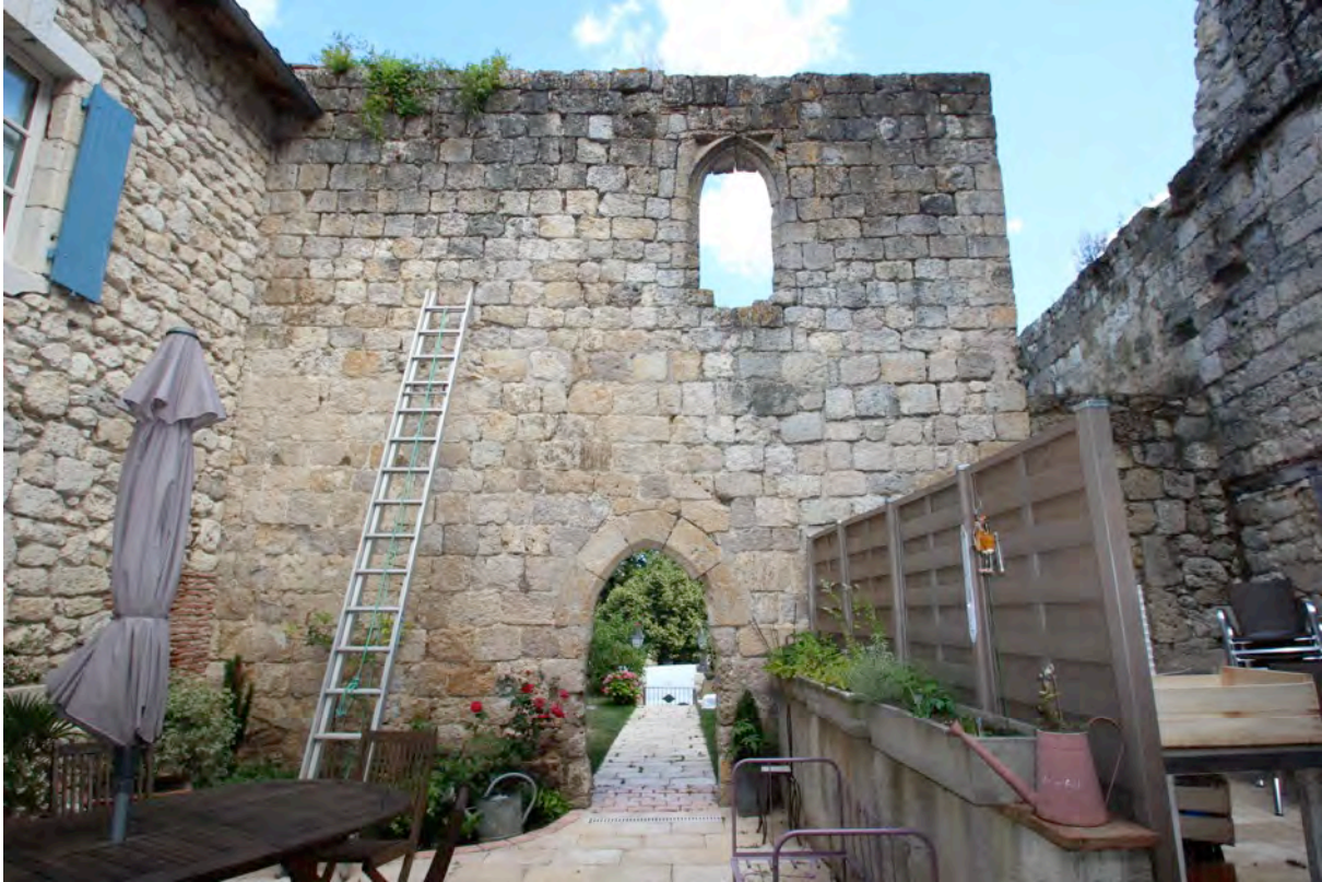
Fig. 4-75 – La Romieu, maison parcelle AB 159, façade en cœur de parcelle, vue externe depuis le sud.
