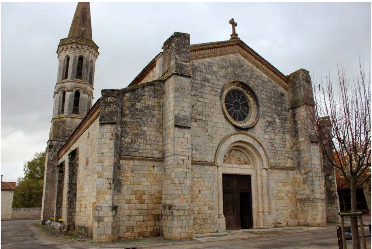
Fig. 7-35 – Solomiac, vue de l'église depuis le nord-ouest.
