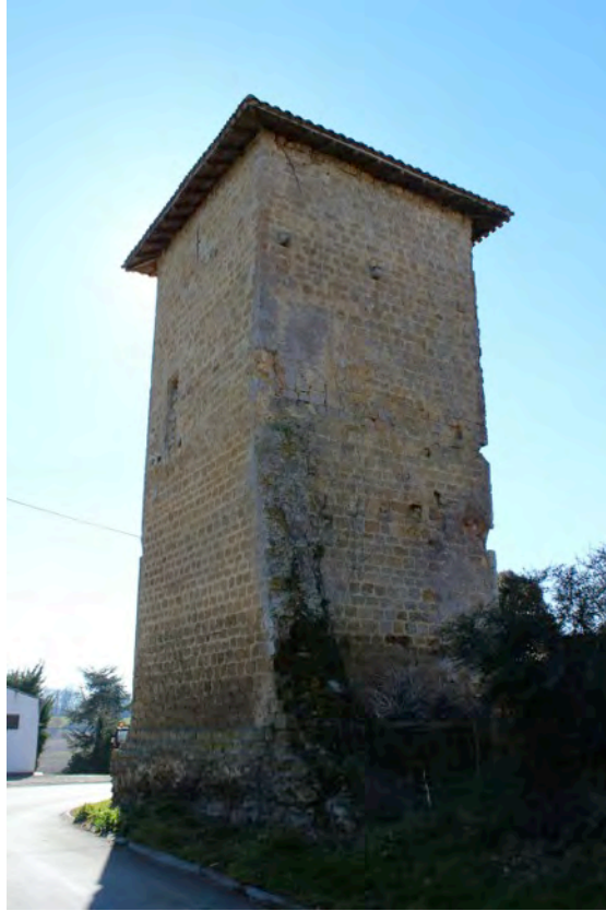
Fig. 8-60 – Bassoues, tour d'angle, vue depuis le nord-est.
