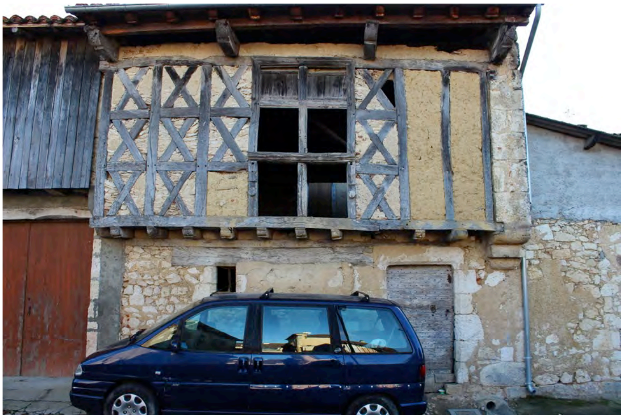
Fig. 9-68 – Touget, maison (parcelle C 542), façade nord, vue depuis le nord.
