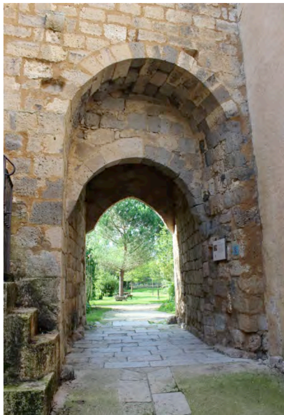
Fig. 8-76 – Fourcès, tour-porte, vue de la face interne et des nombreuses reprises en calcaire gris de l'Agenais.
