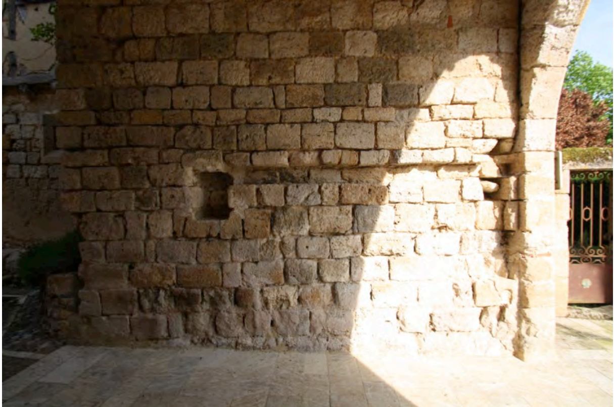
Fig. 6-63 – Saint-Antoine, couloir de la tour-porte, détail de la rainure.
