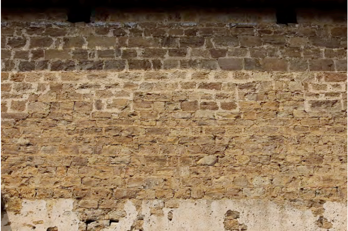
Fig. 6-116 – Aignan, surélévation crénelée de l'élévation sud de l'église paroissiale.
