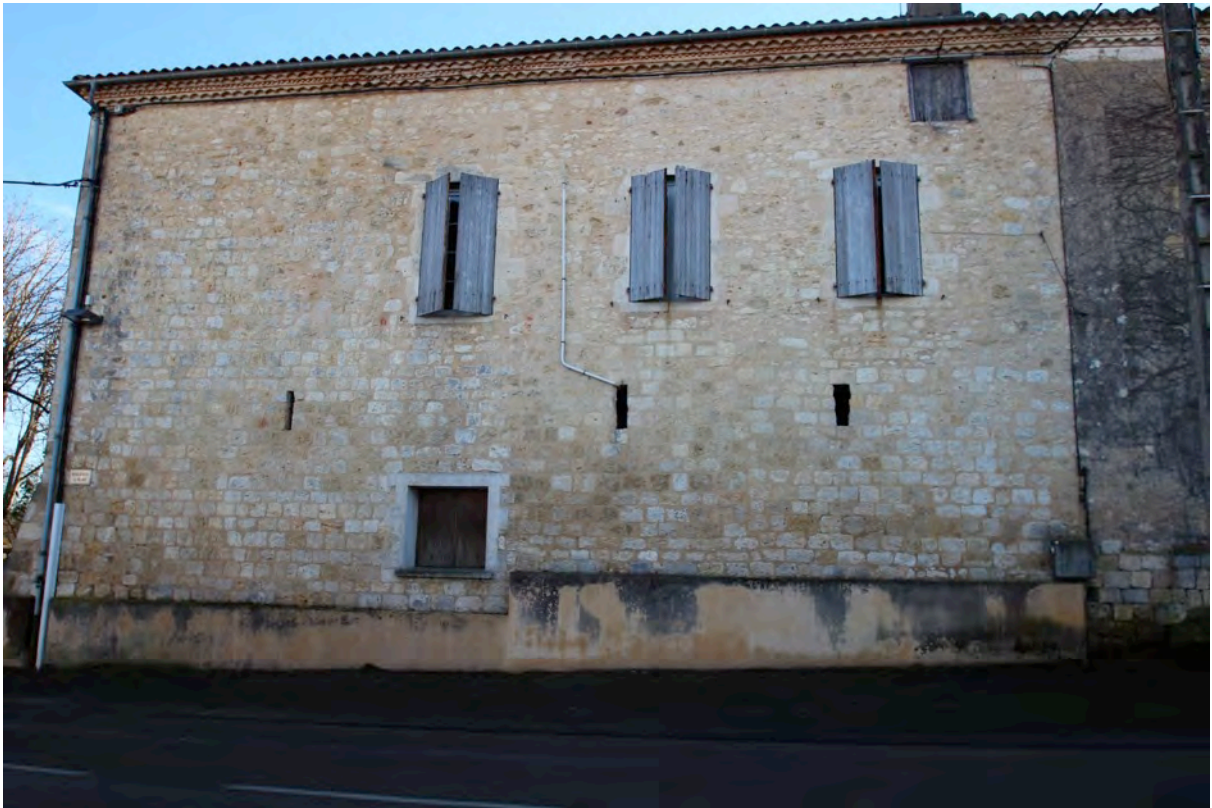
Fig. 5-30 – Jegun, front nord de l'enceinte (parcelle AT 196), vue depuis le nord.
