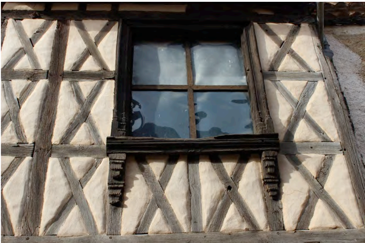
Fig. 9-66 – Biran, maison (parcelle AO 146), façade sud-est, détail de la croisée et des consoles sculptées.
