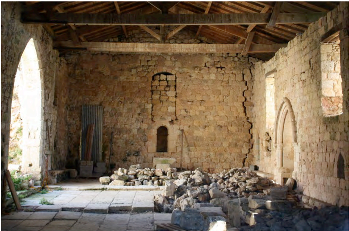
Fig. 6-107 – Le Vieux-Castéra (c. de Castéra-Verduzan), église paroissiale, vue intérieure depuis l'ouest.
