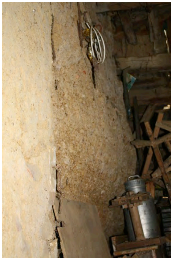
Fig. 8-53 – Villefranche, front nord de l'enceinte (parcelle B 69), vue depuis le nord-est.
