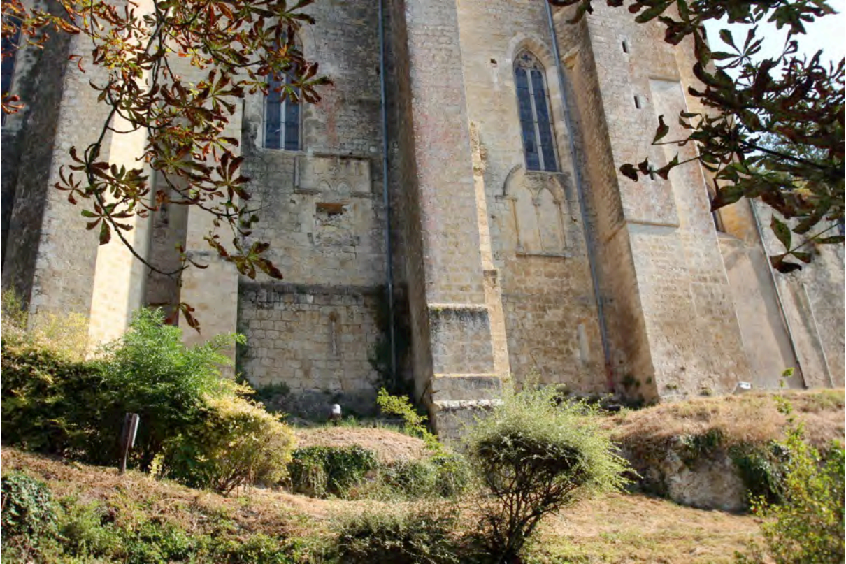
Fig. 4-40 – Montréal, église paroissiale, élévation sud, vue depuis le sud.
