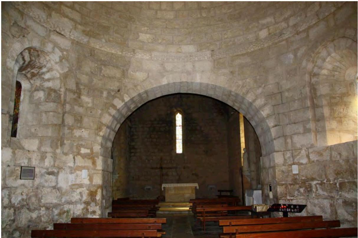
Fig. 6-111 – Larressingle, vue de l'abside de l'église primitive percée lors de l'agrandissement, vue depuis la nef.
