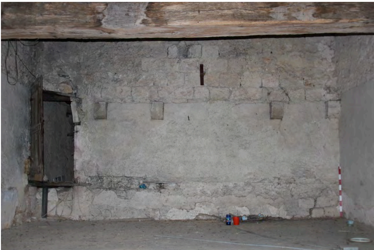
Fig. 4-88 – Montréal, maison parcelle BM 221, étage de comble, mur de refend médiéval.
