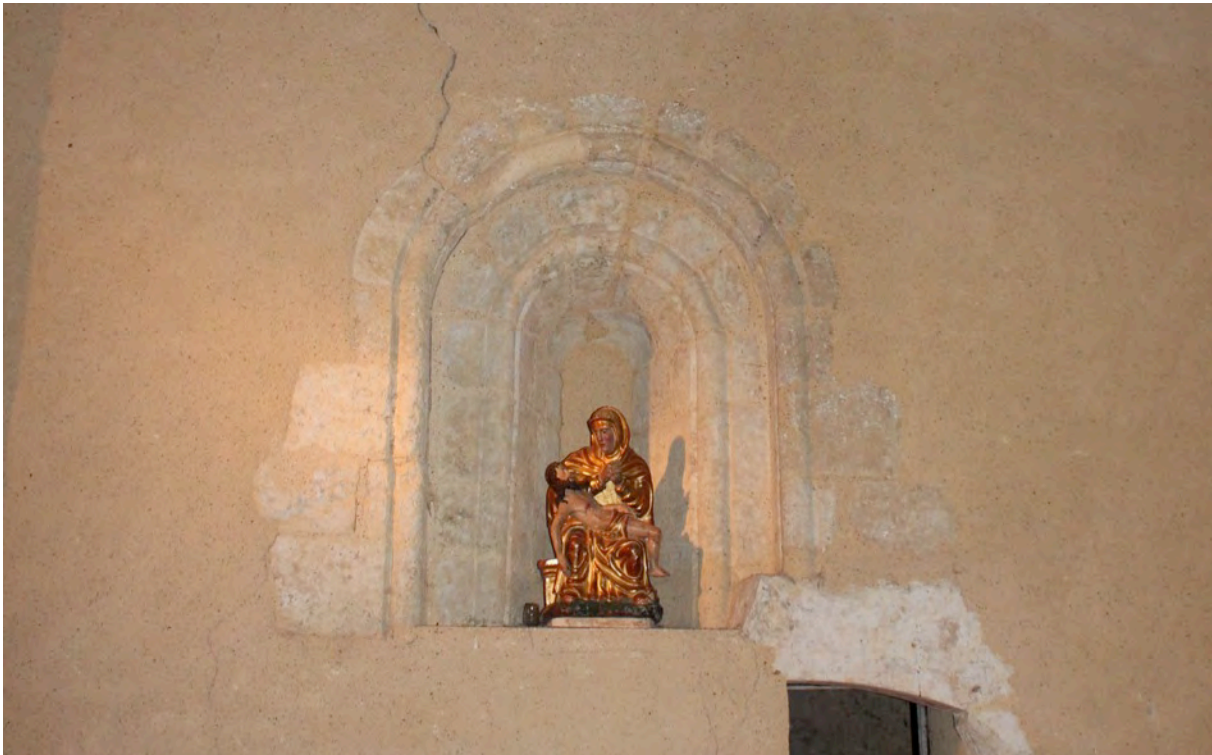
Fig. 5-55 – Pessan, église, détail d'une baie en plein cintre aujourd'hui bouchée, bras sud du transept, vue depuis l'ouest.
