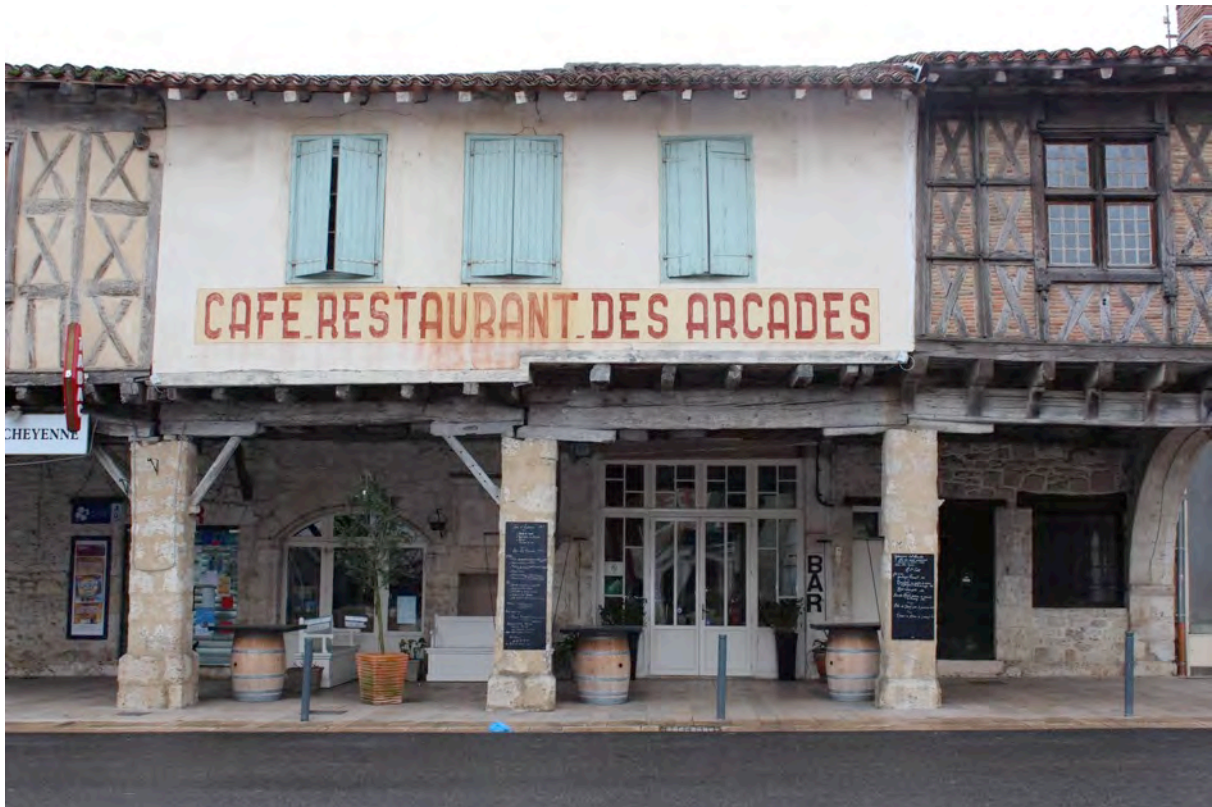
Fig. 9-140 – Solomiac, couverts reposant sur des piliers maçonnés postérieurs à leur édification (parcelles B 796 et 985).
