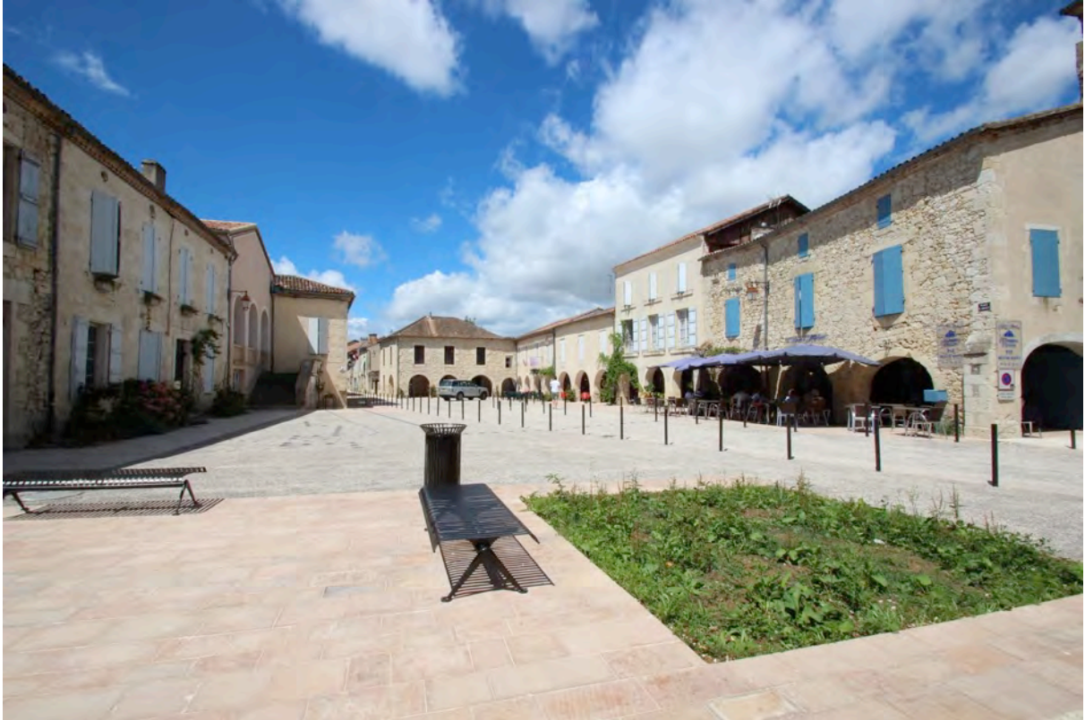
Fig. 4-59 – La Romieu, place, vue d'ensemble depuis le sud-est.
