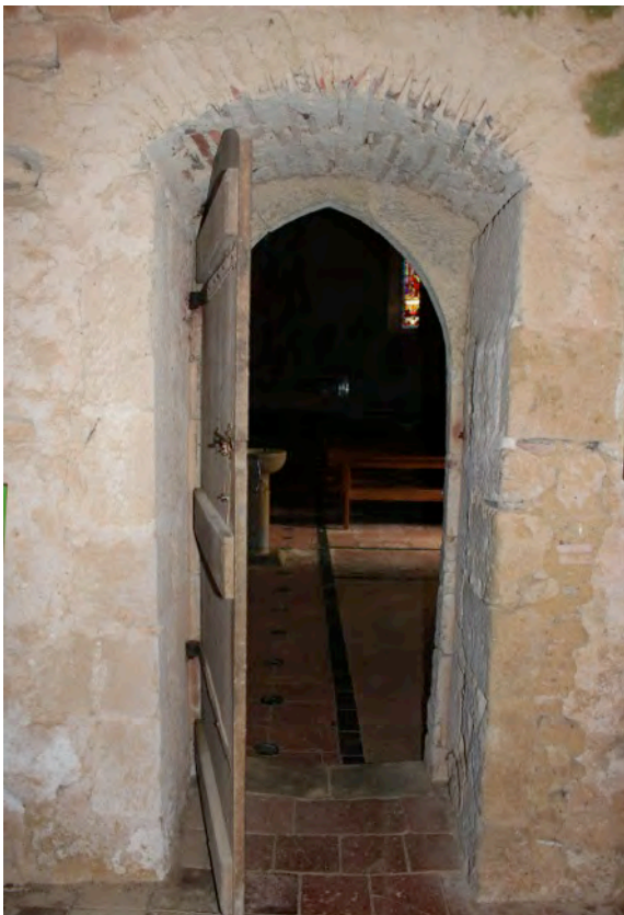
Fig. 8-37 – Sabazan, vue intérieure de la porte permettant l'accès depuis la nef de l'église vers le rez-de-chaussée de la tour.
