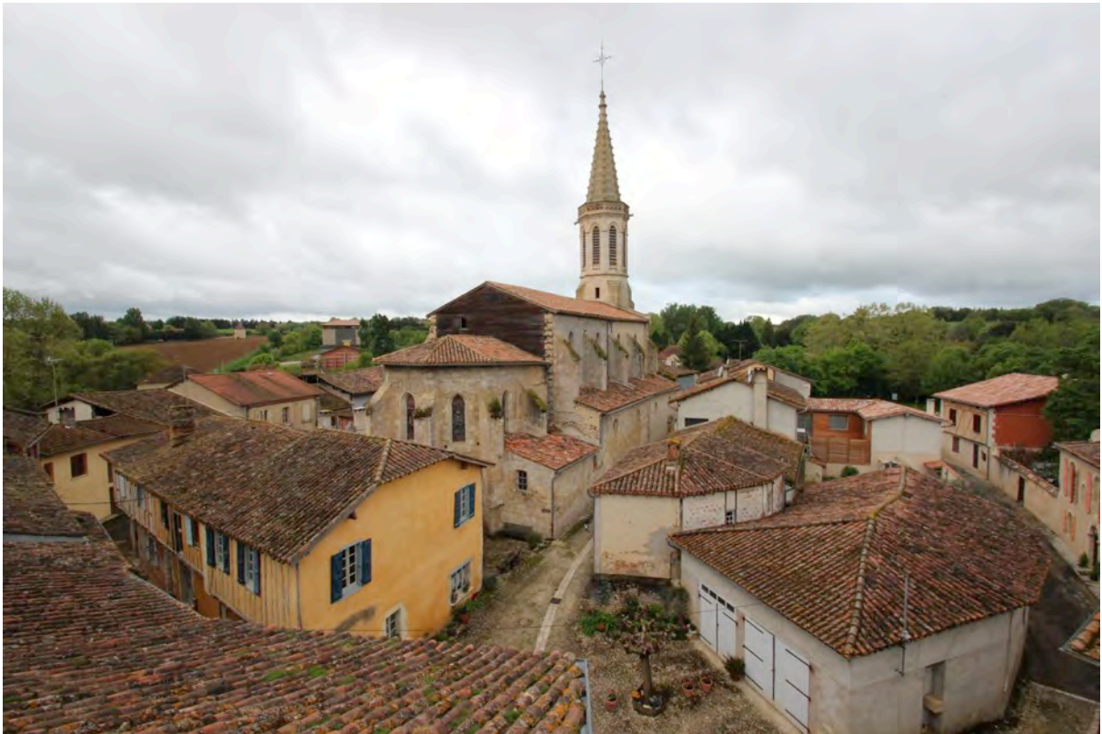
Fig. 4-34 – Sarrant, vue du village depuis la tour-porte, vue depuis le nord-est.
