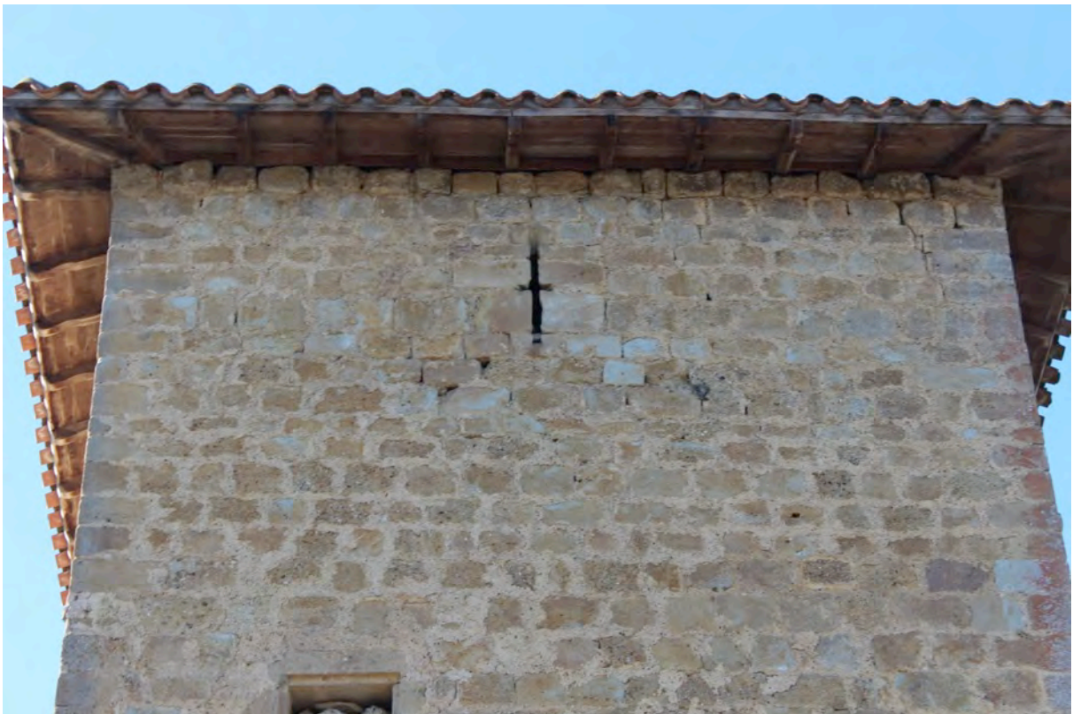
Fig. 8-59 – Bassoues, tour d'angle, face orientale, détail de la partie sommitale et de la meurtrière à croix pattée.
