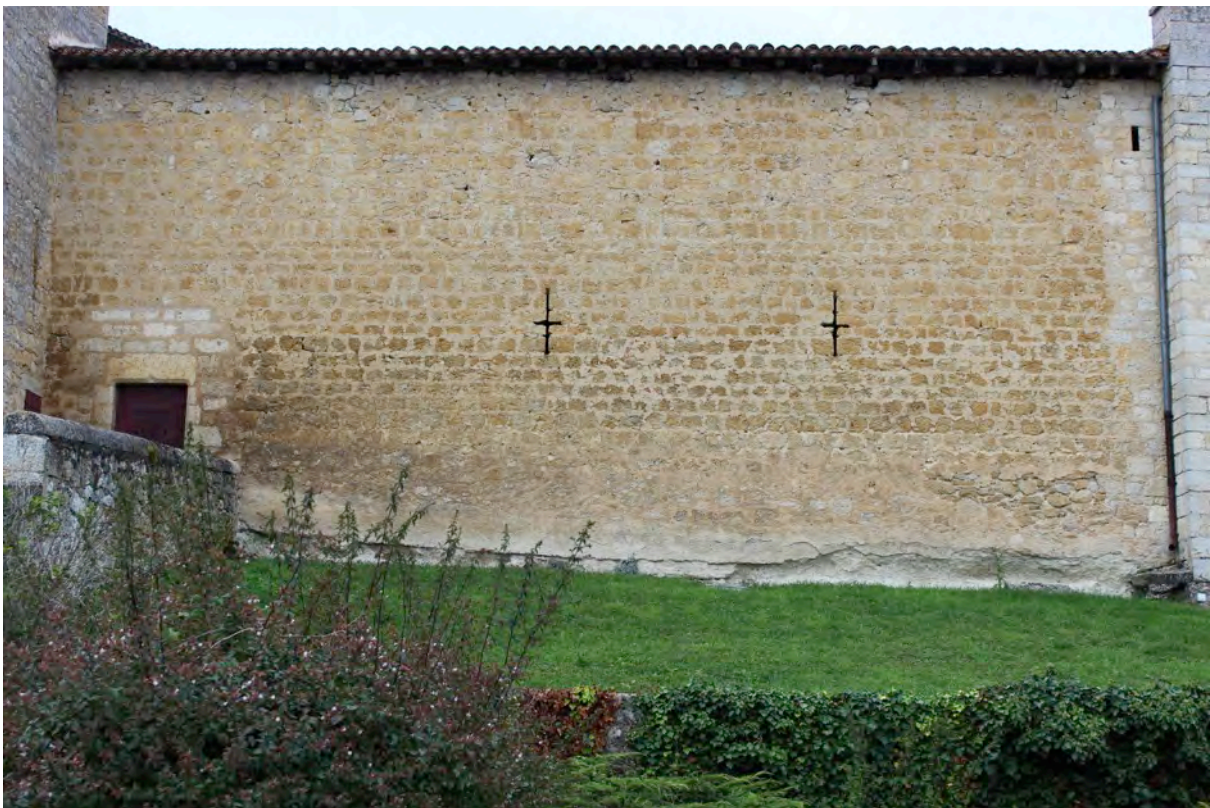
Fig. 6-13 – Terraube, mur d'enceinte sud, vue d'ensemble depuis le sud.
