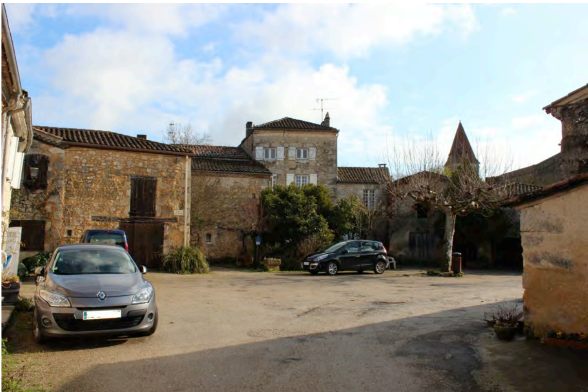
Fig. 5-10 – Fourcès, place dite « des cornières », vue depuis le sud-ouest.
