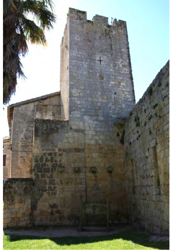
Fig. 8-24 – Larressingle, tour-porte, vue depuis le nord.
