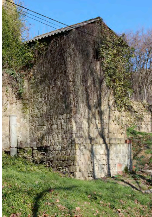
Fig. 8-18 – Bassoues, front sud de l'enceinte, base d'une tour de flanquement (parcelle AB 236), vue depuis le sud-ouest.
