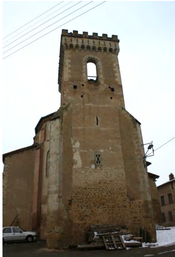
Fig. 8-40 – Saramon, église, vue de la tour Saint-Victor depuis l'est.
