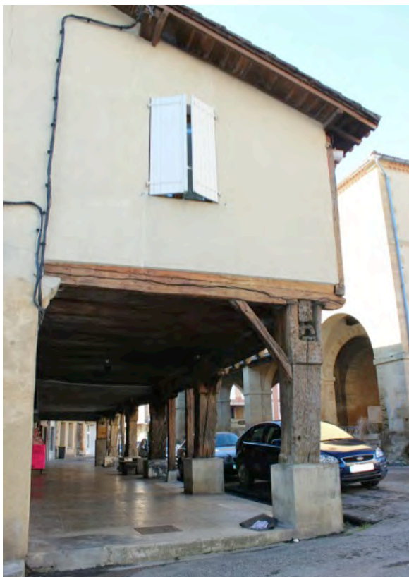
Fig. 9-144 – Miélan, maison (parcelle AD 107), détail des couverts et du poteau cornier dans lequel s'insère la sablière de plancher, vue depuis le nord.
