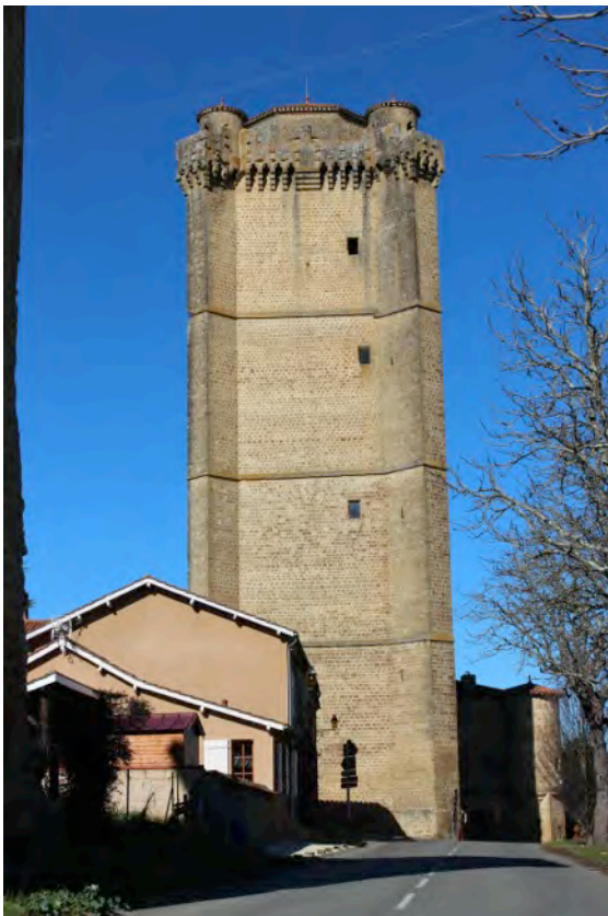
Fig. 8-16 – Bassoues, donjon des archevêques, vue depuis le sud.
