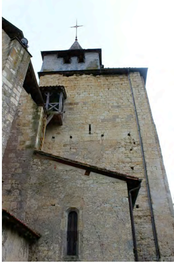
Fig. 6-49 – Pessan, tour de l'abbatiale, élévation orientale.
