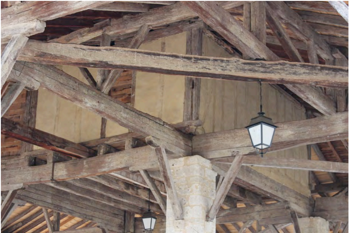
Fig. 6-139 – Solomiac, détail de l'ancienne maison commune, vue depuis le nord-est.
