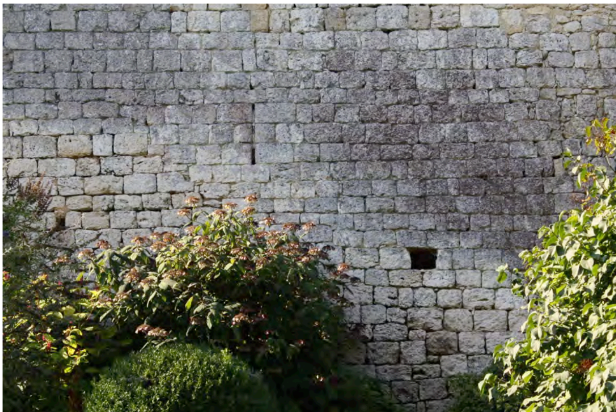
Fig. 6-73 – Mauroux, front nord de l'enceinte (parcelle D 335), vue depuis le nord.
