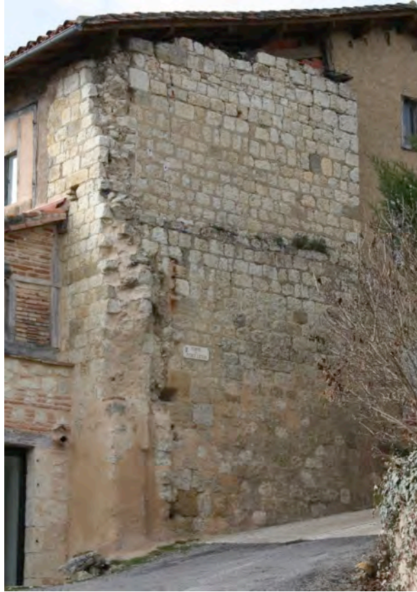
Fig. 5-4 – Castelnaud-Barbarens, vestiges de la porte « de dessous » (P2 sur le plan précédent), vue depuis le sud-est.
