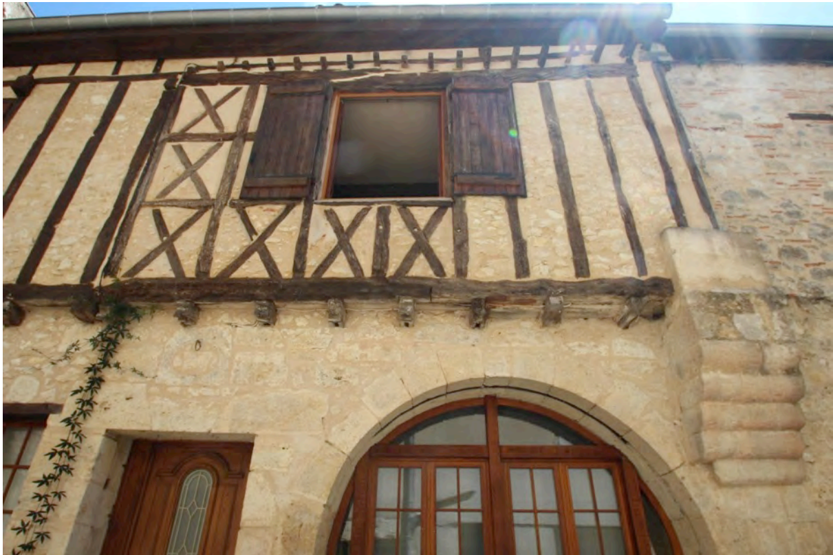
Fig. 9-63 – La Romieu, maison (parcelle AB 321), façade nord-ouest, vue depuis le nord-ouest.
