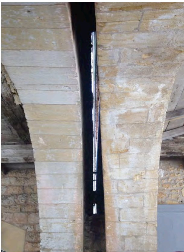
Fig. 9-137 – Monpazier (Dordogne), exemple de deux arcs de couverts édifîés côte à côte.
