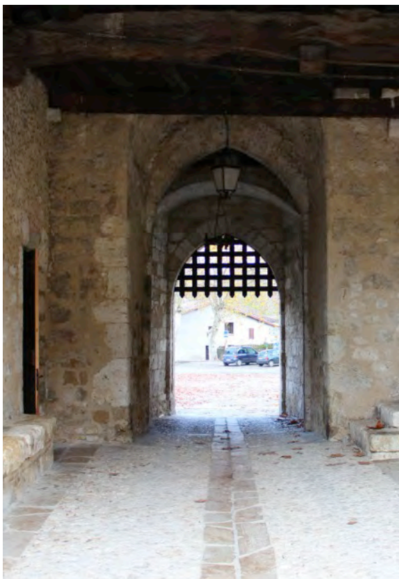
Fig. 6-67 – Terraube, tour-porte, encoche destinée à recevoir la barre de fermeture des vantaux en arrière de la herse.
