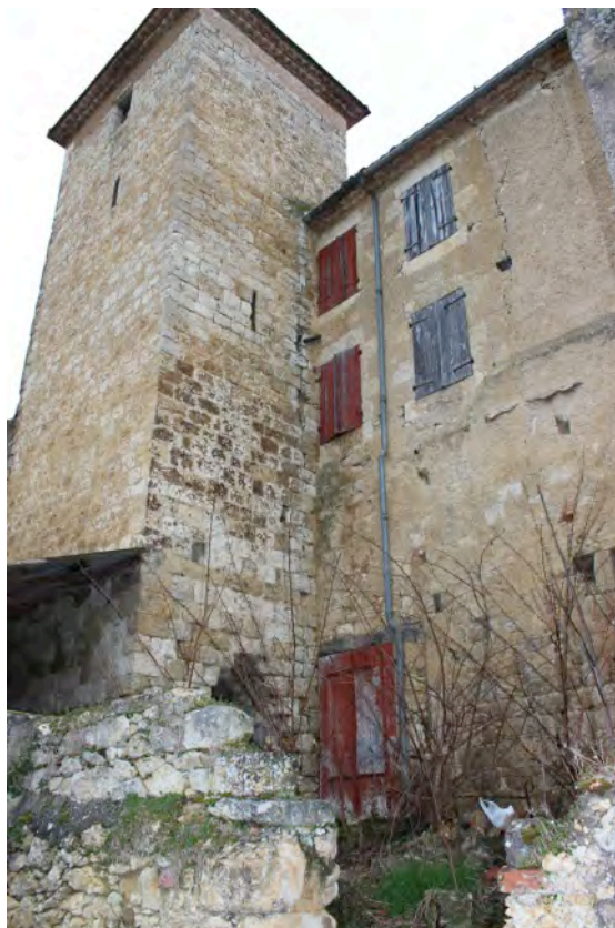
Fig. 6-45 – Lavardens, tour (parcelle BL 95), vue depuis le sud-est.
