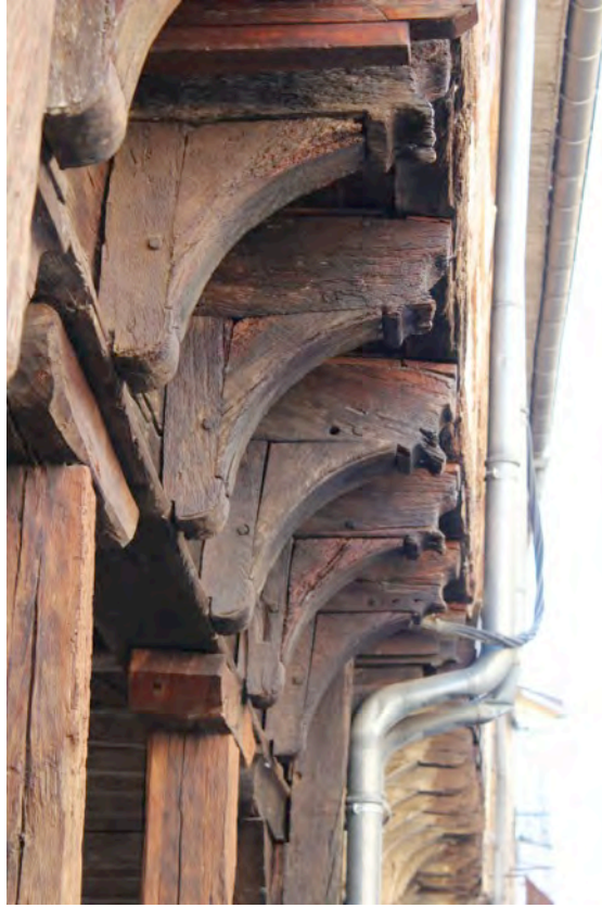
Fig. 9-94 – Miélan, maison (parcelle AD 107), détail des abouts de solives et des consoles.
