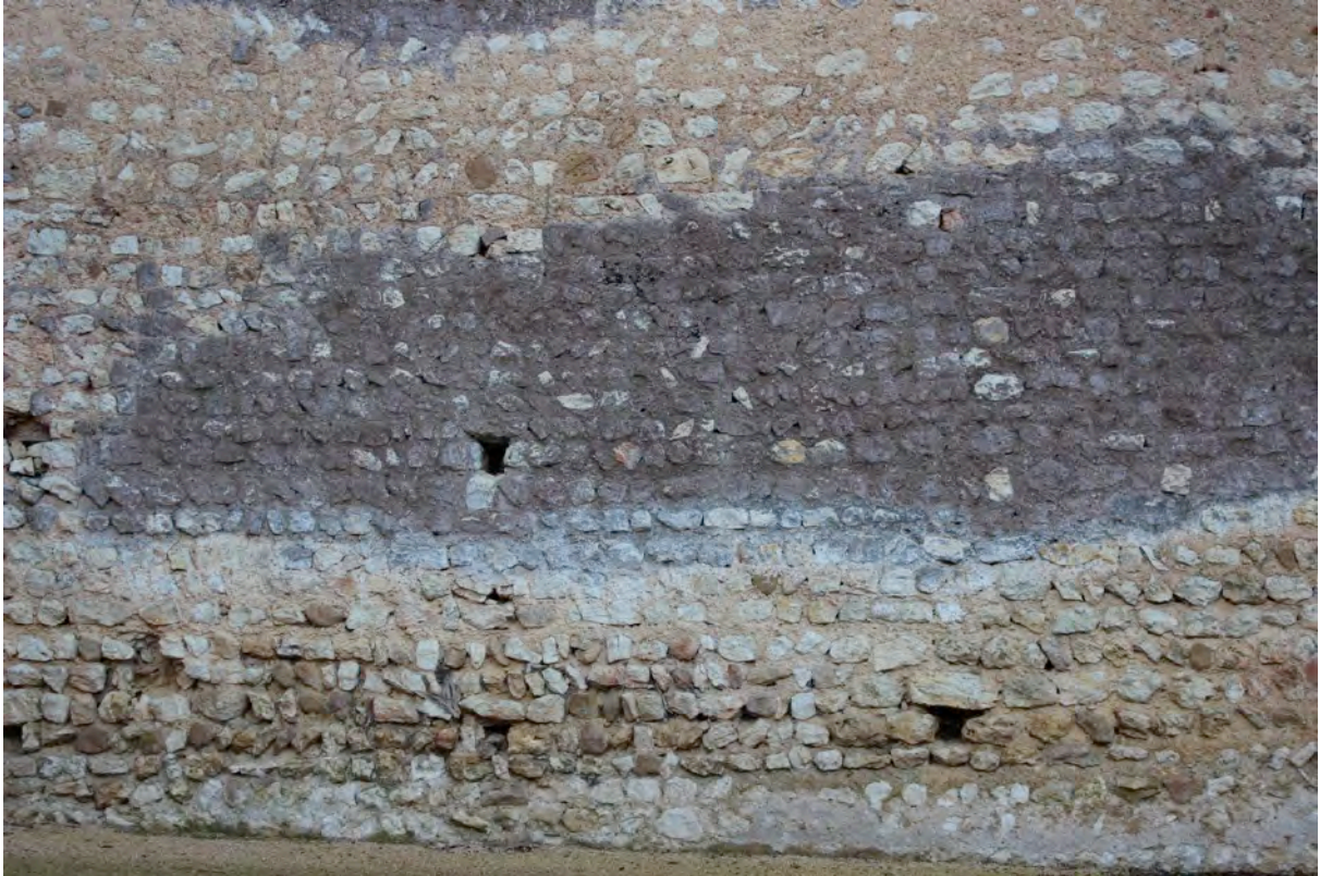
Fig. 5-54 – Pessan, église, détail de la maçonnerie du mur nord de la nef, vue depuis le nord.
