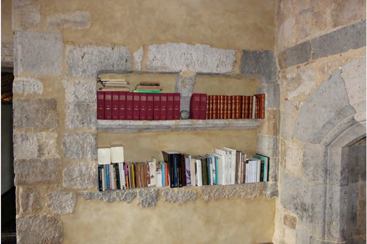
Fig. 9-107 – Montréal, maison « du bailli » (parcelle BM 213), premier étage, pièce nord, placard aménagé dans le mur et sculpté.
