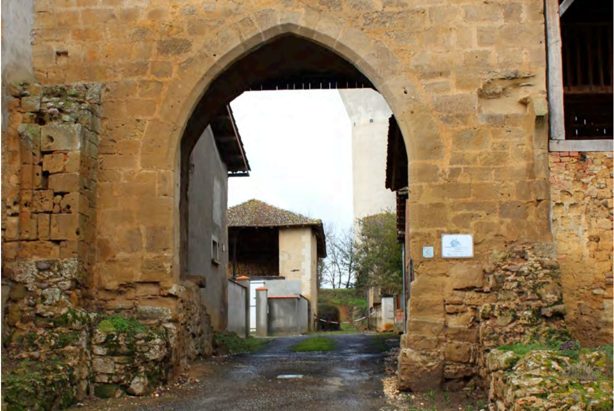
Fig. 8-70 – Mont-d'Astarac, tour-porte, détail des maçonneries ajoutées de part et d'autre de la porte, vue depuis l'est.
