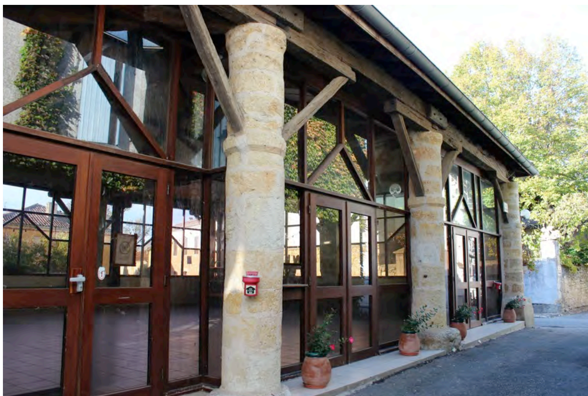
Fig. 9-47 – La Sauvetat, halle, vue depuis le sud-est.
