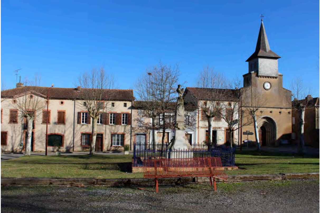
Fig. 6-94 – Villefranche, vue d'ensemble de la place de la bastide depuis l'ouest.
