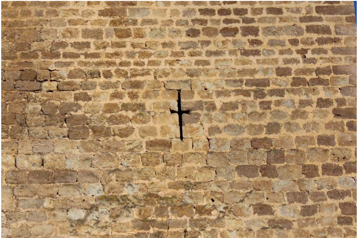
Fig. 6-77 – Dému, face externe de la tour-porte, détail de la meurtrière à croix pattée.
