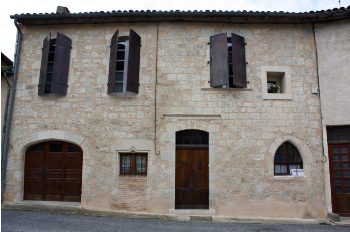
Fig. 4-51 – Pessan, maison implantée sur une rue transversale suivant les courbes de niveau (parcelle AD 79), vue depuis le nord-est.
