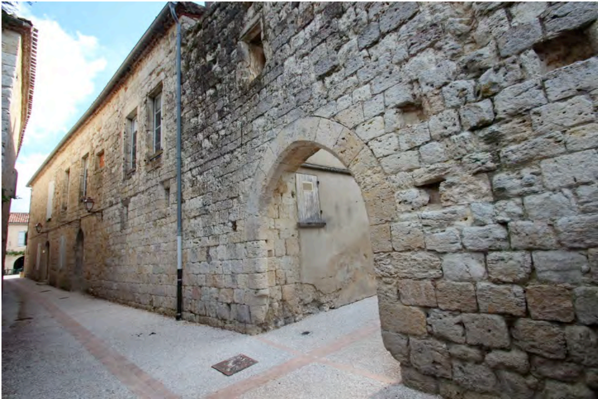
Fig. 6-102 – La Romieu, mur de l'enclos du quartier canonial, vue depuis le sud-ouest.
