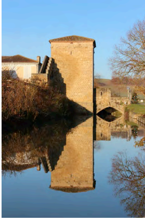
Fig. 8-3 – Barran, vue d'ensemble de l'ouvrage fortifié depuis l'est.
