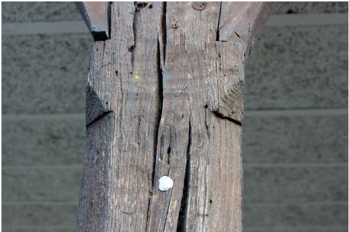
Fig. 9-148 – Aignan, maison (parcelle AB 205), détail de la partie haute d'un des poteaux aux angles abattus terminés par des congés triangulaires.
