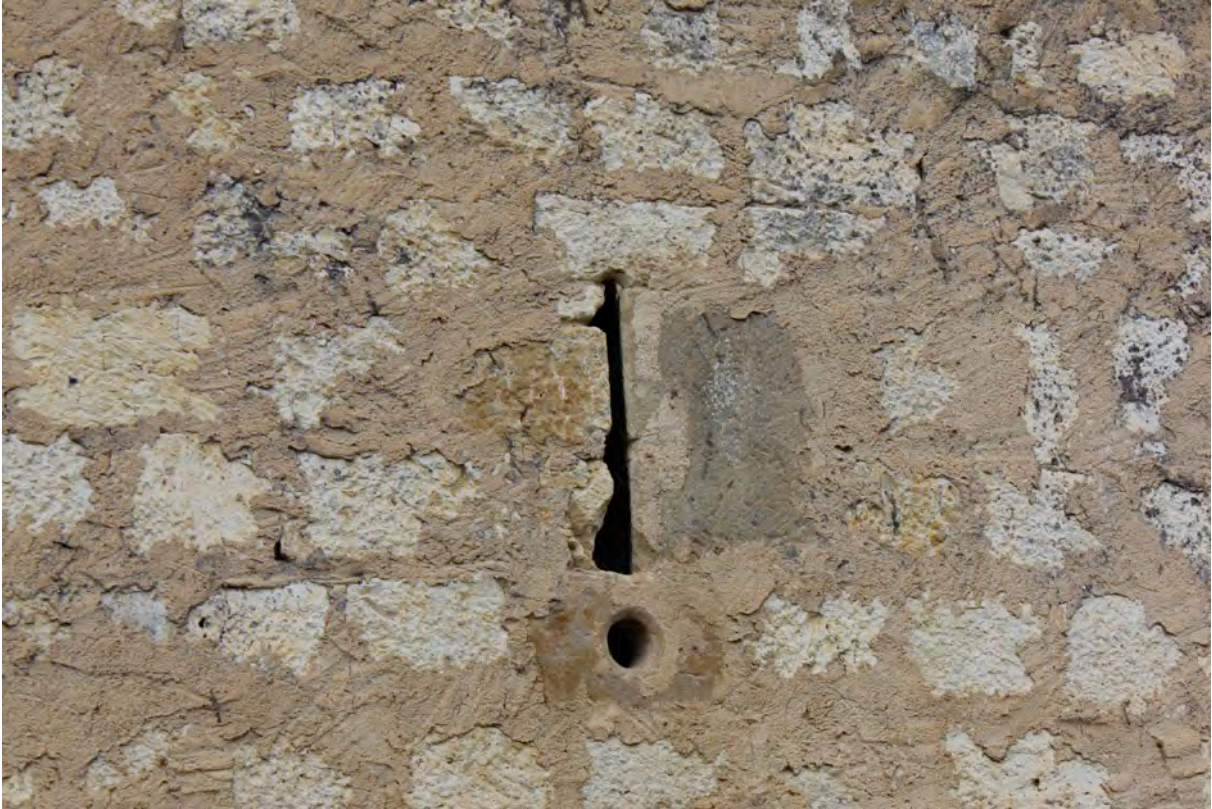
Fig. 8-66 – Saint-Lary, front oriental de l'enceinte, détail d'une archère-canonnaire.
