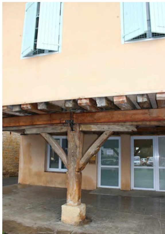
Fig. 9-145 – Aignan, maison (parcelle AB 208), façade sud, détail du poteau central doté de deux aisseliers et chapeaux.
