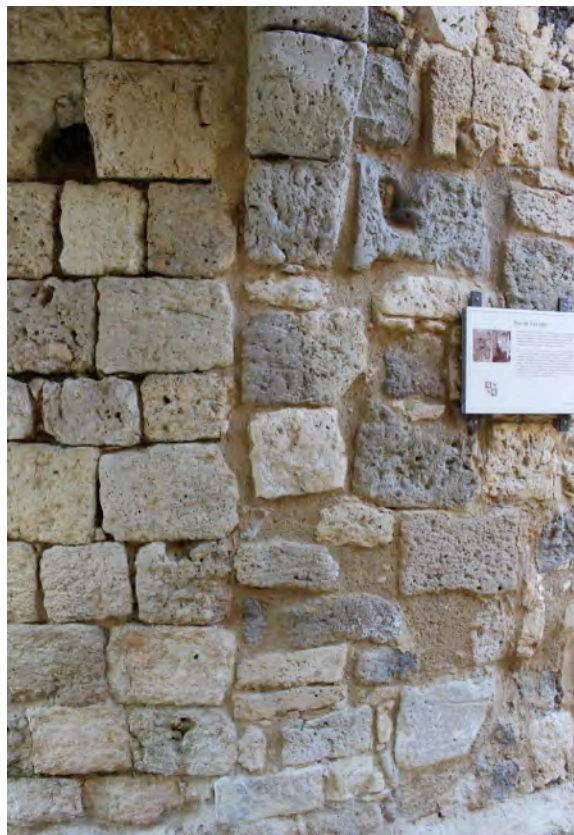
Fig. 6-8 – Fourcès, détail du mur nord du couloir, vue depuis le sud. La tour-porte, à gauche, s'appuie contre la porte antérieure, à droite.
