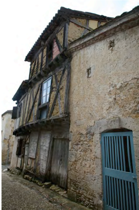
Fig. 9-51 – Gimbrède, maison (parcelle AO 19), façade orientale, vue depuis le nord-est.
