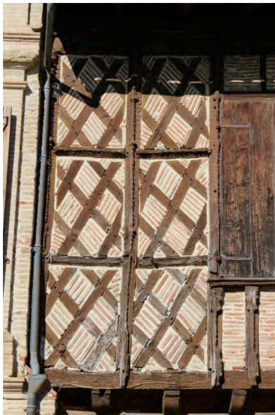
Fig. 9-77 – Cologne, maison (parcelle AA 69), façade sud, détail du panneautage.
