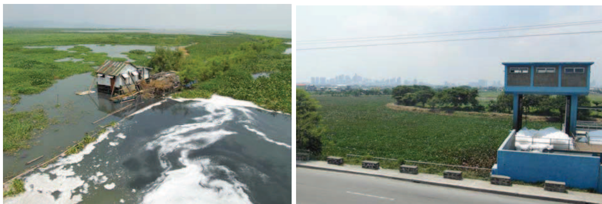
PHOTO 8. Station de pompage côté ville (à droite) et flux des eaux urbaines dérivées côté lac vers l'habitation d'une famille d'agriculteurs urbains (à gauche)
