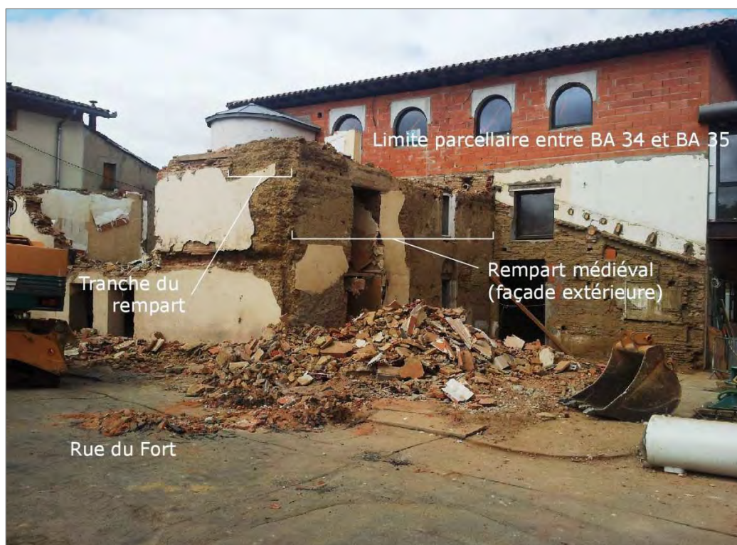
Fig. 107 : Vue depuis le Nord-Est du rempart médiéval en cours de démolition (Cliché : P. Pisani, 2013, SATM).
