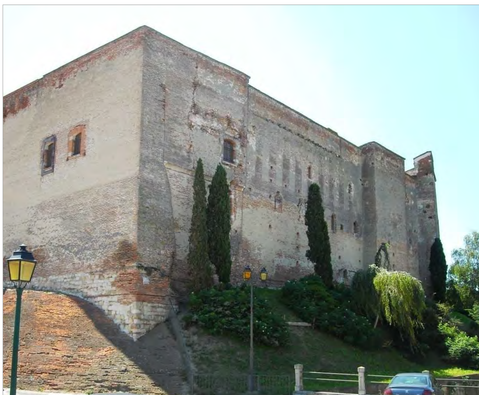
Fig. 18 : Percement d'ouvertures sur les façades est et nord du château de Verfeil (C. Lacroix, 2011).
