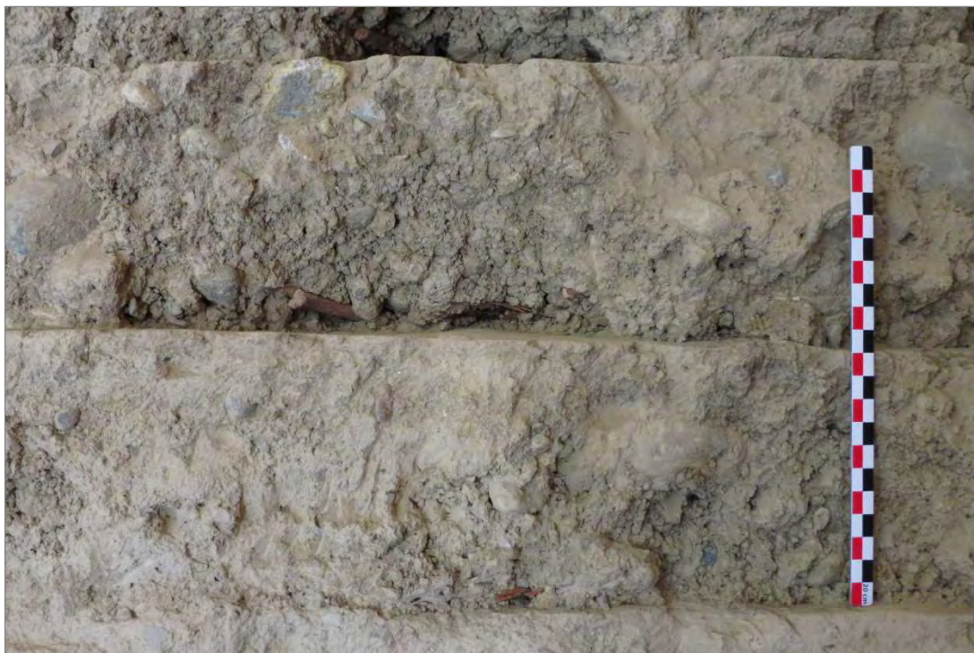
Fig. 109 : La mise en œuvre du rempart : lits de terre avec inclusion de végétaux observés dans la coupe du rempart nord (Cliché : C. Lacroix, 2013).
