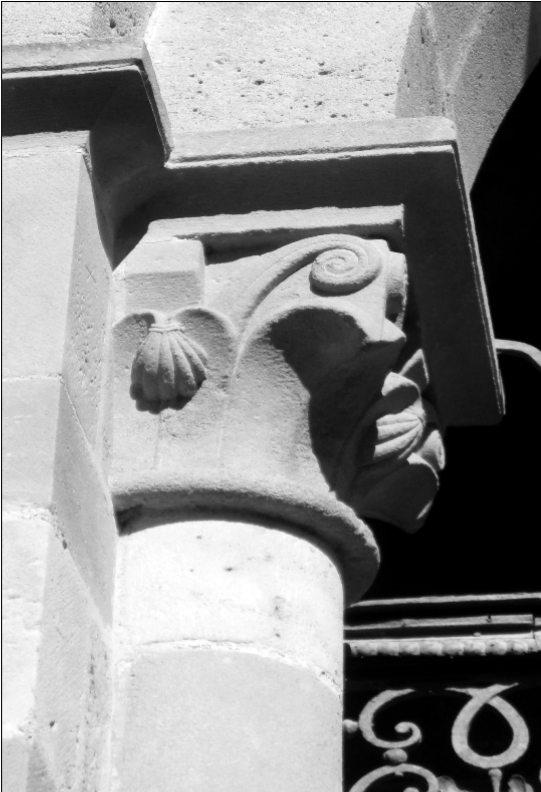
Colonne adossée remployée sur la façade de Notre-Dame-de-l'Assomption à Marciac. Photographie S. A., 2013.
