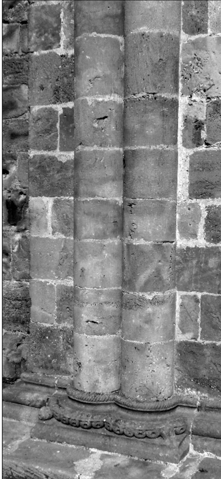
Colonnes adossées remployées sur la façade de Notre-Dame-de-l'Assomption à Marciac. Photographie S. A., 2013.
