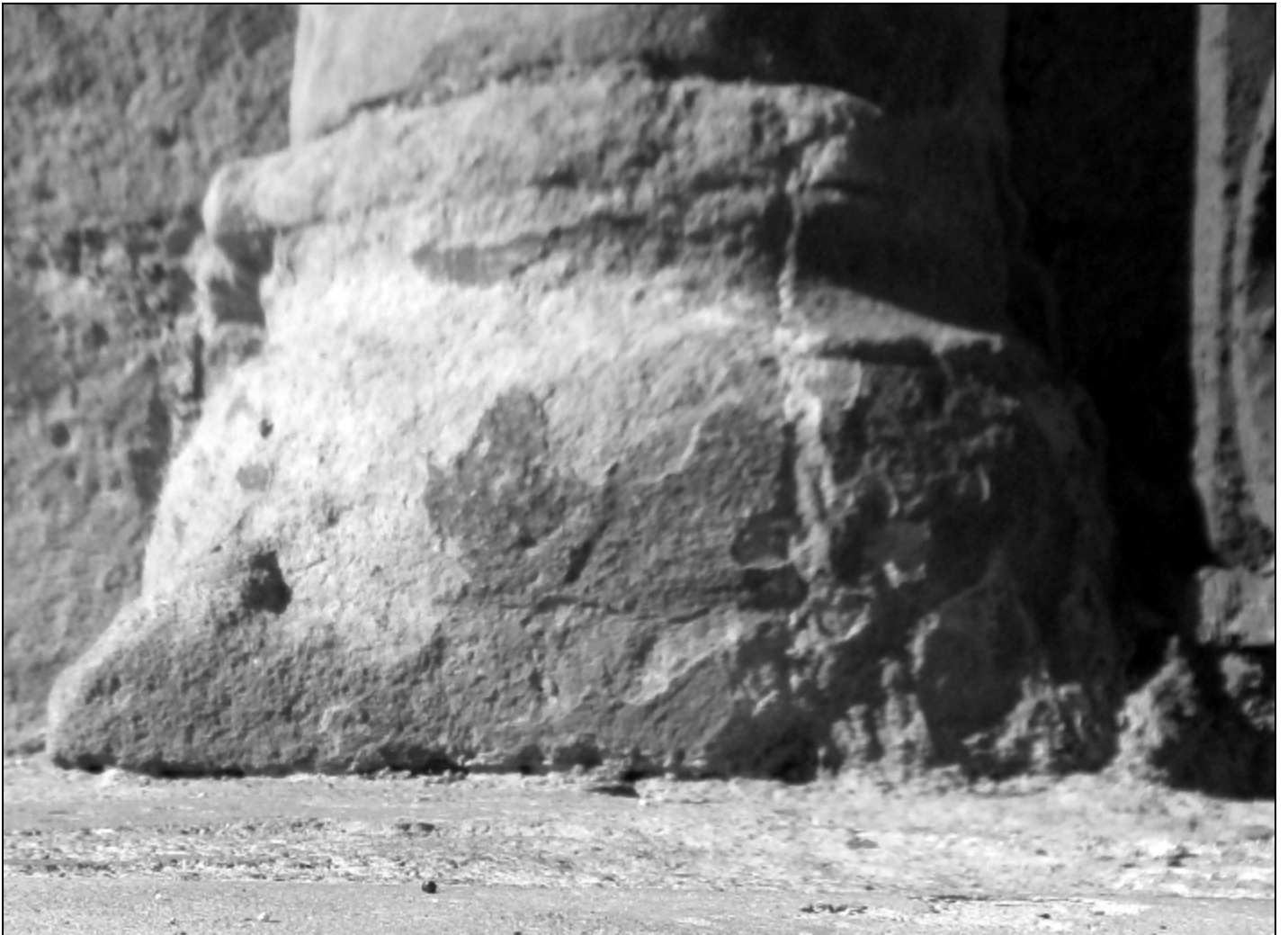
Base de style prégothique réemployée sur la façade de Notre-Dame-de-l'Assomption à Marciac. Photographie S. A., 2013.
