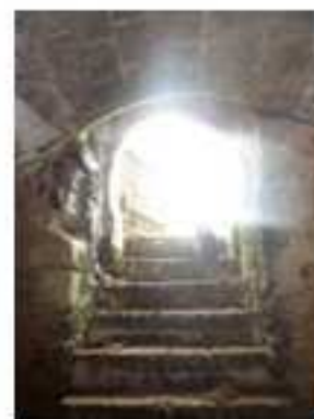
Figure 278 : Accès extérieur à la cave à La Chevalerie à Sainte-Cérotte
