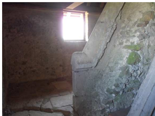
Figure 108 : Rampants au Château de Bouloire
