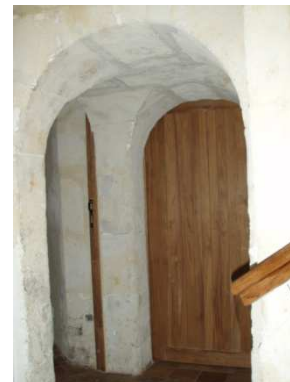
Figure 308 : Vestibule à Haut Éclair à Nogent-le-Bernard
