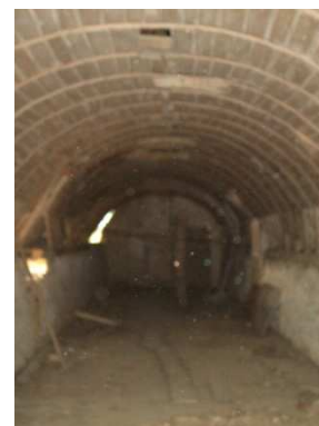
Figure 313 : Second niveau de la galerie de Verdigné à Avesnes-en-Saosnois
