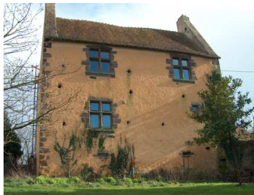
Figure 266 : Façade arrière de La Corbinière à Mézières-sous-Lavardin
