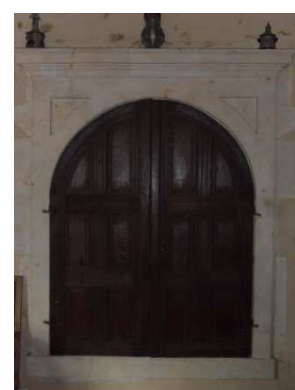
Figure 150 : La Grande Roche à Souvigné-sur-Même
