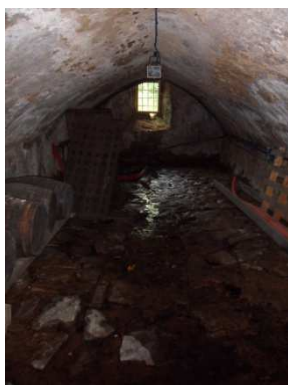
Figure 293 : Cave dallée et cours d'eau à Buis à Saint-Célerin
