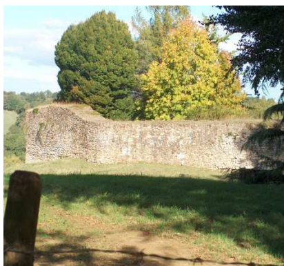
Figure 537 : Le Vieux Lavardin à Mézières-sous-Lavardin
