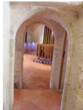
Figure 307 : Vestibule à Haut Éclair à Nogent-le-Bernard
