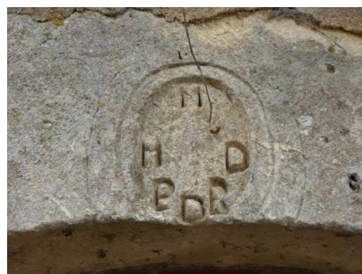
Figure 774 : La Grande Malpougère à Saint-Jean-des-Échelles
