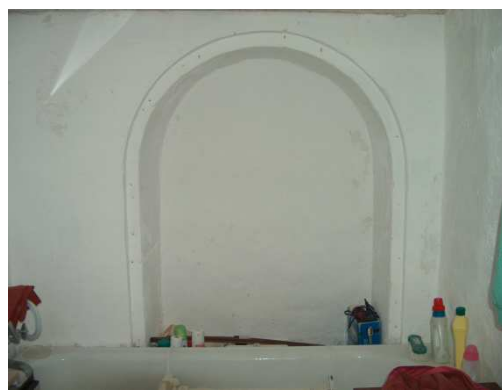
Figure 326 : Ancien cabinet de latrines à la Cour de Coudrecieux
