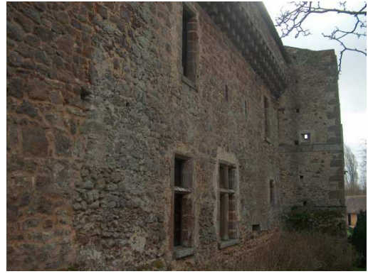
Figure 603 : Le Vieux Lavardin à Mézières-sous-Lavardin
