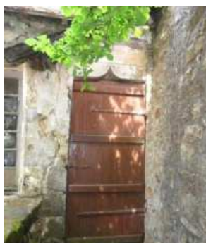
Figure 633 : Le Logis à Montreuil-le-Chétif
