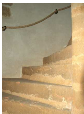
Figure 138 : Le Vieux Lavardin à Mézières-sous-Lavardin
