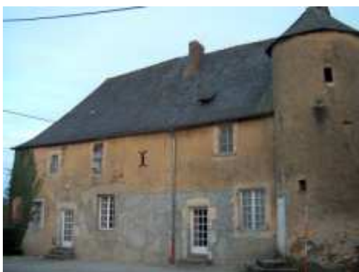
Figure 254 : Façade avant de La Brochère à Rouez-en-Champagne
