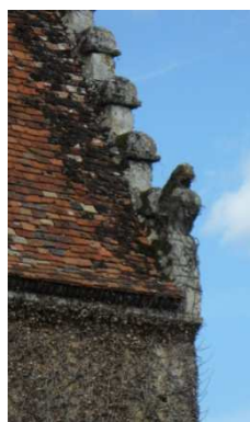
Figure 746 : La Pinelière à Gréez-sur-Roc
