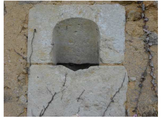
Figure 285 : La Pinelière à Gréez-sur-Roc
