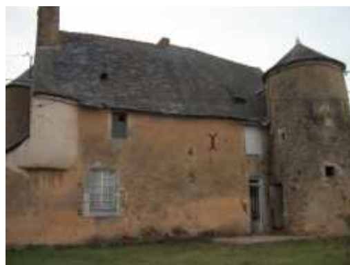
Figure 255 : Façade arrière de La Brochère à Rouez-en-Champagne
