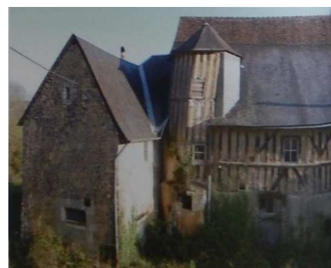
Figure 115 : Romigny à Bessé-sur-Braye
