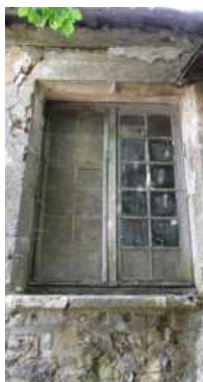
Figure 216 : Le Logis à Montreuil-le- Chétif
