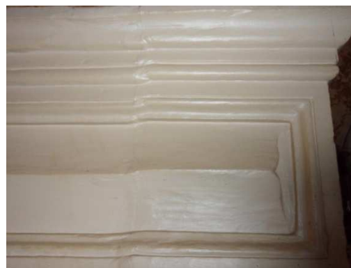
Figure 719 : Maison du Grand Chardon à Montfort-le-Gesnois
