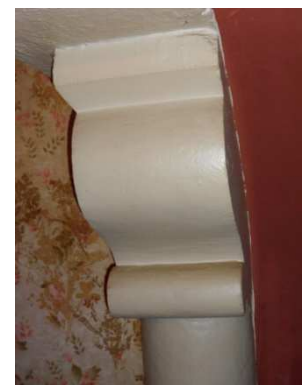
Figure 720 : Maison du Grand Chardon à Montfort-le-Gesnois
