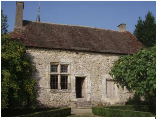
Figure 52 : Façade arrière de L'Auditoire de justice de Contilly
