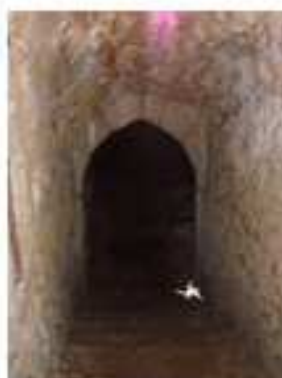
Figure 273 : Accès extérieur à la cave du Boille à Montmirail
