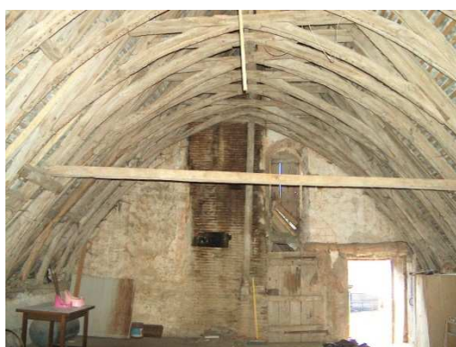
Figure 170 : Berceau en arc brisé à L'Épinay à Saint-Marceau
