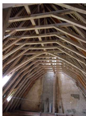
Figure 171 : Charpente de La Garenne à Roullée
