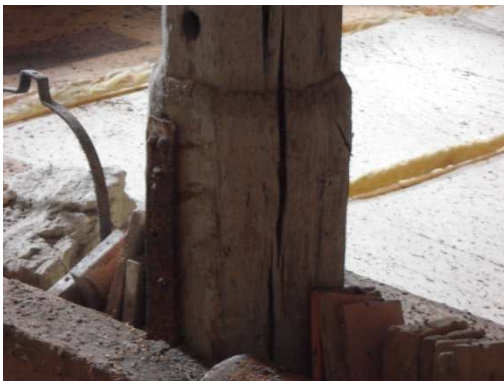
Figure 173 : Base du Poinçon sur la charpente de La Garenne à Roullée
