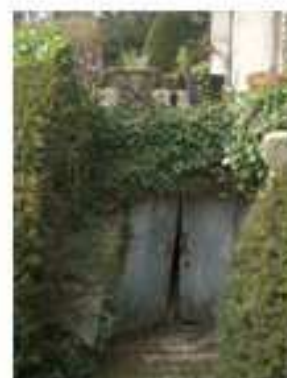
Figure 274 : Accès extérieur à la cave du Château de Saint-Paterne
