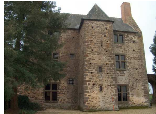
Figure 113 : Le Vieux Lavardin à Mézières-sous-Lavardin
