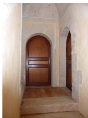
Figure 303 : Escalier rampe-sur-rampe à Planchette à Cormes
