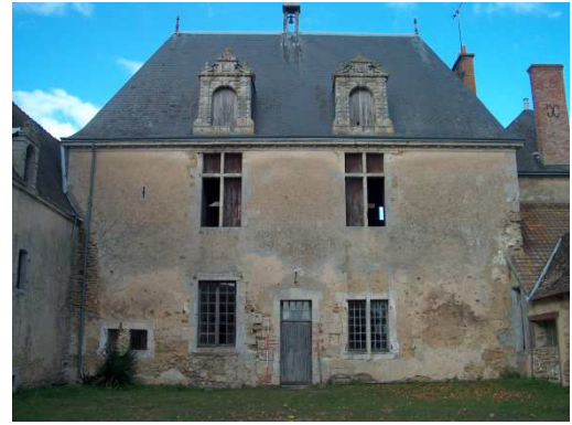
Figure 98 : Enduit à Verdigné à Avesnes-en-Saosnois
