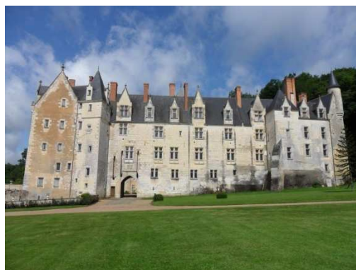
Figure 34 : Logis du début du XVIe siècle à Courtanvaux à Bessé-sur-Braye
