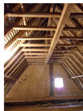
Figure 172 : Charpente du Logis à Thoigné
