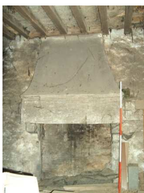
Figure 384 : Radray à Assé-le-Riboul
