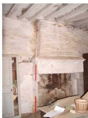
Figure 430 : Radray à Assé-le-Riboul
