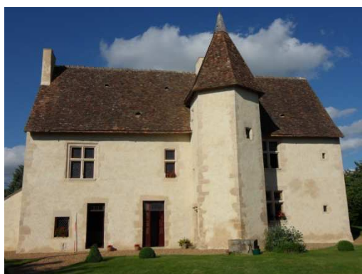
Figure 185 : Toiture à deux pentes au Logis à Thoigné
