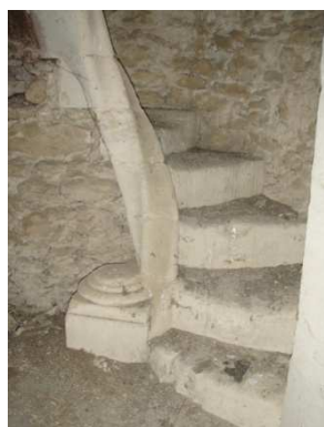
Figure 341 : Escalier du pavillon à Verdigné à Avesnes-en-Saosnois
