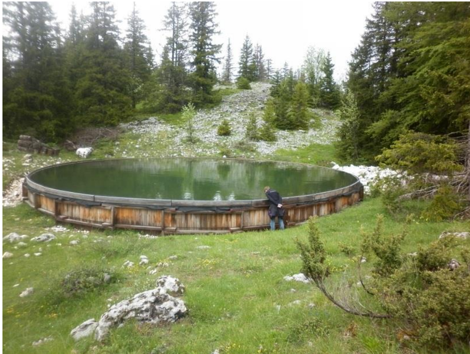
Photo 13 : Impluvium de l'alpage de Darbounouse, juin 2016
