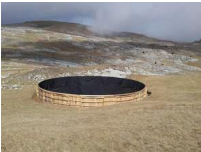
Photo 15 : Installation de l'impluvium à Chamousset
