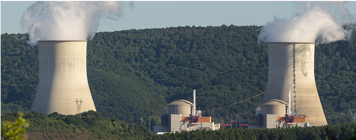
FIGURE 1.5 – Centrale nucléaire de Chooz (Ardennes). Les deux réacteurs sont logés dans les deux bâtiments cylindriques au premier plan. Les cheminées, plus à l'arrière, sont destinées au refroidissement des réacteurs (certaines centrales, refroidies grâce à l'eau d'une mer ou d'un cours d'eau, ne sont pas équipées de telles cheminées) 36
