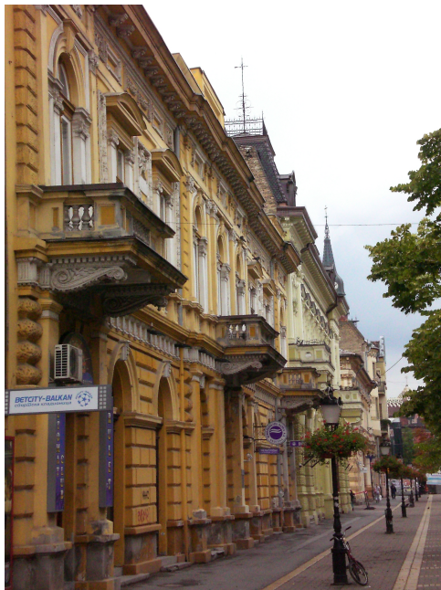
Figure 76- Aperçus d'ensembles urbains datant de la période d'occupation autrichienne à Osijek, Novi Sad et Subotica.
