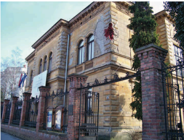
Figure 64 - La Galerie des Beaux Arts à Osijek
