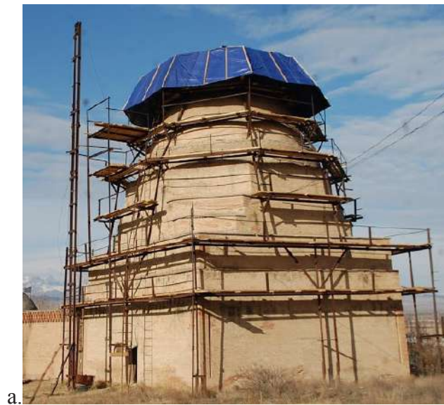
2. Le mausolée de Šāh Faḡl en travaux Photos U. Akmatkaliev (2014), téléchargées depuis Google Maps en 2016
