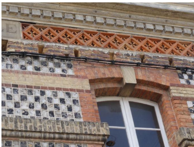
Figure 90 : Détails de la façade de l'école du Port.
