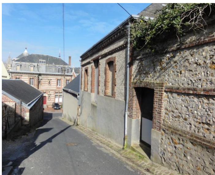
Sente de la Fromagerie. Sur la droite, l'ancienne école des Frères. Photographie Elisabeth SIMON, mars 2016. Photographie agrandie en annexe.
