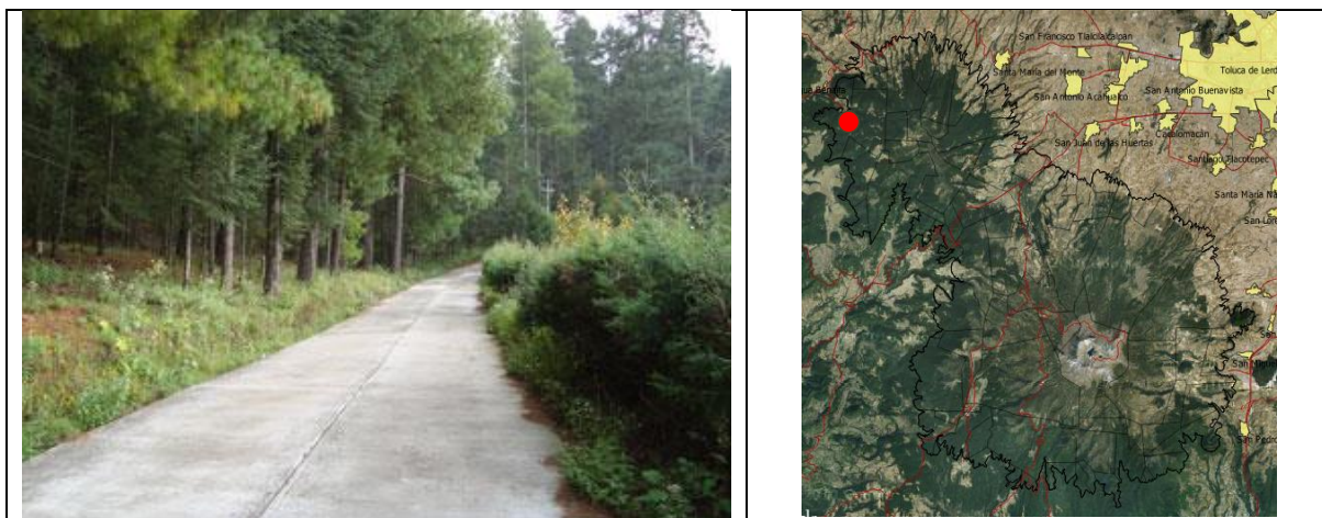
Photo 17. Chemin conduisant d'Agua Bendita vers Huacal Viejo ( ejido Agua Bendita). Travaux financés par le FISM et réalisés en faenas durant 2010 et 2011. Cliché : A. Salinas Rojas, le 09 novembre 2011.
