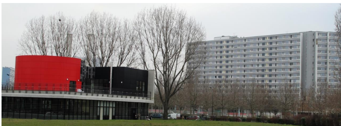
La médiathèque Ulysse en face des tours du quartier Franc Moisin, Saint-Denis. Cliché : janvier 2011
