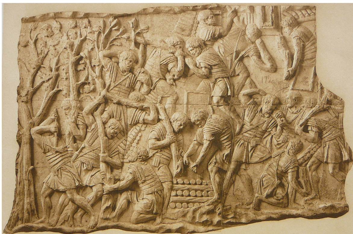
Figure 37 : Des légionnaires travaillent sous la protection de rondins de bois (Rome, colonne Trajane, scène CXVII)
