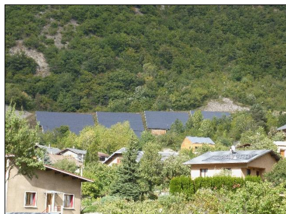
Photos 15 & 16 – La CPVS [1] de Saint-Julien-Mont-Denis (Savoie), exploitée par SUNALP, est implantée sur la forte pente de merlons anti-avalanche
