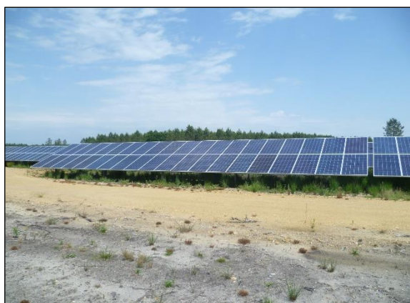
Photos 4 & 5 – La CPVS [1] de Garein (Landes), exploitée par MAÏA ÉNERGIE, utilise des modules PV basés sur la technologie silicium polycristallin
