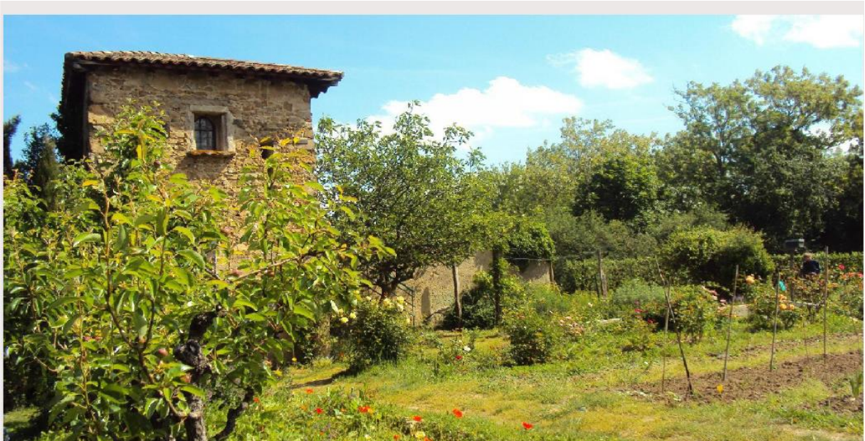
Figure 8 : Le mur, la haie, les arbres et arbustes délimitant le jardin du Cœur et la propriété de la Chardonnière sur l'extérieur (Grenet, 2014)
