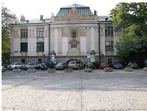
Flanc central (ouest, nord ouest) de la place Dernier belsonère
