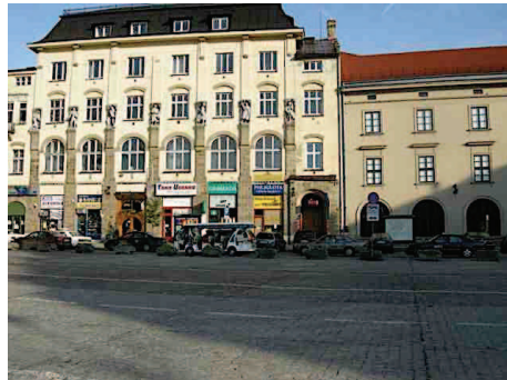
Flanc droit (sud-ouest, sud-est) de la place troisième belsonère
