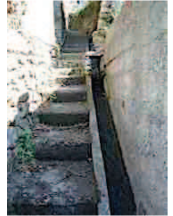
Vue sur la descente du canal
