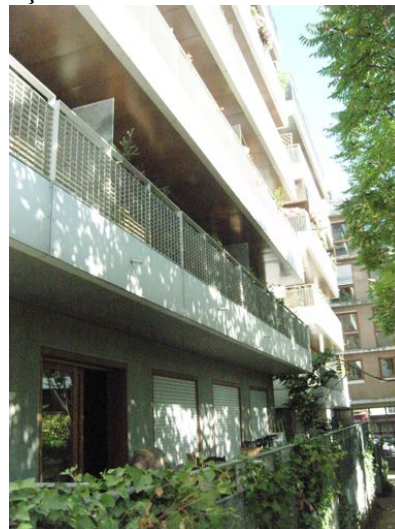
Photographie 2 : Site intermédiaire Inkerman, façade intérieure
