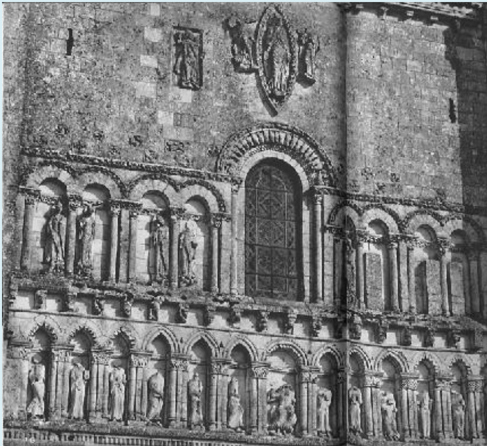
Fig. 93 : Façade ouest (Pérignac, église Saint-Pierre)
